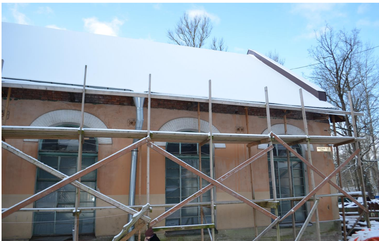
Фото 04. Выявленный ОКН «Павловская электрическая станция (с 2 службами и оградой)». Главное здание. Северо-восточный фасад. Фрагмент. Съёмка 15.03.2022 г.
