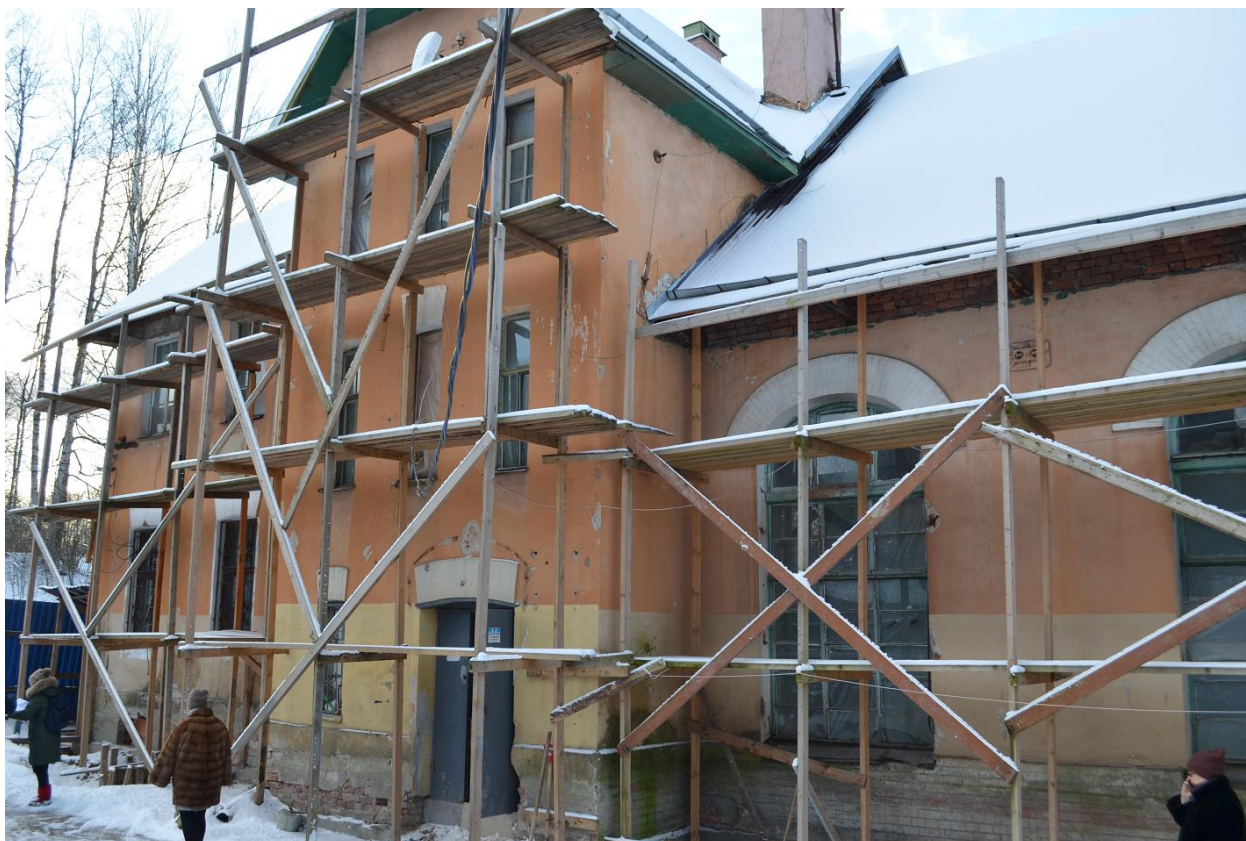
Фото 03. Выявленный ОКН «Павловская электрическая станция (с 2 службами и оградой)». Главное здание. Северо-восточный фасад. Фрагмент. Съёмка 15.03.2022 г.
