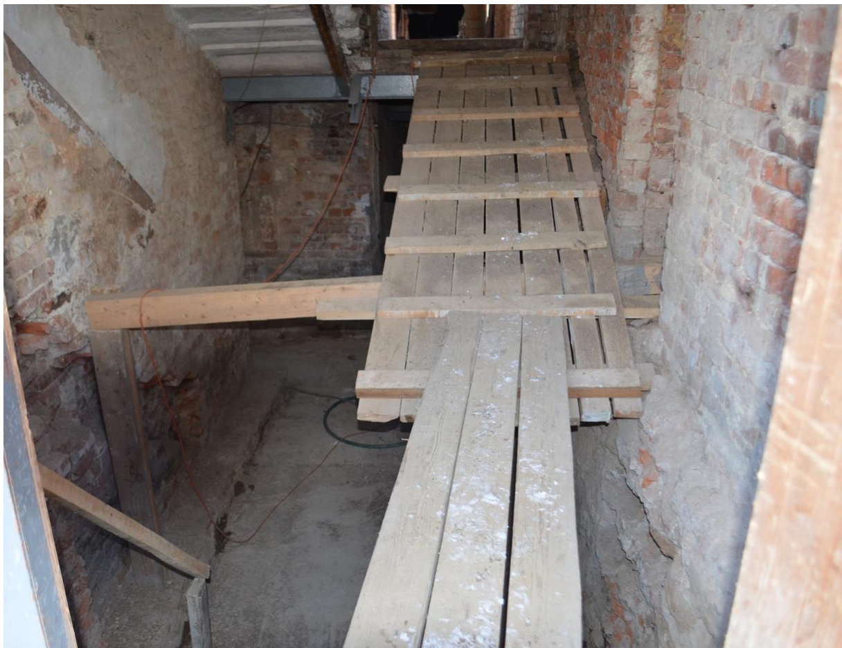
Фото 13. Выявленный ОКН «Павловская электрическая станция (с 2 службами и оградой)». Главное здание. Помещение 1-Н (6). Вид на лестницу. Съёмка 15.03.2022 г.
