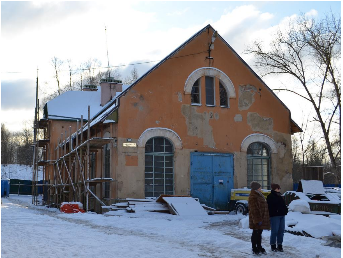
Фото 01. Выявленный ОКН «Павловская электрическая станция (с 2 службами и оградой)». Главное здание. Северо-западный фасад. Общий вид. Съёмка 15.03.2022 г.
