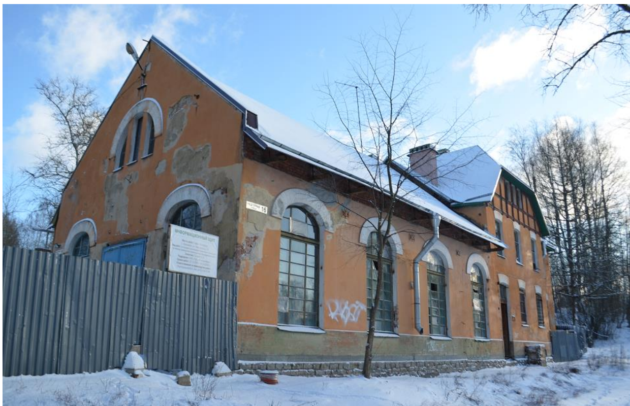
Фото 06. Выявленный ОКН «Павловская электрическая станция (с 2 службами и оградой)». Главное здание. Северо-западный и юго-западный фасады. Общий вид. Съёмка 15.03.2022 г.
