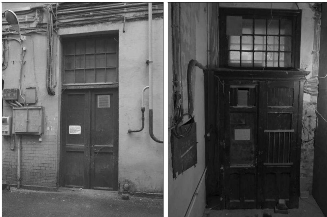
Илл. 19. Дом Г.А. Шульца, расположенный по ул. Куйбышева, д. 22. Дворовый фасад. Дверь и входной тамбур.
