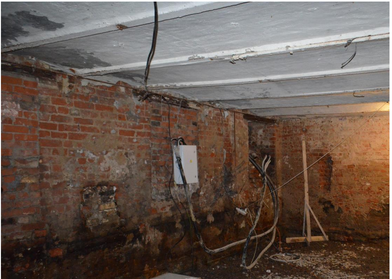
Фото 20. Выявленный ОКН «Павловская электрическая станция (с 2 службами и оградой)». Главное здание. Подвал. Помещение 1-Н (36,39). Общий вид. Съёмка 15.03.2022 г.
