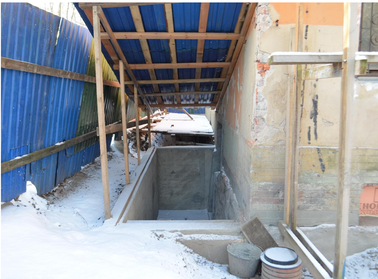
Фото 05. Выявленный ОКН «Павловская электрическая станция (с 2 службами и оградой)». Главное здание. Северо-восточный фасад. Фрагмент. Съёмка 15.03.2022 г.
