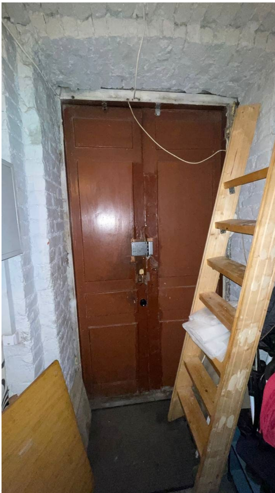
8. Вид на входную дверь в квартире;
