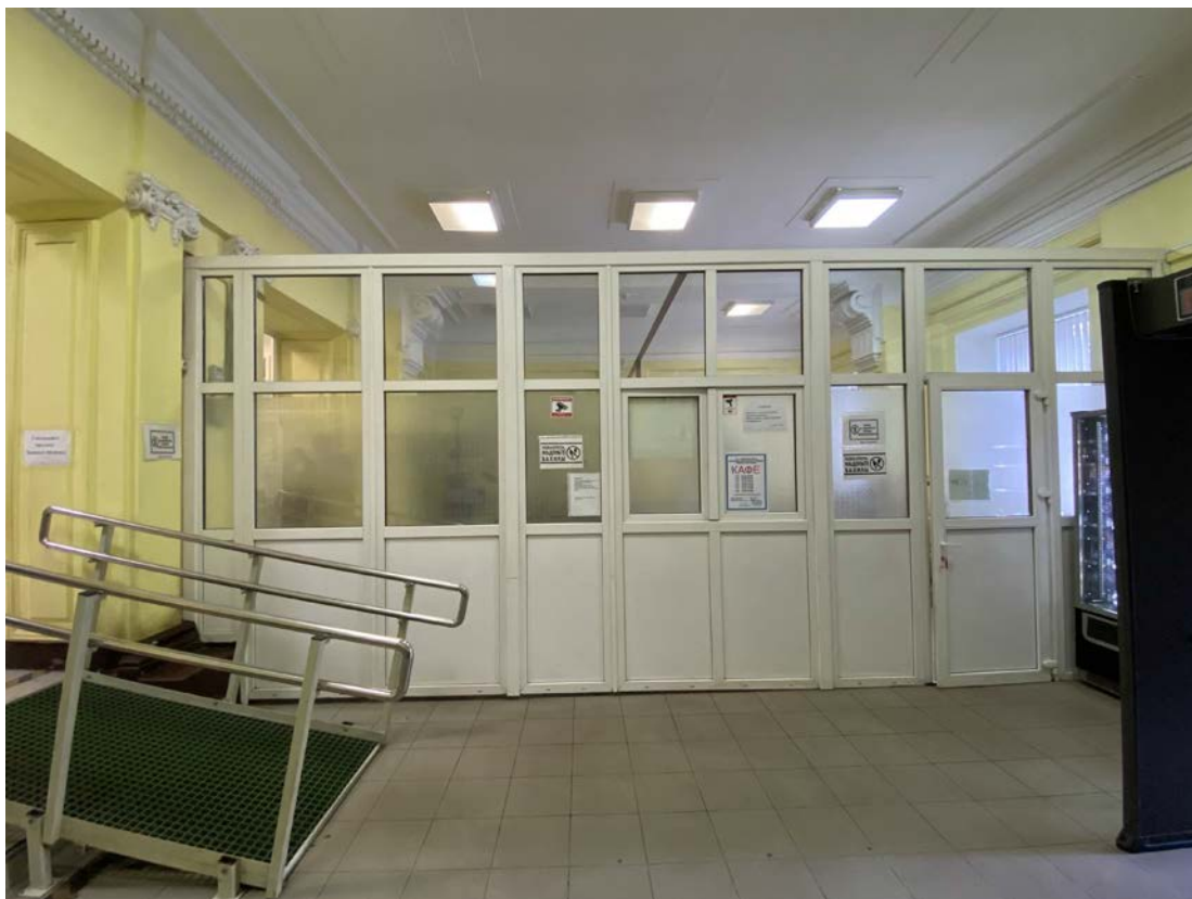
2. Объект культурного наследия «Комплекс зданий Дома призрения А.И. Тименкова и В.А. Фролова». Помещение №1. Вид на восток. 18.06.2021 г.
