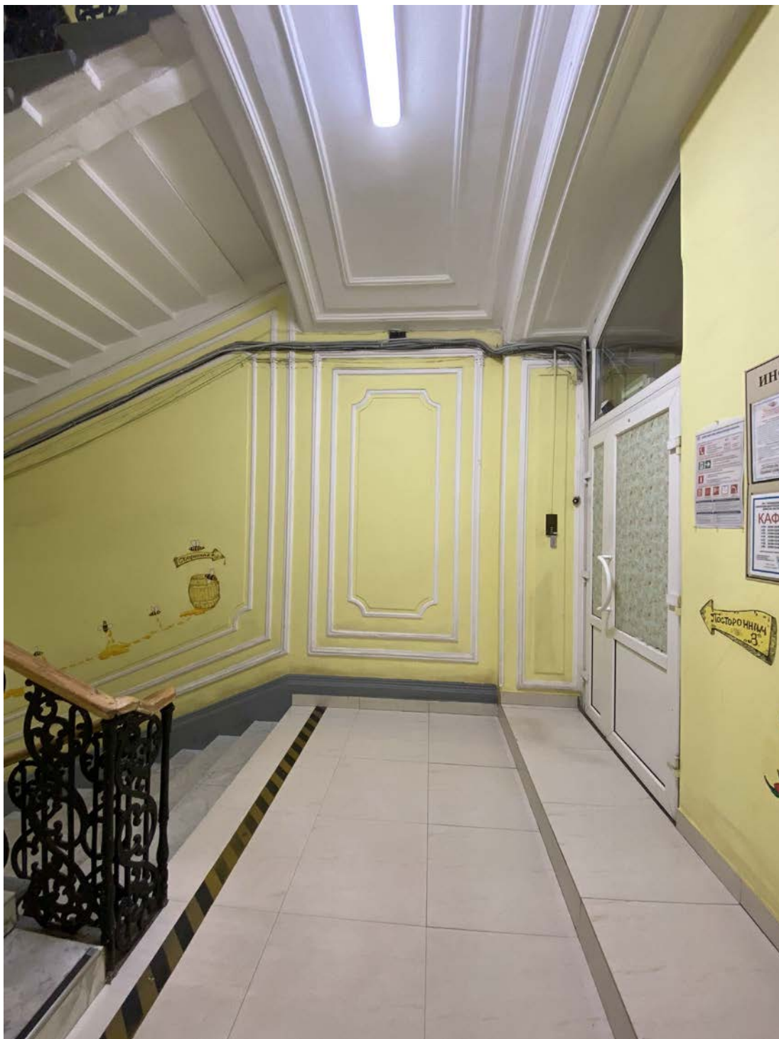
26. Объект культурного наследия «Комплекс зданий Дома призрения А.И. Тименкова и В.А. Фролова». Помещение №3. Вид на запад. 18.06.2021 г.
