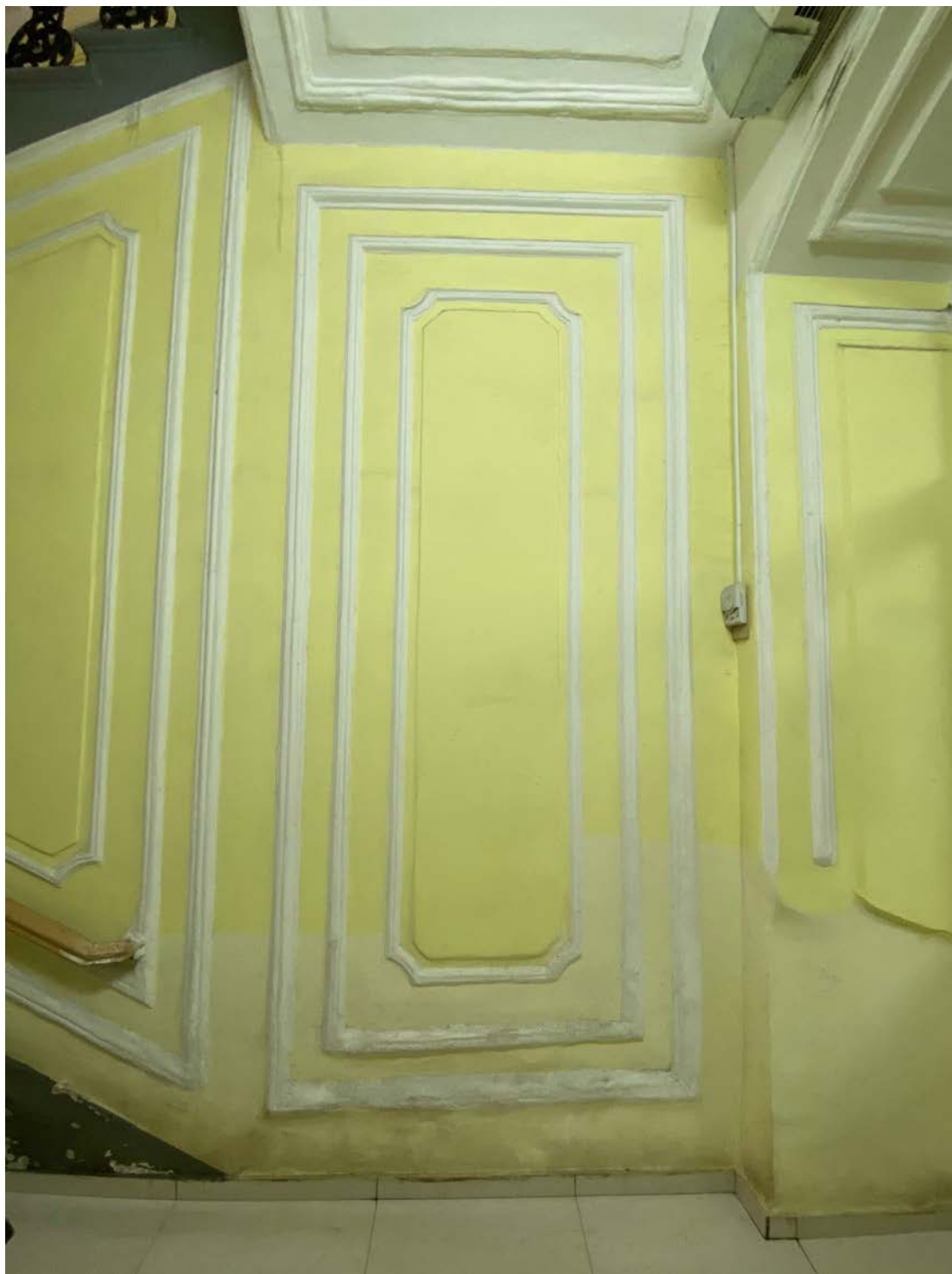
21. Объект культурного наследия «Комплекс зданий Дома призрения А.И. Тименкова и В.А. Фролова». Помещение №3. Вид на восток. 18.06.2021 г.
