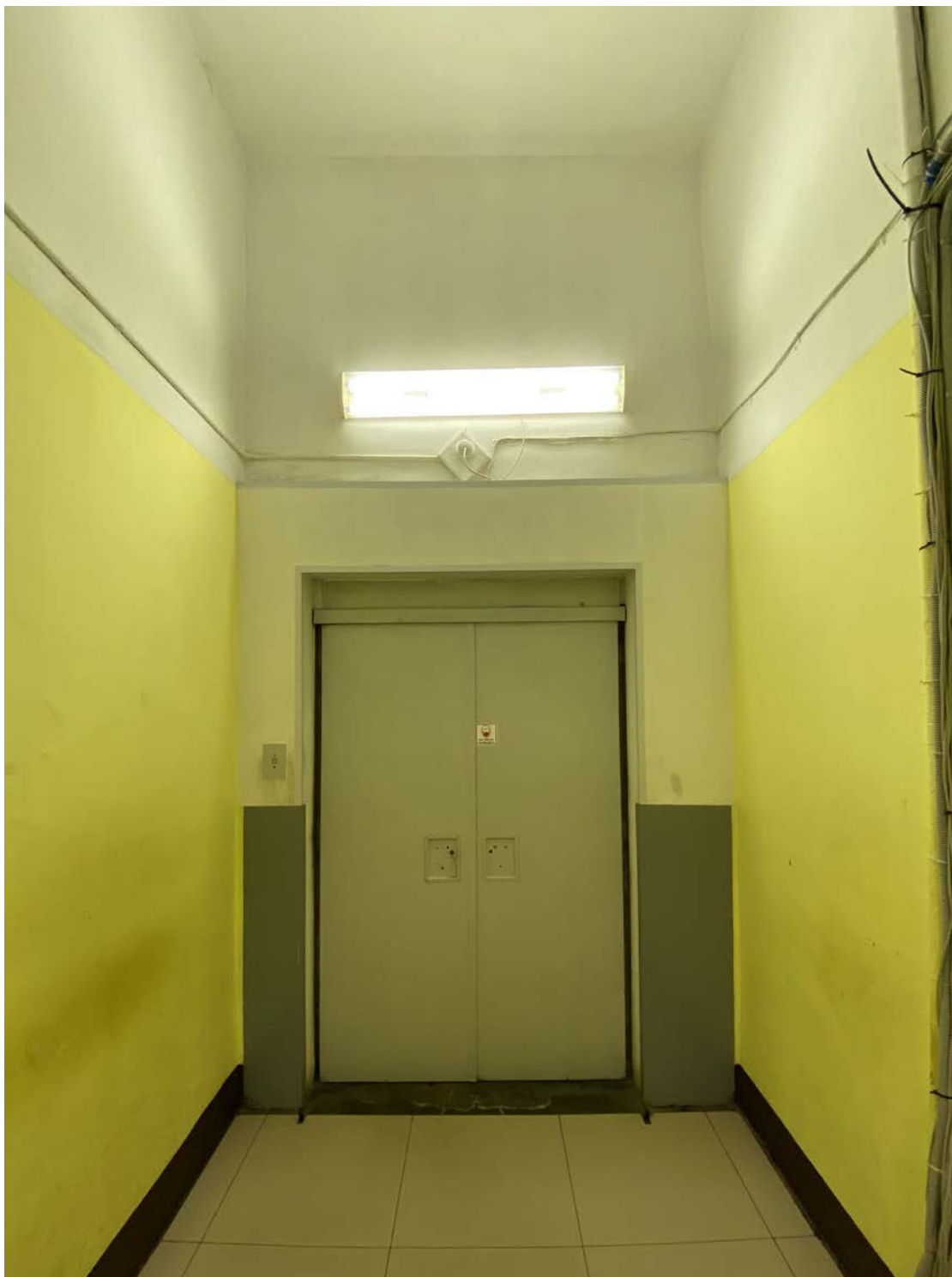
28. Объект культурного наследия «Комплекс зданий Дома призрения А.И. Тименкова и В.А. Фролова». Помещение №4. Вид на север. 18.06.2021 г.
