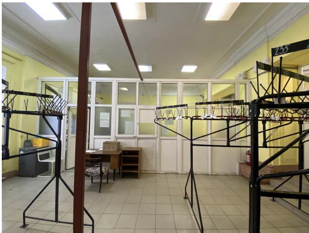
7. Объект культурного наследия «Комплекс зданий Дома призрения А.И. Тименкова и В.А. Фролова». Помещение №2. Вид на запад. 18.06.2021 г.
