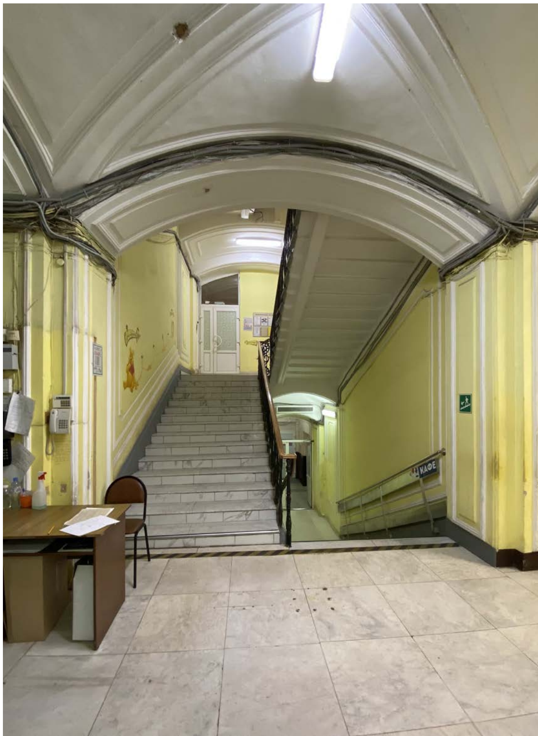
10. Объект культурного наследия «Комплекс зданий Дома призрения А.И. Тименкова и В.А. Фролова». Помещение №3. Вид на север. 18.06.2021 г.
