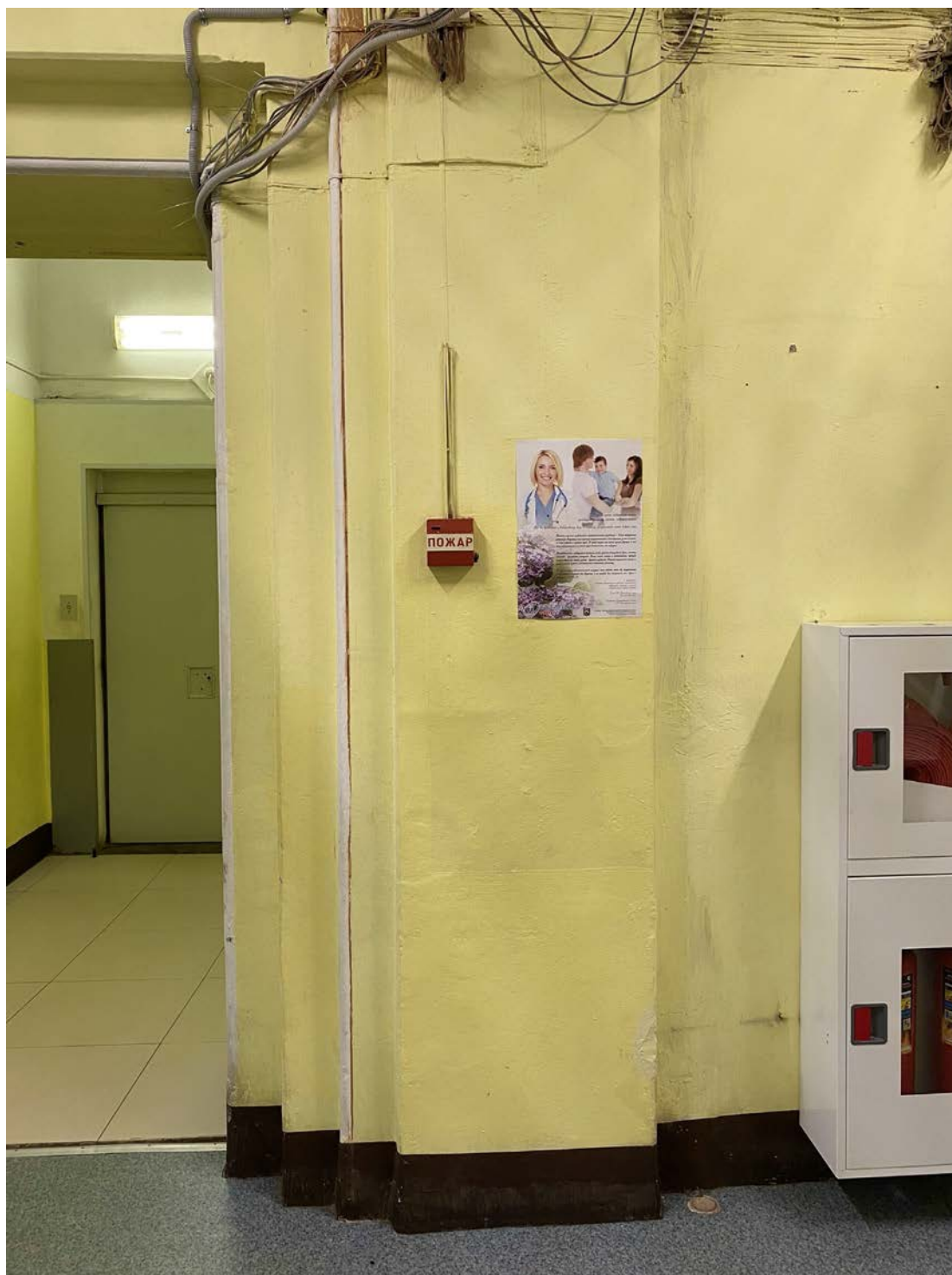
12. Объект культурного наследия «Комплекс зданий Дома призрения А.И. Тименкова и В.А. Фролова». Помещение №3. Вид на север. 18.06.2021 г.
