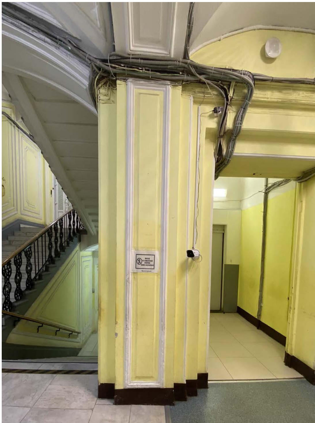
11. Объект культурного наследия «Комплекс зданий Дома призрения А.И. Тименкова и В.А. Фролова». Помещение №3. Вид на север. 18.06.2021 г.
