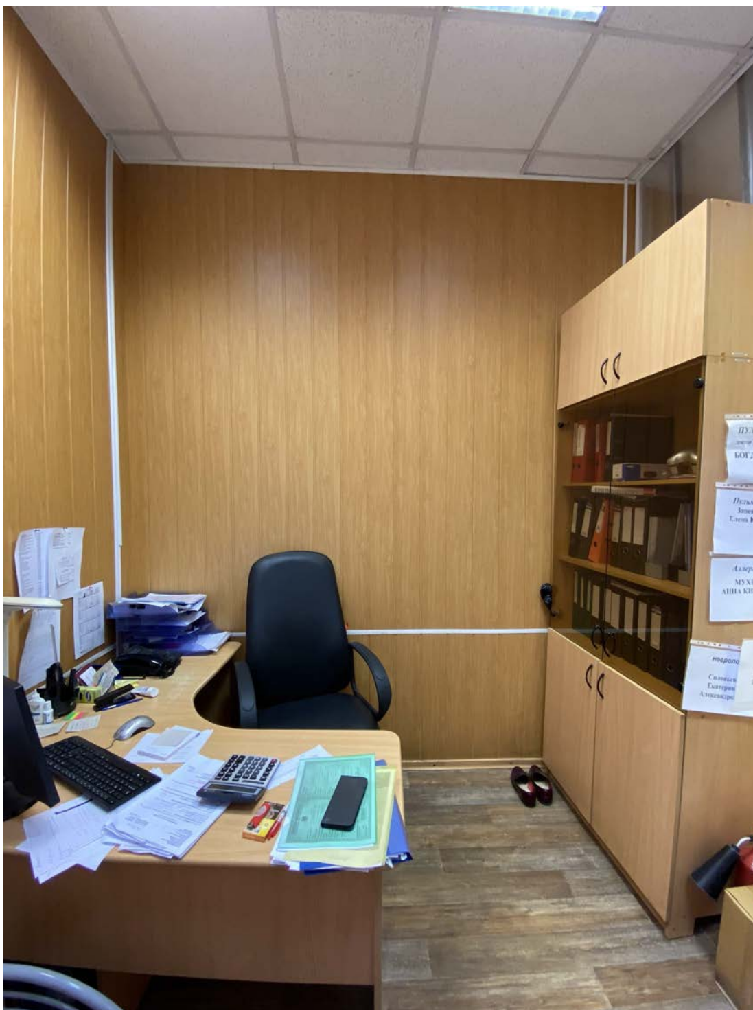
43. Объект культурного наследия «Комплекс зданий Дома призрения А.И. Тименкова и В.А. Фролова». Помещение №7. Вид на восток. 18.06.2021 г.
