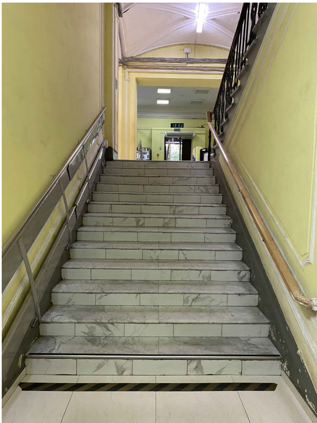
22. Объект культурного наследия «Комплекс зданий Дома призрения А.И. Тименкова и В.А. Фролова». Помещение №3. Вид на юг. 18.06.2021 г.
