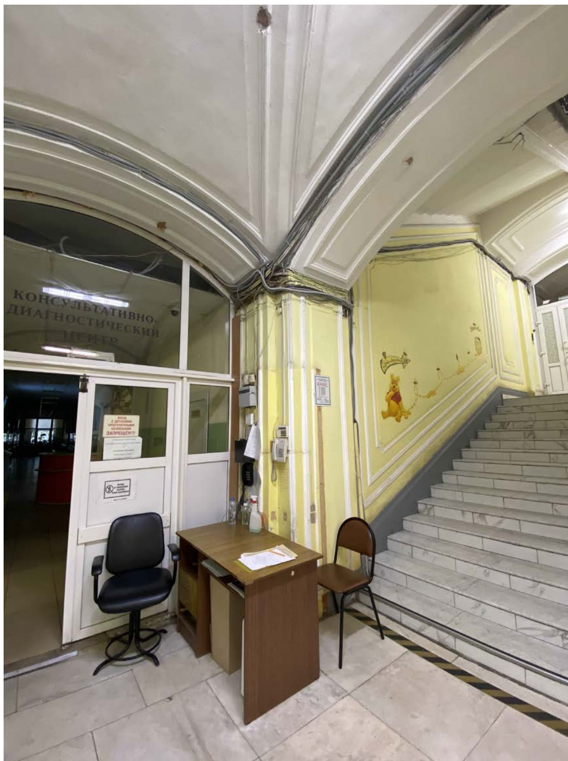
19. Объект культурного наследия «Комплекс зданий Дома призрения А.И. Тименкова и В.А. Фролова». Помещение №3. Вид на северо-запад. 18.06.2021 г.
