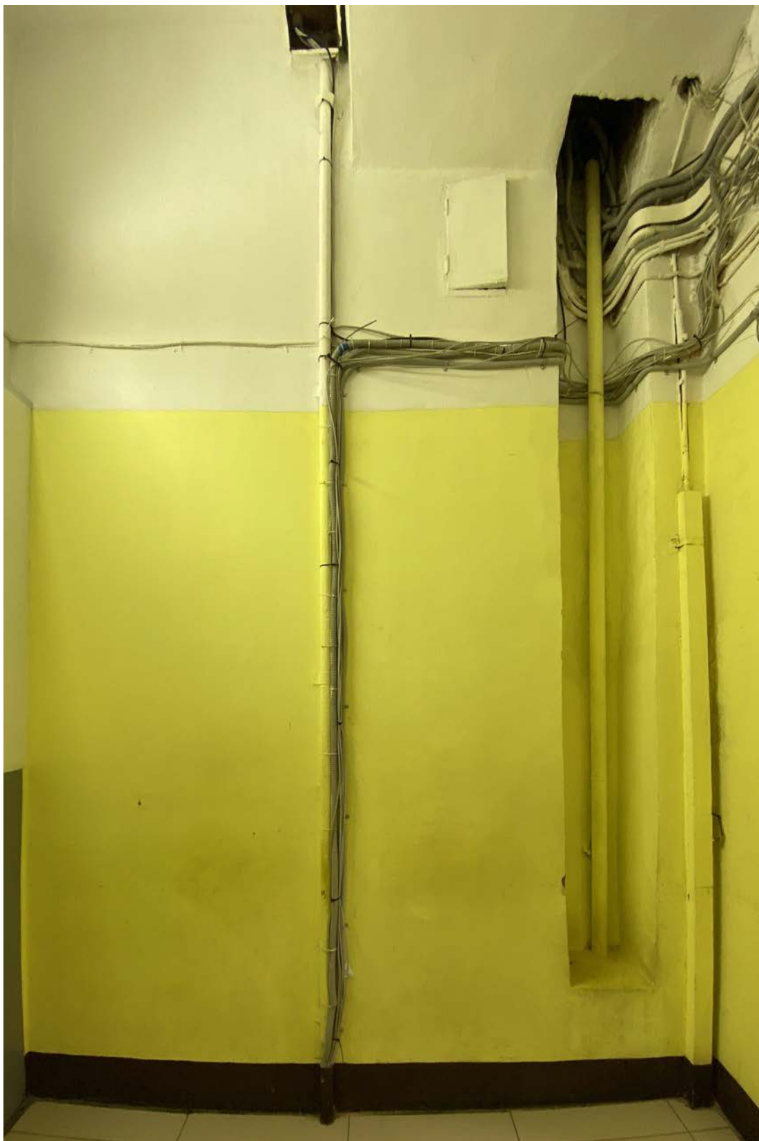
29. Объект культурного наследия «Комплекс зданий Дома призрения А.И. Тименкова и В.А. Фролова». Помещение №4. Вид на восток. 18.06.2021 г.
