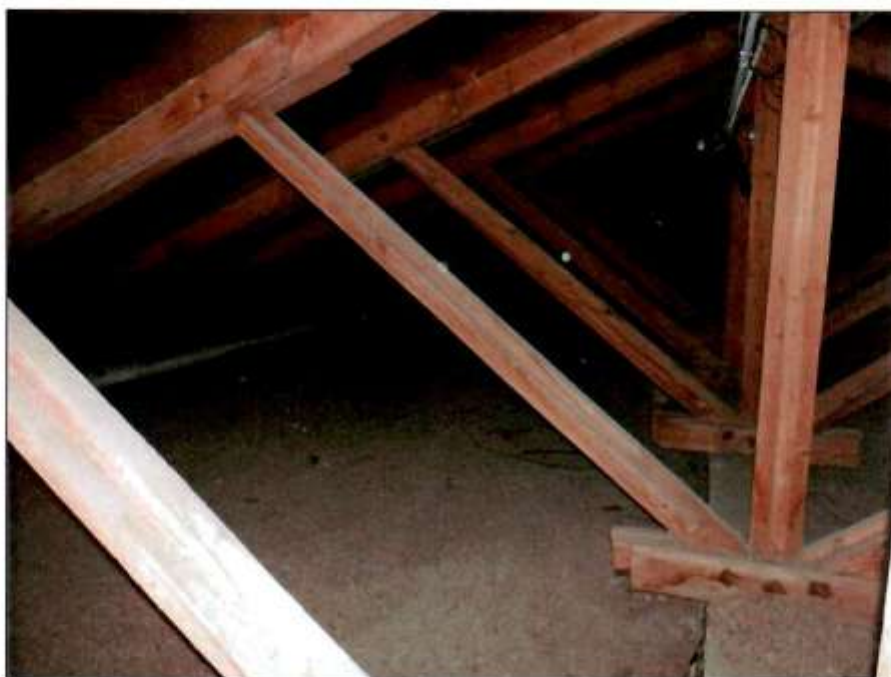
24. Стропильная система. Общий вид.
