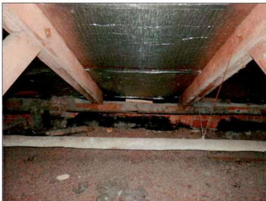
26. Стропильная система. Фрагмент.
