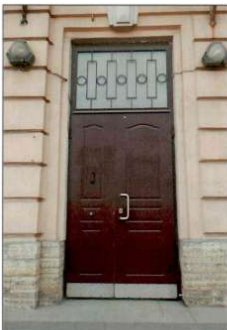
8. Северный фасад. Оформление дверного проёма.
