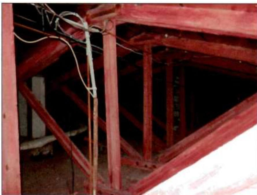
25. Стропильная система. Общий вид.
