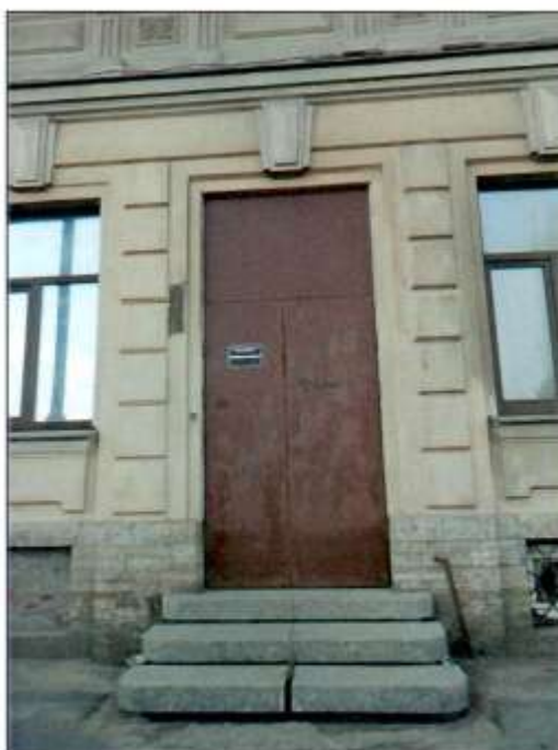
9. Северный фасад. Оформление дверного проёма.
