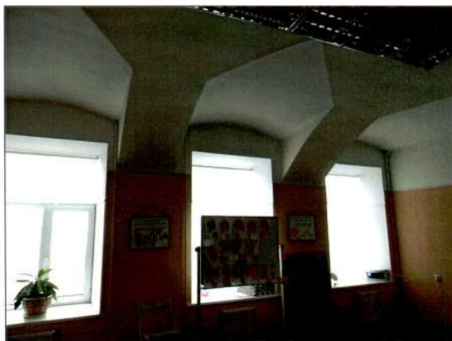
41. Помещение в уровне первого этажа.
