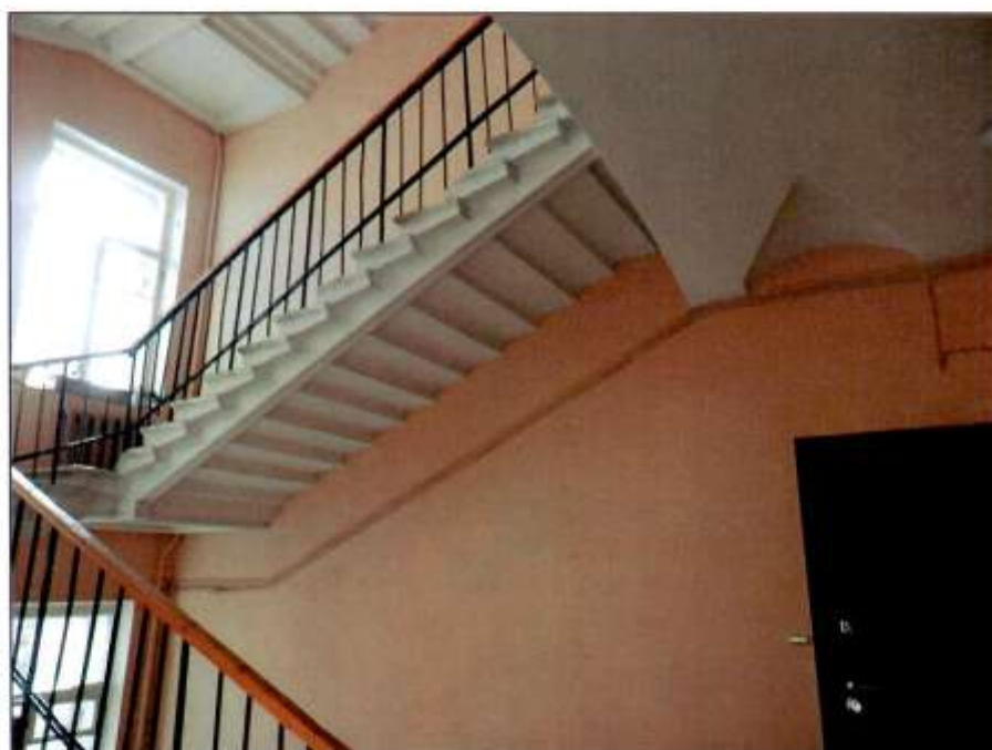
34. Подъезд № 7. Лестница. Общий вид.
