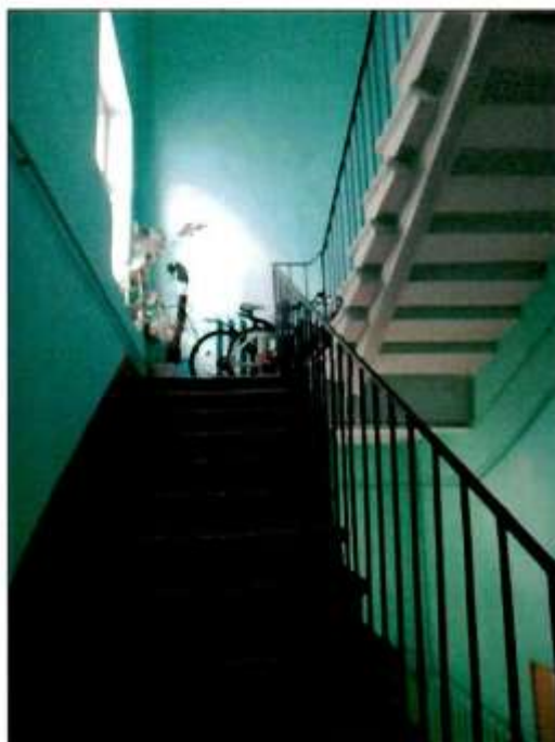
29. Подъезд № 2. Лестница. Общий вид.
