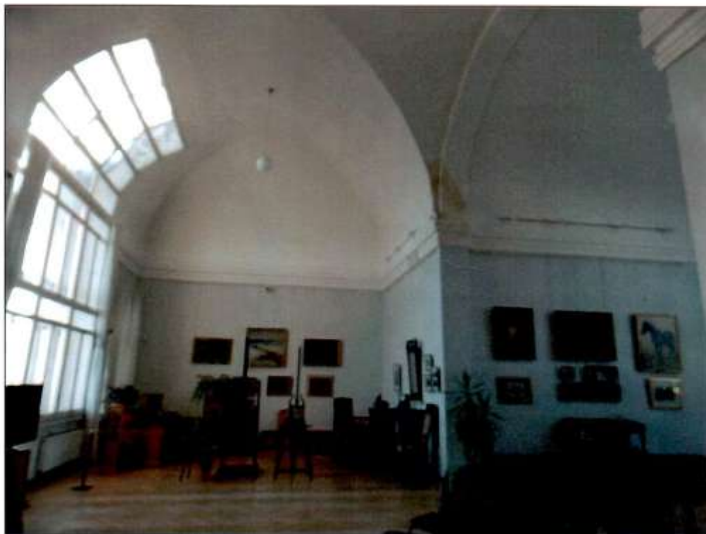
44. Помещение в уровне мансардного этажа.
