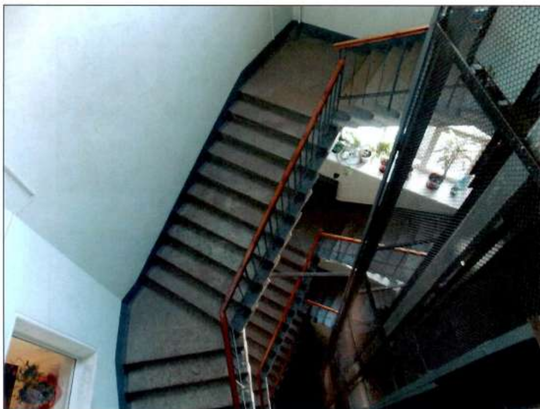
28. Подъезд № 1, Лестница, Общий вид.
