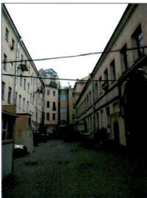
14. Внутренний двор. Вид с запада на восток.
