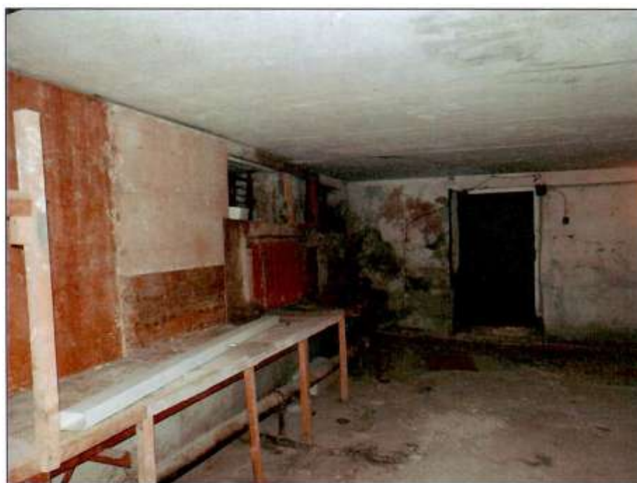
27. Помещение в уровне подвального этажа.
