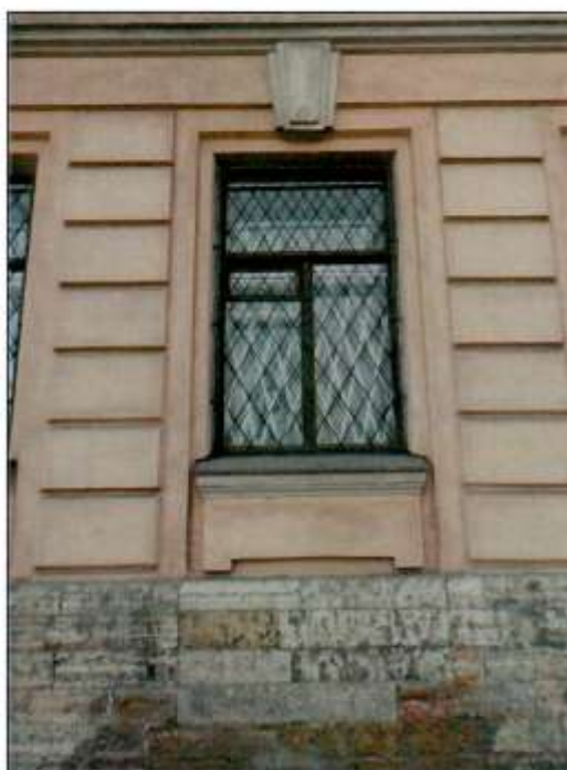
10. Южный фасад. Оконный проем в уровне 1-го этажа.
