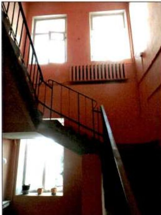
30. Подъезд № 3. Лестница. Общий вид.
