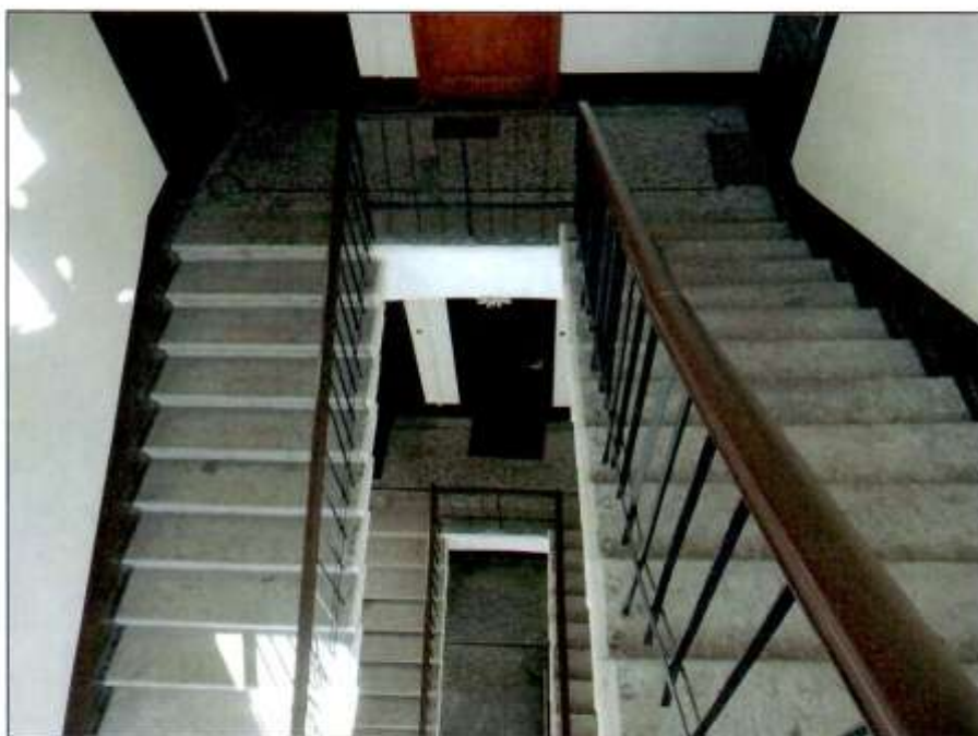
36. Подъезд № 8. Лестница. Общий вид.
