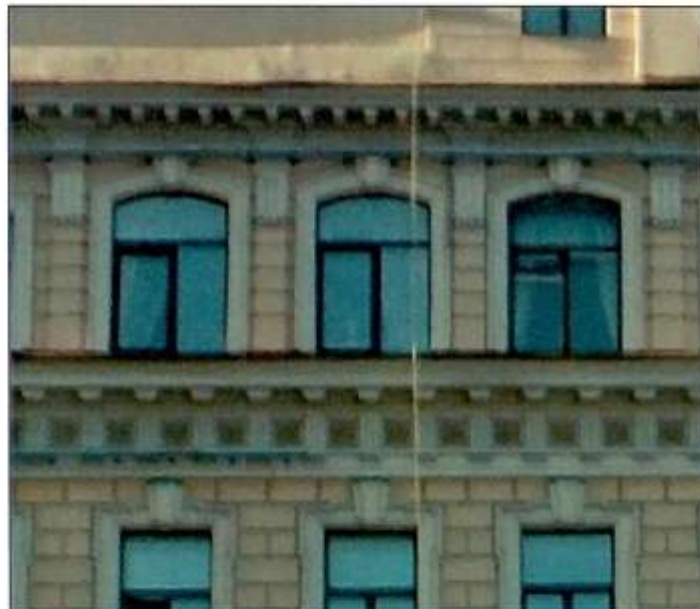
11. Северо-восточный фасад. Оконные проемы в уровне 4-го этажа.
