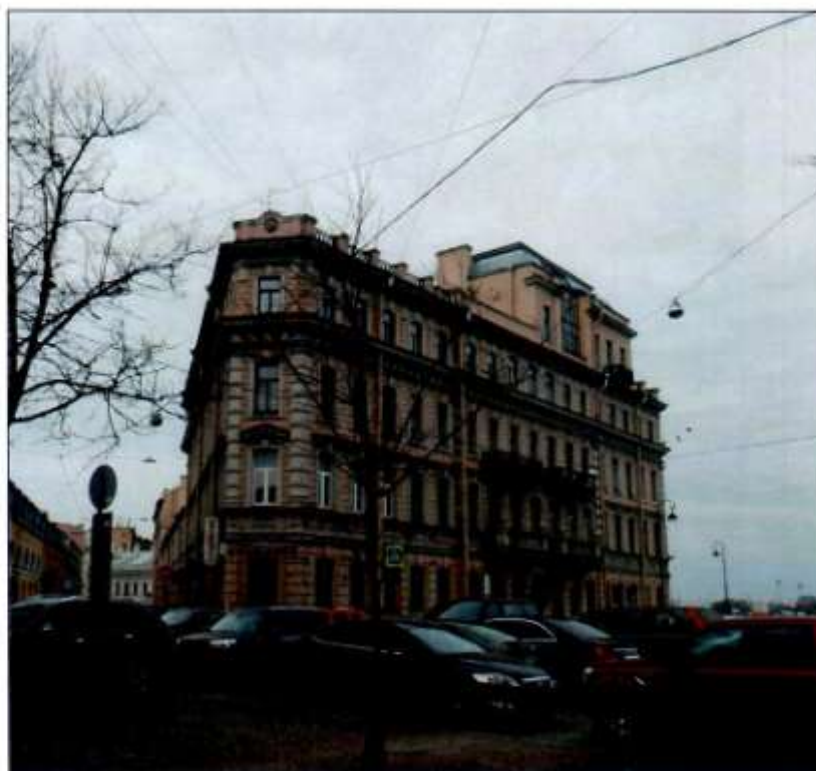
1. Общий вид с востока.
