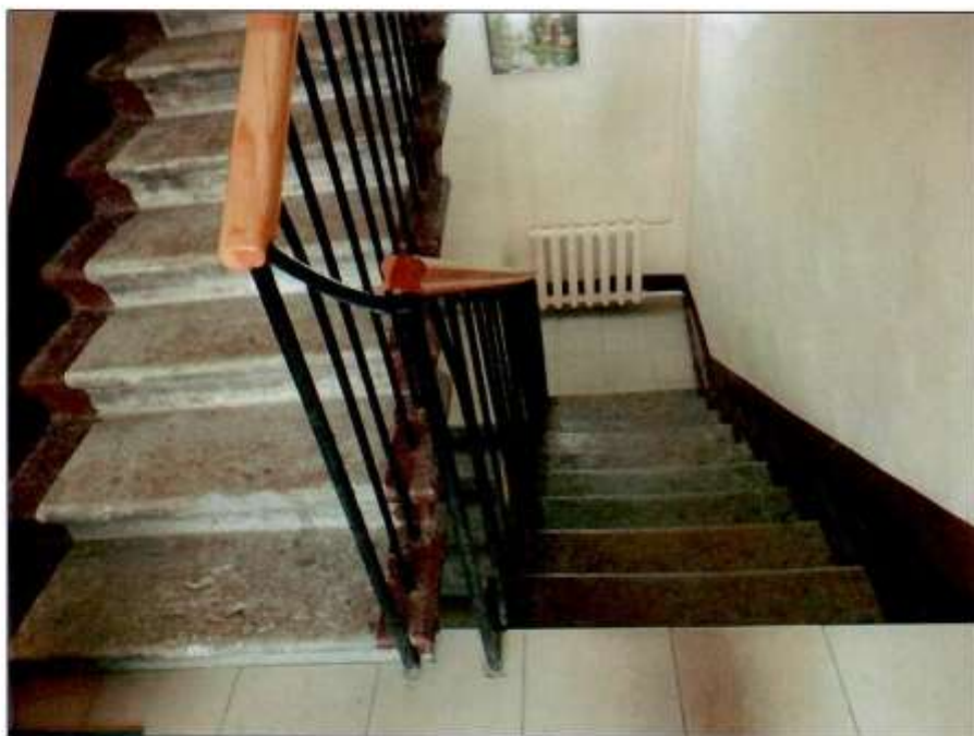
32. Подъезд № 5. Лестница. Общий вид.
