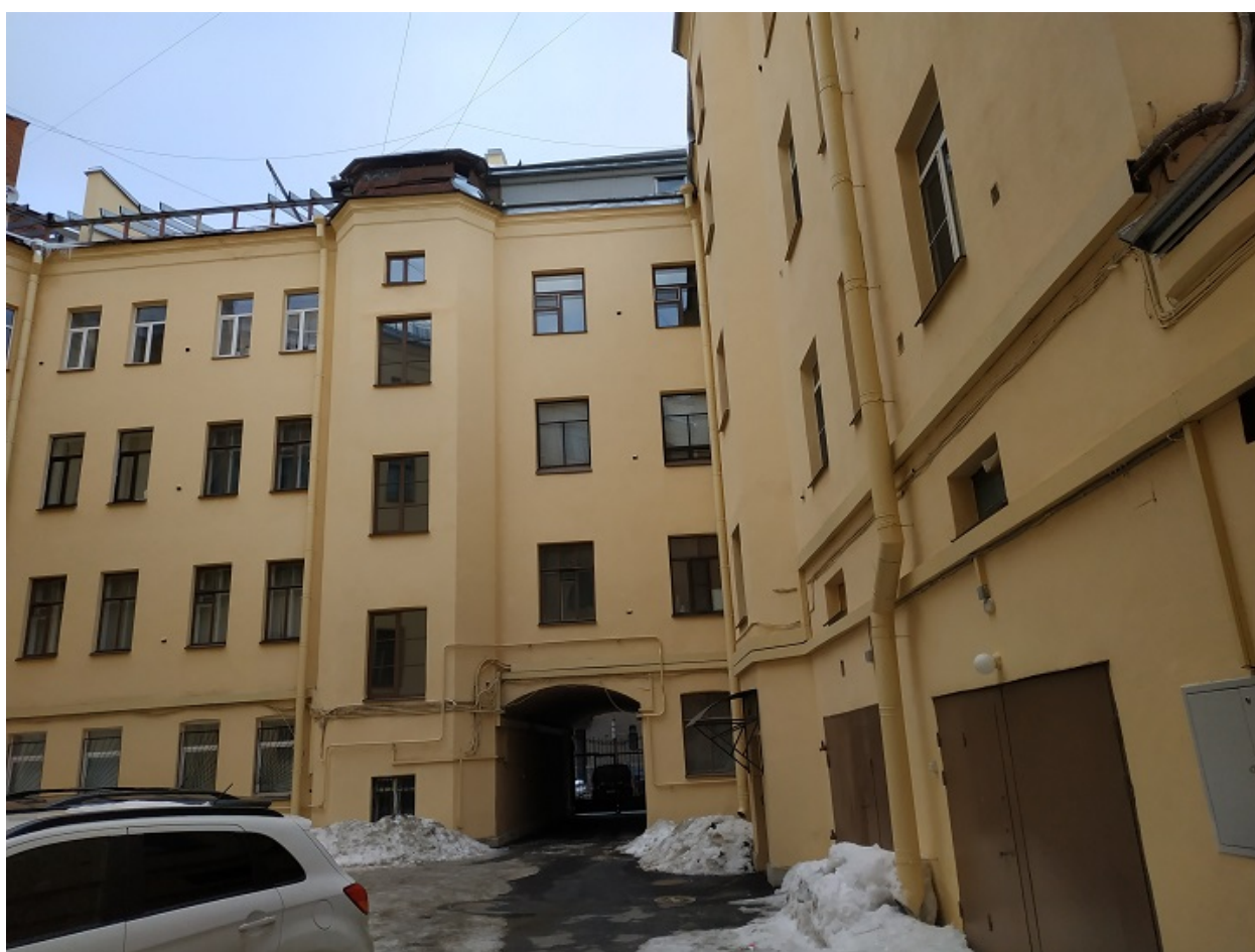
14. Здание по адресу: Санкт-Петербург, Каменноостровский проспект, д. 1-3. Фрагмент дворового фасада.
