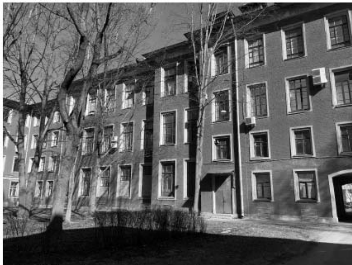
Фото 7. Вид на фасад, первый и подвальный этажи которого входят в границы проектирования.
