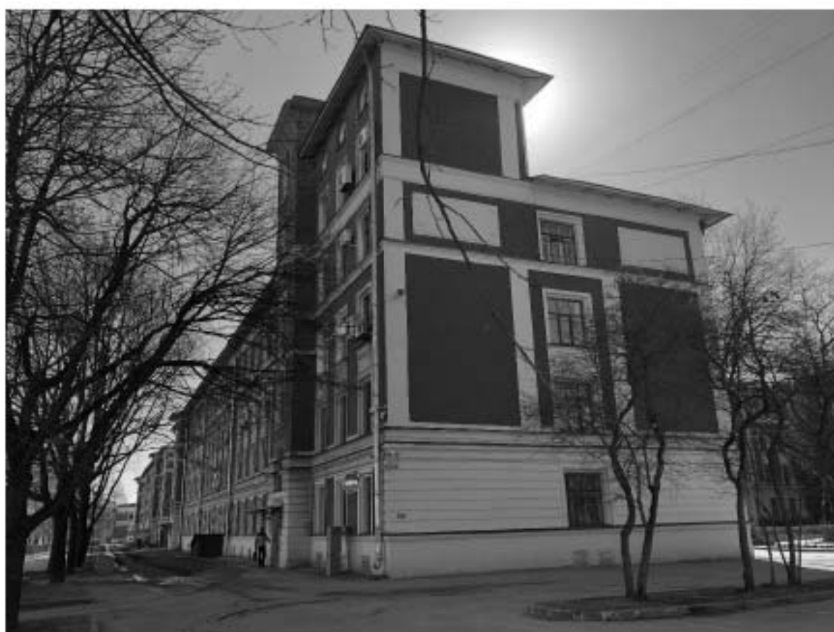
Фото 2. Вид на угол северо-западного и северо-восточного (по ул. Гидротехников) лицевых фасадов.
