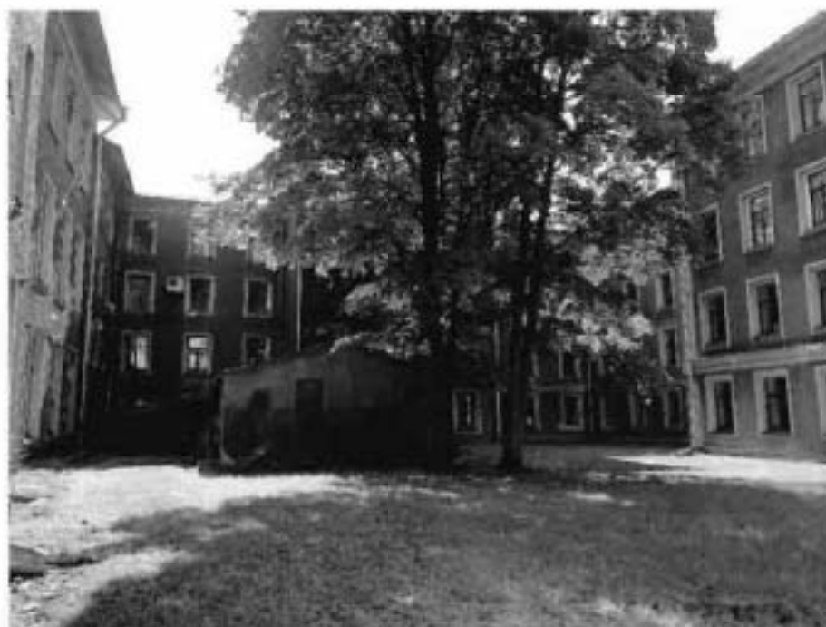
3.Вид на объект культурного наследия со стороны южного дворового фасада (здания 2-го корпуса)
