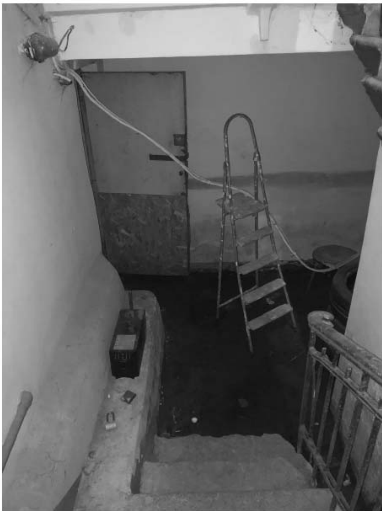
Фото 32. Вид на подвальные помещения с лестницы.
