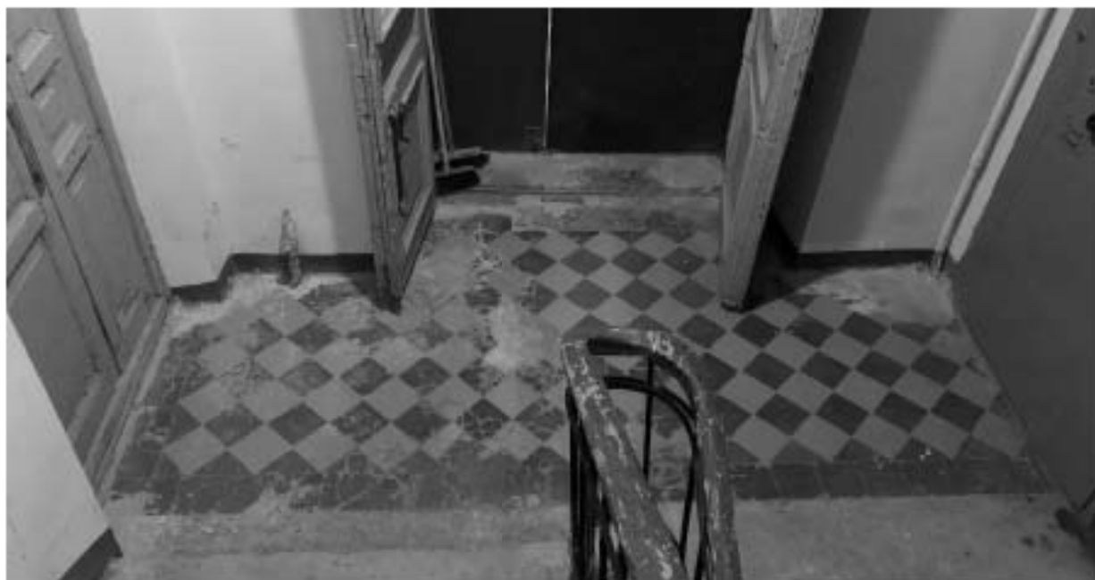
Фото 18. Вид на метлахскую плитку на межлестничной площадке.
