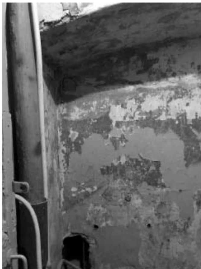
Фото 30. Вид на санузел.
