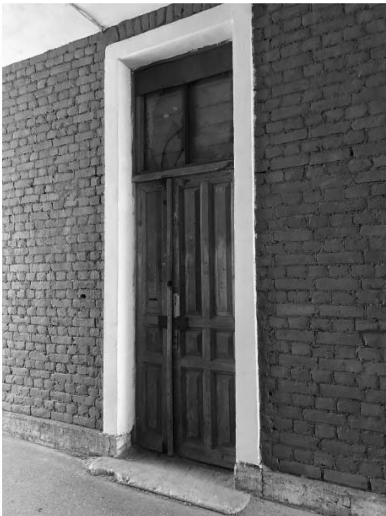
Фото 5. Вид на дверь в арочном проезде, через которую осуществляется вход в помещения, расположенные в границах проектирования.
