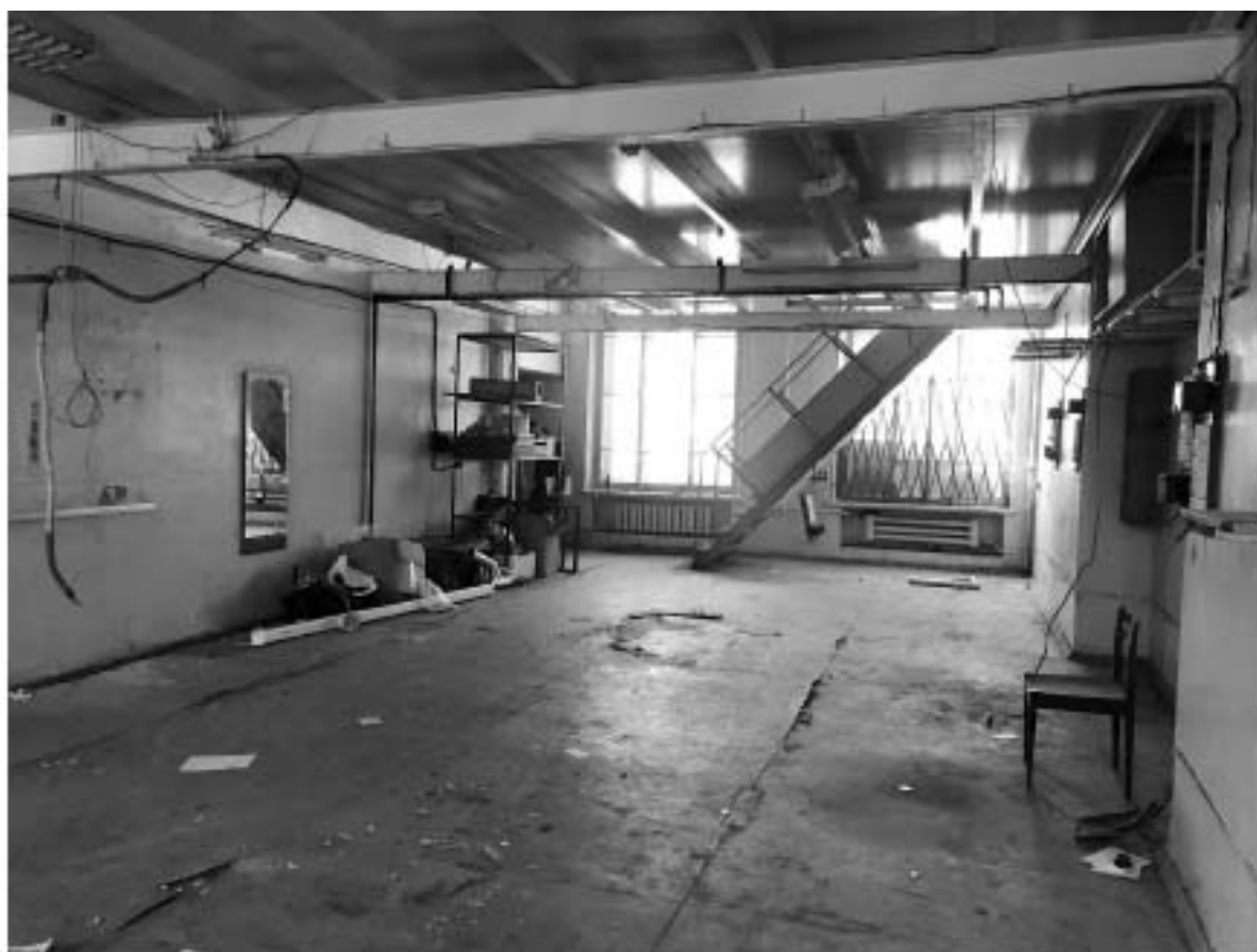
Фото 15. Вид на помещение хозяйственно-бытового назначения за аудиторией.
