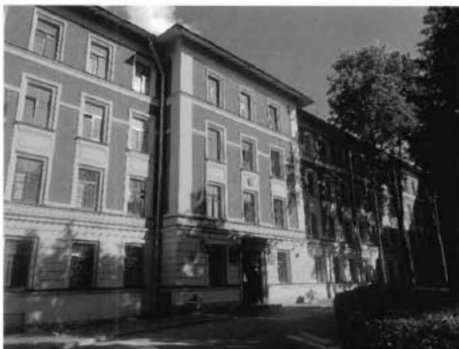
2.Фрагмент лицевого фасада объекта культурного наследия с западной стороны
