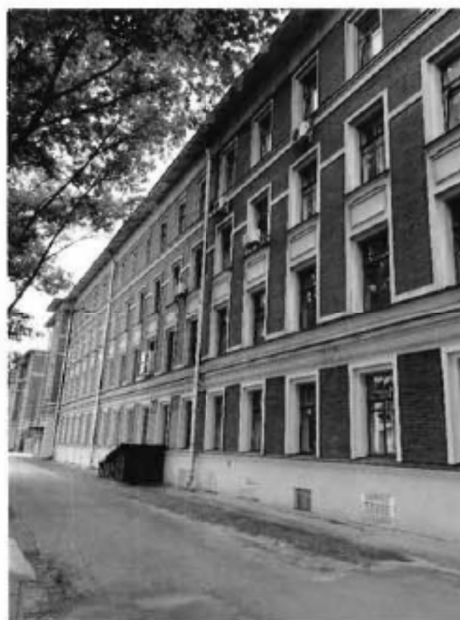
1. Вид на объект культурного наследия с северной стороны (здание 1-го корпуса)
