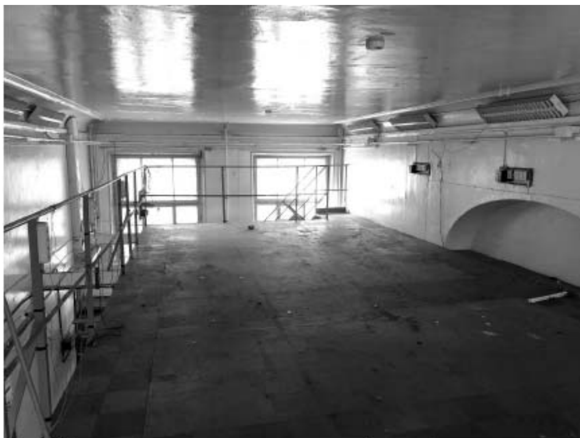
Фото 17. Металлическая антресоль в помещении хозяйственно-бытового назначения за аудиторией.
