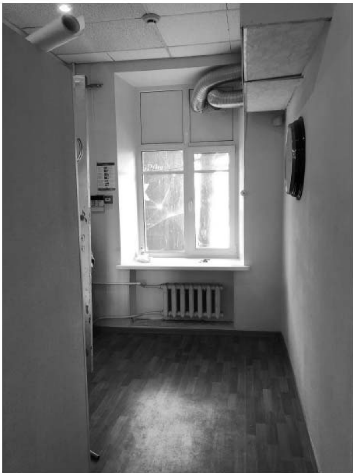
Фото 21. Вид на офисное помещение.
