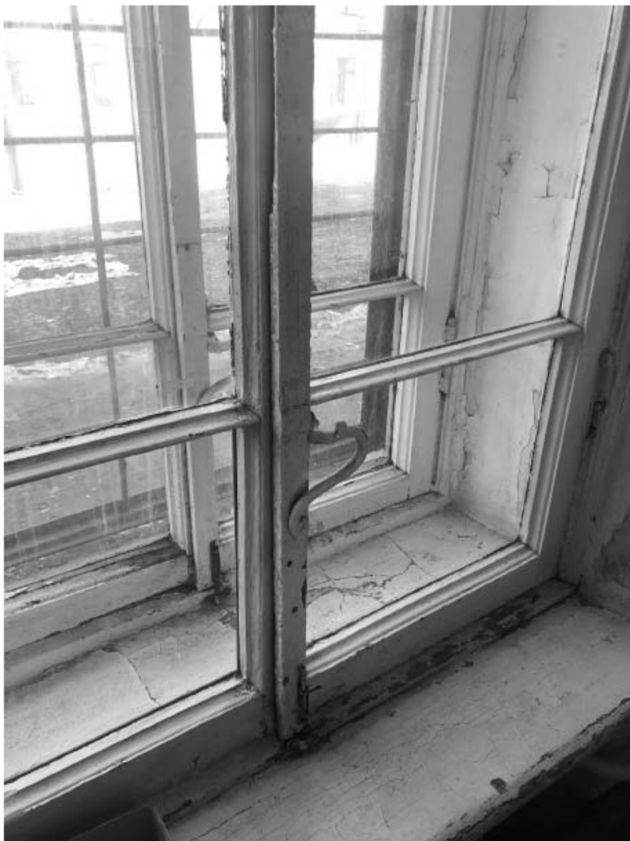
Фото 11. Фрагмент заполнения оконных проемов в аудитории.
