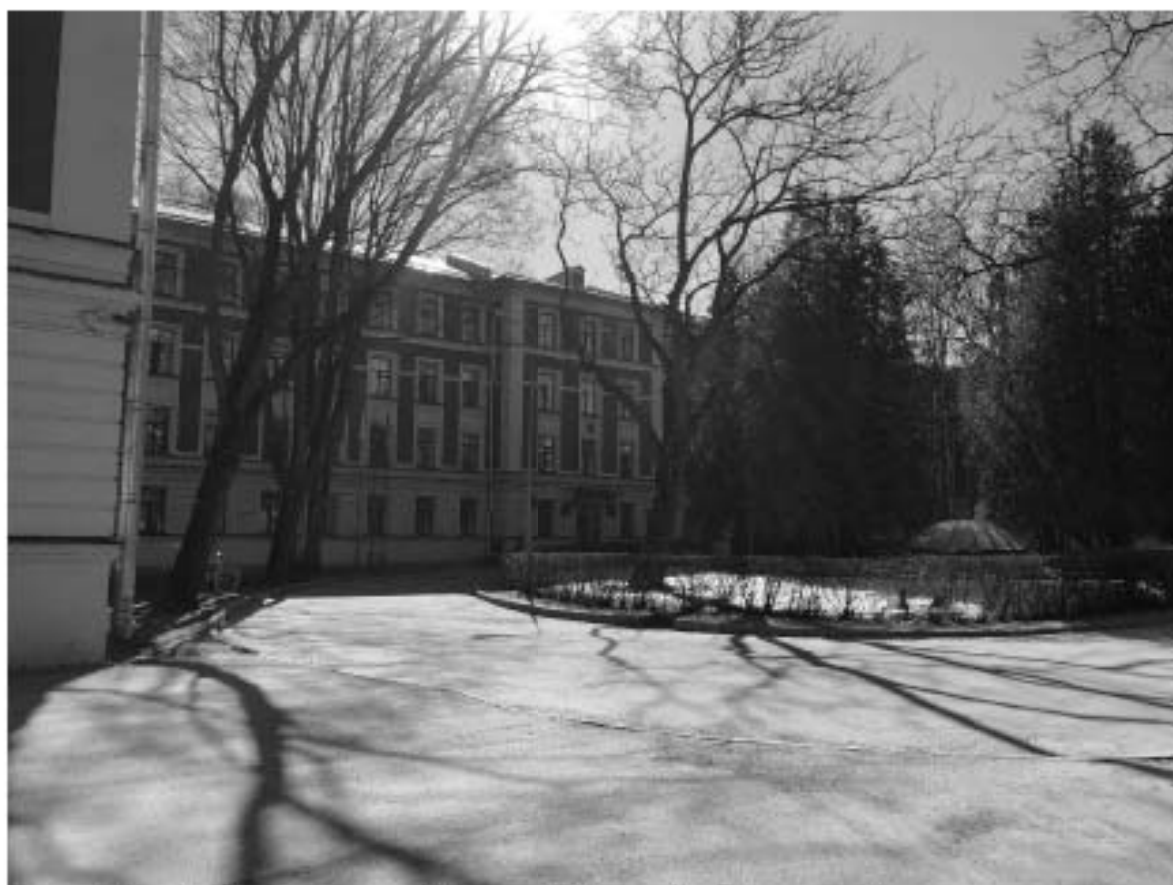
Фото 1. Северо-западный лицевой фасад. Вид на главный вход в здание.
