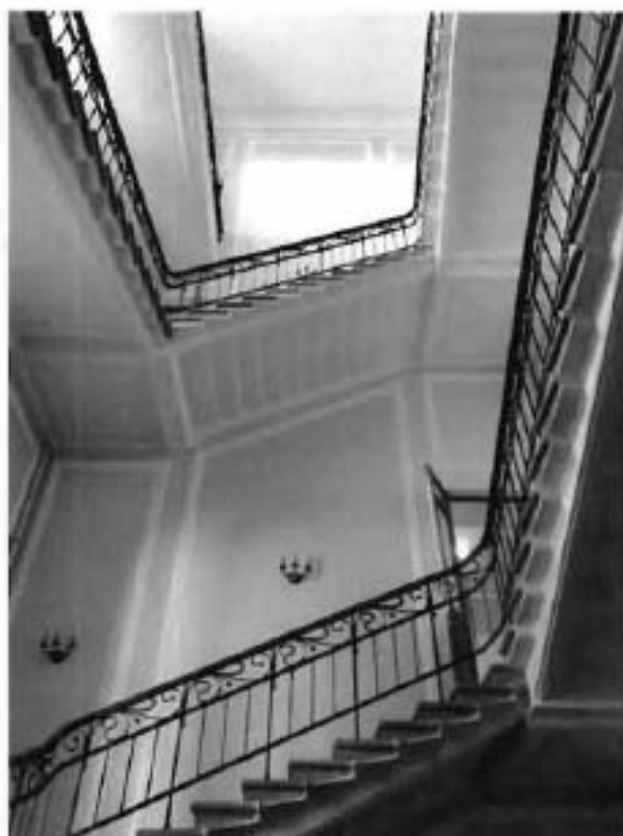
4. Парадная лестница пом. 21-Н в здании 1-го корпуса
