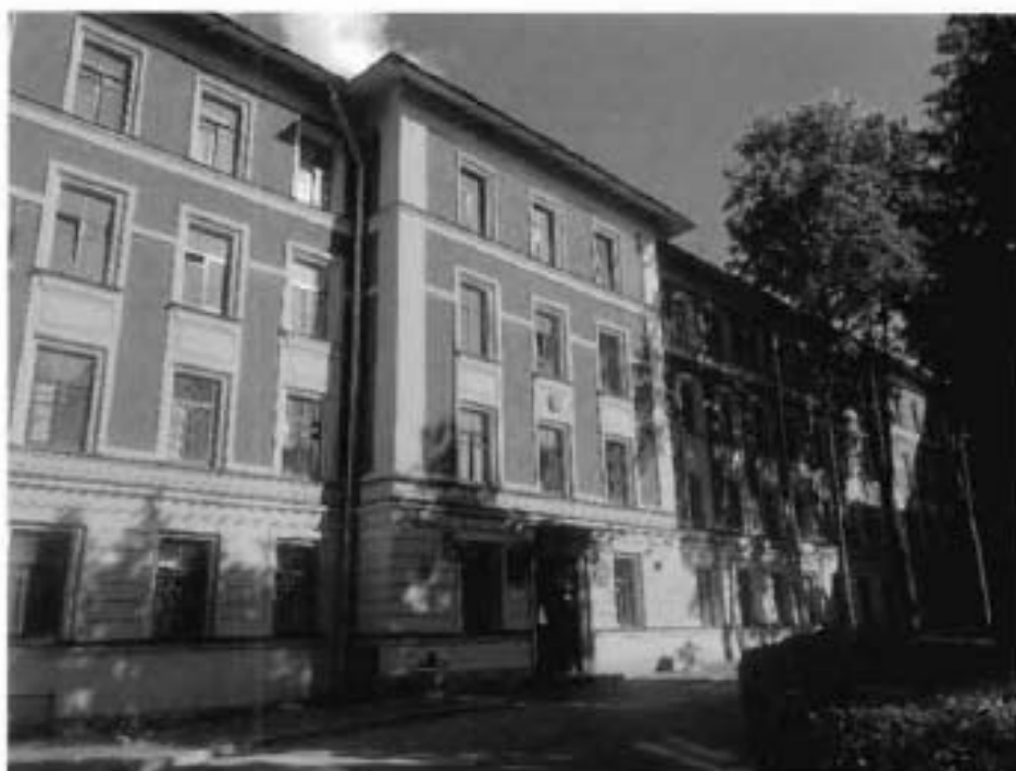
2.Фрагмент лицевого фасада объекта культурного наследия с западной стороны
