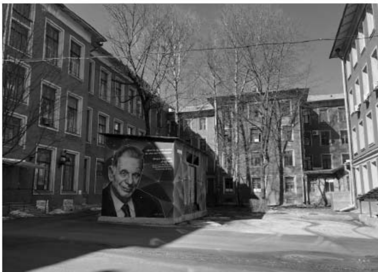
Фото 3. Вид на дворовые фасады северо-западной части двора.
