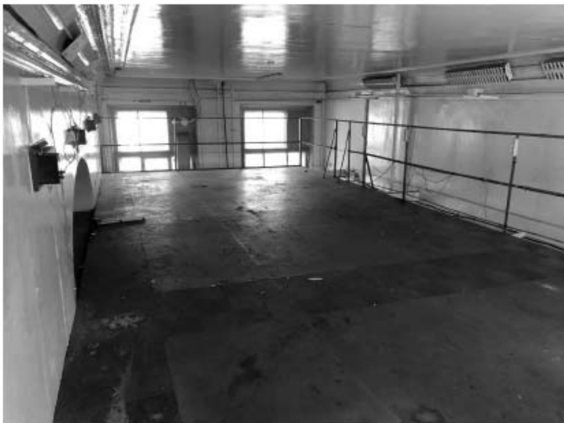
Фото 16. Металлическая антресоль в помещении хозяйственно-бытового назначения за аудиторией.
