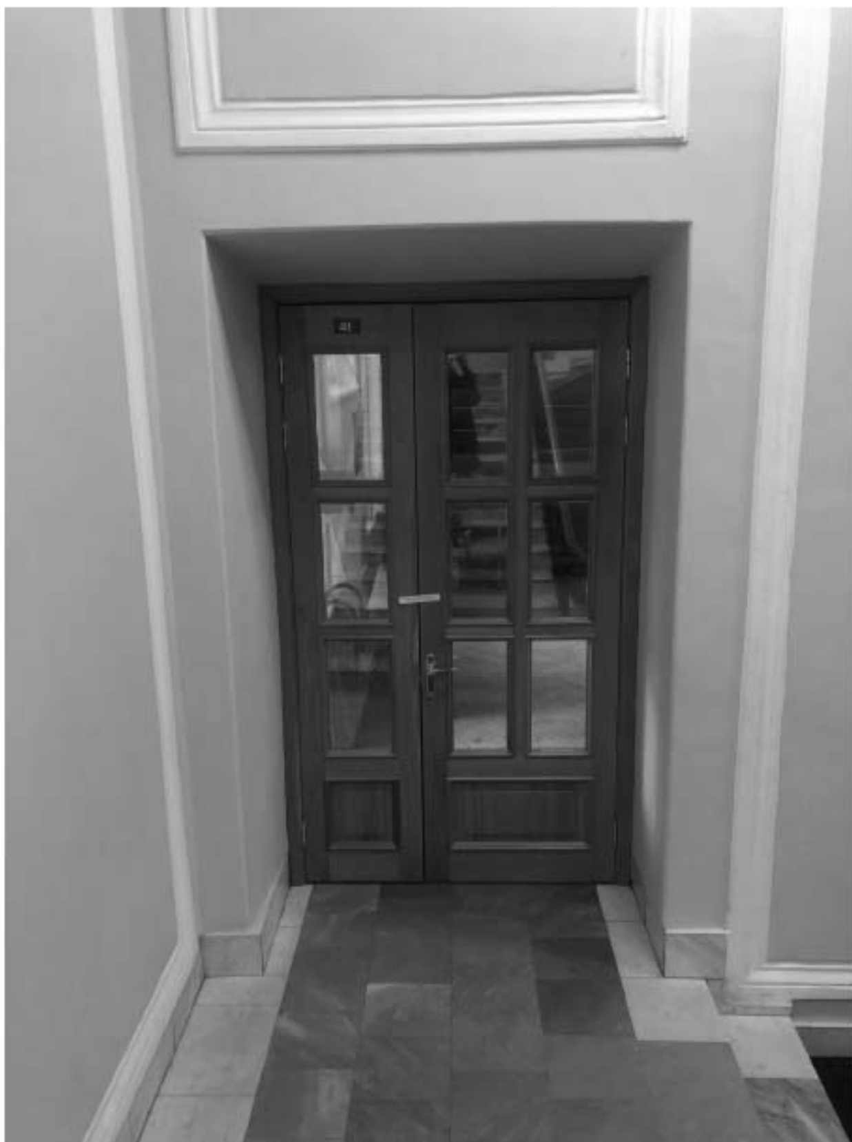
Фото 6. Вид на вход в аудиторию.
