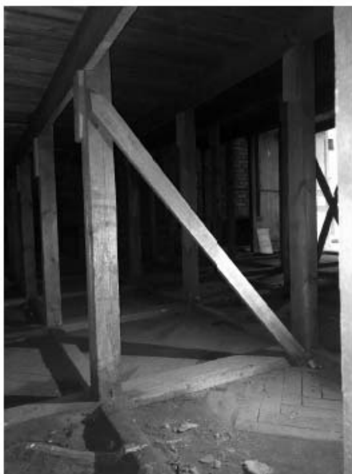
Фото 13. Вид на конструкцию деревянного «амфитеатра» в аудитории.
