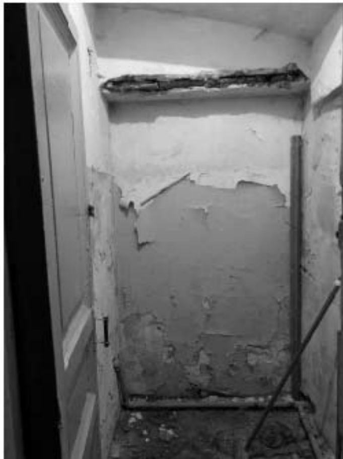
Фото 31. Вид на санузел.
