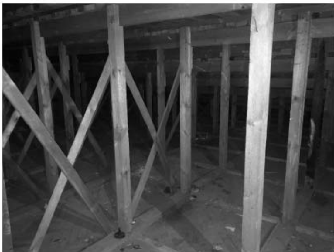
Фото 12. Вид на конструкцию деревянного «амфитеатра» в аудитории.
