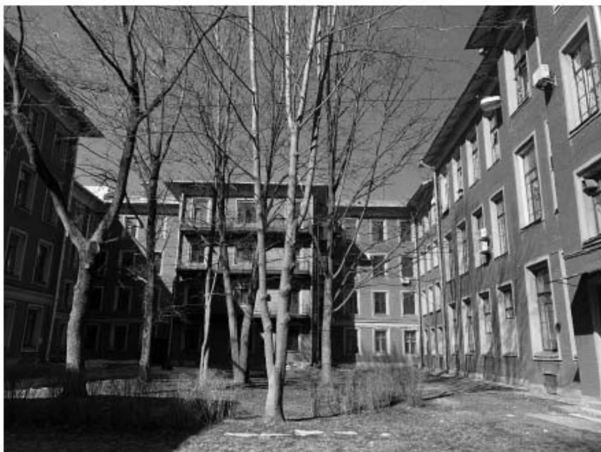
Фото 6. Вид на дворовые фасады юго-западного двора.
