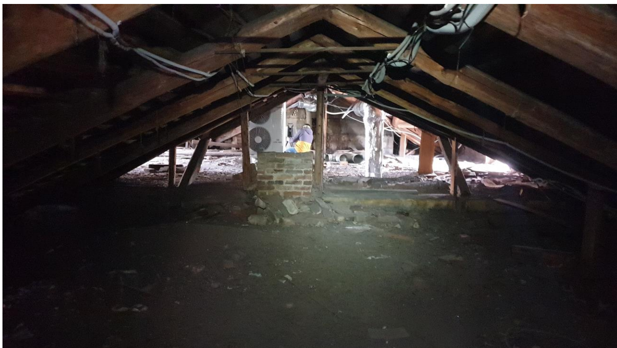
Илл. 19. Общий вид на чердачное помещение.
