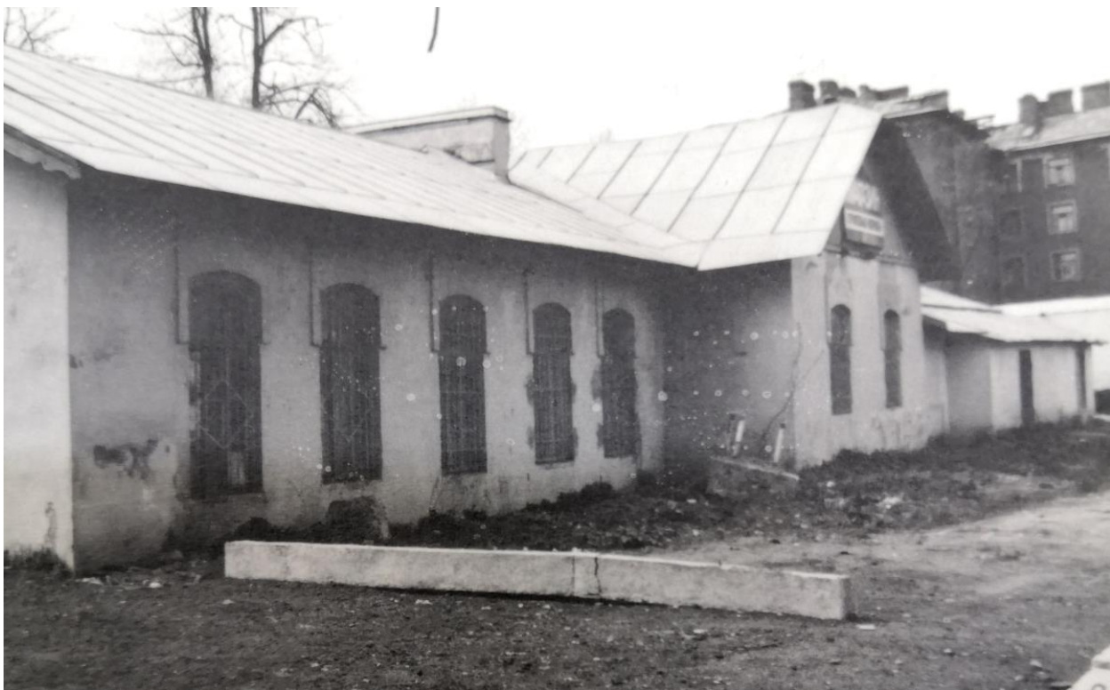
Илл. 22 Общий вид на здание б.бани с запада Увеличенный фрагмент. 1999 г. С. Шмид // Архив КГИОП.
