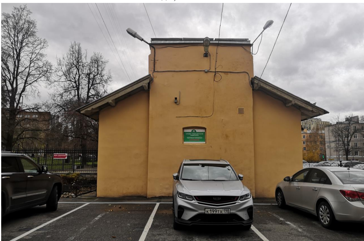
Илл. 4. Вид на восточный торцевой фасад. Адрес: Санкт-Петербург, ул. Гидротехников, д.5, лит. А.
