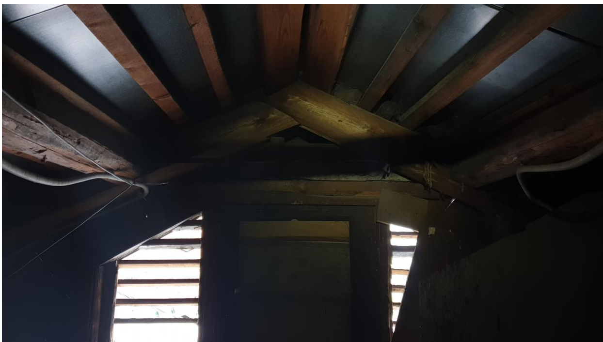
Илл. 17. Общий вид на чердачное помещение.
