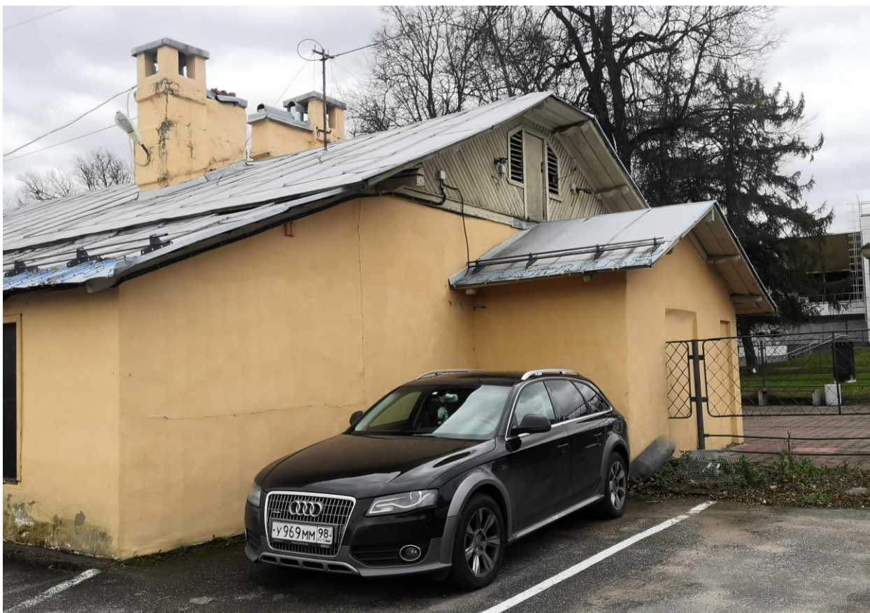
Илл. 11. Общий вид на западный фасад. Адрес: Санкт-Петербург, ул. Гидротехников, д.5, лит. А.
