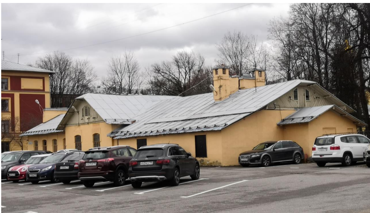
Илл. 12. Общий вид на здание с северо-запада. Адрес: Санкт-Петербург, ул. Гидротехников, д.5, лит. А.
