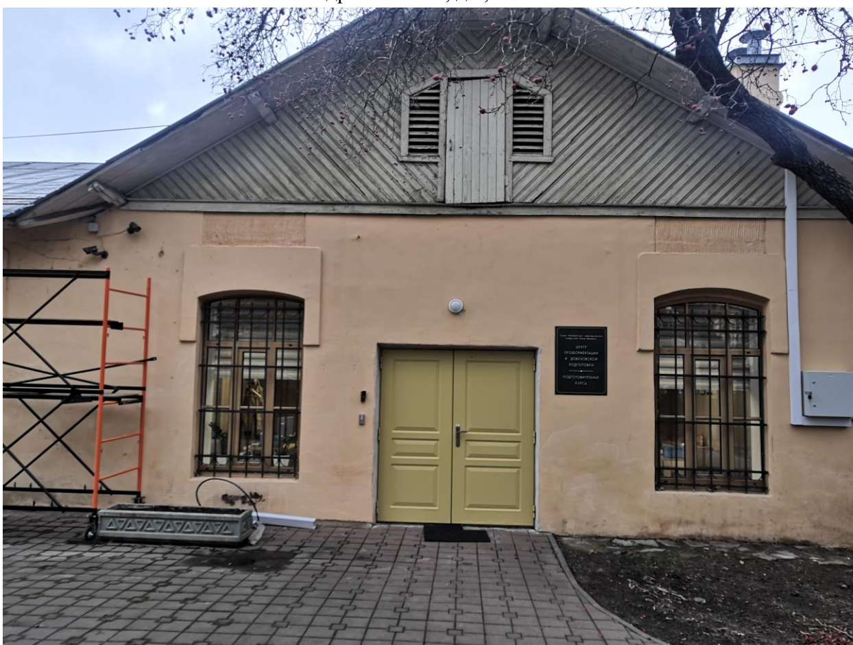
Илл. 16. Вид на центральную часть южного фасада. Адрес: Санкт-Петербург, ул. Гидротехников, д.5, лит. А.
