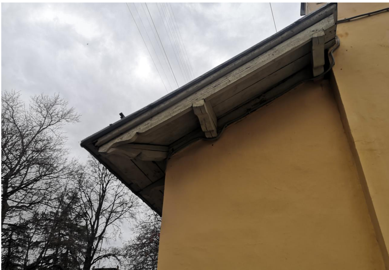
Илл. 5. Вид на резные кобылки крыши.
