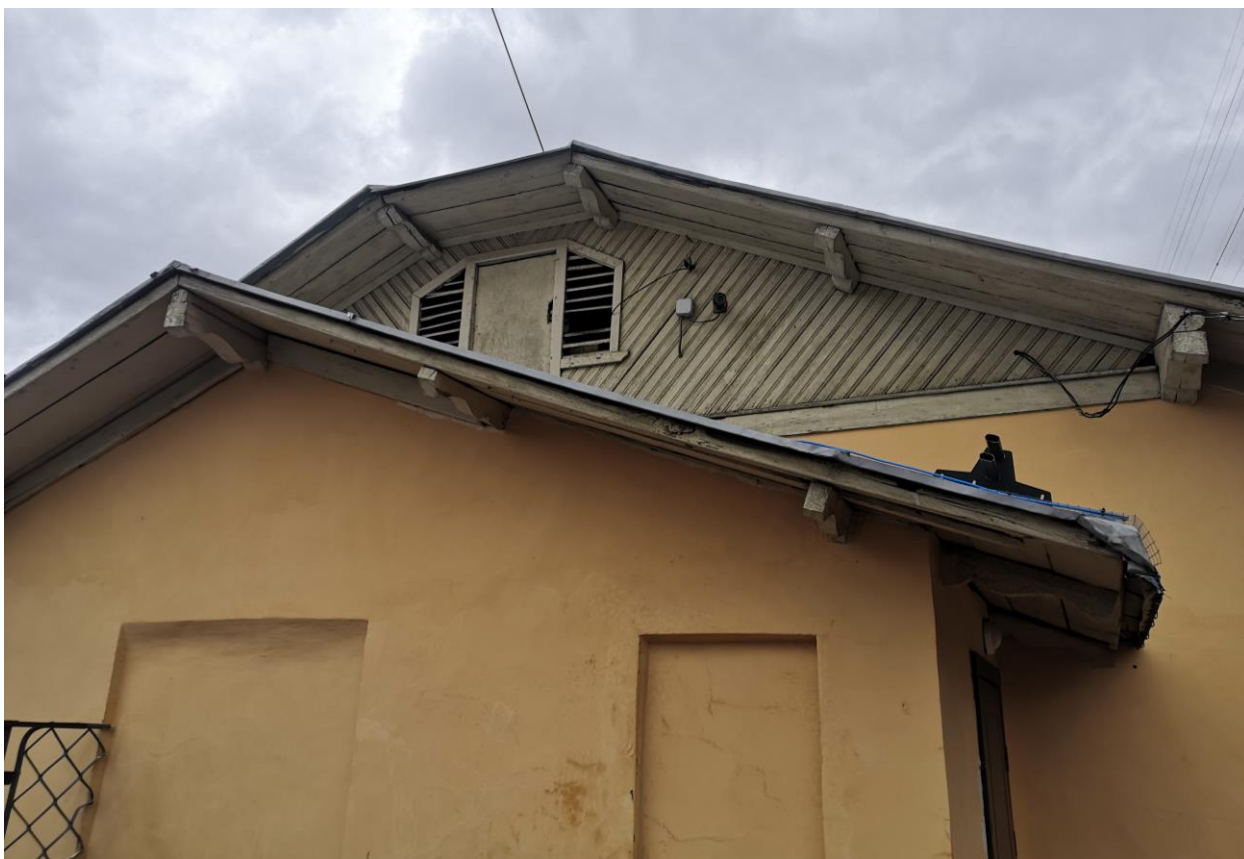
Илл. 13. Вид на фронтон западного фасада.
