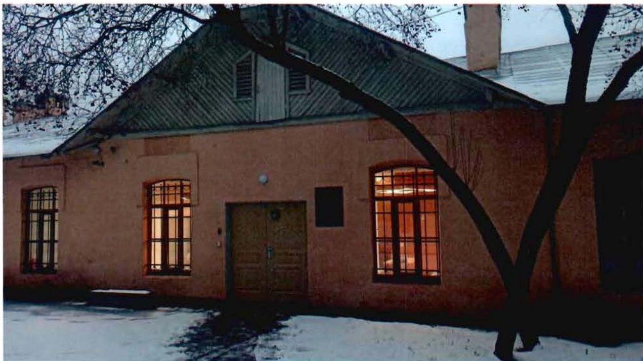
2. Вид на южный фасад объекта культурного наследия.
