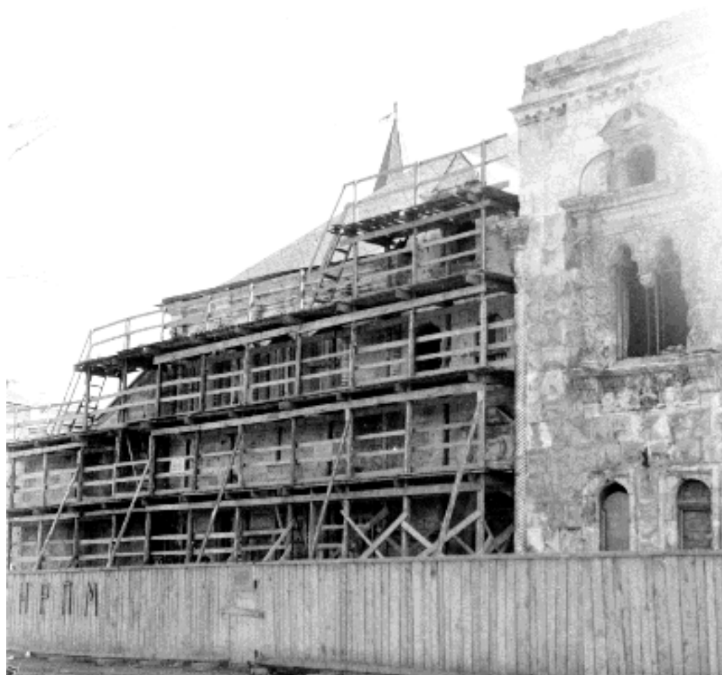
Илл.97 Ремонт здания Трапезной палаты. Фото конца 1970-х гг.
