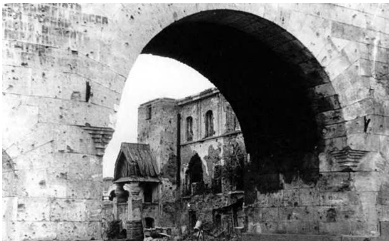
Илл.91. Арка, ведущая на территорию Фёдоровского городка, город Пушкин, (Главные ворота у Трапезной палаты) 1969 г. 1982 г., шифр Ар 96-Ник - ЦГАКФФД. (Академический пр., 14-30; Б.Фермерская дорога).
