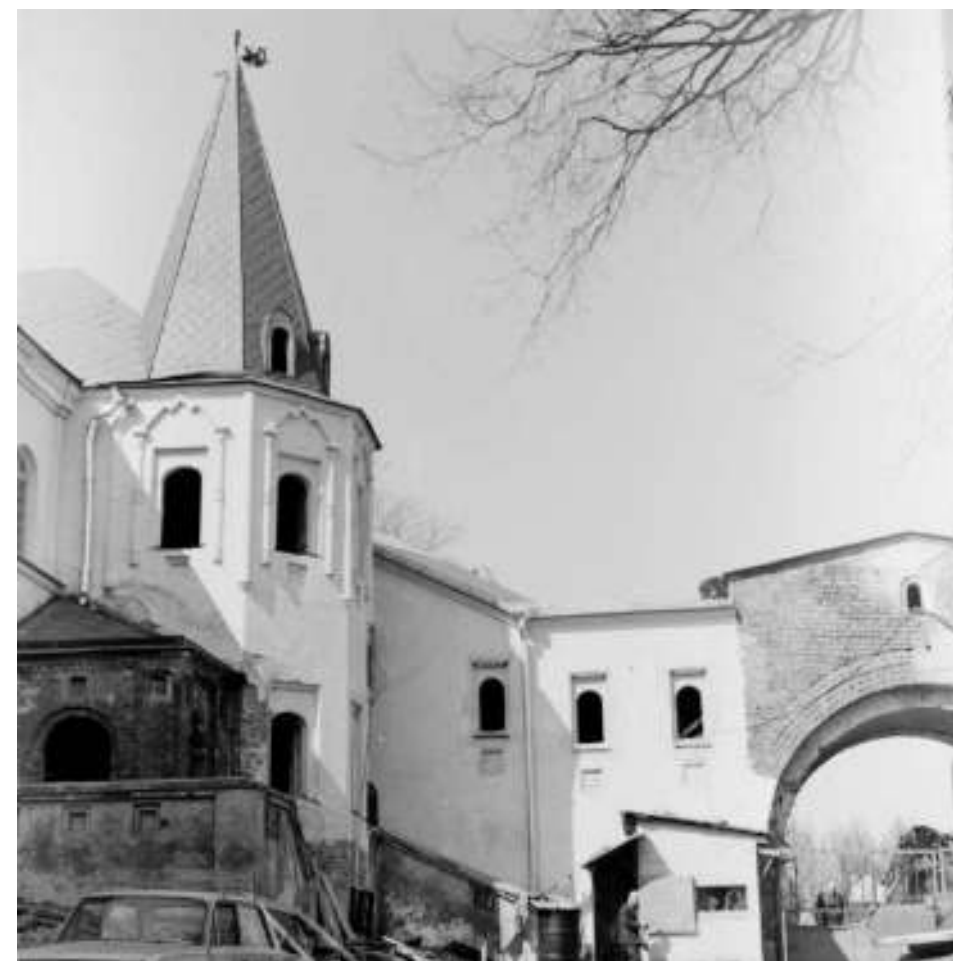
Илл.98. Фото конца 1970-х гг. Трапезная палата после ремонта.
