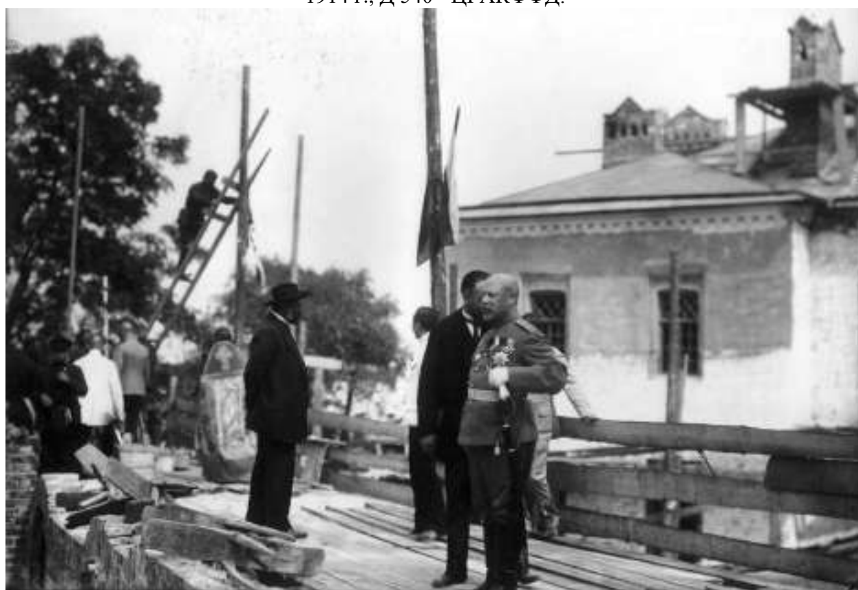
Илл.28. Молебен на начало строительства Дома дьяконов. 1914 г. Фото 29 июня 1914 г., шифр Д 536 - ЦГАКФФД.
