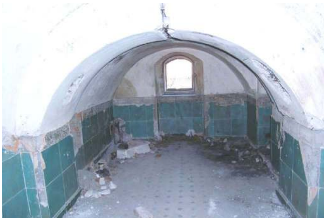
Илл.139. Подвал. Общий план помещения умывальной с изразцами. Фото 2008 г.
