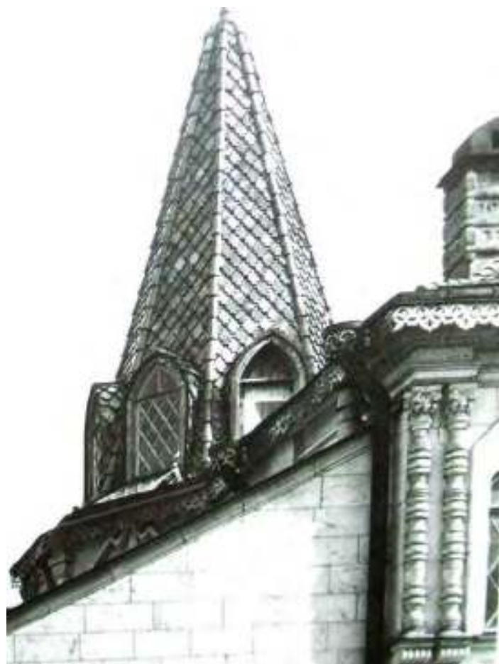
Илл.78. Илл.79. Трапезная палата. Фото до 1941 г. Западный фасад. Федоровский городок. Фрагменты кровли и карнизов с причелинами.*
