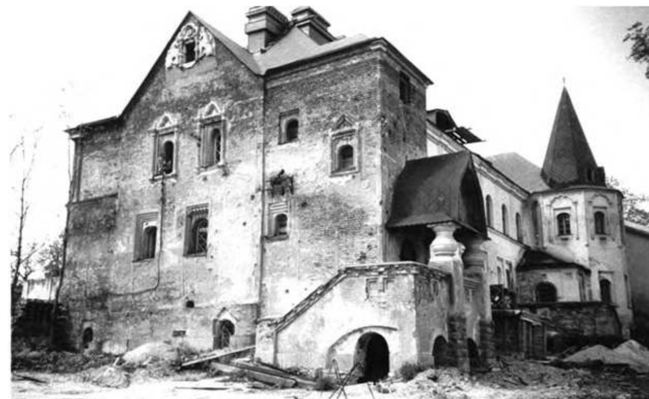
Илл.92. Вид одного из зданий городка (Трапезная палата). Архитектор С.С. Кричинский. Фото 1982 г., шифр Ар 14-89, ЦГАКФФД.
