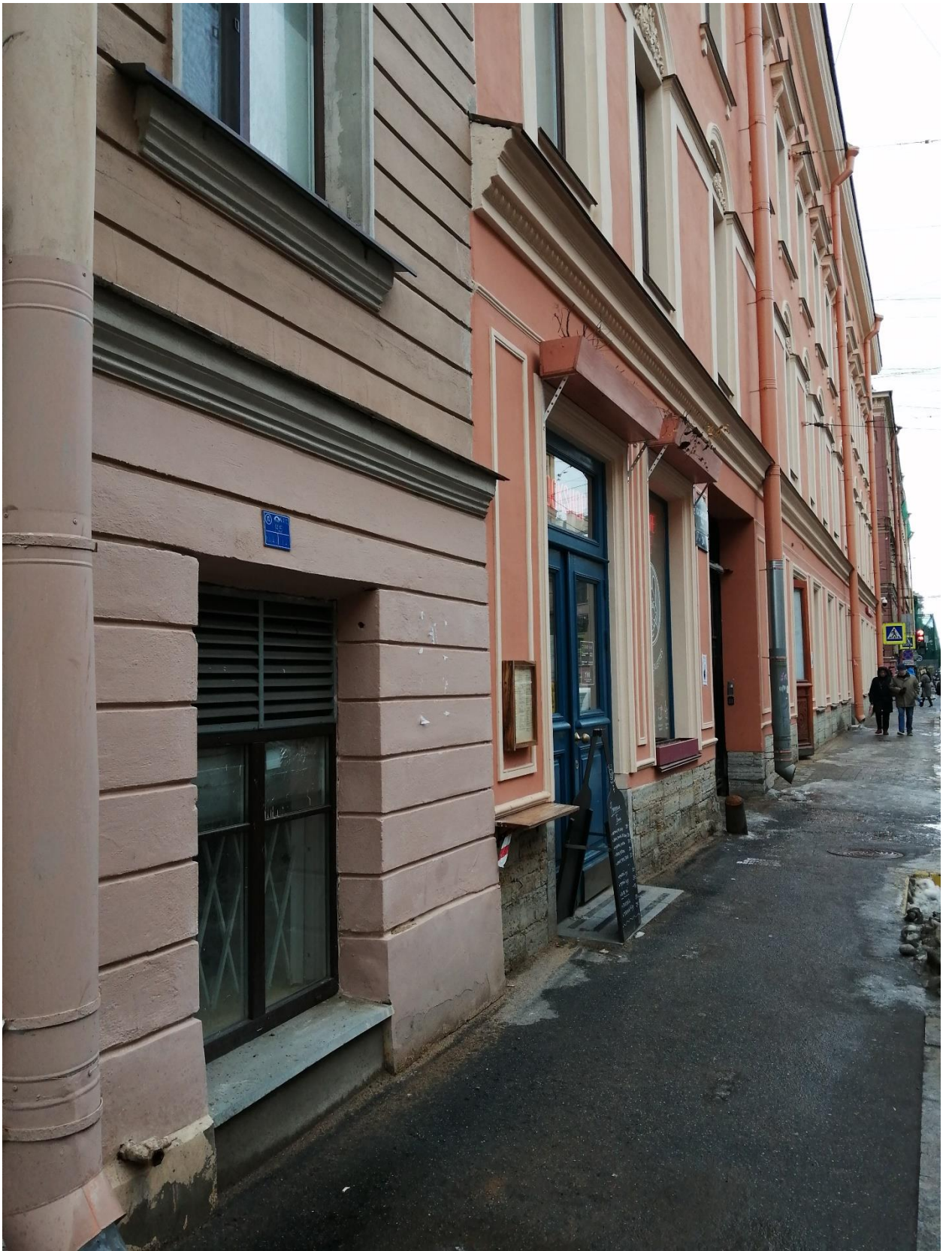
Фото 6. Место выполнения планируемых земляных работ (выполнение шурфа в месте ввода сетей теплоснабжения в здание по адресу Санкт-Петербург, Казанская ул., 22).
