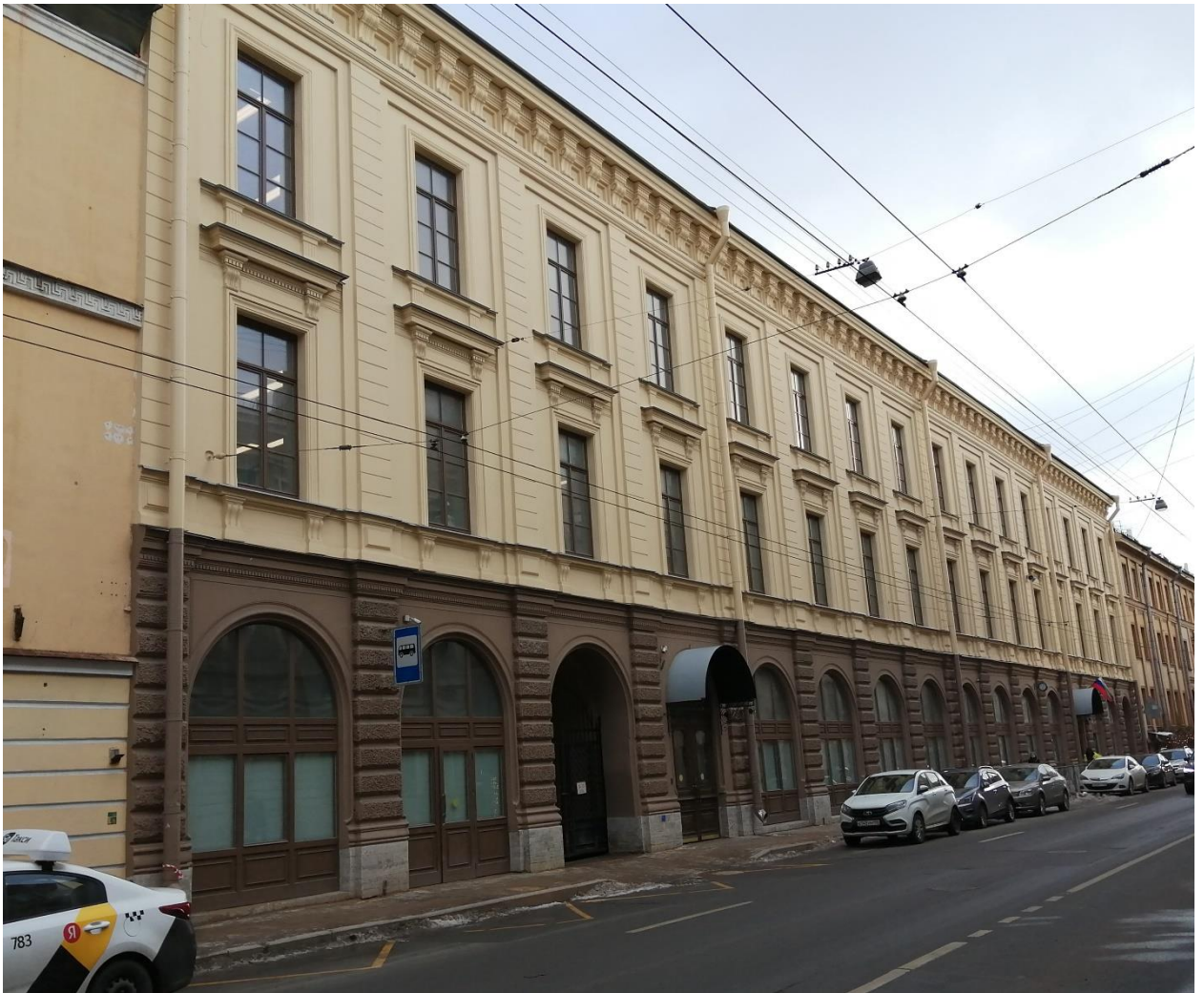
Фото 7. Выявленный объект культурного наследия «Здание женской гимназии и детского приюта при Санкт-Петербургском Воспитательном доме», расположенный по адресу: г. Санкт-Петербург, ул. Гороховая, д.20. Юго-западный фасад.
