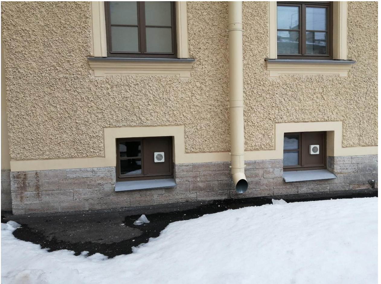
Фото 11. Выявленный объект культурного наследия «Здание женской гимназии и детского приюта при Санкт-Петербургском Воспитательном доме», расположенный по адресу: г. Санкт-Петербург, ул. Гороховая, д.20. Юго-восточный фасад, фрагмент. Место выполнения планируемых земляных работ (выполнение шурфа в месте ввода сетей теплоснабжения в здание по адресу Санкт-Петербург, гороховая ул., 20).
