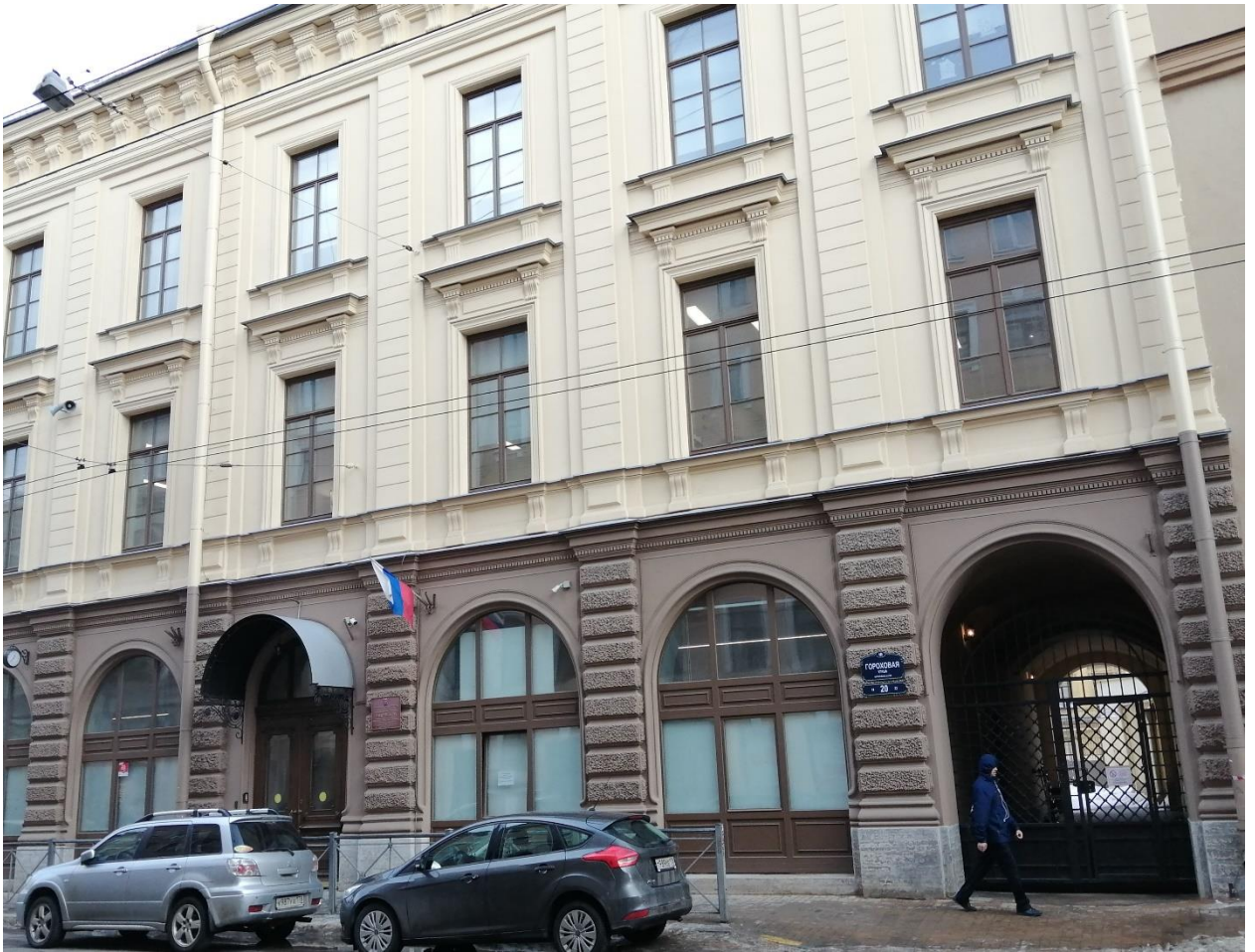
Фото 8. Выявленный объект культурного наследия «Здание женской гимназии и детского приюта при Санкт-Петербургском Воспитательном доме», расположенный по адресу: г. Санкт-Петербург, ул. Гороховая, д.20. Юго-западный фасад. Фрагмент.
