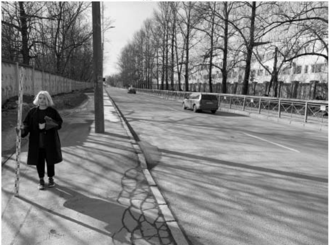
Рис. 36. Цимбалинский путепровод-2022. Точка фотофиксации 8, вид на северо-запад.
