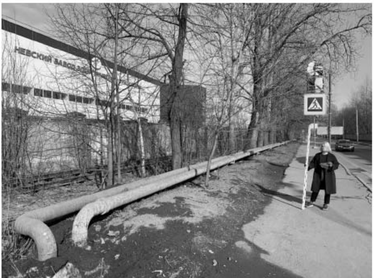
Рис. 47. Цимбалинский путепровод-2022. Точка фотофиксации 10, вид на северо-восток.
