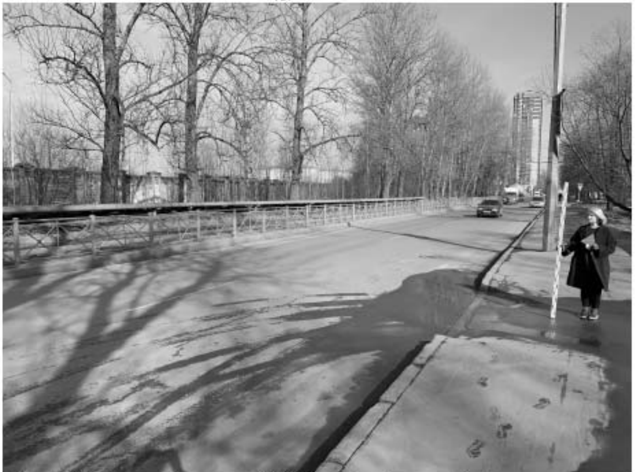
Рис. 34. Цимбалинский путепровод-2022. Точка фотофиксации 7, вид на северо-восток.
