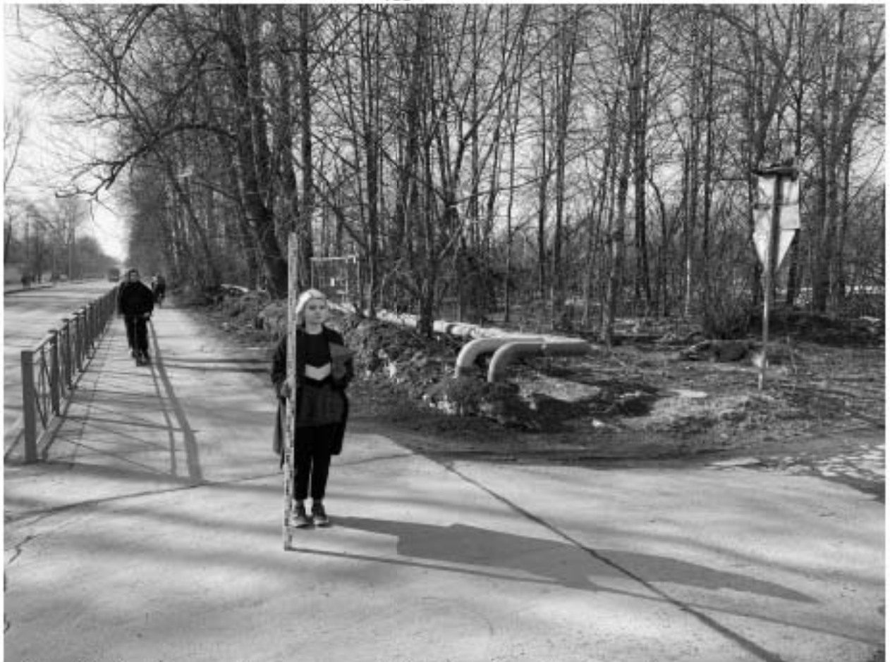
Рис. 26. Цимбалинский путепровод-2022. Точка фотофиксации 5, вид на северо-запад.
