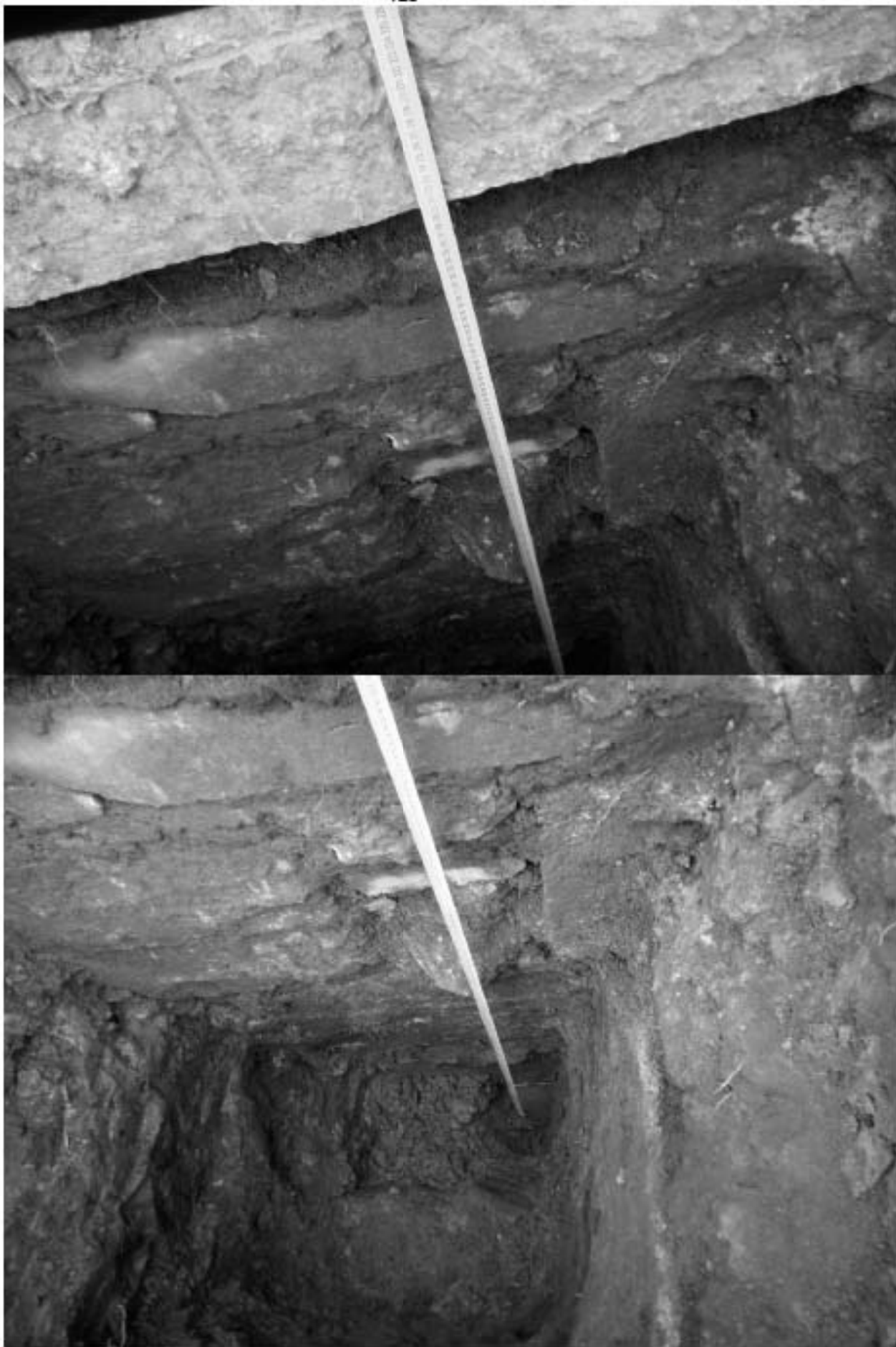
Рис. 65. Цимбалинский путепровод-2022. Шурф 2, юго-восточная стенка.
