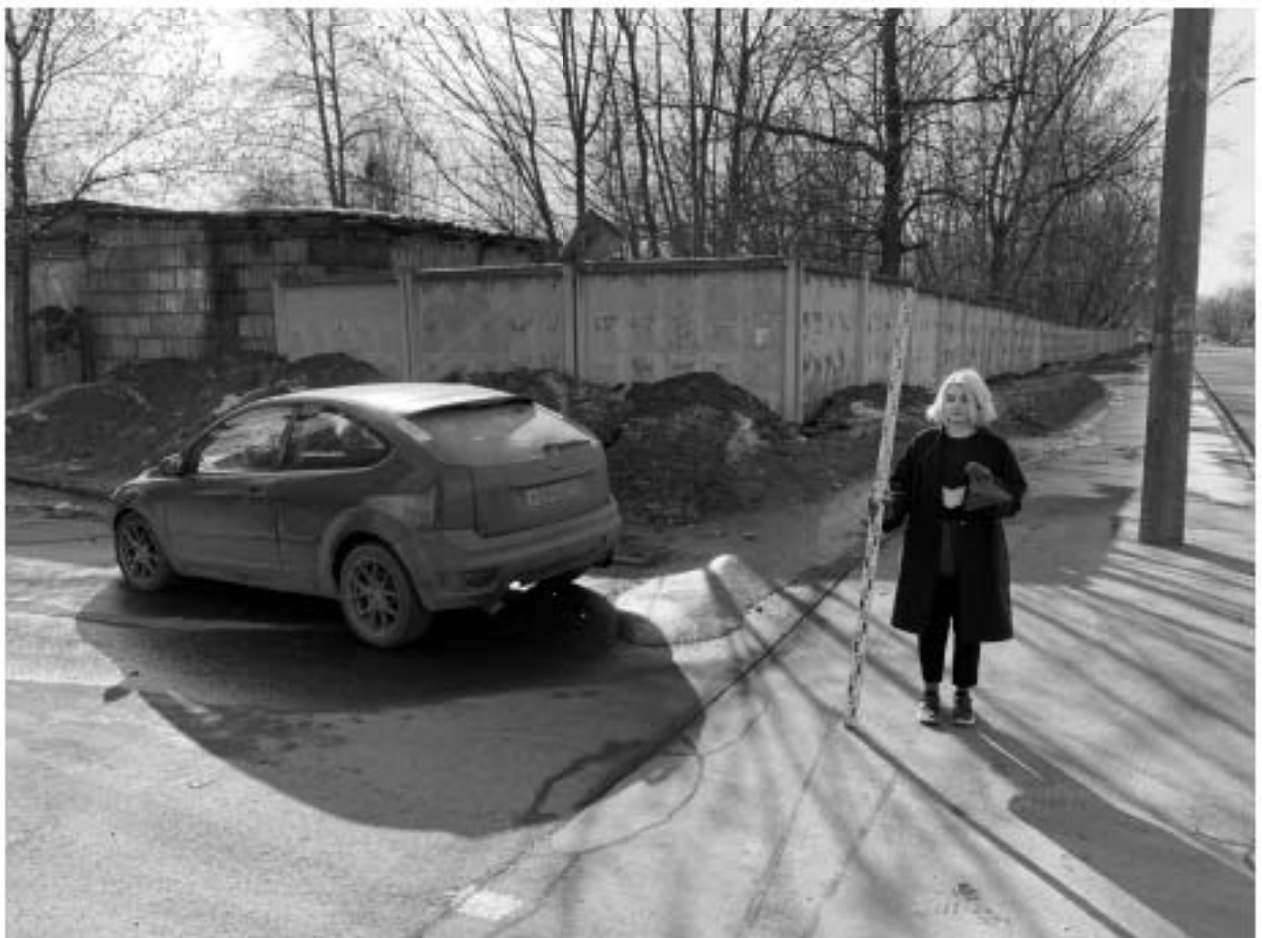
Рис. 37. Цимбалинский путепровод-2022. Точка фотофиксации 8, вид на юго-запад.
