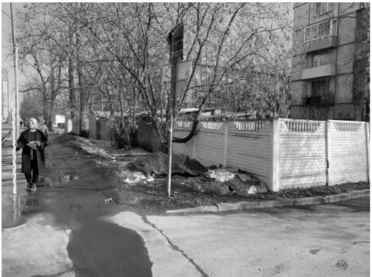
Рис. 39. Цимбалинский путепровод-2022. Точка фотофиксации 8, вид на юго-восток.
