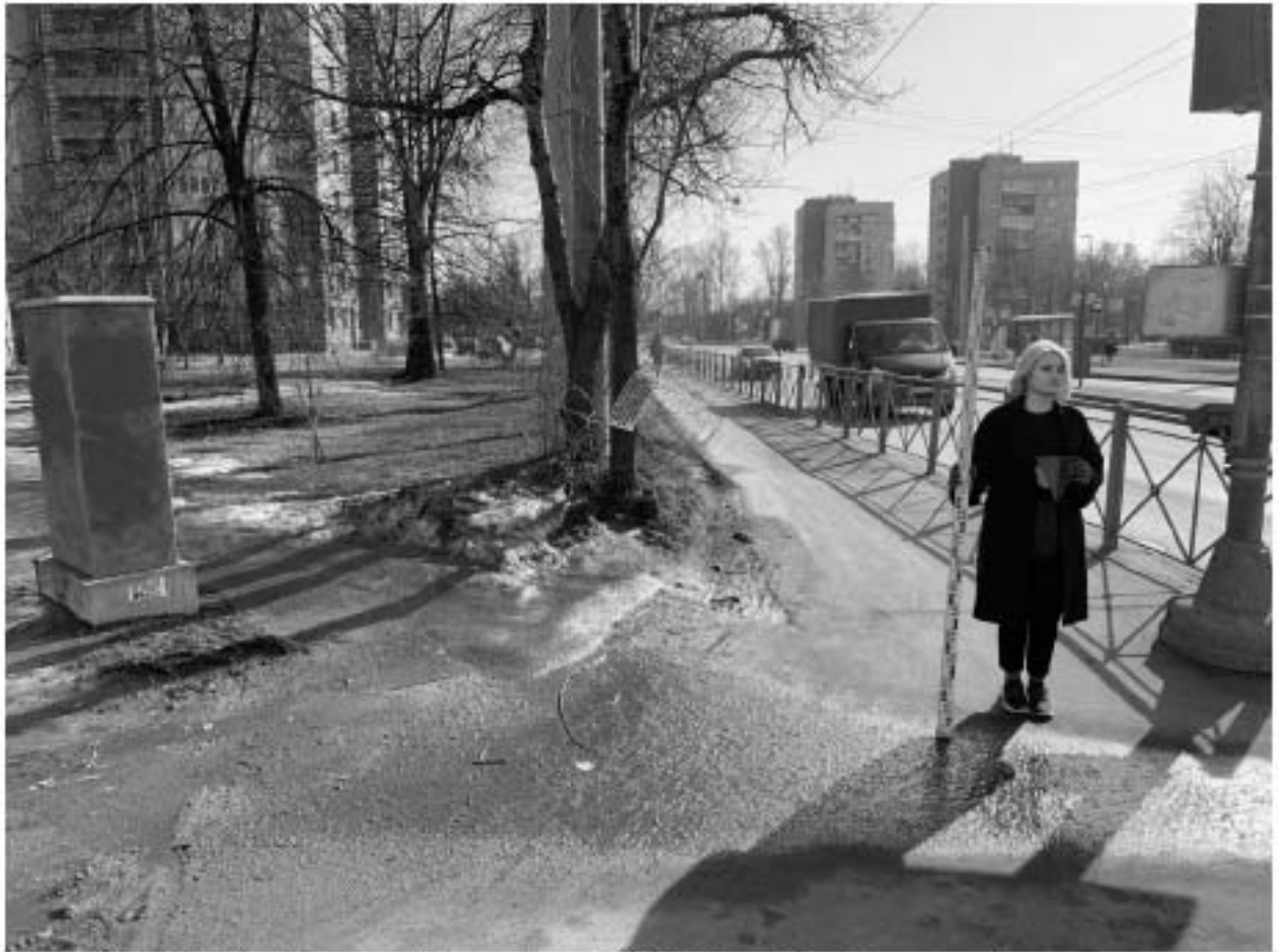
Рис. 18. Цимбалинский путепровод-2022. Точка фотофиксации 2, вид на юг.
