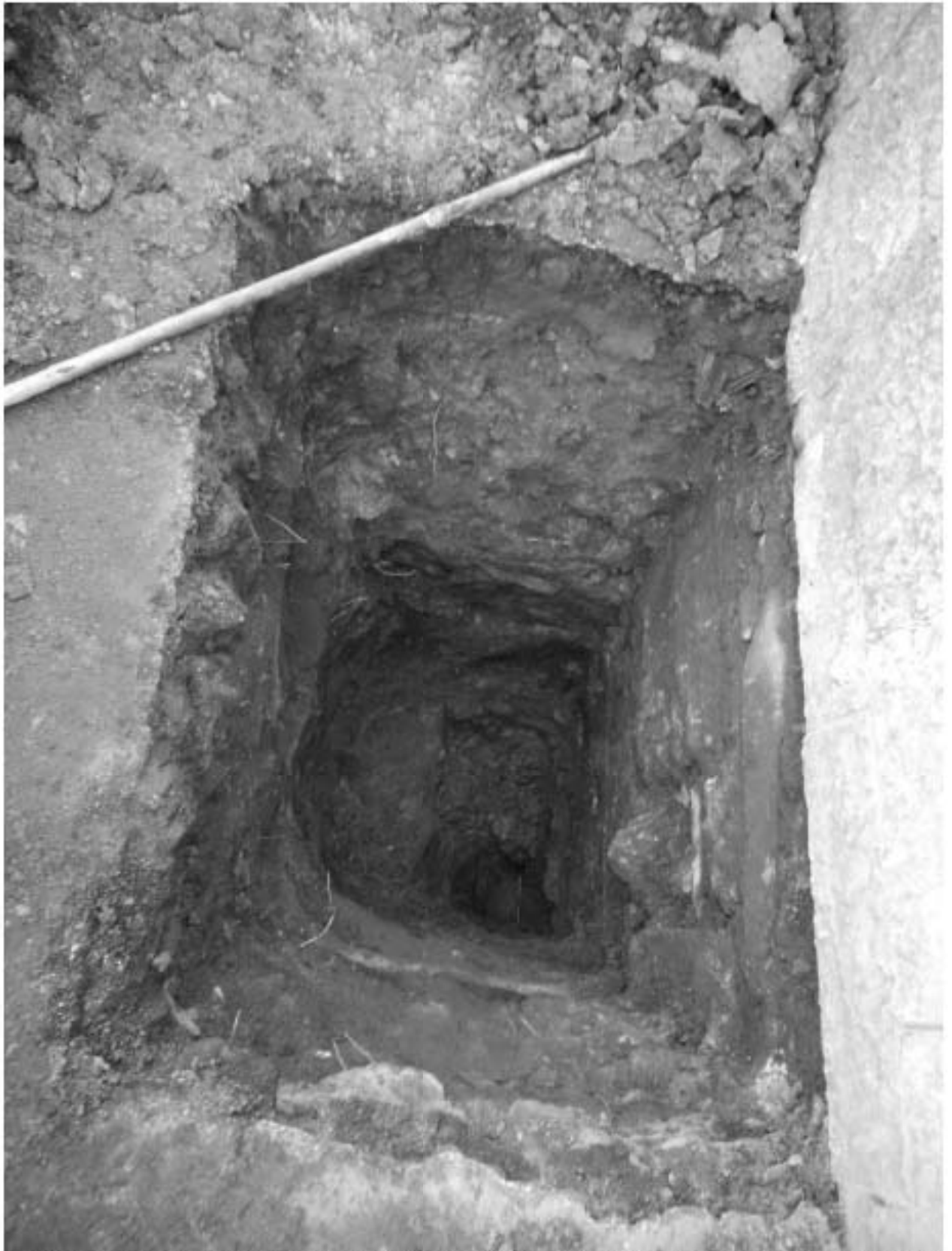
Рис. 64. Цимбалинский путепровод-2022. Шурф 2, фиксация по уровню окончания работ, вид на северо-восток.
