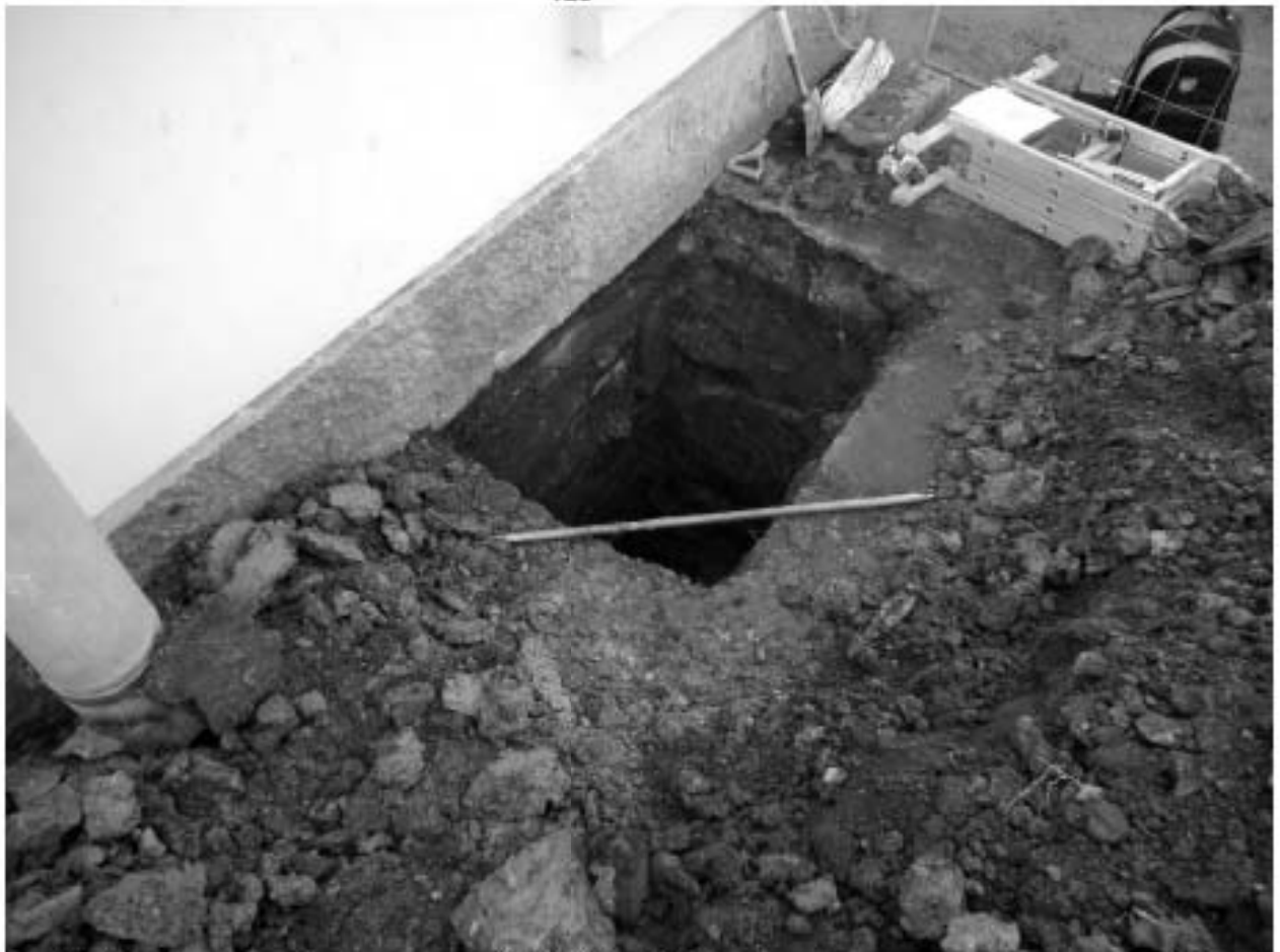
Рис. 63. Цимбалинский путепровод-2022. Шурф 2, фиксация по уровню окончания работ, вид на юг.
