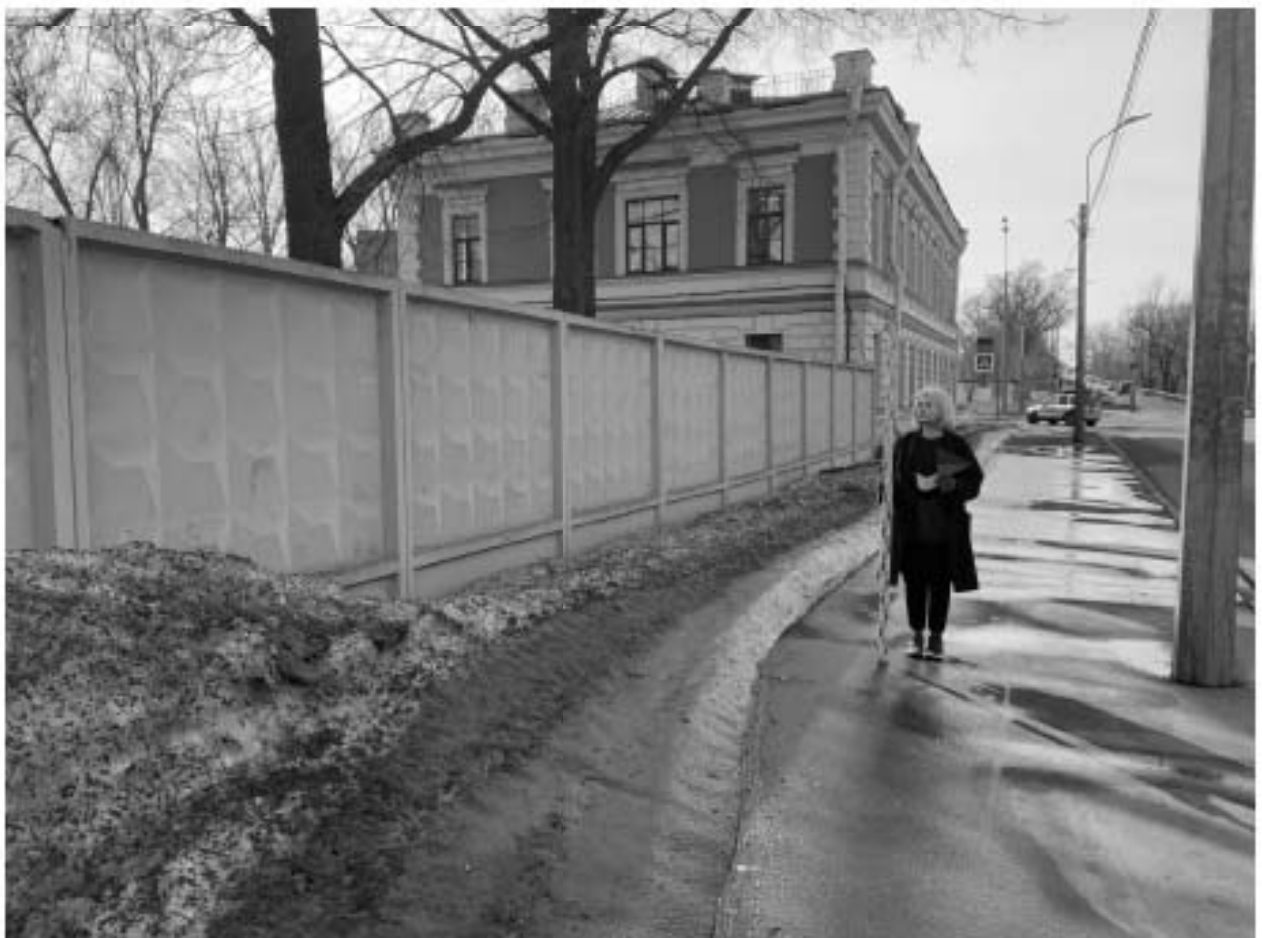
Рис. 41. Цимбалинский путепровод-2022. Точка фотофиксации 9, вид на юго-запад.
