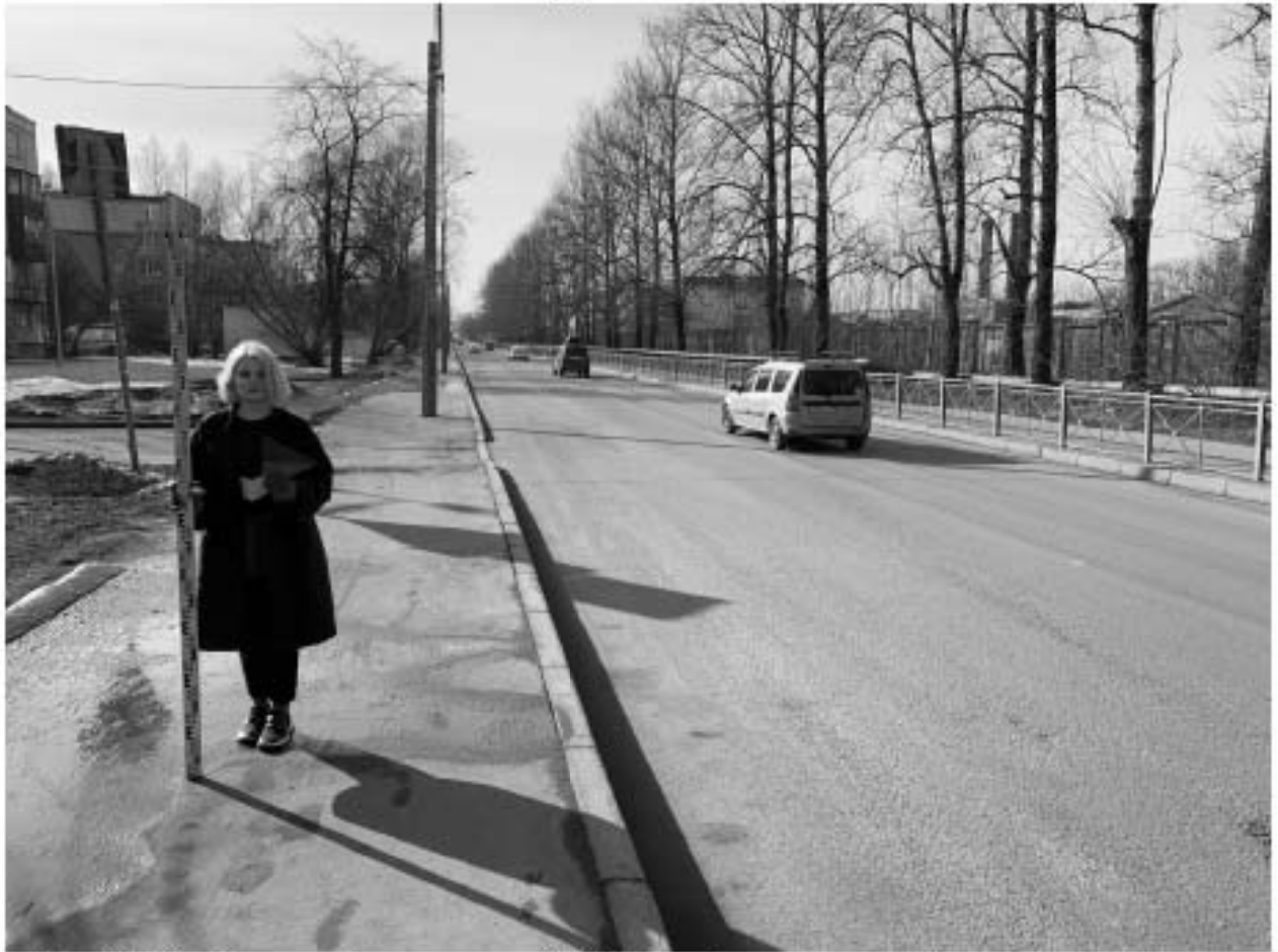
Рис. 28. Цимбалинский путепровод-2022. Точка фотофиксации 6, вид на северо-запад.
