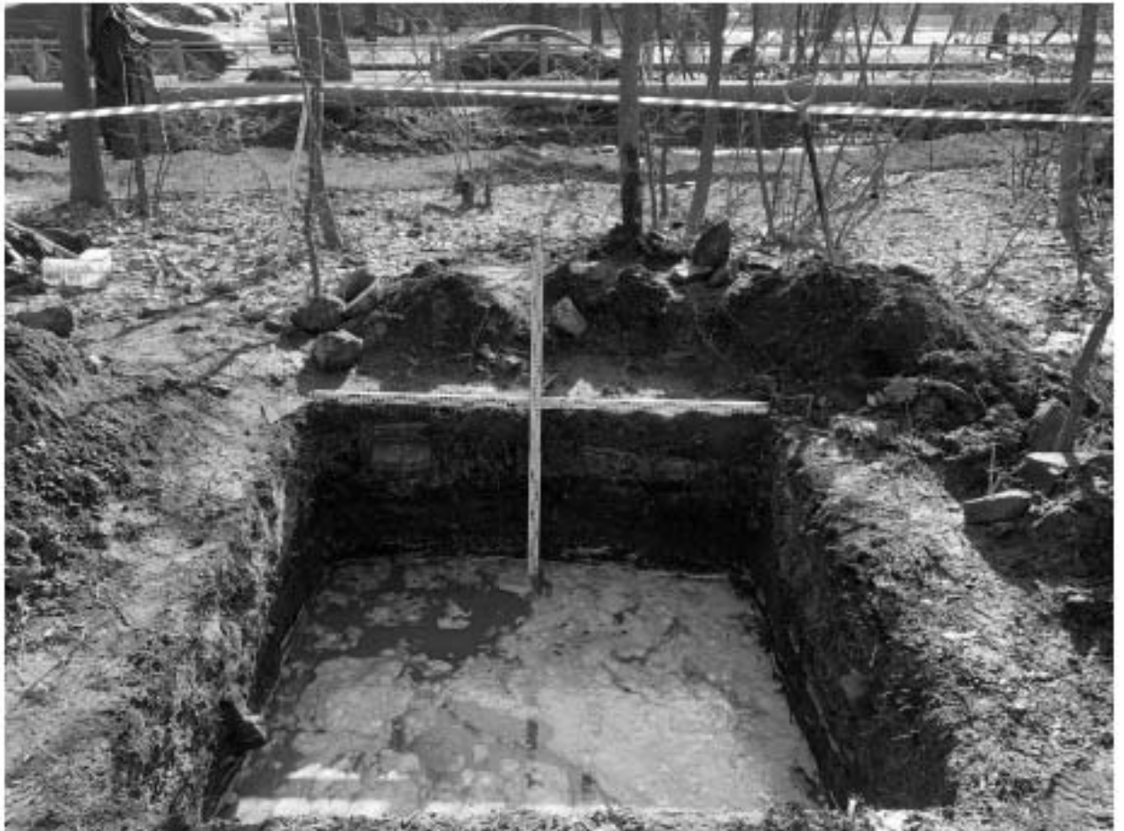
Рис. 53. Цимбалинский путепровод-2022. Шурф 1, фиксация по уровню окончания работ, вид на юг.
