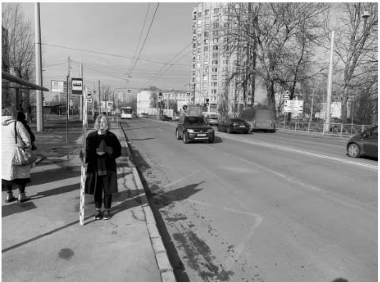
Рис. 21. Цимбалинский путепровод-2022. Точка фотофиксации 3, вид на северо-восток.
