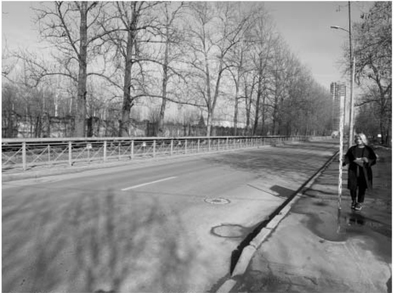
Рис. 38. Цимбалинский путепровод-2022. Точка фотофиксации 8, вид на северо-восток.
