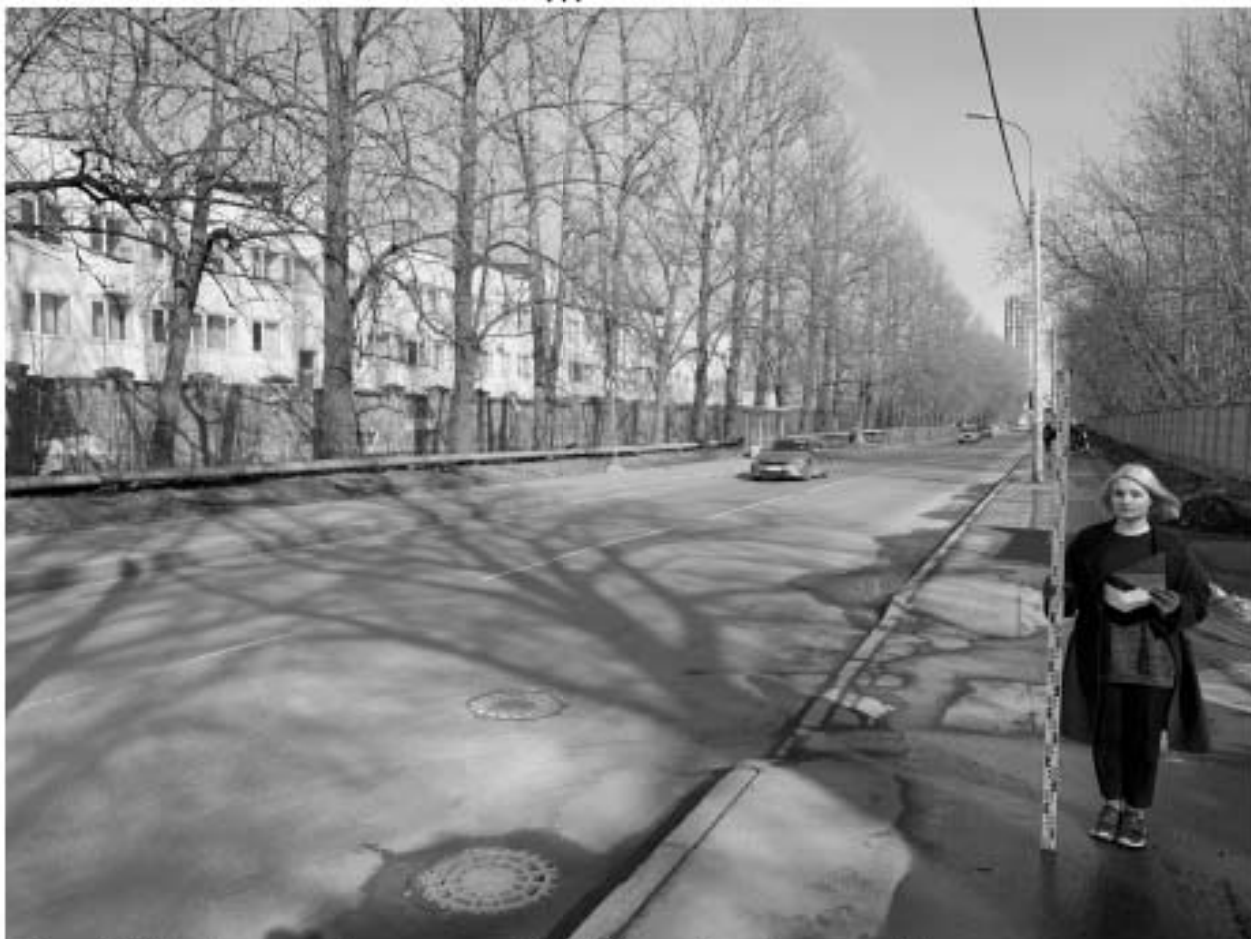
Рис. 42. Цимбалинский путепровод-2022. Точка фотофиксации 9, вид на северо-восток.
