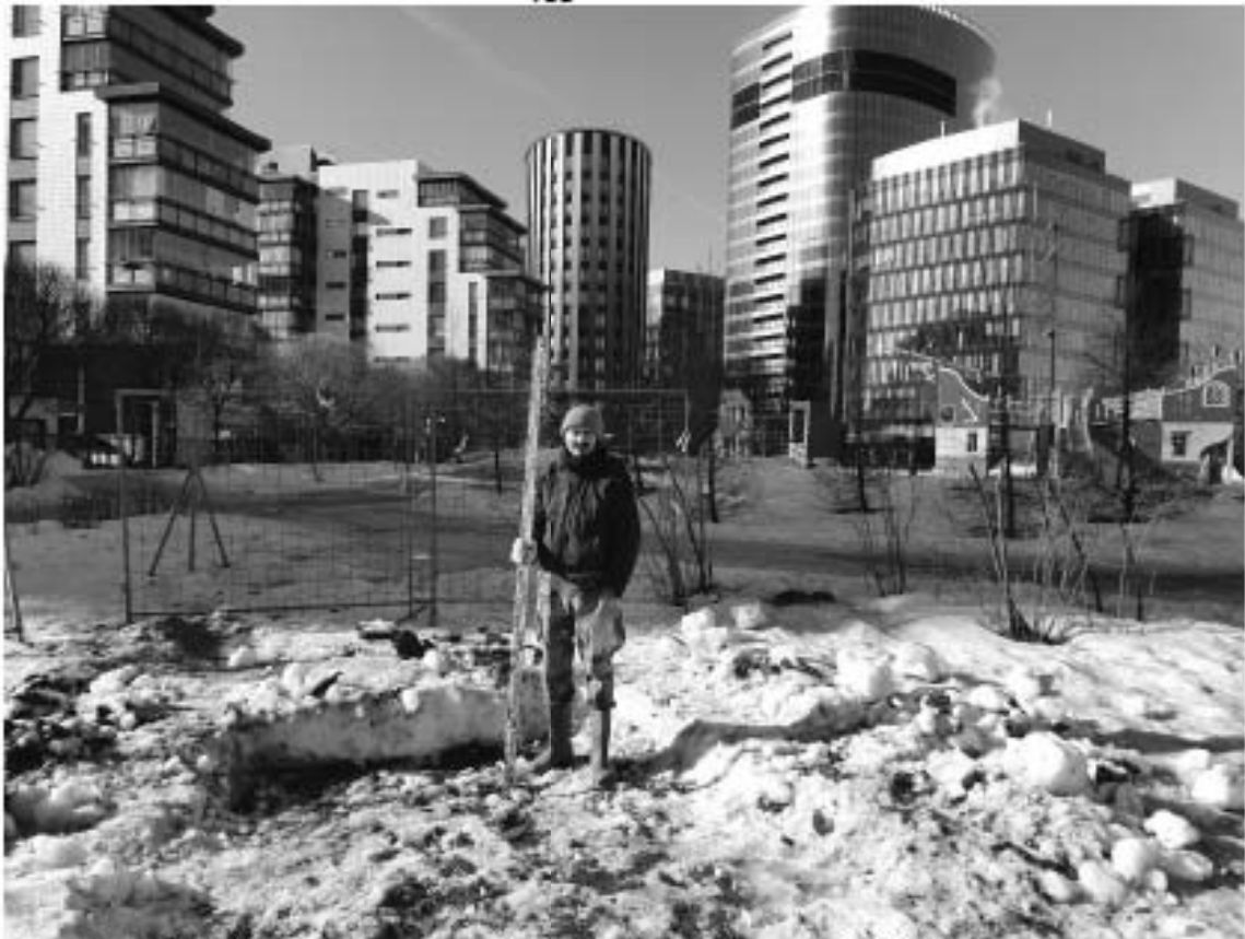
Рис. 17. СПб-2022. Красногвардейский район, Охта кв. 8, 9 М. Общий вид участка обследования. Шурф 1. До начала работ. Вид с севера
