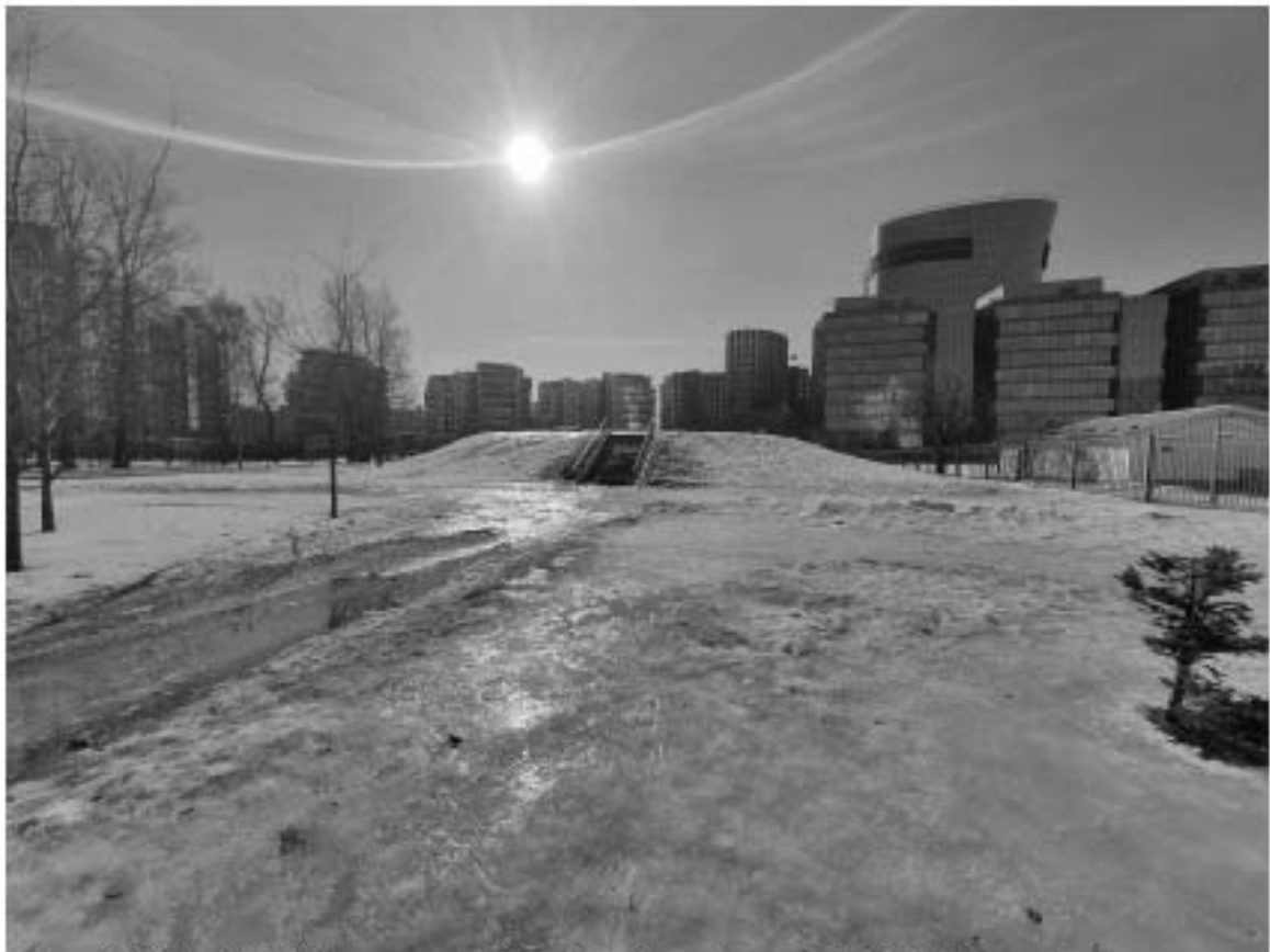
Рис. 9. СПб-2022. Красногвардейский район, Охта кв. 8, 9 М. Общий вид участка обследования. Точка фотофиксации 2. Вид с запада
