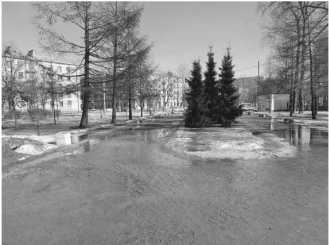
Рис. 13. СПб-2022. Красногвардейский район, Охта кв. 8, 9 М. Общий вид участка обследования. Точка фотофиксации 5. Вид с запада
