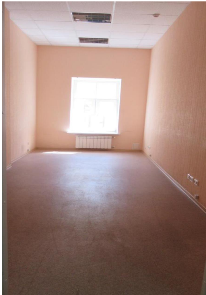
18. Объект культурного наследия федерального значения «Дом Карамзина В.Н. (Коровиной Л.Н.) с дворовыми флигелями» по адресу: г. Санкт-Петербург, Большая Морская улица, дом 55, литера А. Помещение №17-Н. Фрагмент интерьера.
