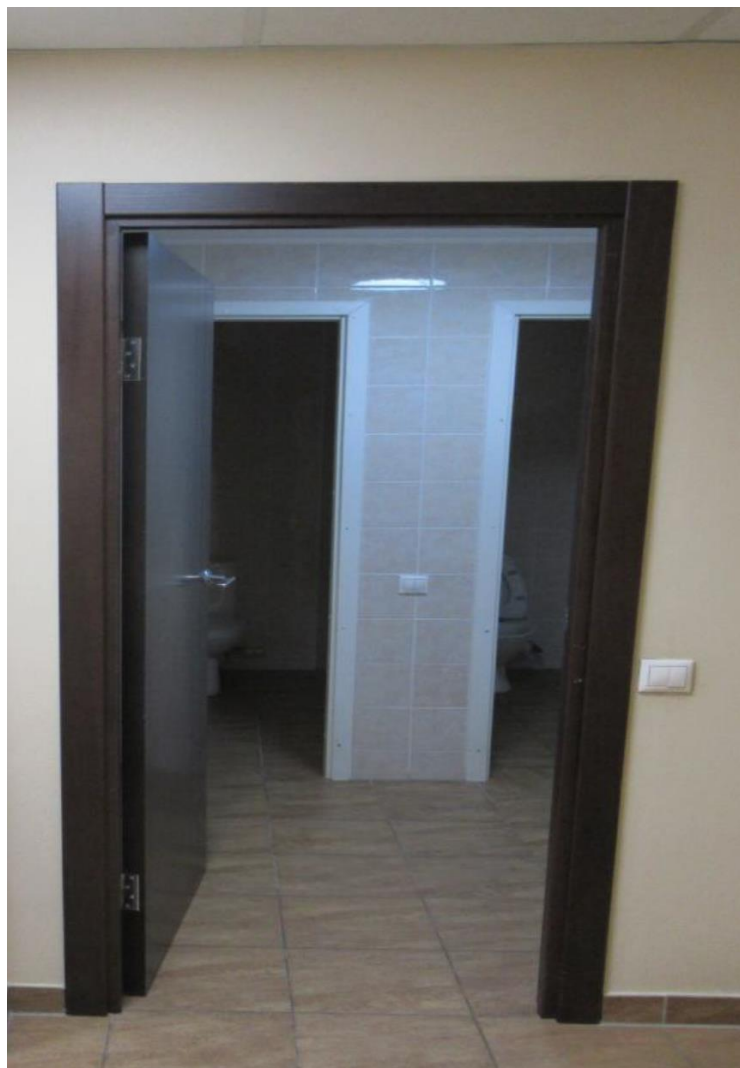
21. Объект культурного наследия федерального значения «Дом Карамзина В.Н. (Коровиной Л.Н.) с дворовыми флигелями» по адресу: г. Санкт-Петербург, Большая Морская улица, дом 55, литера А. Помещение №17-Н. Помещение санузла. Общий вид.
