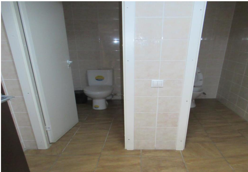
22. Объект культурного наследия федерального значения «Дом Карамзина В.Н. (Коровиной Л.Н.) с дворовыми флигелями» по адресу: г. Санкт-Петербург, Большая Морская улица, дом 55, литера А. Помещение №17-Н. Санузел. Общий вид.
