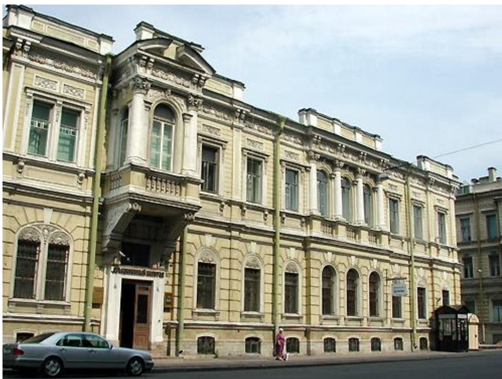
17. Объект культурного наследия федерального значения «Дом Карамзина В.Н. (Коровиной Л.Н.) с дворовыми флигелями» по адресу: г. Санкт-Петербург, Большая Морская улица, дом 55, литера А. Главный (лицевой) фасад по Большой Морской улице. Общий вид. Фотография. 2004 г. https://www.citywalls.ru/
