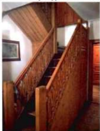
6. Лестница в центральной части объекта культурного наследия.
