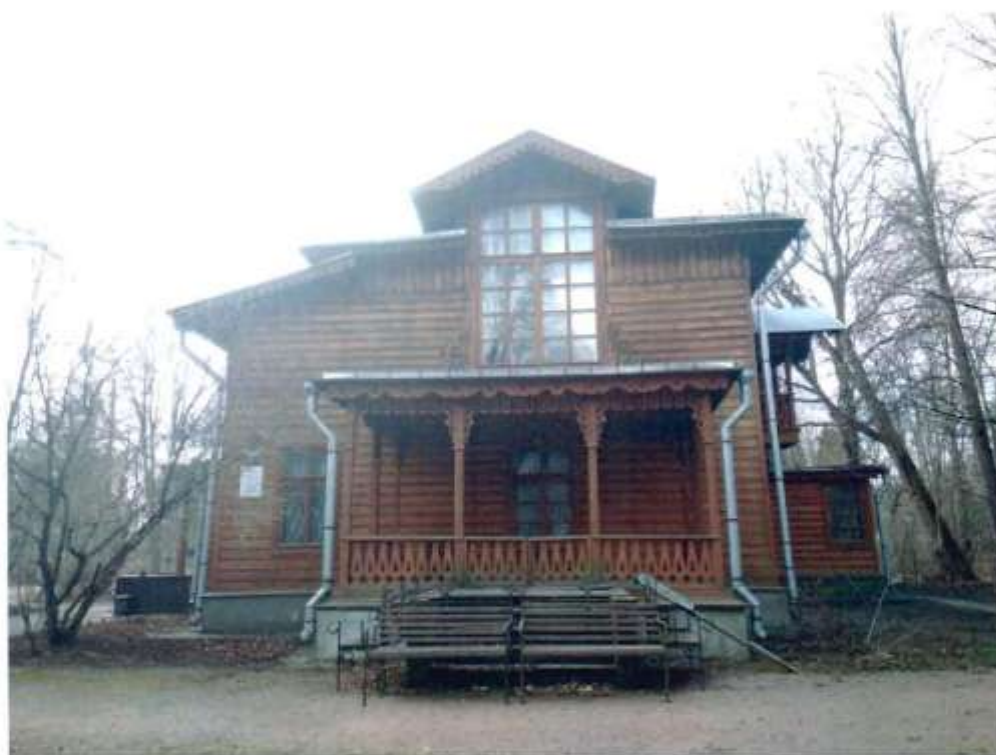
1. Вид на объект культурного наследия с северо-восточной стороны.
