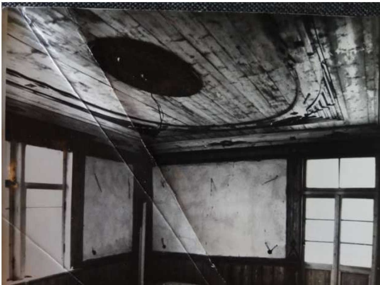
Илл. 12. Большая гостиная перед реставрационными работами 1970-х гг. Архив Музея-квартиры П.П. Чистякова.
