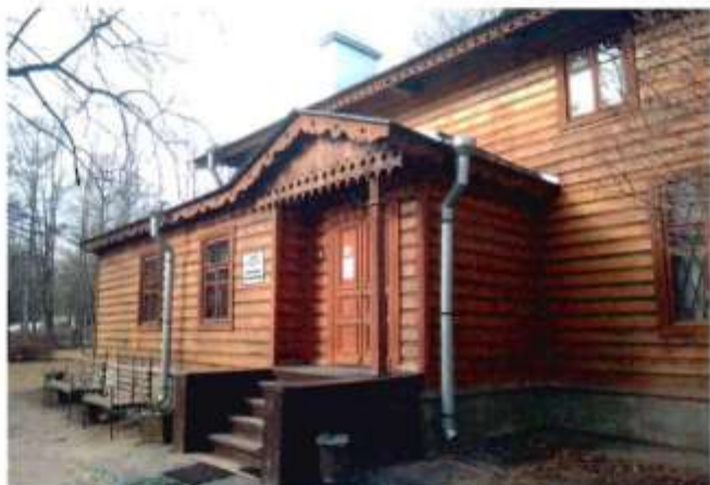
5. Вид на юго-восточный фасад объекта культурного наследия.
