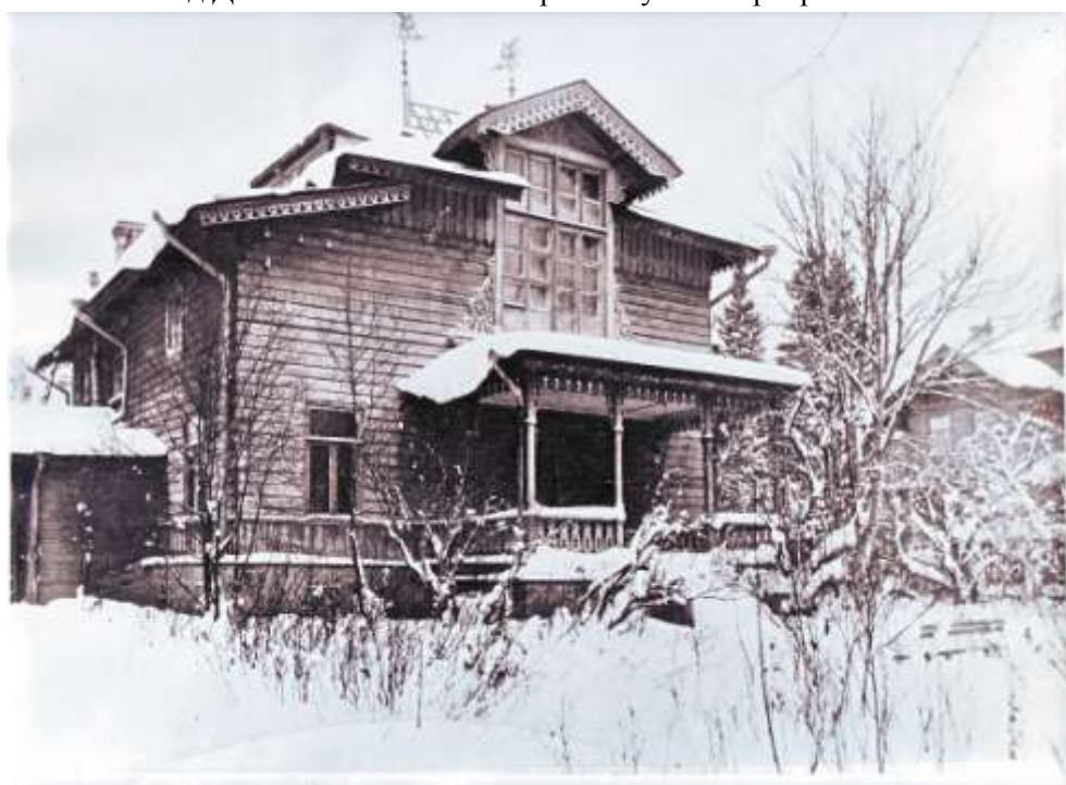
Илл. 3. Дача П.П. Чистякова. Северный фасад здания. 1926 г. Архив Музея-квартиры П.П. Чистякова. Зап. №230.
