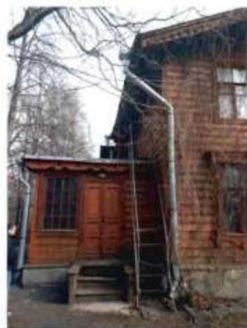
3. Фрагмент юго-западного фасада.
