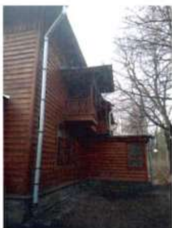
4. Вид на северо-западный фасад объекта культурного наследия.
