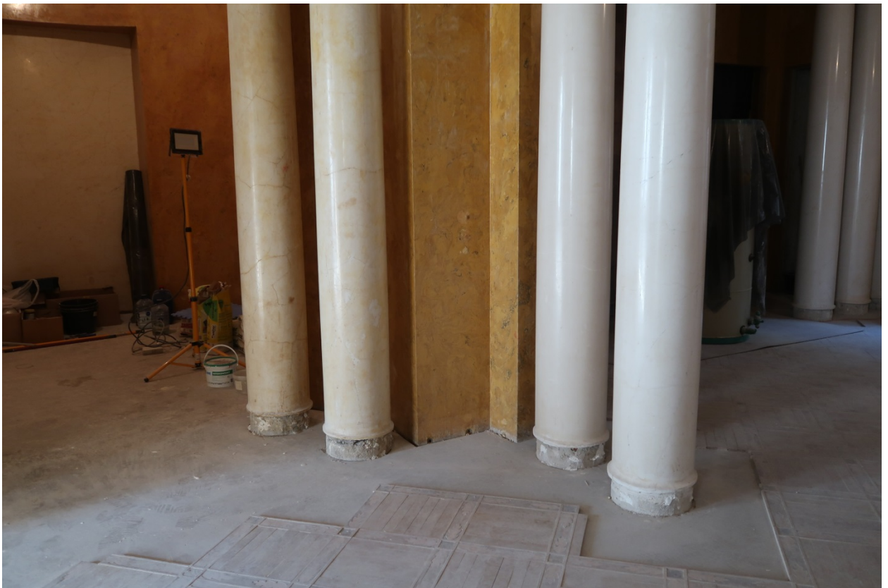
43. Выявленный объект культурного наследия «Дом М.М.Верховского» (г. Санкт-Петербург, Кировная ул., д. 22, лит. А). Помещение кв. №2.
