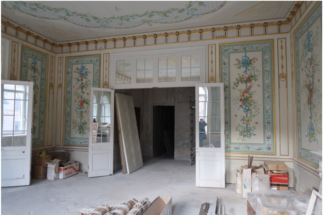
18. Выявленный объект культурного наследия «Дом М.М.Верховского» (г. Санкт-Петербург, Кирочная ул., д. 22, лит. А). Помещение кв. №2.
