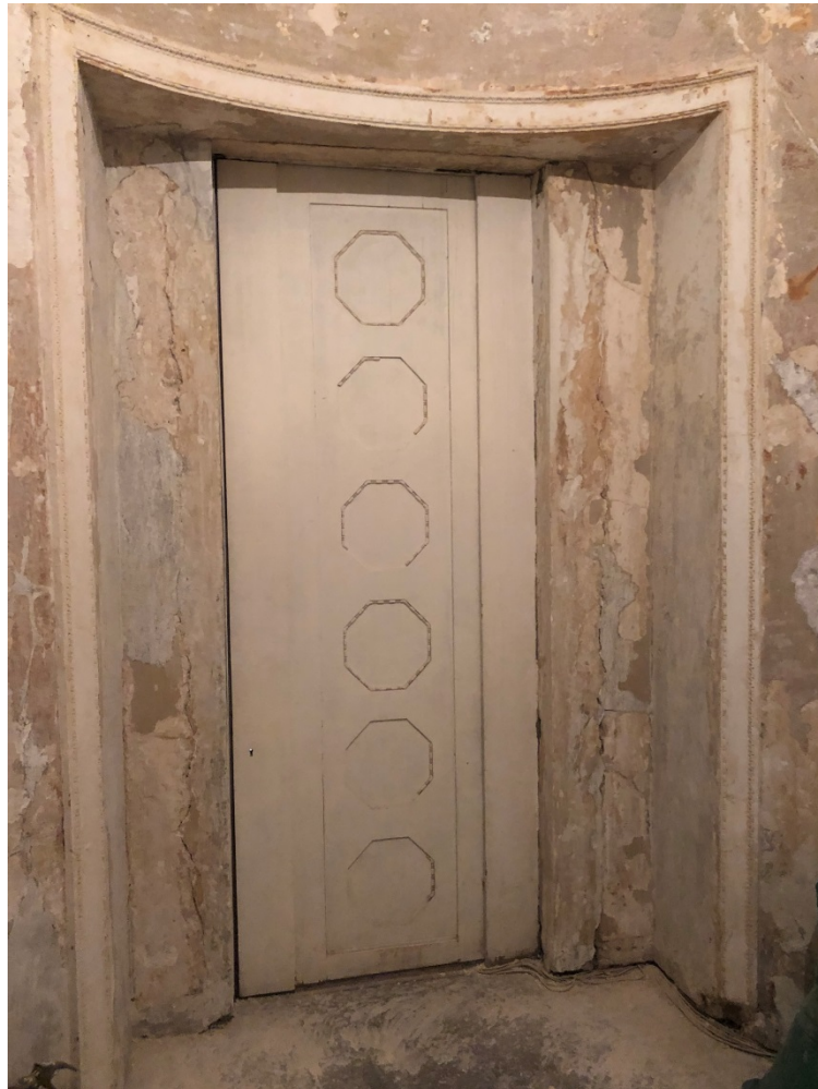
11. Выявленный объект культурного наследия «Дом М.М.Верховского» (г. Санкт-Петербург, Кирочная ул., д. 22, лит. А). Помещение кв. №2.
