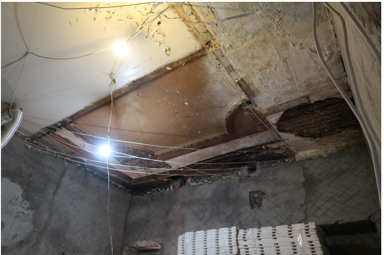
22. Выявленный объект культурного наследия «Дом М.М.Верховского» (г. Санкт-Петербург, Кирочная ул., д. 22, лит. А). Помещение кв. №2.
