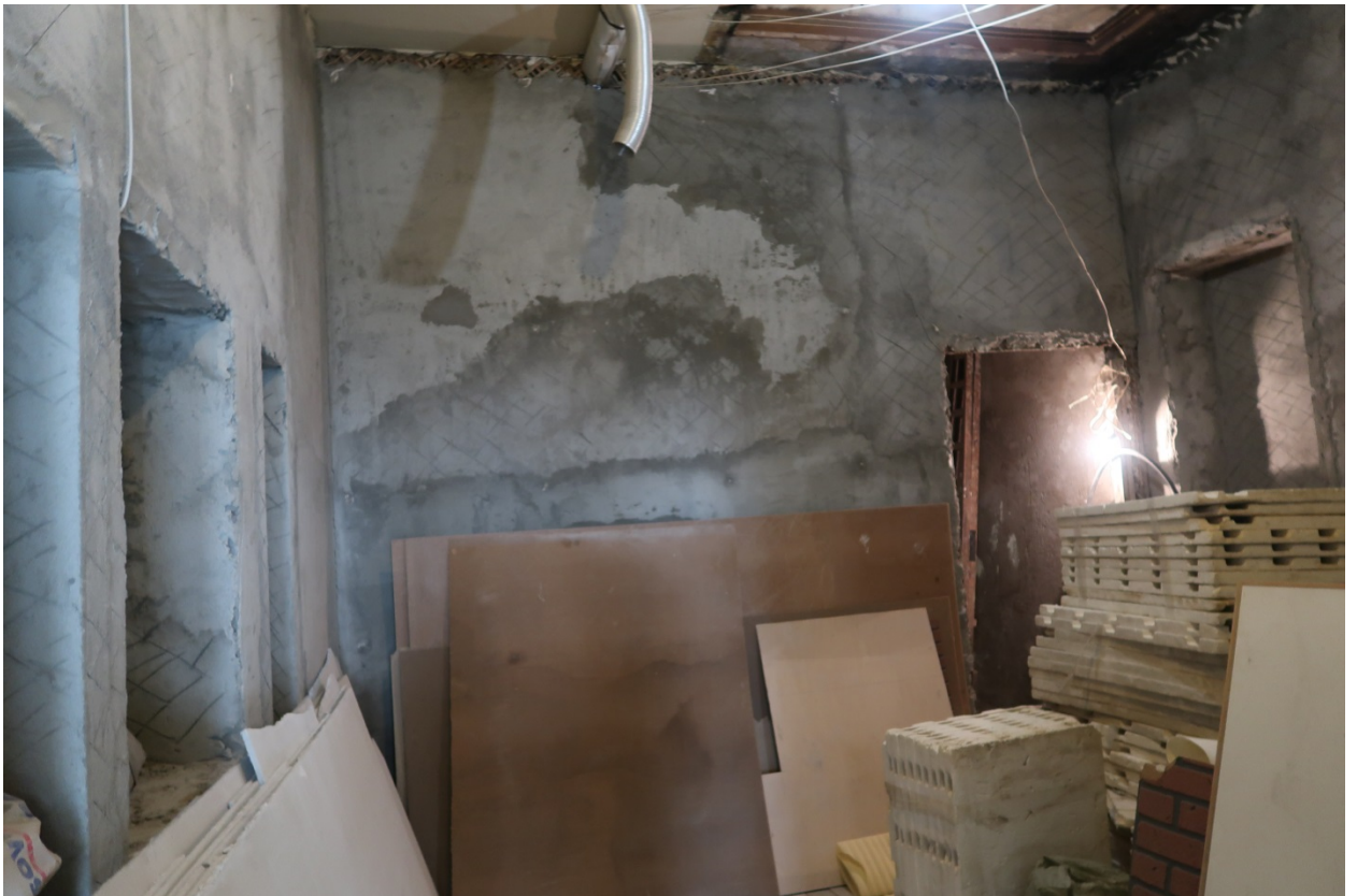
20. Выявленный объект культурного наследия «Дом М.М.Верховского» (г. Санкт-Петербург, Кирочная ул., д. 22, лит. А). Помещение кв. №2.
