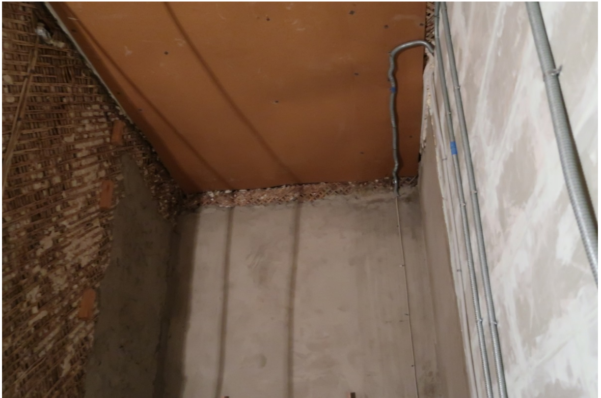
24. Выявленный объект культурного наследия «Дом М.М.Верховского» (г. Санкт-Петербург, Кирочная ул., д. 22, лит. А). Помещение кв. №2.
