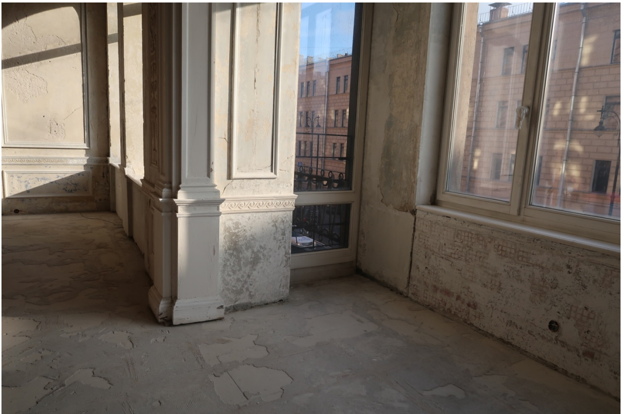
28. Выявленный объект культурного наследия «Дом М.М.Верховского» (г. Санкт-Петербург, Кирочная ул., д. 22, лит. А). Помещение кв. №2.
