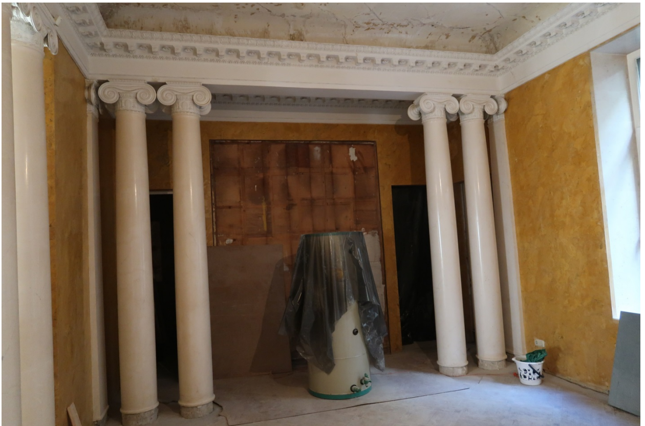
42. Выявленный объект культурного наследия «Дом М.М.Верховского» (г. Санкт-Петербург, Кирочная ул., д. 22, лит. А). Помещение кв. №2.
