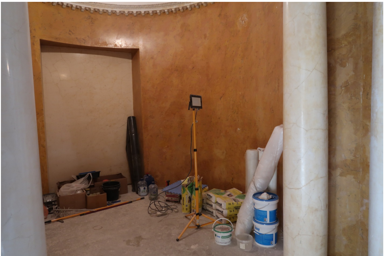
36. Выявленный объект культурного наследия «Дом М.М.Верховского» (г. Санкт-Петербург, Кирочная ул., д. 22, лит. А). Помещение кв. №2.
