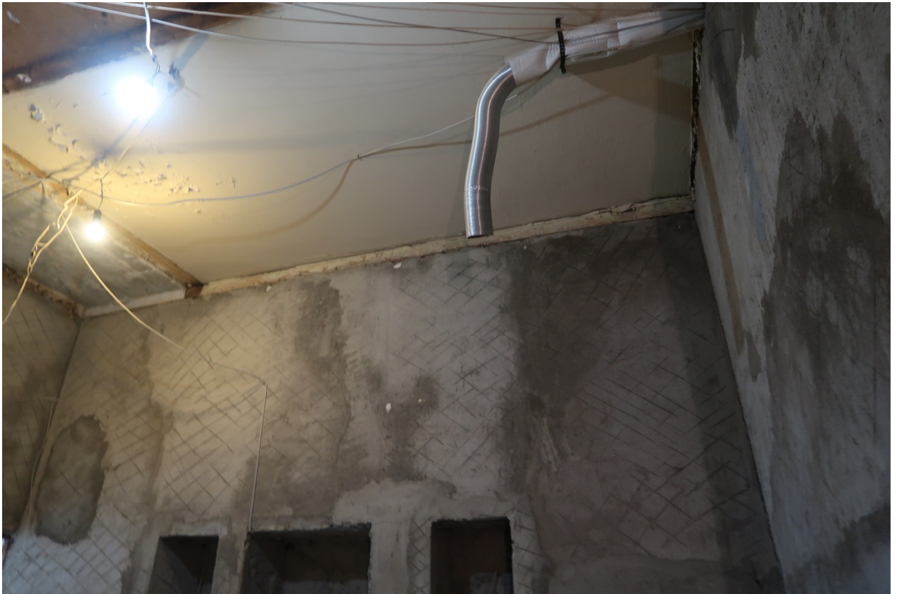
21. Выявленный объект культурного наследия «Дом М.М.Верховского» (г. Санкт-Петербург, Кирочная ул., д. 22, лит. А). Помещение кв. №2.
