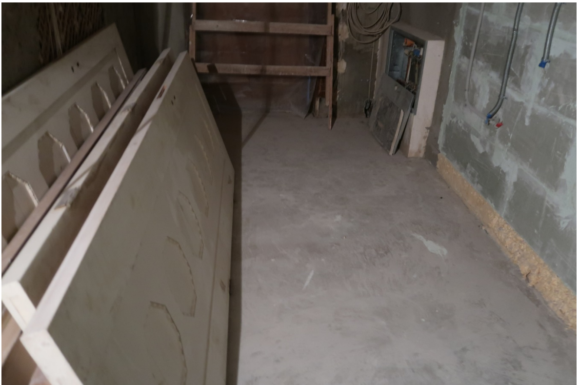
23. Выявленный объект культурного наследия «Дом М.М.Верховского» (г. Санкт-Петербург, Кирочная ул., д. 22, лит. А). Помещение кв. №2.
