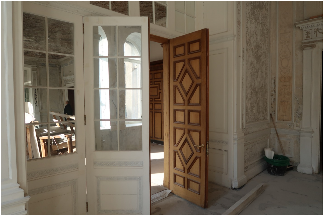
30. Выявленный объект культурного наследия «Дом М.М.Верховского» (г. Санкт-Петербург, Кирочная ул., д. 22, лит. А). Помещение кв. №2.
