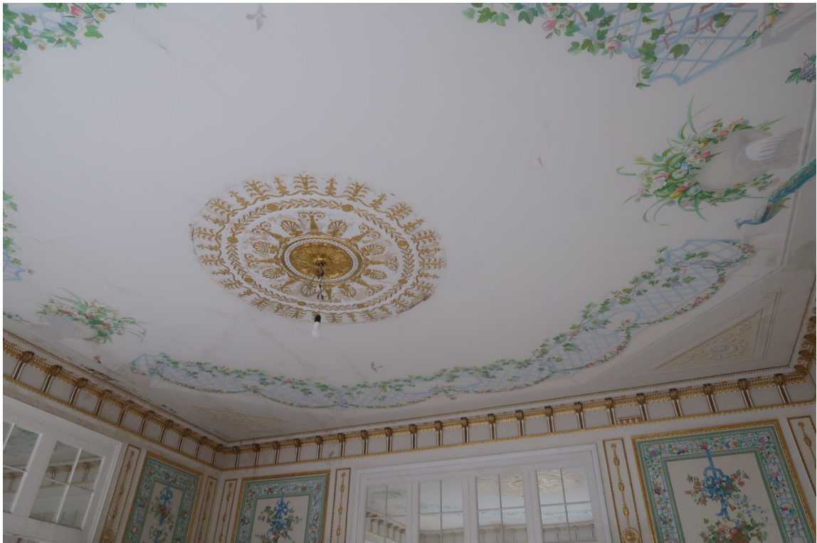
19. Выявленный объект культурного наследия «Дом М.М.Верховского» (г. Санкт-Петербург, Кирочная ул., д. 22, лит. А). Помещение кв. №2.
