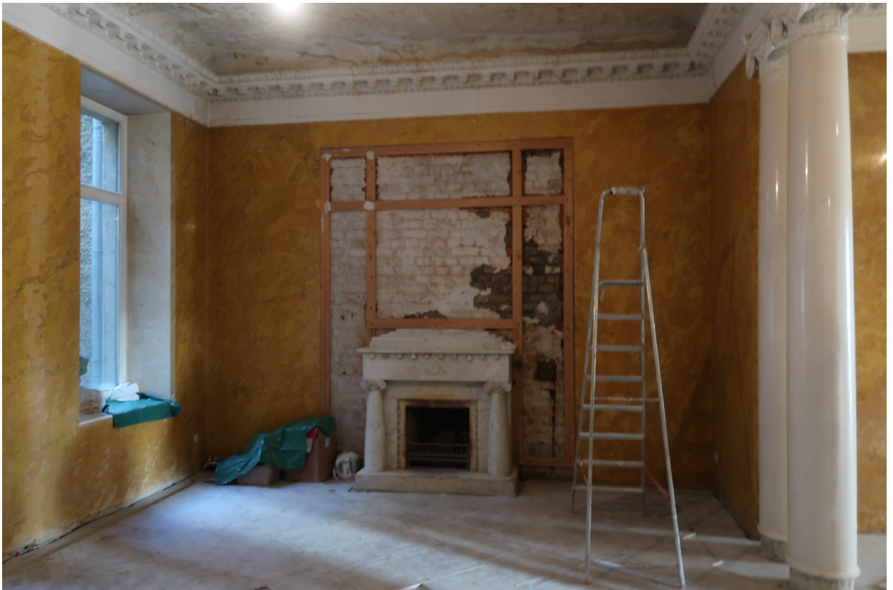
40. Выявленный объект культурного наследия «Дом М.М.Верховского» (г. Санкт-Петербург, Кирочная ул., д. 22, лит. А). Помещение кв. №2.
