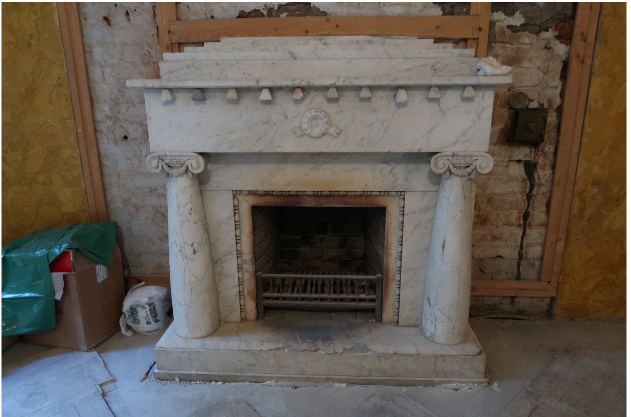
41. Выявленный объект культурного наследия «Дом М.М.Верховского» (г. Санкт-Петербург, Кирочная ул., д. 22, лит. А). Помещение кв. №2.
