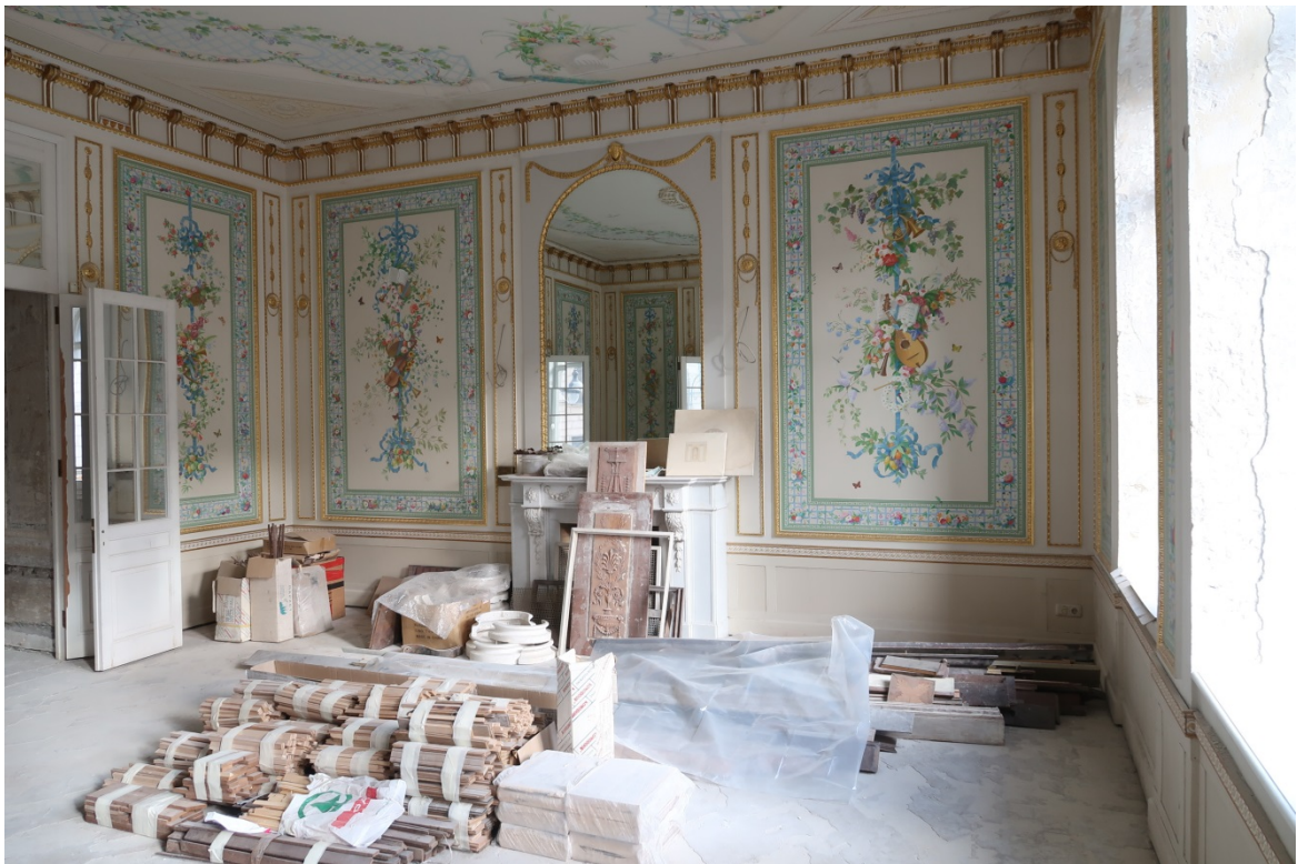
17. Выявленный объект культурного наследия «Дом М.М.Верховского» (г. Санкт-Петербург, Кирочная ул., д. 22, лит. А). Помещение кв. №2.
