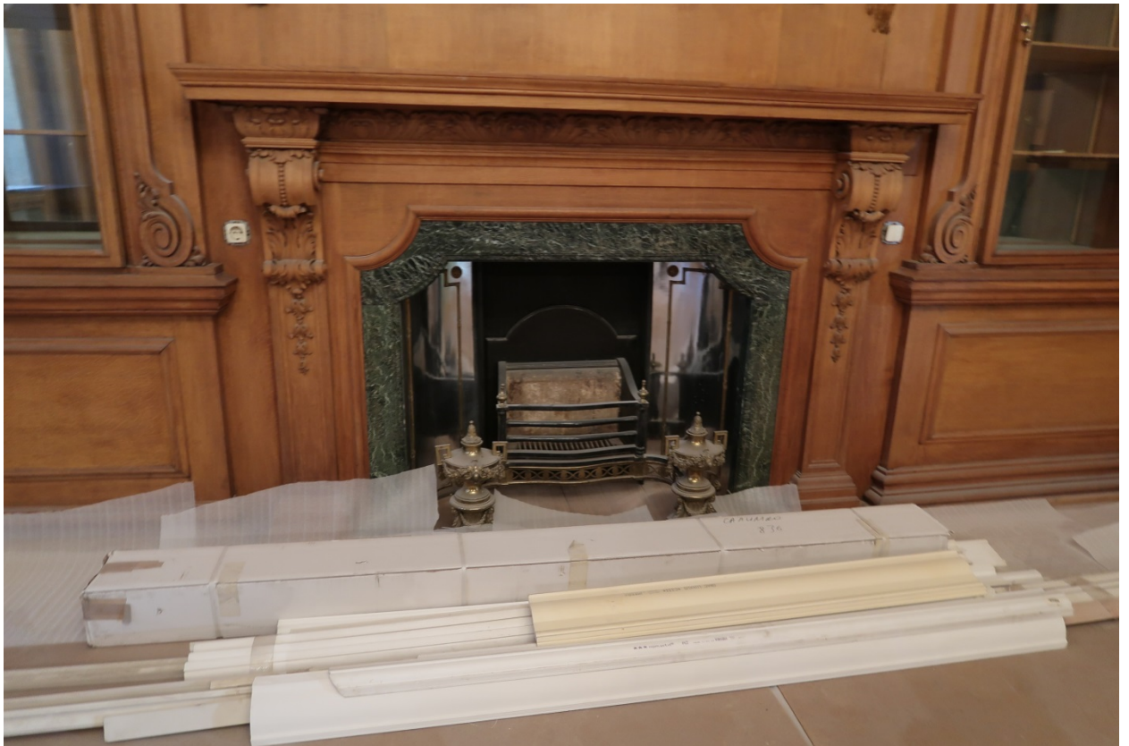
14. Выявленный объект культурного наследия «Дом М.М.Верховского» (г. Санкт-Петербург, Кирочная ул., д. 22, лит. А). Помещение кв. №2.
