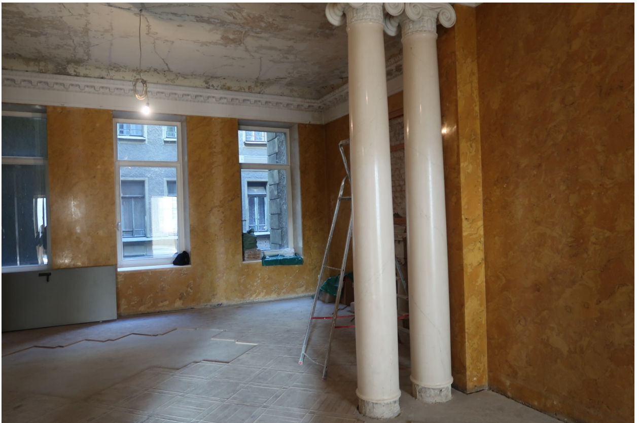
39. Выявленный объект культурного наследия «Дом М.М.Верховского» (г. Санкт-Петербург, Кирочная ул., д. 22, лит. А). Помещение кв. №2.
