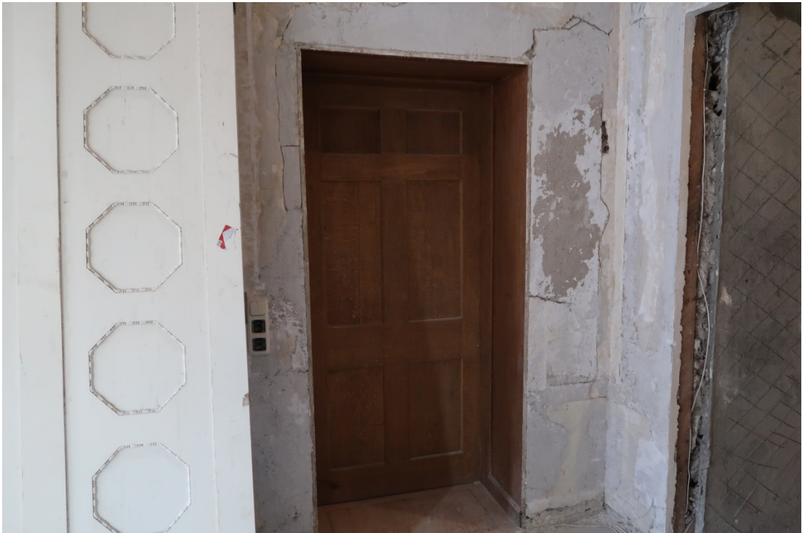
15. Выявленный объект культурного наследия «Дом М.М.Верховского» (г. Санкт-Петербург, Кирочная ул., д. 22, лит. А). Помещение кв. №2.
