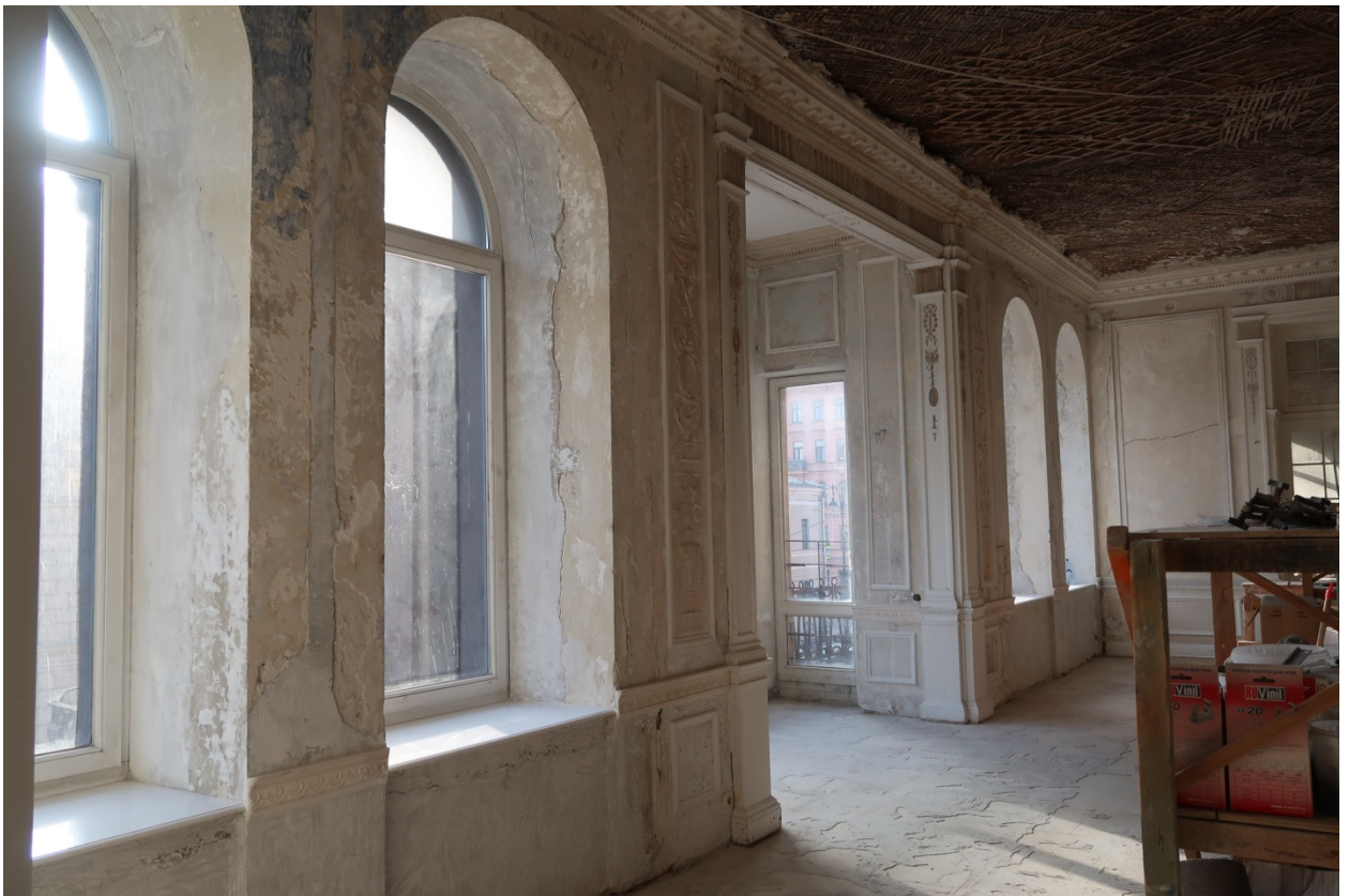
27. Выявленный объект культурного наследия «Дом М.М.Верховского» (г. Санкт-Петербург, Кирочная ул., д. 22, лит. А). Помещение кв. №2.
