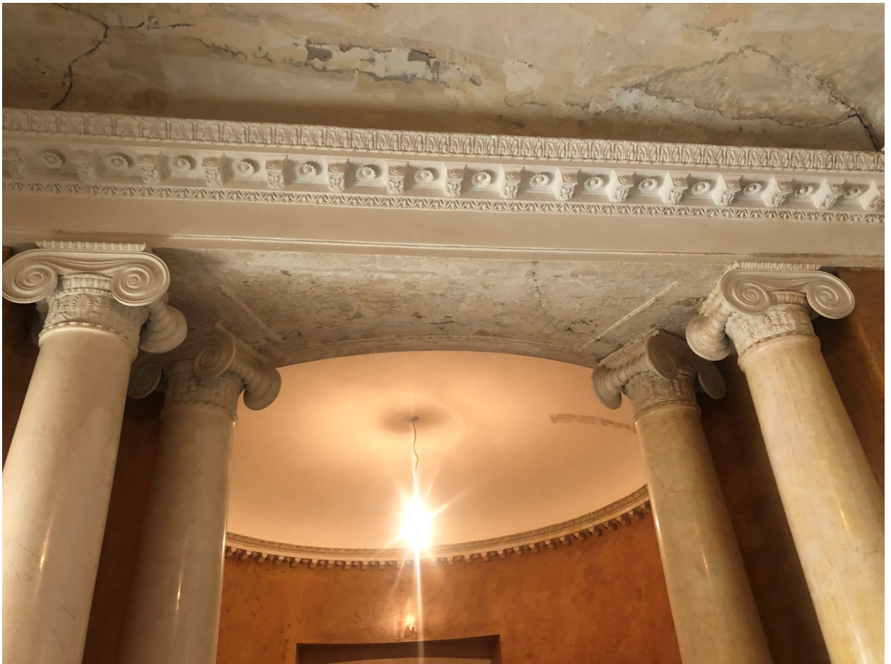
37. Выявленный объект культурного наследия «Дом М.М.Верховского» (г. Санкт-Петербург, Кировная ул., д. 22, лит. А). Помещение кв. №2.
