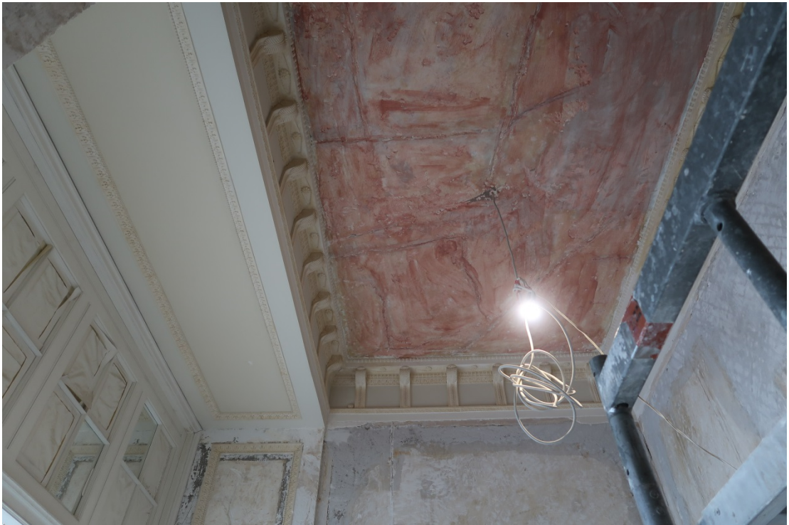
16. Выявленный объект культурного наследия «Дом М.М.Верховского» (г. Санкт-Петербург, Кирочная ул., д. 22, лит. А). Помещение кв. №2.
