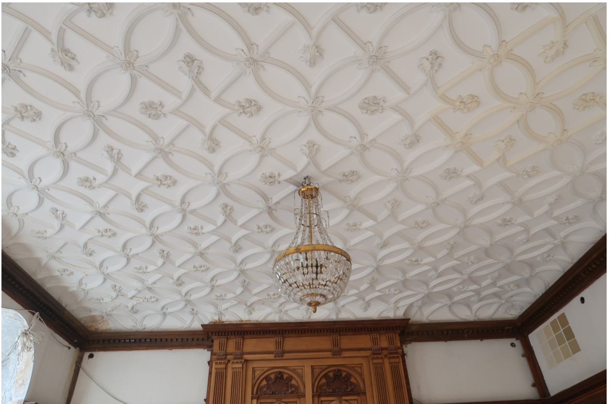
32. Выявленный объект культурного наследия «Дом М.М.Верховского» (г. Санкт-Петербург, Кирочная ул., д. 22, лит. А). Помещение кв. №2.
