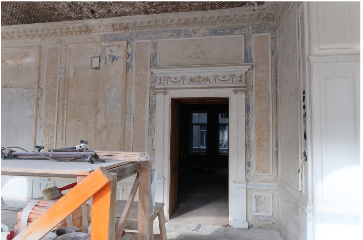
29. Выявленный объект культурного наследия «Дом М.М.Верховского» (г. Санкт-Петербург, Кирочная ул., д. 22, лит. А). Помещение кв. №2.
