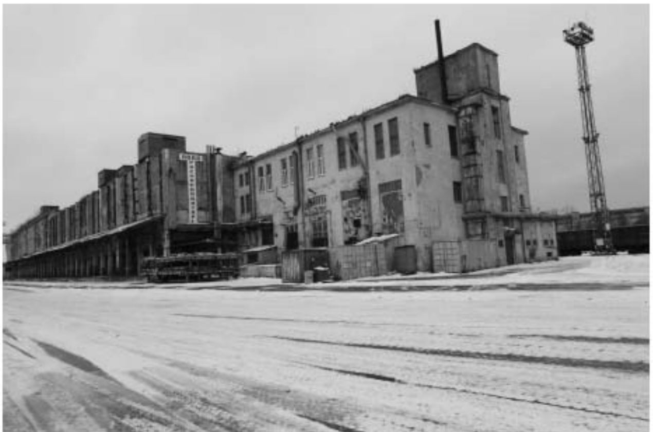
Железобетонный холодильник-склад. Современное состояние. Фотофиксация: ноябрь 2021 г.
