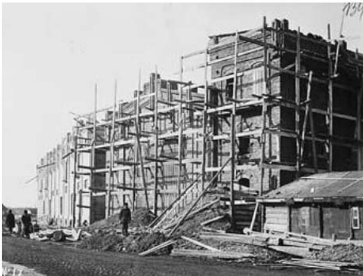
Строительство здания электростанции. 1913 г.
