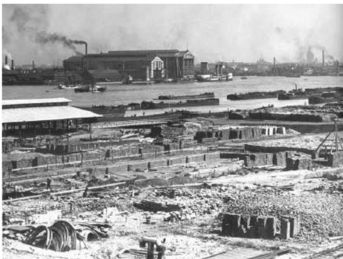
Строительство набережной и складов Петербургского морского порта. Справа вдали - Адмиралтейские верфи; на другом берегу Невы - Балтийский судостроительный и механический завод Морского министерства. 1900-е годы.
