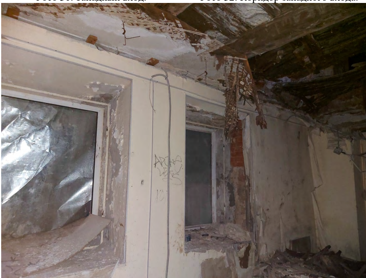
Фото 33. Проемы лицевого фасада.
