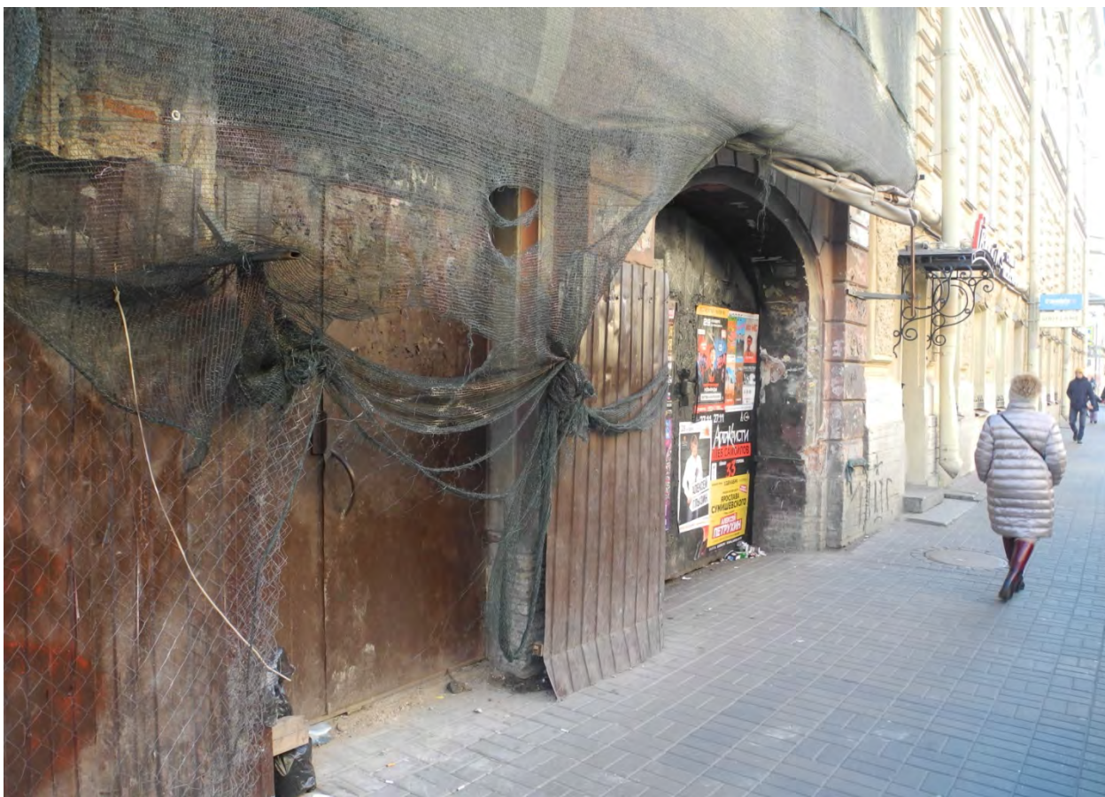
Фото 4. Фрагмент фасада вид на западную часть.
