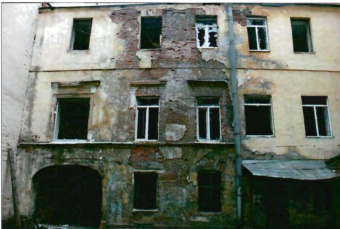
2. Дворовый фасад. Общий вид.
