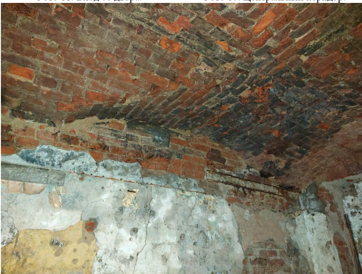
Фото 18. Фрагмент перекрытия, заложенные проемы.
