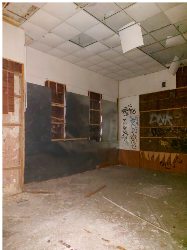
Фото 45. Северо-восточный угол помещения 14.
