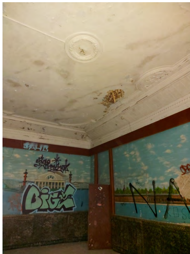
Фото 54. Северо-восточный угол помещения 9.
