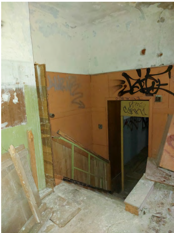
Фото 59. Юго-восточное помещение с лестницей на третий этаж.
