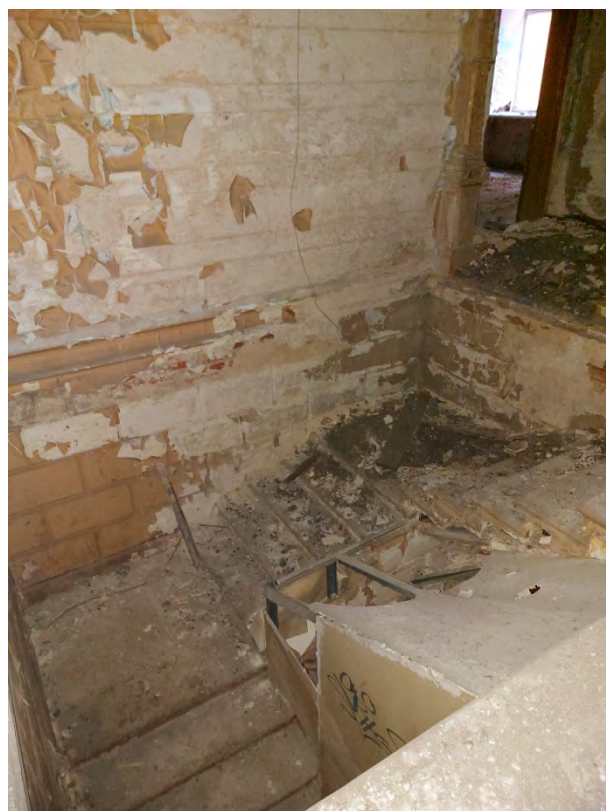
Фото 41. Парадная лестница, вид со второго этажа.
