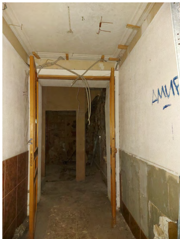
Фото 32. Коридор западного входа.
