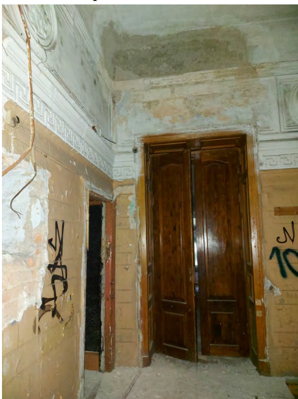
Фото 40. Площадка второго этажа.
