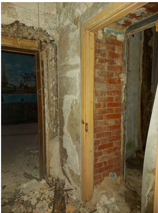
Фото 50. Проемы в центральной части.
