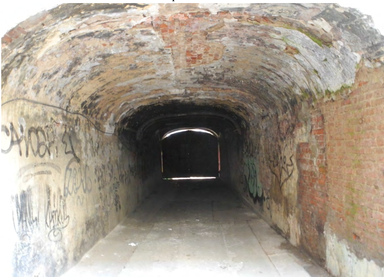
Фото 9. Проездная арка, вид со двора.
