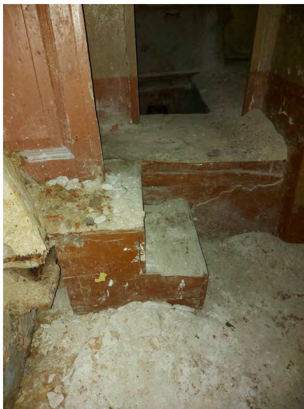
Фото 28. Ступени в западной части.
