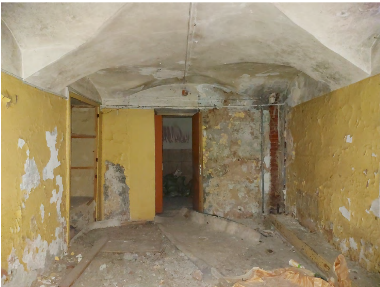
Фото 19. Помещение 5, по дворовому фасаду.
