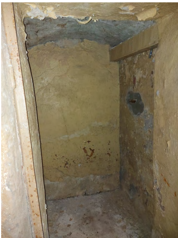
Фото 27. Помещение под парадной лестницей.
