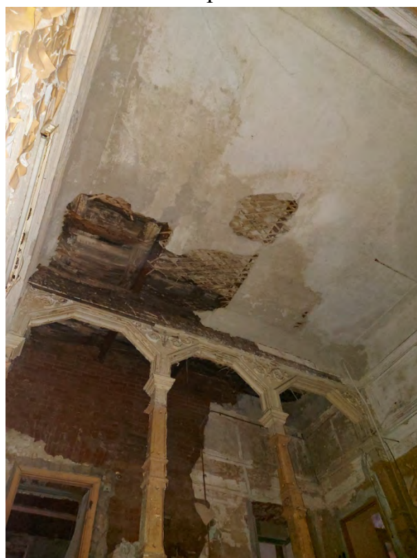
Фото 37. Перекрытие парадной лестницы.
