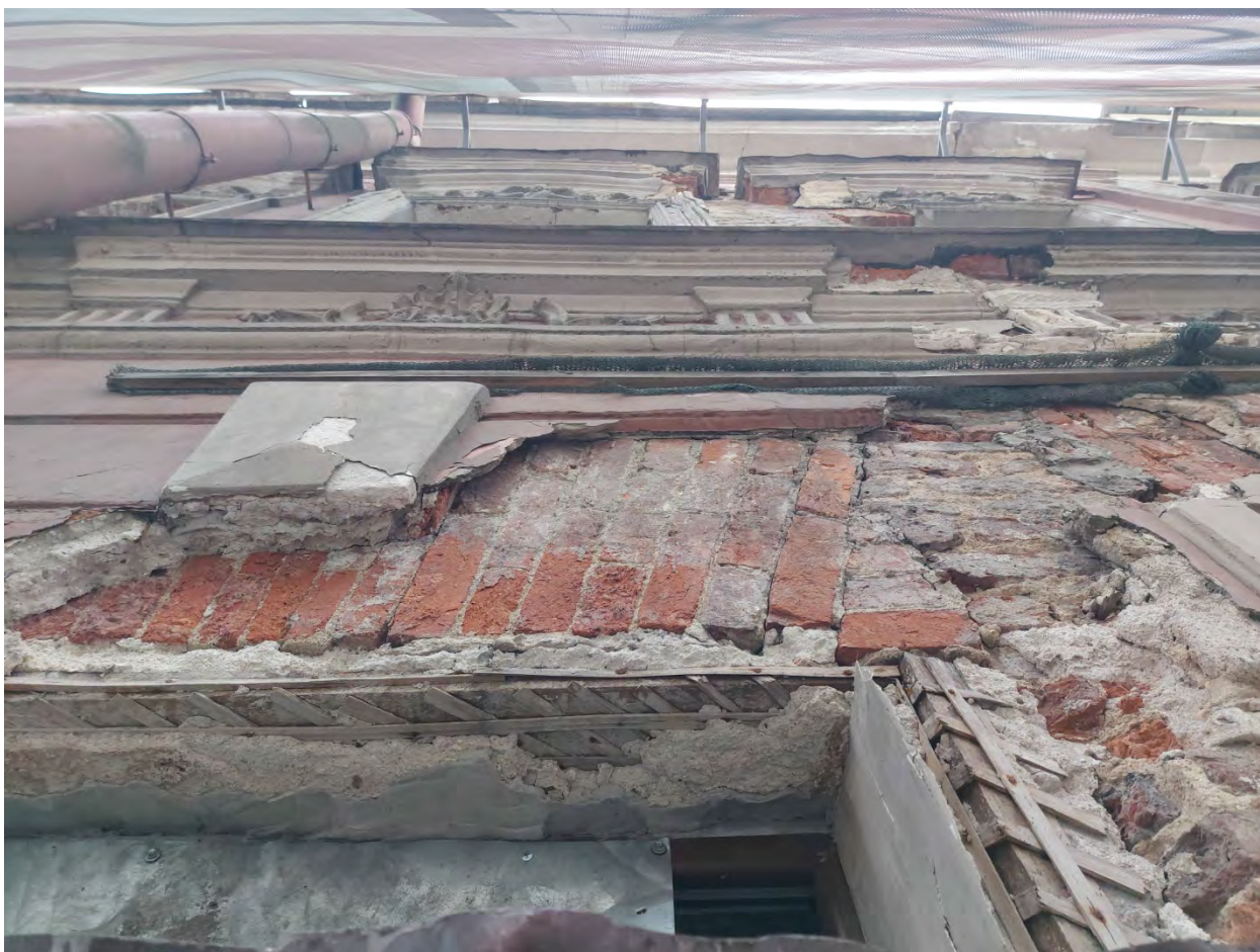
Фото 6. Фрагмент лицевого фасада, оконный проем.
