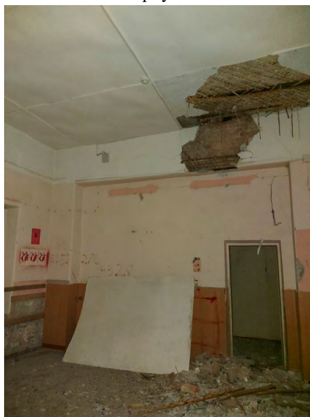
Фото 58. Помещение 8 и проем в помещении 7.
