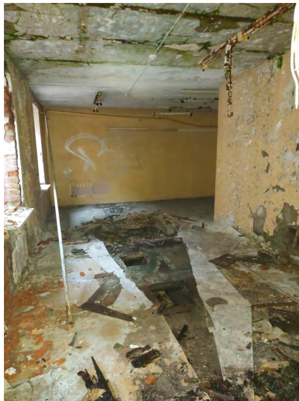
Фото 60. Западное помещение третьего этажа.
