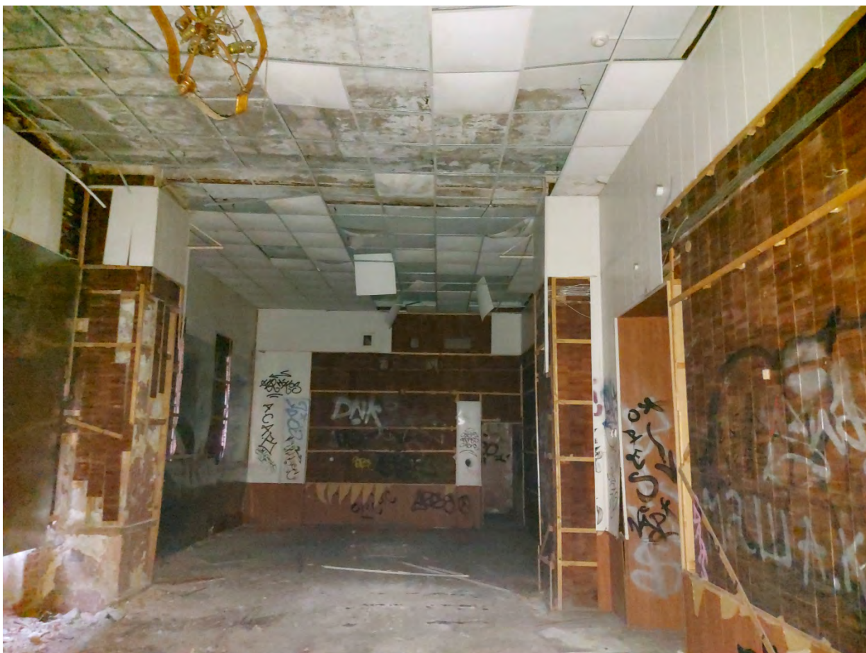
Фото 42. Восточная и центральная часть помещения 14.
