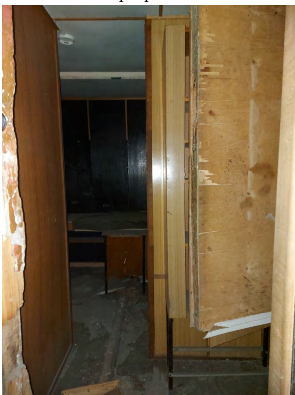
Фото 46. Вид на помещение 13.
