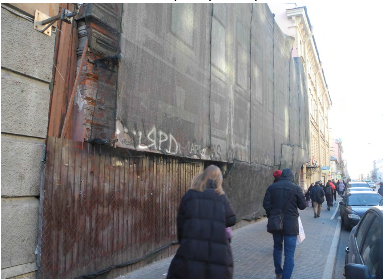
Фото 3. Лицевой фасад с северо-востока.
