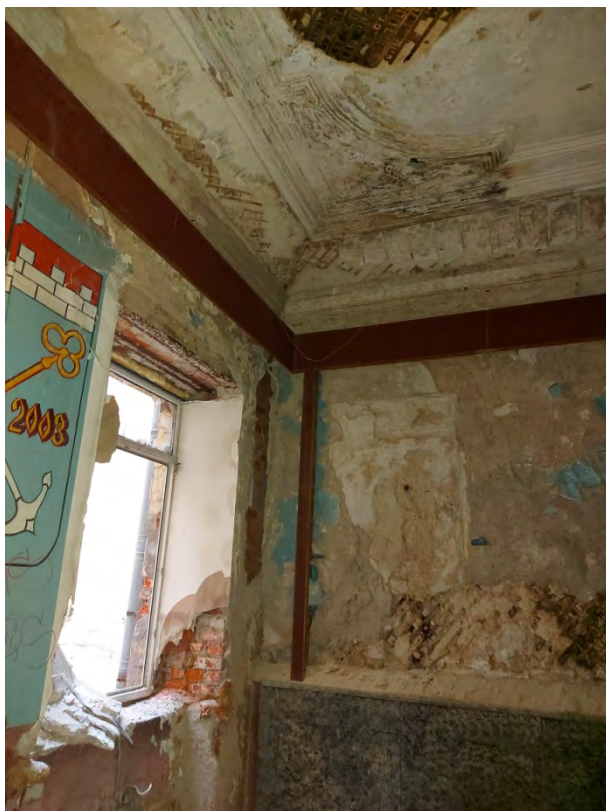
Фото 53. Фрагмент помещения 9, оконный проем.
