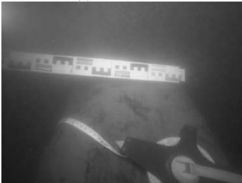
Рис. 190. Кронштадт. Каботажная гавань. Акустическая цель № 20. Деревянная балка.
