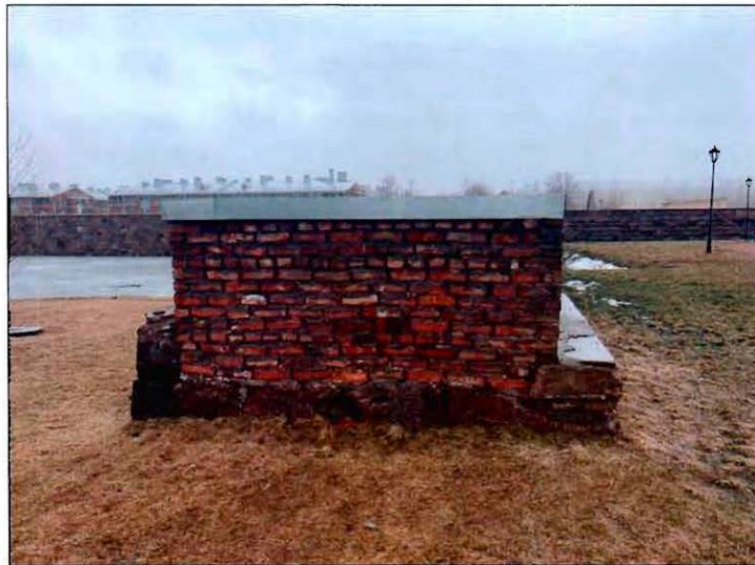
4. Западный фасад объекта культурного наследия.
