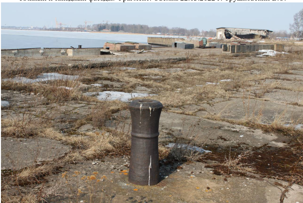
Илл. 06. Объект культурного наследия федерального значения «Гидротехнические сооружения», входящий в состав объекта культурного наследия федерального значения «Гавань купеческая», входящий в состав объекта культурного наследия федерального значения «Набережные и молы со спусками, парапетами, лестницами Итальянского пруда, Купеческой, Средней, Военной и Лесной гаваней с доками Николаевским, Алексеевским, Константиновским, Александровским и другими гидротехническими сооружениями». Северная часть территории. Исторический пушечный кнехт. Съемка 22.03.2022 г. Трушковский В.Э.
