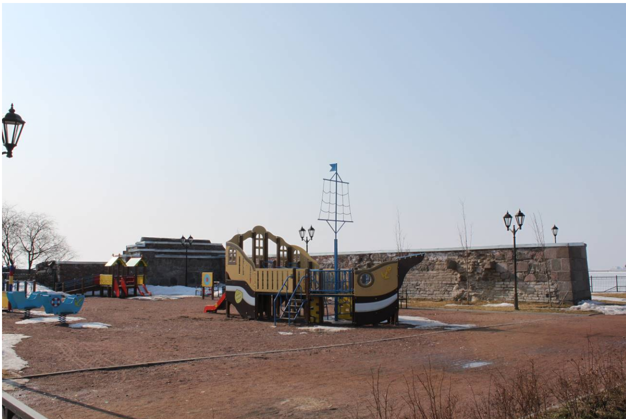
Илл. 03. Объект культурного наследия федерального значения «Крепость Кронштадт». Южная часть территории (сквер Инчхон). Объект культурного наследия федерального значения «Ботардо южное». Съемка 22.03.2022 г. Трушковский В.Э.
