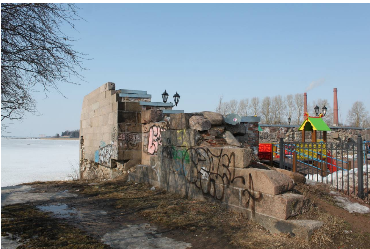
Илл. 04. Объект культурного наследия федерального значения «Ботардо южное». Южный фасад. Съемка 22.03.2022 г. Трушковский В.Э.
