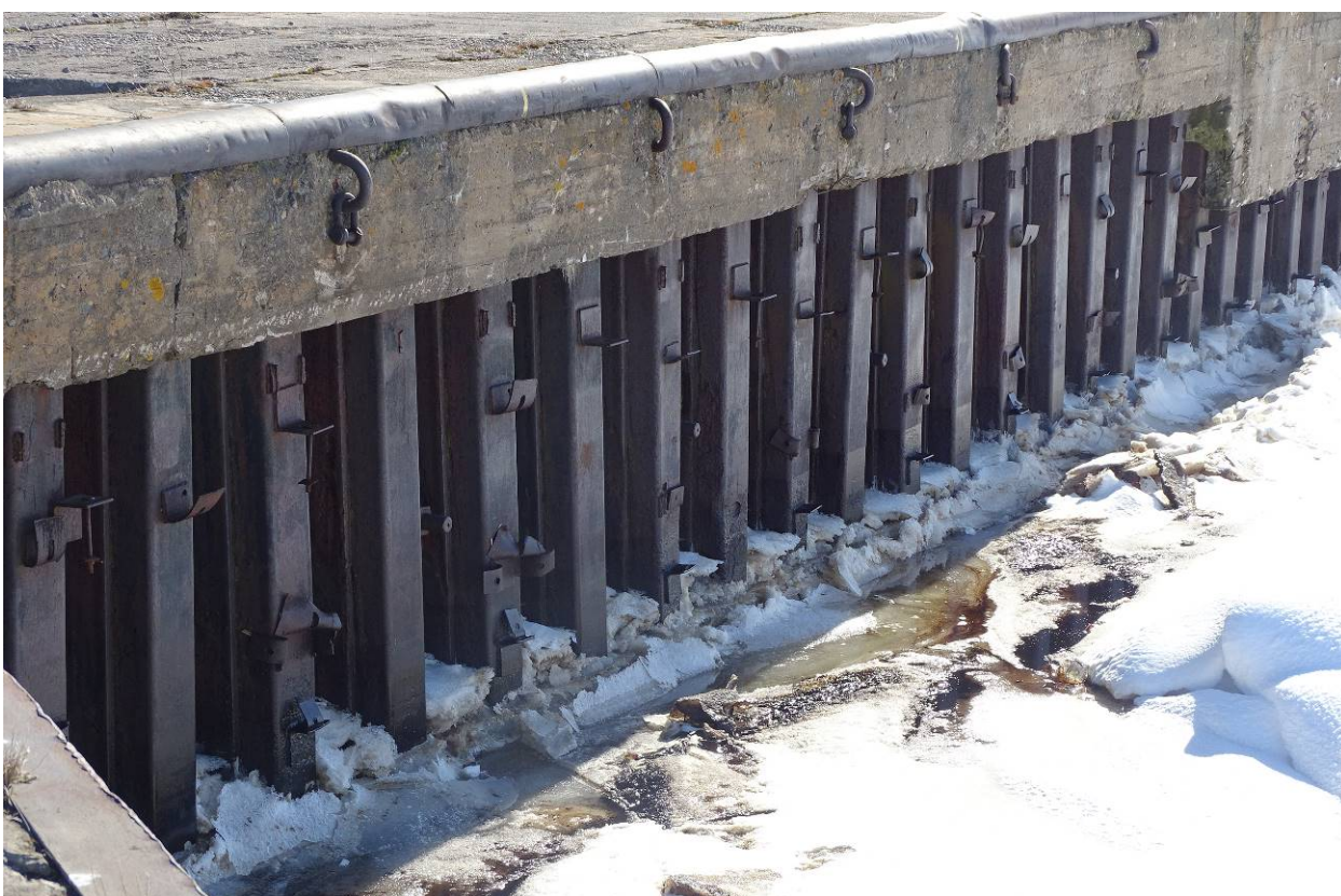
Илл. 16. Объект культурного наследия федерального значения «Гидротехнические сооружения». Мазутный причал. Фрагмент. Съемка 22.03.2022 г. Трушковский В.Э.
