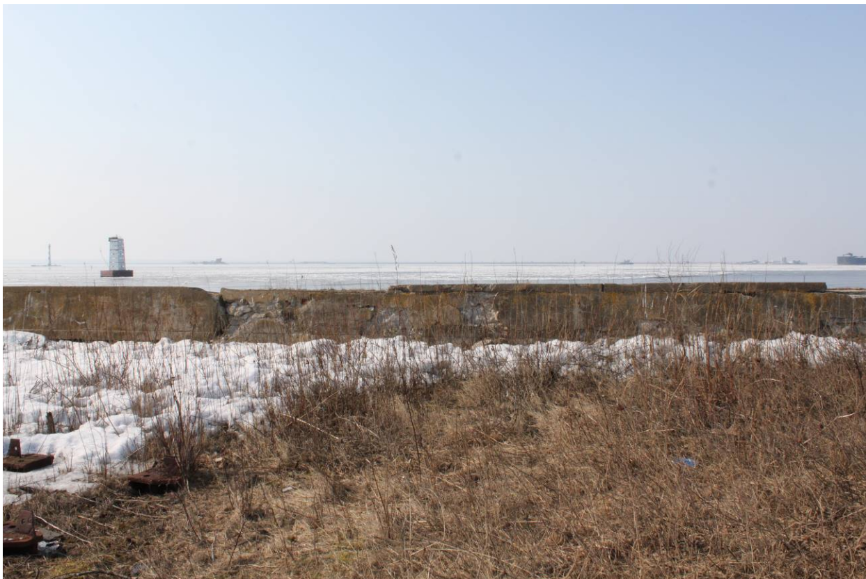
Илл. 09. Объект культурного наследия федерального значения «Гидротехнические сооружения». Разделительный мол. Вид на Каботажную гавань. Съемка 22.03.2022 г. Трушковский В.Э.
