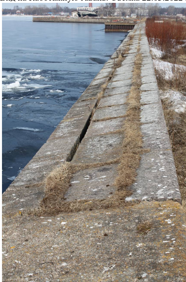
Илл. 10. Объект культурного наследия федерального значения «Гидротехнические сооружения». Южная часть западного оградительного мола. Набережная со стороны Каботажной гавани. Съемка 22.03.2022 г. Трушковский В.Э.
