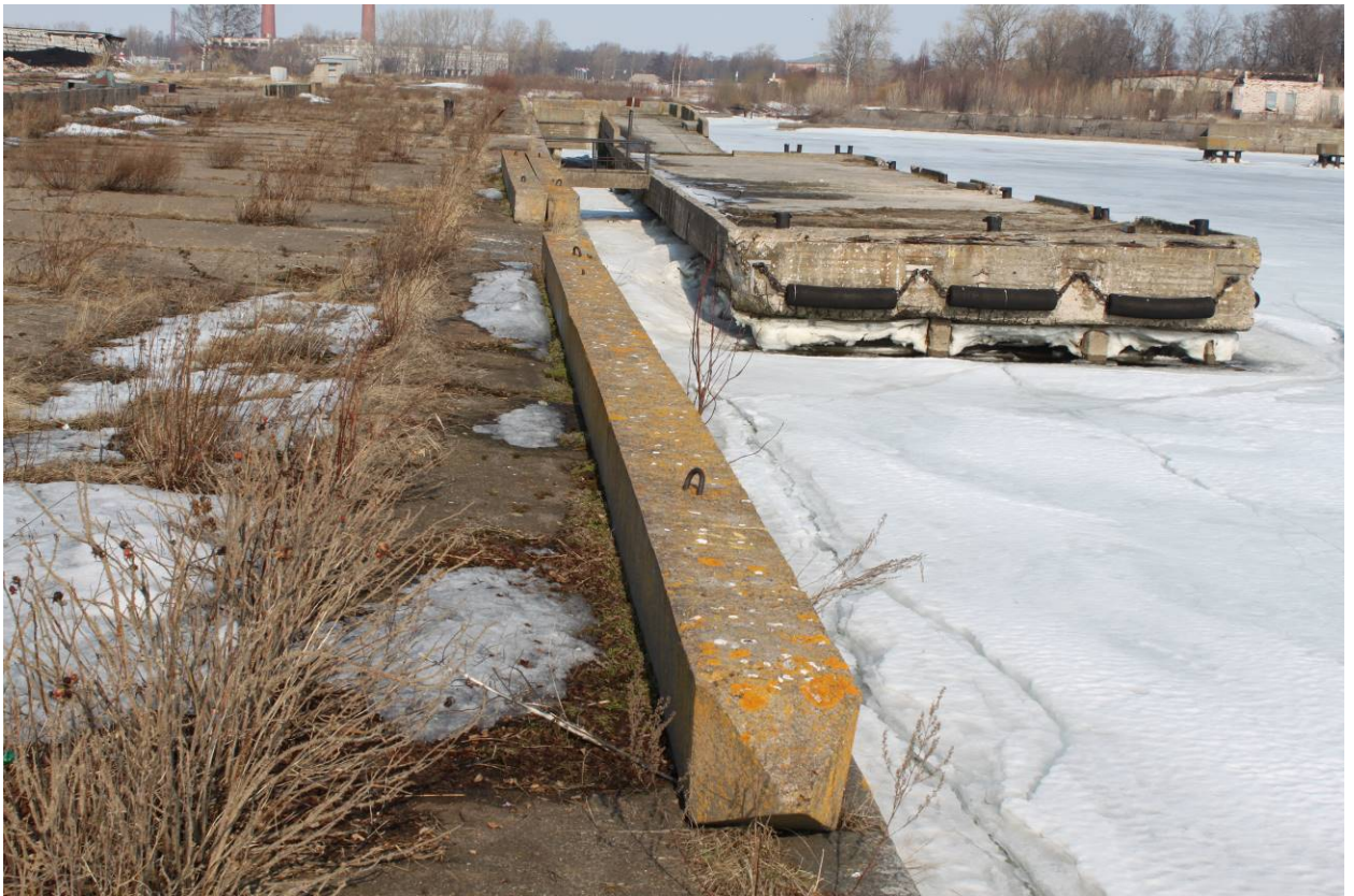
Илл. 13. Объект культурного наследия федерального значения «Гидротехнические сооружения». Оградительный мол. Вид на Причал склада жидкого топлива. Съемка 22.03.2022 г. Трушковский В.Э.
