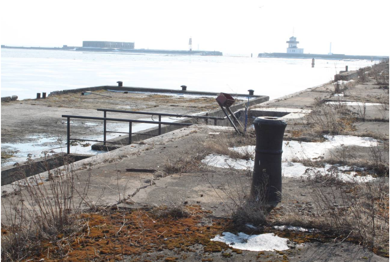
Илл. 14. Объект культурного наследия федерального значения «Гидротехнические сооружения». Оградительный мол. Вид на Причал склада жидкого топлива. Исторический пушечный кнехт. Съемка 22.03.2022 г. Трушковский В.Э.
