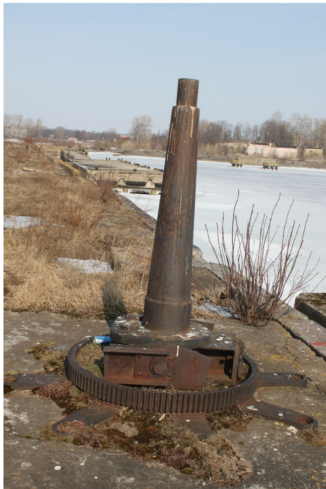
Илл. 07. Объект культурного наследия федерального значения «Гидротехнические сооружения». Разделительный мол. Опорная конструкция подъемного крана. Съемка 22.03.2022 г. Трушковский В.Э.
