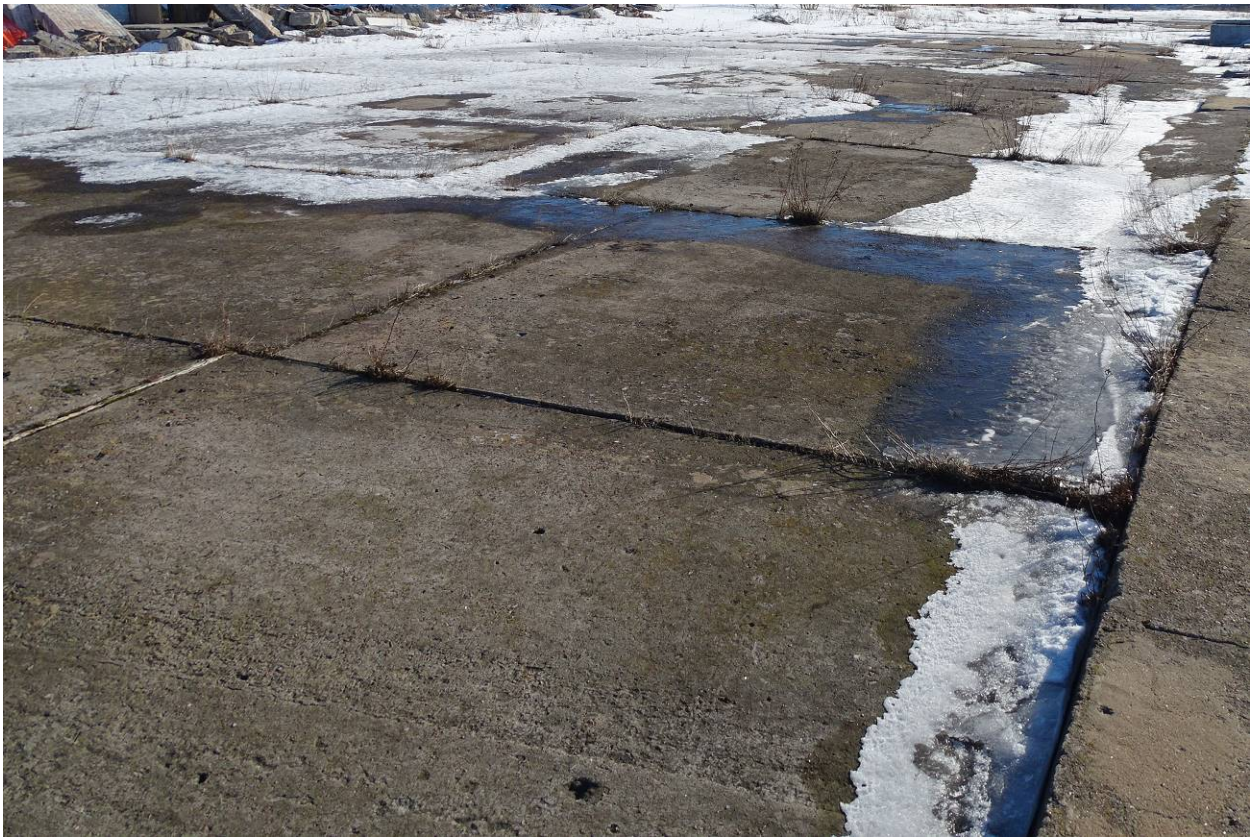
Илл. 17. Объект культурного наследия федерального значения «Гавань Купеческая». Причальная стенка. Вид с северо-запада. Съемка 22.03.2022 г. Трушковский В.Э.
