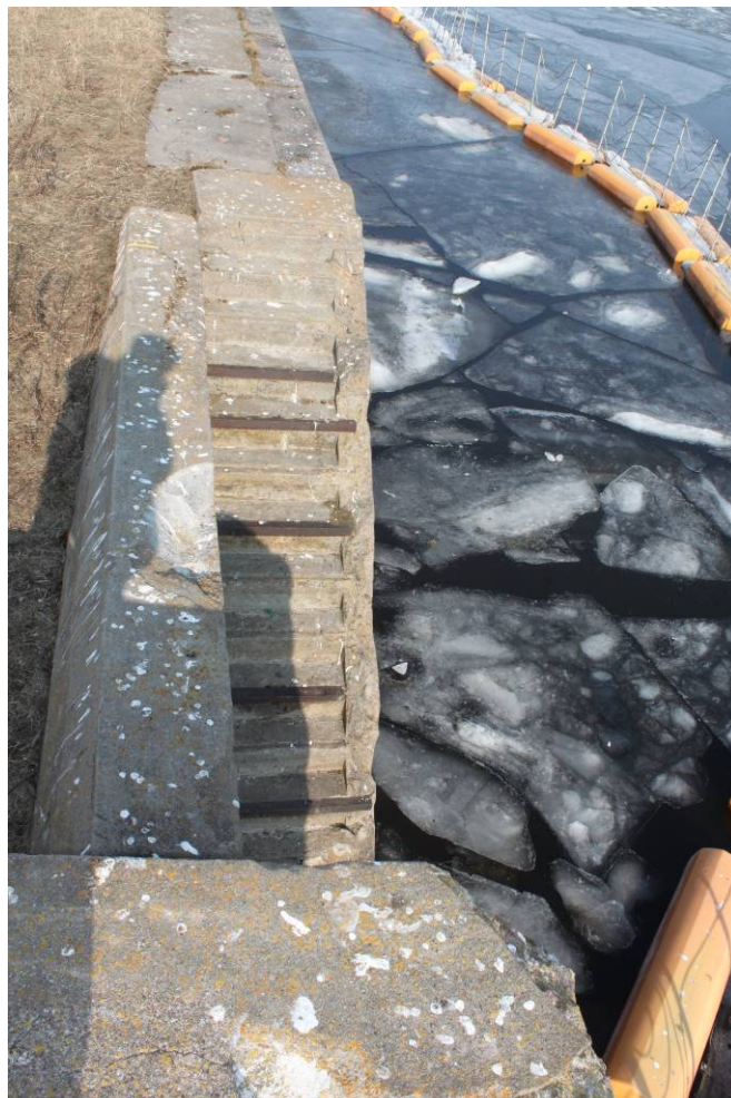
Илл. 03. Объект культурного наследия федерального значения «Гидротехнические сооружения». Спуск к воде в южной части западного разделительного мола. Съемка 22.03.2022 г. Трушковский В.Э.
