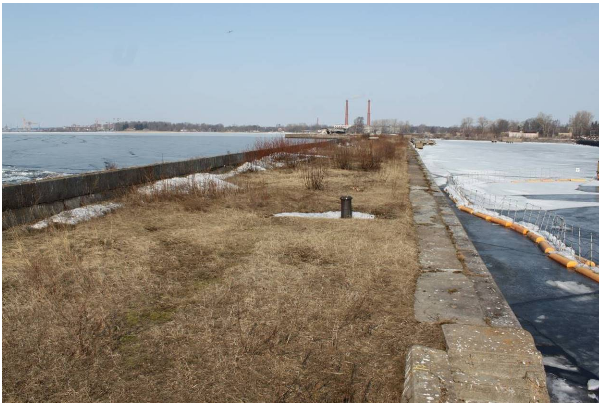
Илл. 01. Объект культурного наследия федерального значения «Гидротехнические сооружения», входящий в состав объекта культурного наследия федерального значения «Гавань купеческая», входящий в состав объекта культурного наследия федерального значения «Набережные и молы со спусками, парапетами, лестницами Итальянского пруда, Купеческой, Средней, Военной и Лесной гаваней с доками Николаевским, Алексеевским, Константиновским, Александровским и другими гидротехническими сооружениями». Вид с юга. Исторический пушечный кнехт. Съемка 22.03.2022 г. Трушковский В.Э.
