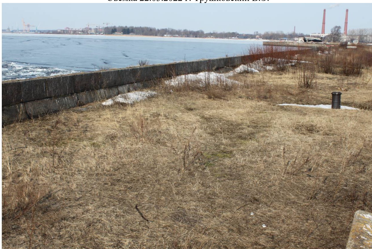
Илл. 04. Объект культурного наследия федерального значения «Гидротехнические сооружения». Вид на Каботажную гавань. Съемка 22.03.2022 г. Трушковский В.Э.
