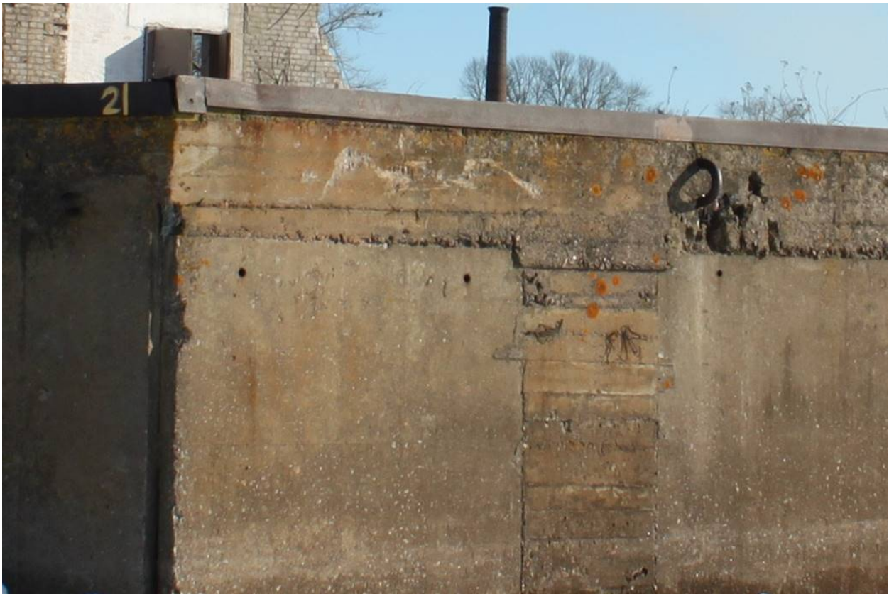
Илл. 13. Объект культурного наследия федерального значения «Гавань Купеческая». Причальная стенка. Съемка 22.03.2022 г. Трушковский В.Э.
