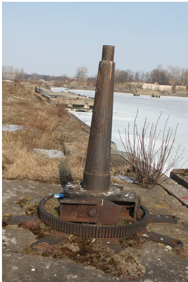
Илл. 03. Объект культурного наследия федерального значения «Гидротехнические сооружения». Разделительный мол. Опорная конструкция подъемного крана. Съемка 22.03.2022 г. Трушковский В.Э.
