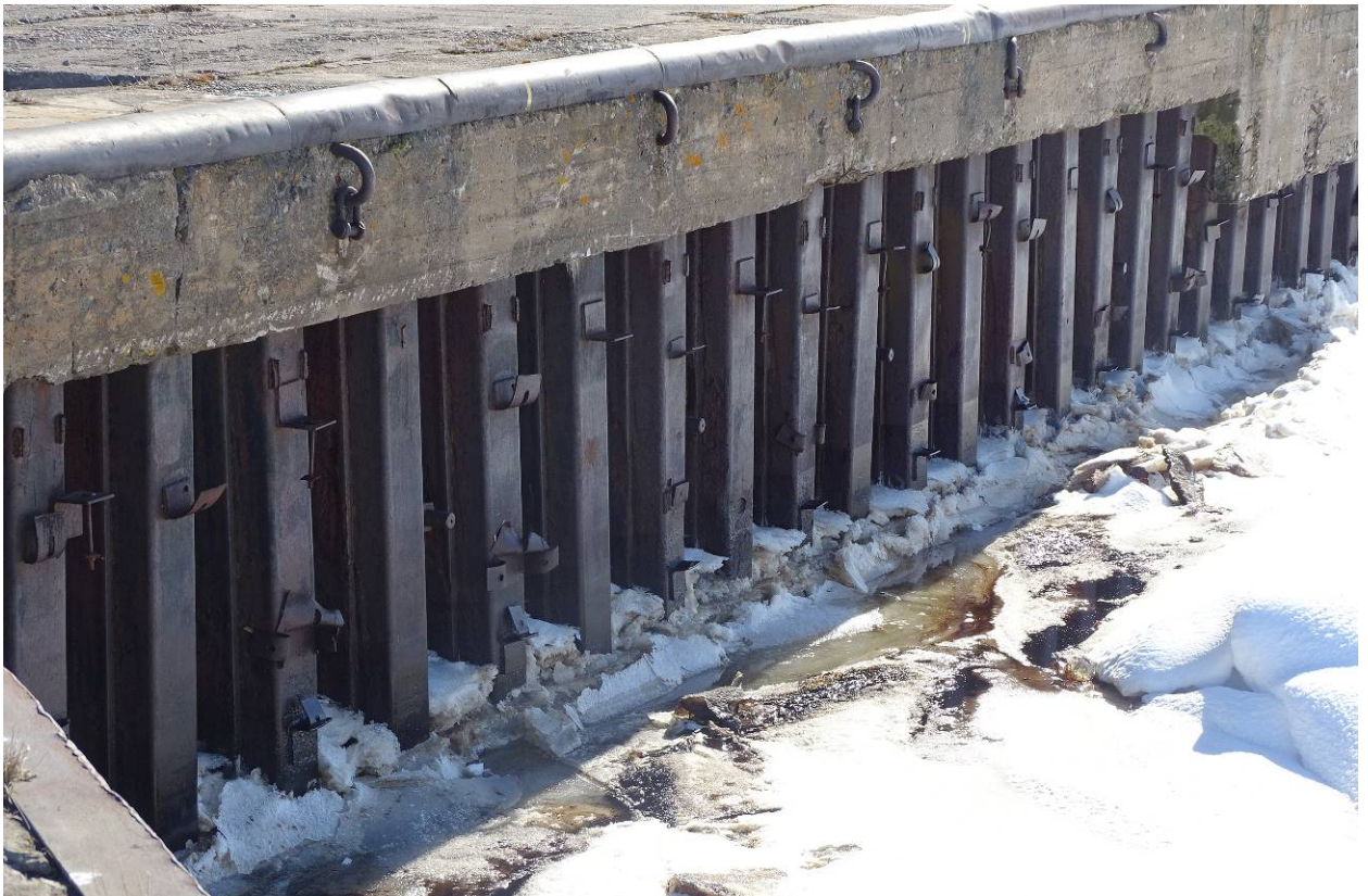
Илл. 10. Объект культурного наследия федерального значения «Гидротехнические сооружения». Мазутный причал. Фрагмент. Съемка 22.03.2022 г. Трушковский В.Э.
