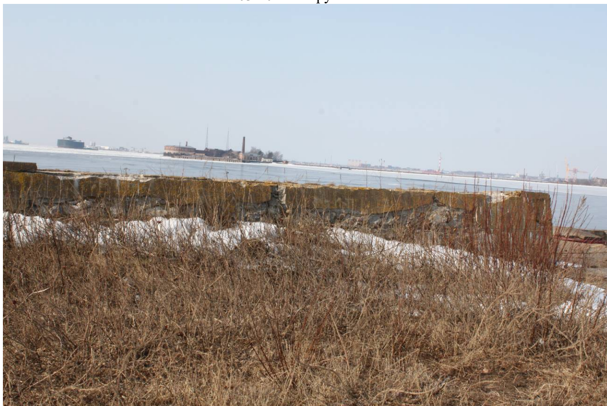
Илл. 08. Объект культурного наследия федерального значения «Гидротехнические сооружения». Оградительный мол. Вид на Каботажную гавань. Съемка 22.03.2022 г. Трушковский В.Э.
