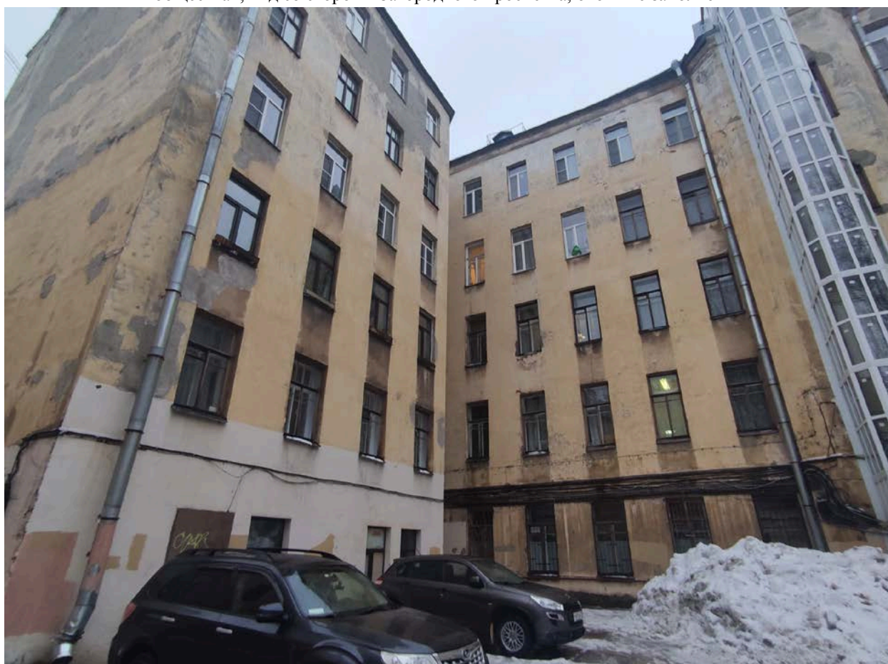
Фото 8. Фрагмент дворового фасада объекта культурного наследия «Дом Санкт-Петербургского Мещанского общества»
