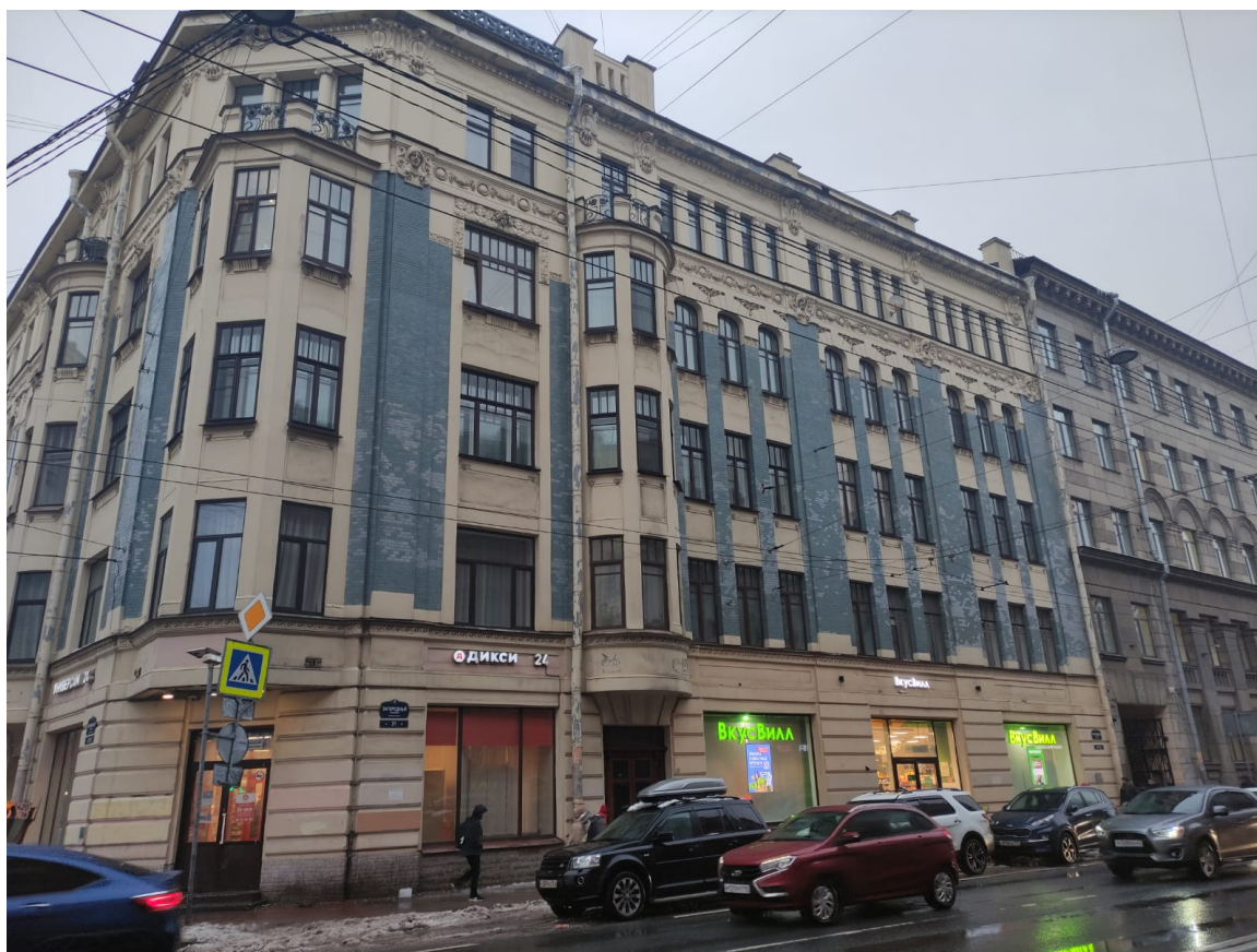
Фото 3. Фрагмент лицевого фасада объекта культурного наследия «Дом Санкт-Петербургского Мещанского общества», вид со стороны Загородного проспекта
