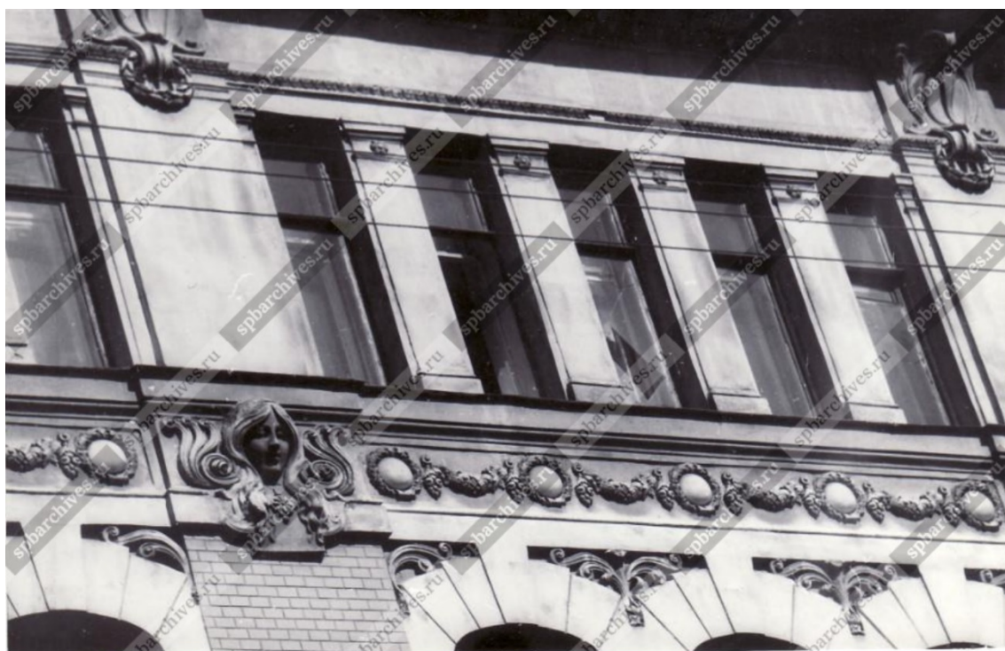
50. Вид части фасада жилого дома № 31 на Загородном проспекте (бывший доходный дом Мещанского общества, архитектор Н.К. Прянишников, 1910 г.). 8 мая 1994 г. — ЦГАКФФД СПб. Шифр: Ар 211987.
