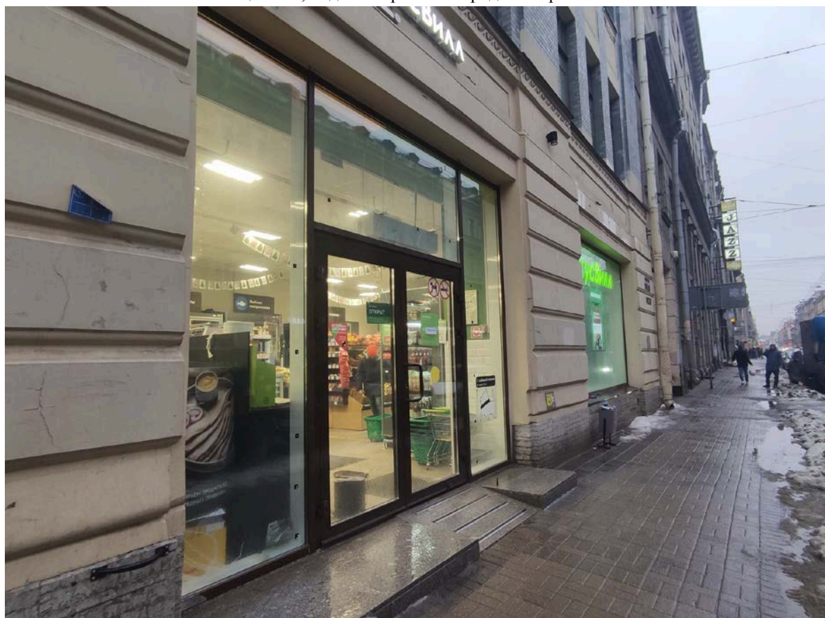
Фото 6. Фрагмент лицевого фасада объекта культурного наследия «Дом Санкт-Петербургского Мещанского общества», вид со стороны Загородного проспекта, оконные и дверные заполнения
