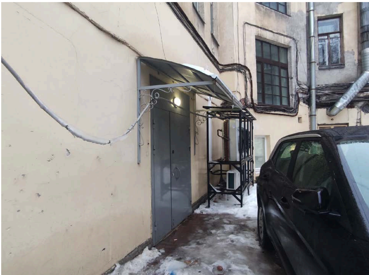
Фото 11. Фрагмент дворового фасада объекта культурного наследия «Дом Санкт-Петербургского Мещанского общества», металлический козырек
