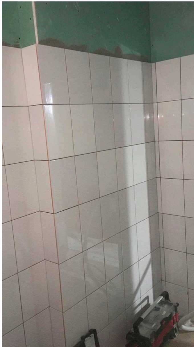
4. Пом. 4 (помещение уборочного инвентаря)
