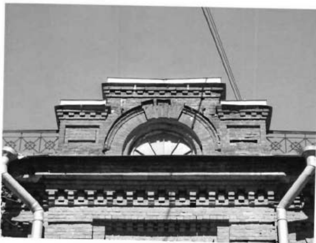
3. Фрагмент лицевого фасада (аттик)
