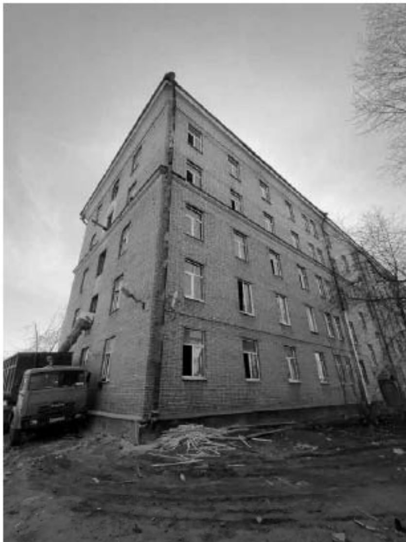
20. Рассматриваемый объект по адресу: г. Санкт-Петербург, 21-я линия В.О., дом 14, литера Г. Вид с севера. Дата съемки: 22 апреля 2022 г.
