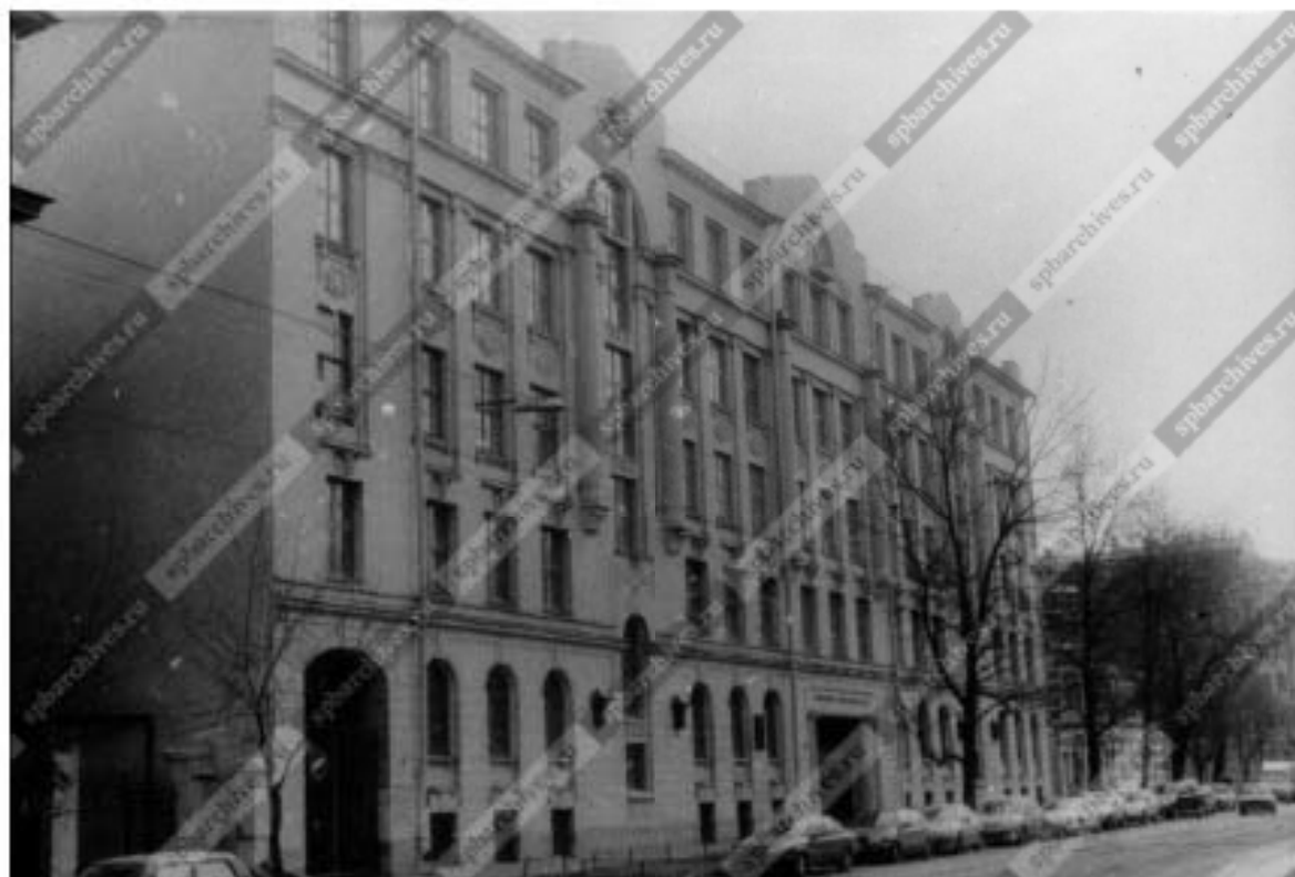
Илл. 69. Общий вид дома № 7 на 22-й линии Васильевского острова (бывший городской училищный дом в память 19 февраля 1861 года, архитектор И.И.Яковлев, 1911 г.; с 1973 года здание занимает юридический факультет Санкт-Петербургского университета). Дата съёмки: 29 марта 2003 г. // ЦГАКФФД СПб. Архивный шифр: Ар 217370.
