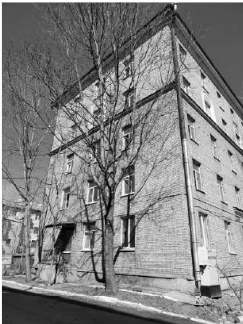
15. Рассматриваемый объект по адресу: г. Санкт-Петербург, 21-я линия В.О., дом 14, литера Г. Вид с юго-запада. Дата съемки: 22 апреля 2022 г.
