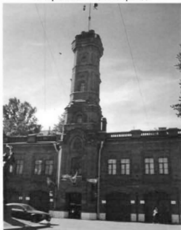
1. Фрагмент лицевого фасада
