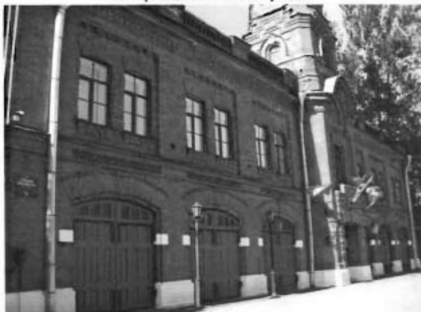
2. Фрагмент лицевого фасада
