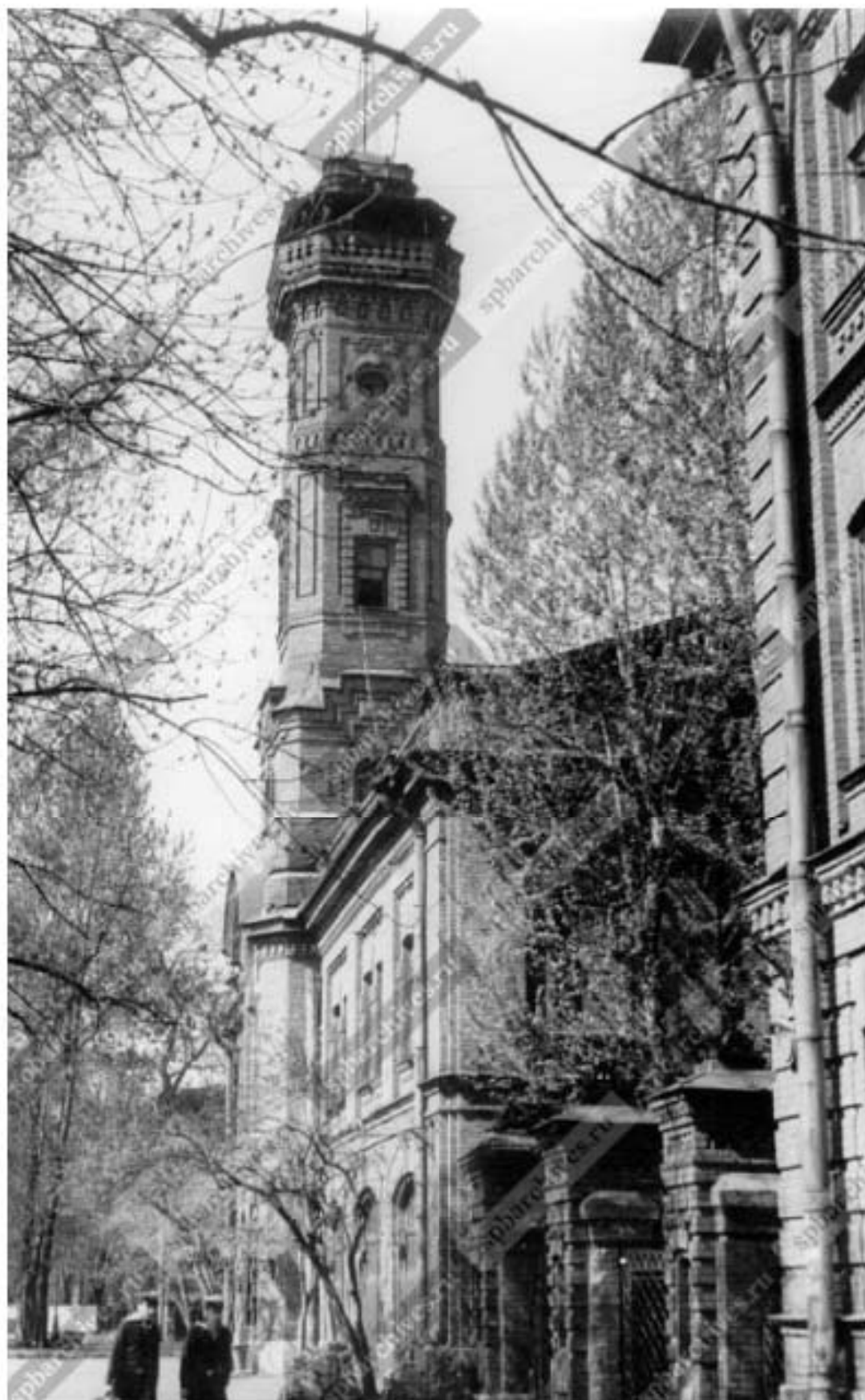
Илл. 34. Вид здания пожарной части с башней по Большому проспекту Васильевского острова, 73 (бывшее пожарное отделение с конюшней, учебно-сушильной башней и служебным флигелем, инженер В.Г. Шаламов, 1882- 1884 гг., пристройка башни к зданию 1910- е годы). Дата съёмки: 20 мая 1978 г. // ЦГАКФФД СПб. Архивный шифр: Ар 217414.
