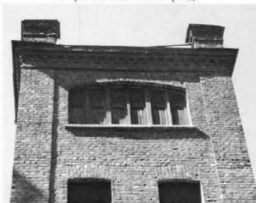
2. Фрагмент южной части фасада
