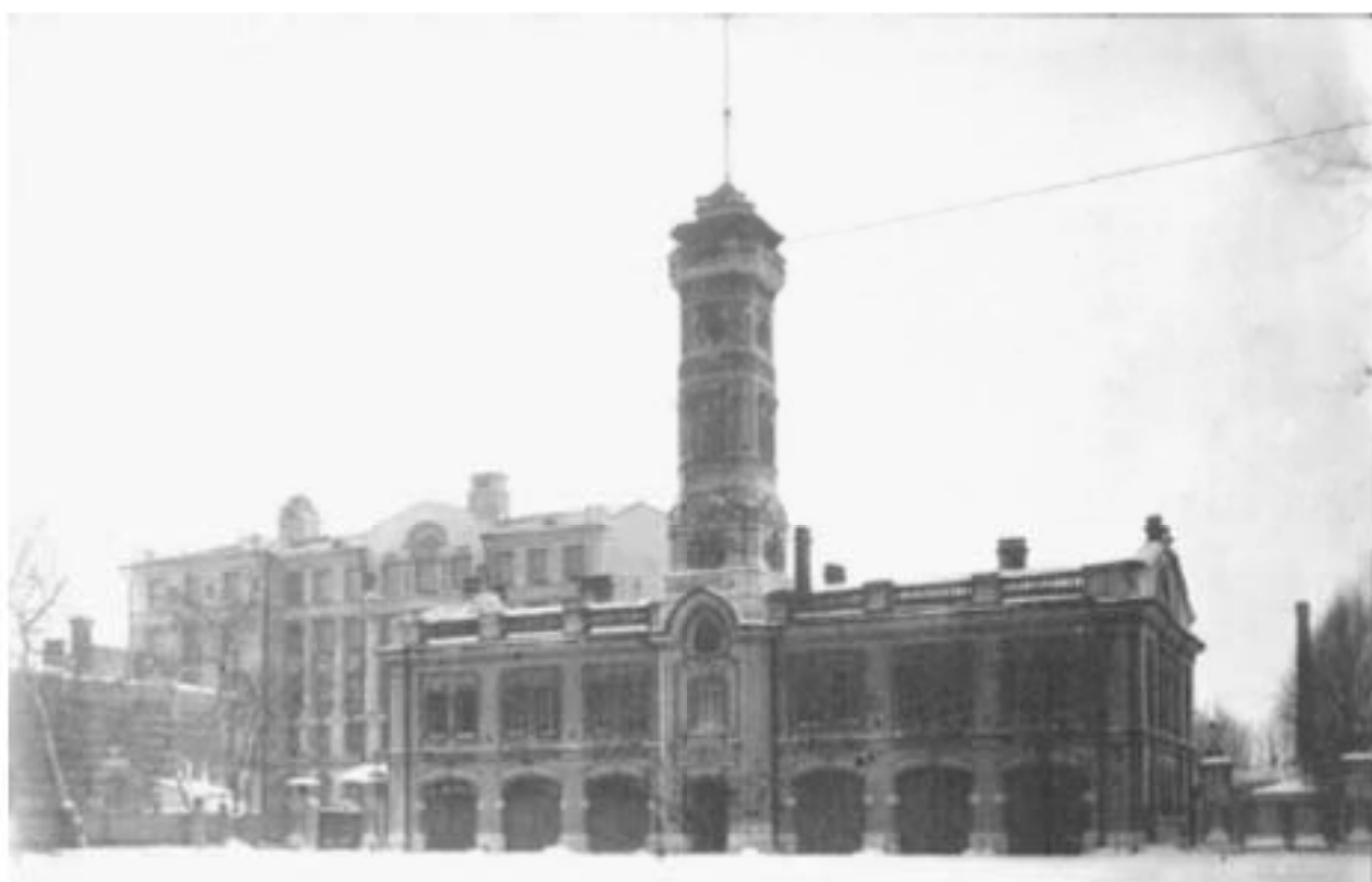
Илл. 30. Пожарная часть на проспекте Пролетарской победы. 1927 г. // https://pastvu.com/p/1255236
