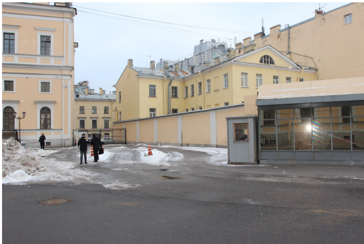
Рис. 29. Московский вокзал-2022. Точка фотофиксации 6, вид на восток.
