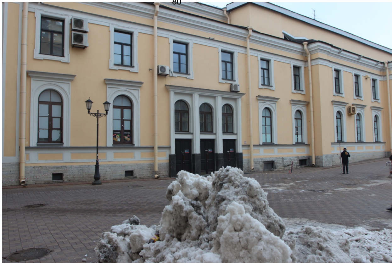
Рис. 20. Московский вокзал-2022. Точка фотофиксации 1, вид на юго-восток.
