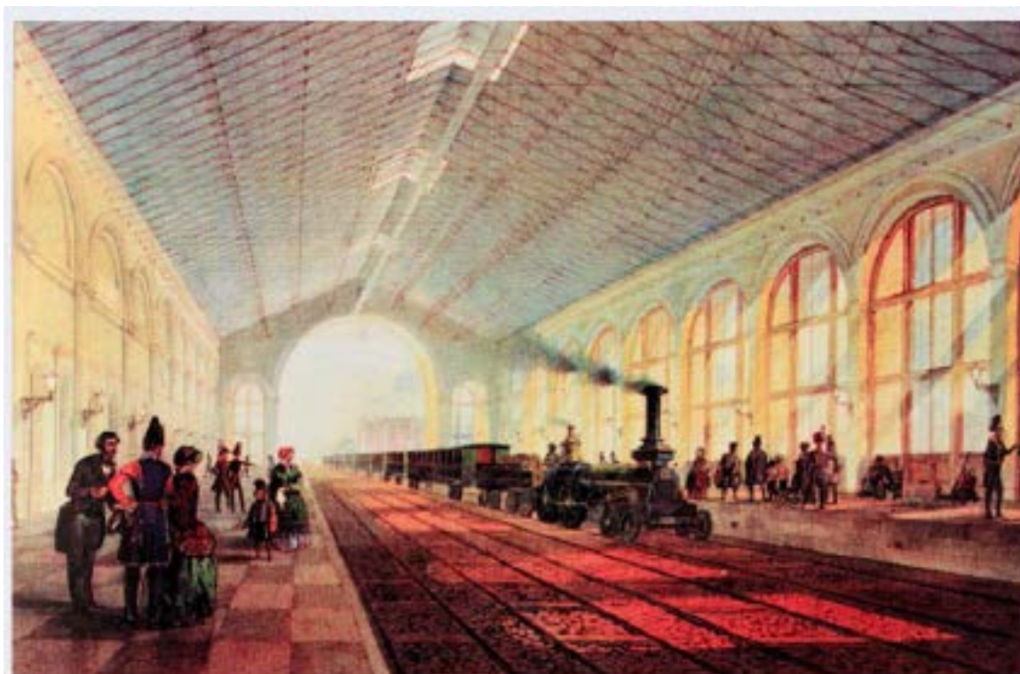
Рис. 11. Крытый перрон (галерея) Санкт-Петербургской пассажирской станции. Акварель А. Петцольта. 1851 г. РНБ, Фонд эстампов, Шифр: ЭАЛТ247777.
