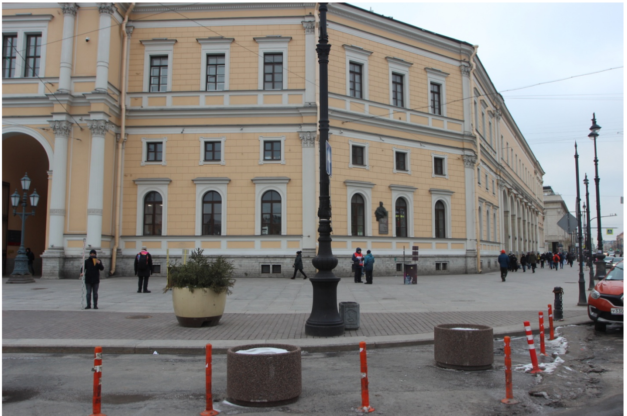
Рис. 19. Московский вокзал-2022. Точка фотофиксации 1, вид на юго-запад.
