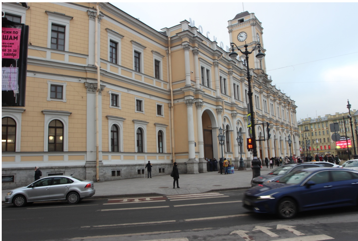
Рис. 23. Московский вокзал-2022. Точка фотофиксации 4, вид на запад.
