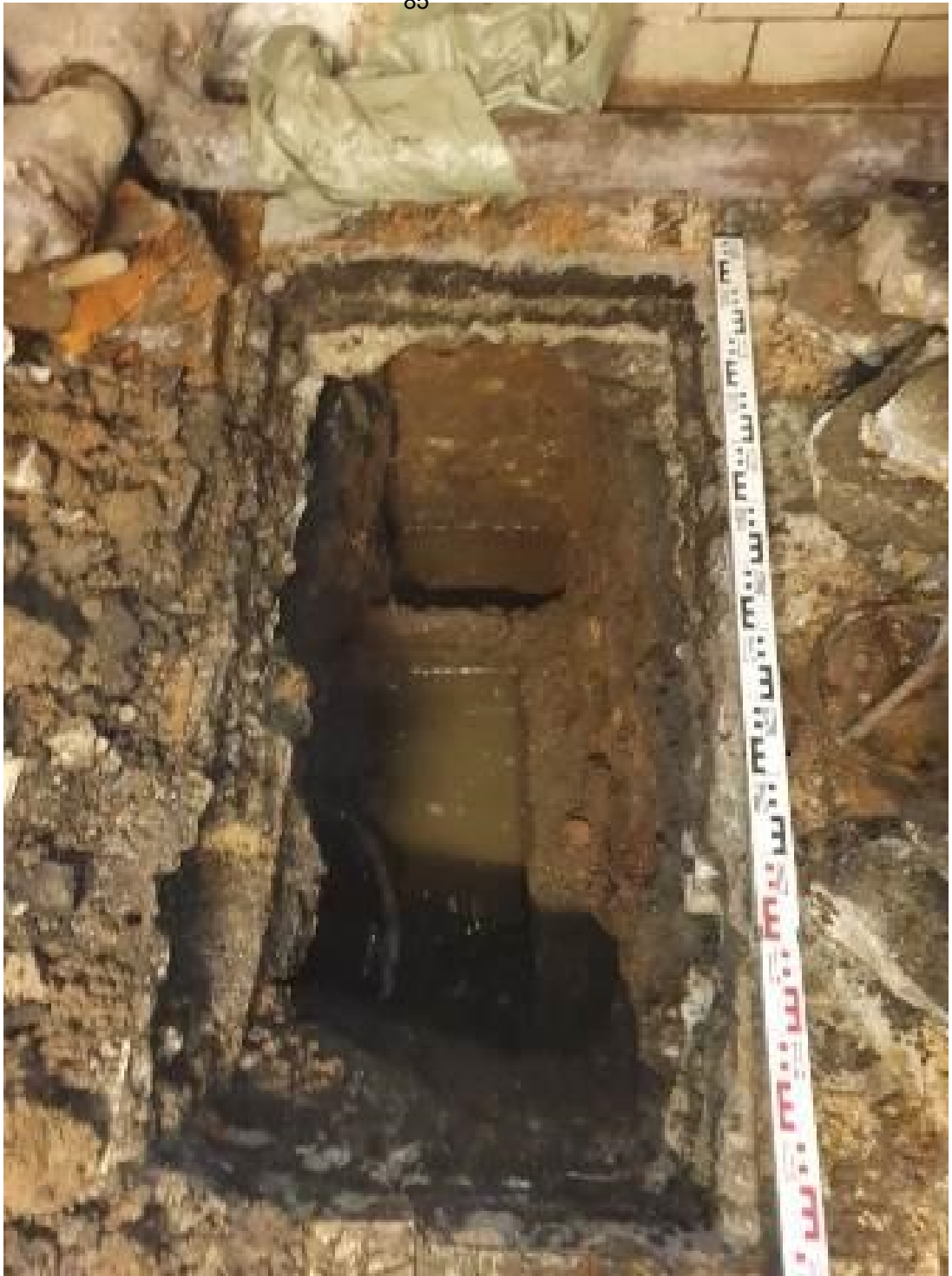
Рис. 30. Московский вокзал-2022. Шурф 1, фиксация по уровню окончания работ, вид на восток.
