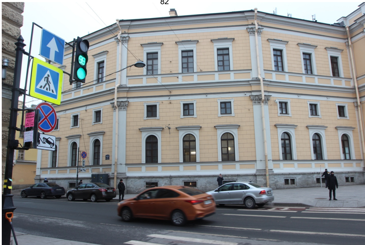
Рис. 24. Московский вокзал-2022. Точка фотофиксации 4, вид на юго-запад.
