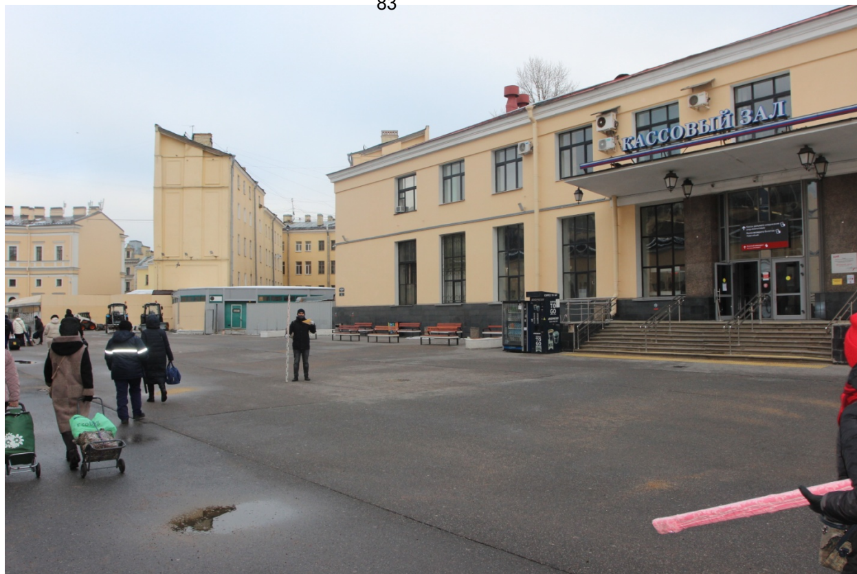
Рис. 26. Московский вокзал-2022. Точка фотофиксации 5, вид на восток.
