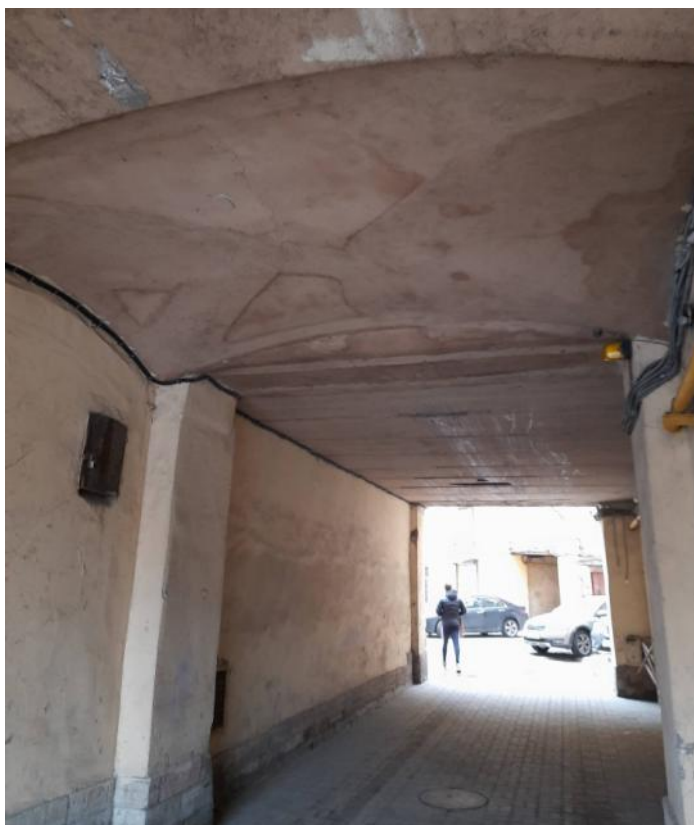
Фото 4 Воротный проезд выявленного объекта культурного наследия «Дом Р.С.Грובה» по адресу: Санкт-Петербург, Марата ул., д. 55/5, лит. А,
