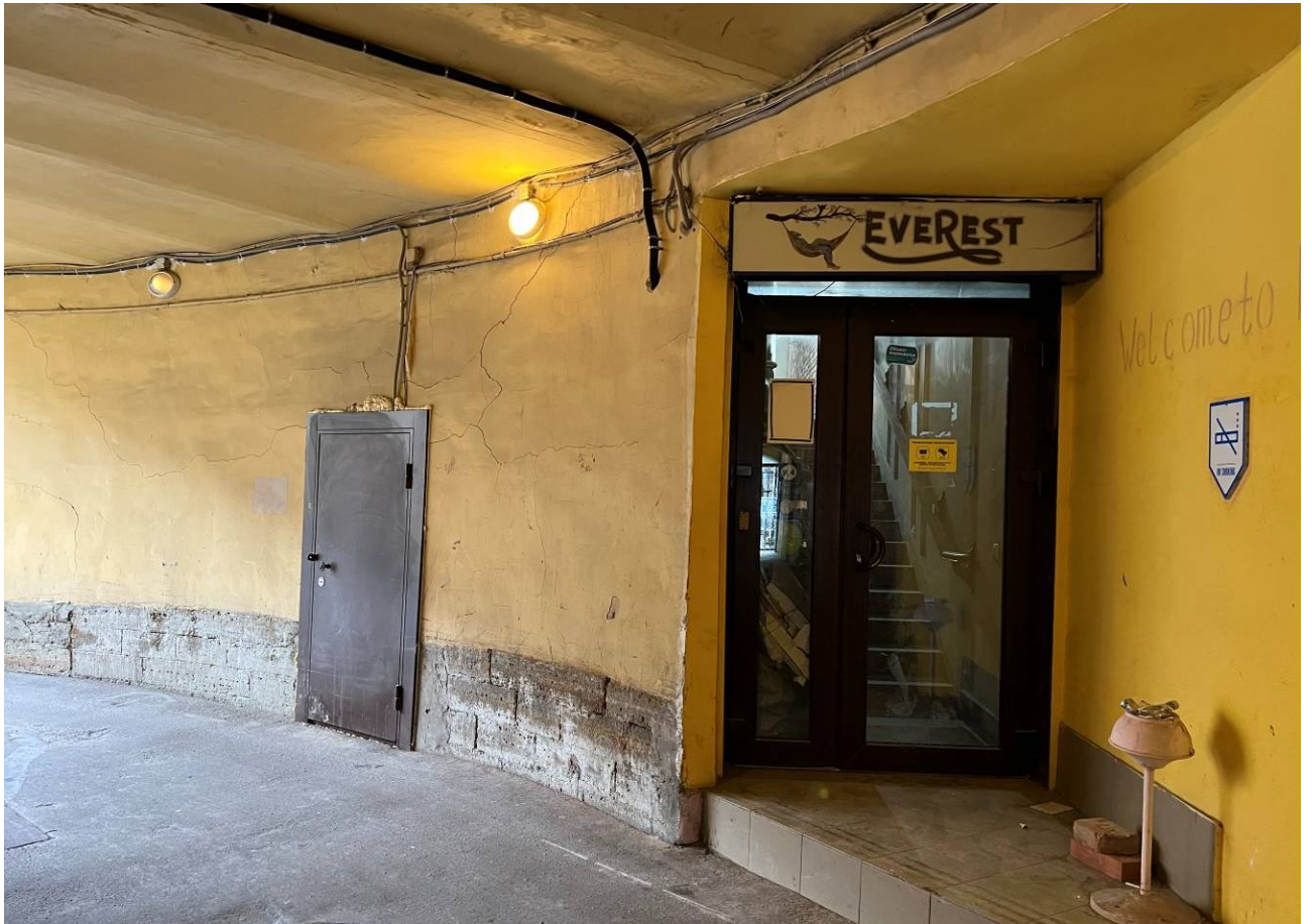
6. Вид на отдельный вход в помещение 17-Н со стороны встроенного воротного проезда.
