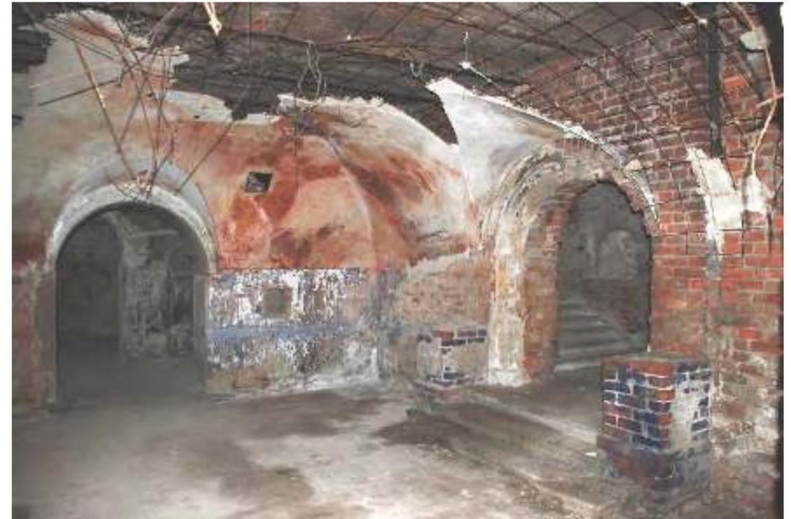
Илл. 106. Теплые сени. Общий вид. Фото 2008 г. Видны металлические конструкции ложных сводов.
