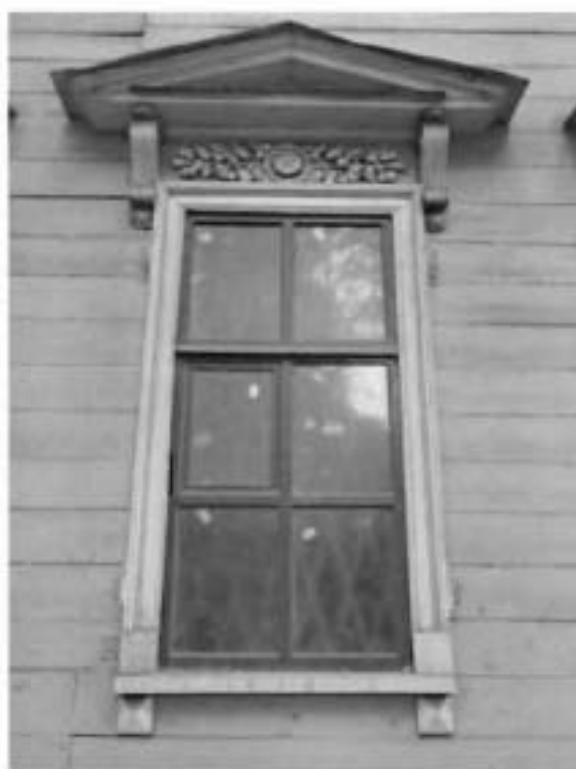
4. Оконный проем первого этажа.
