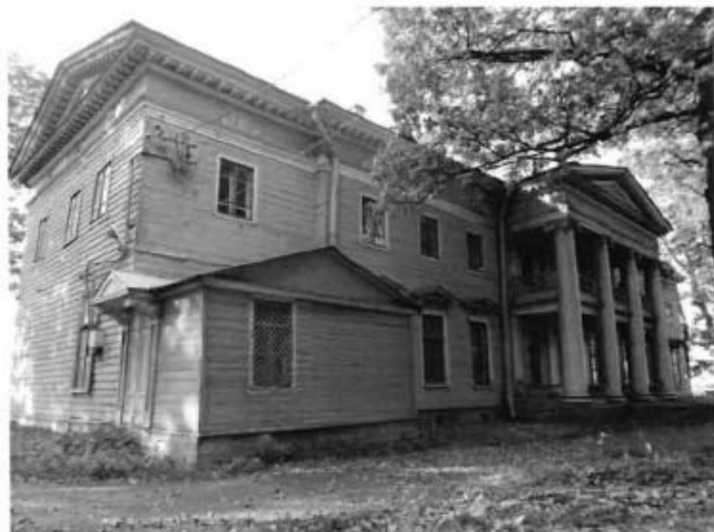
2. Общий вид с северо-востока.
