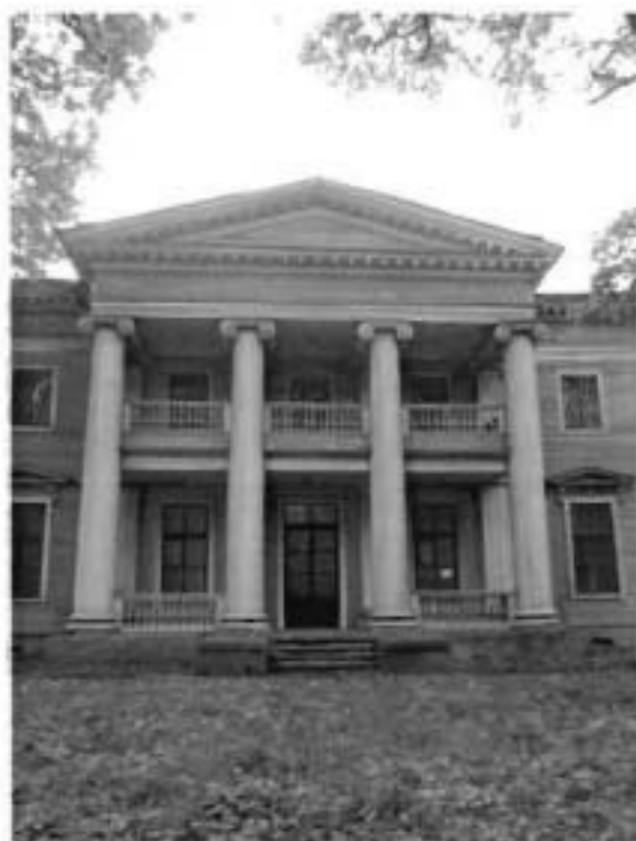
5. Портик со стороны северного фасада.
