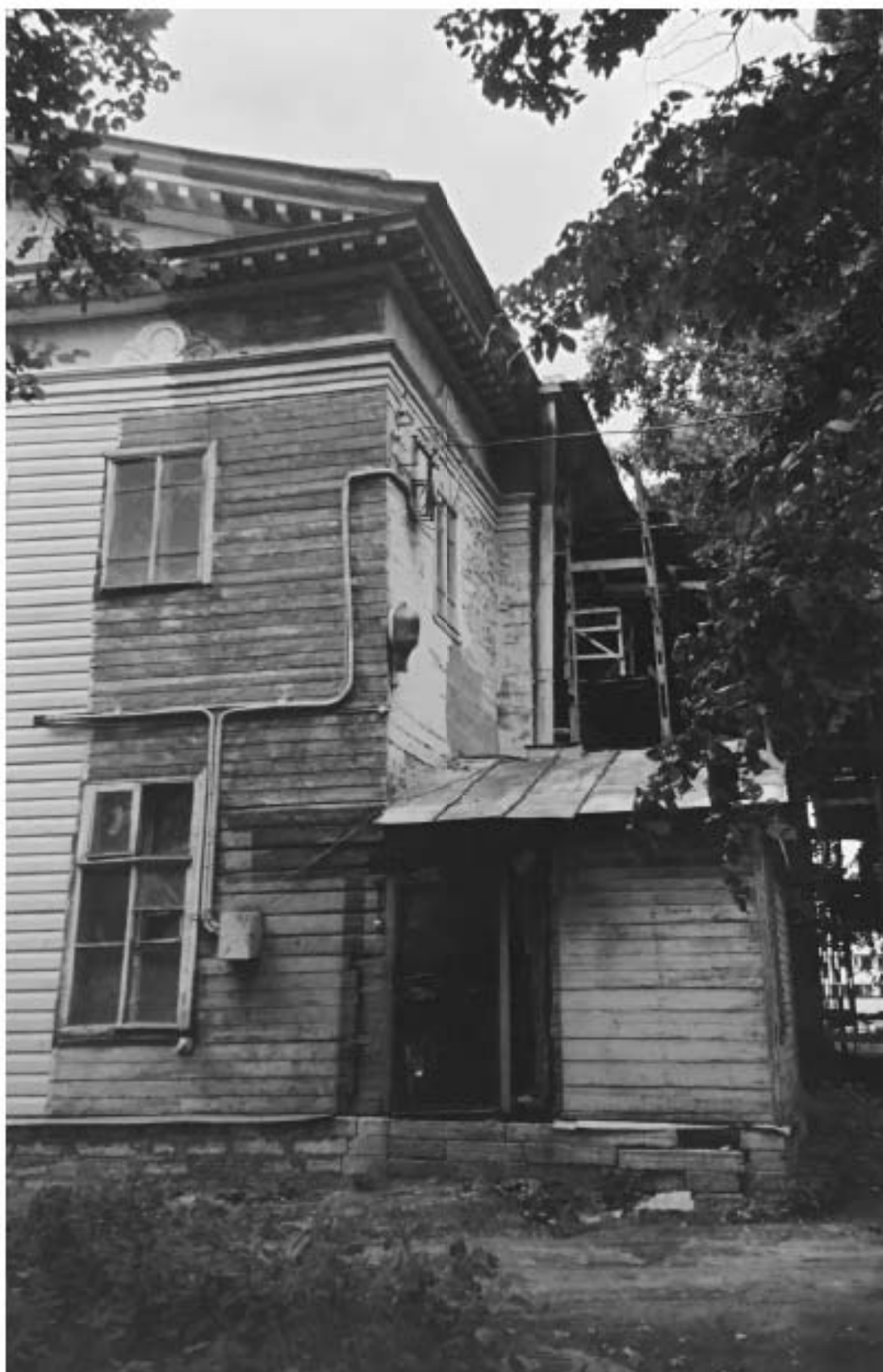
Ил. 31. Дача Головина. Восточный и северный фасады дачи (угол дома). Автор: Пекарева П.Д. 2005 г.
