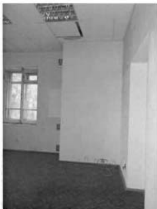
10. Интерьер помещения второго этажа.
