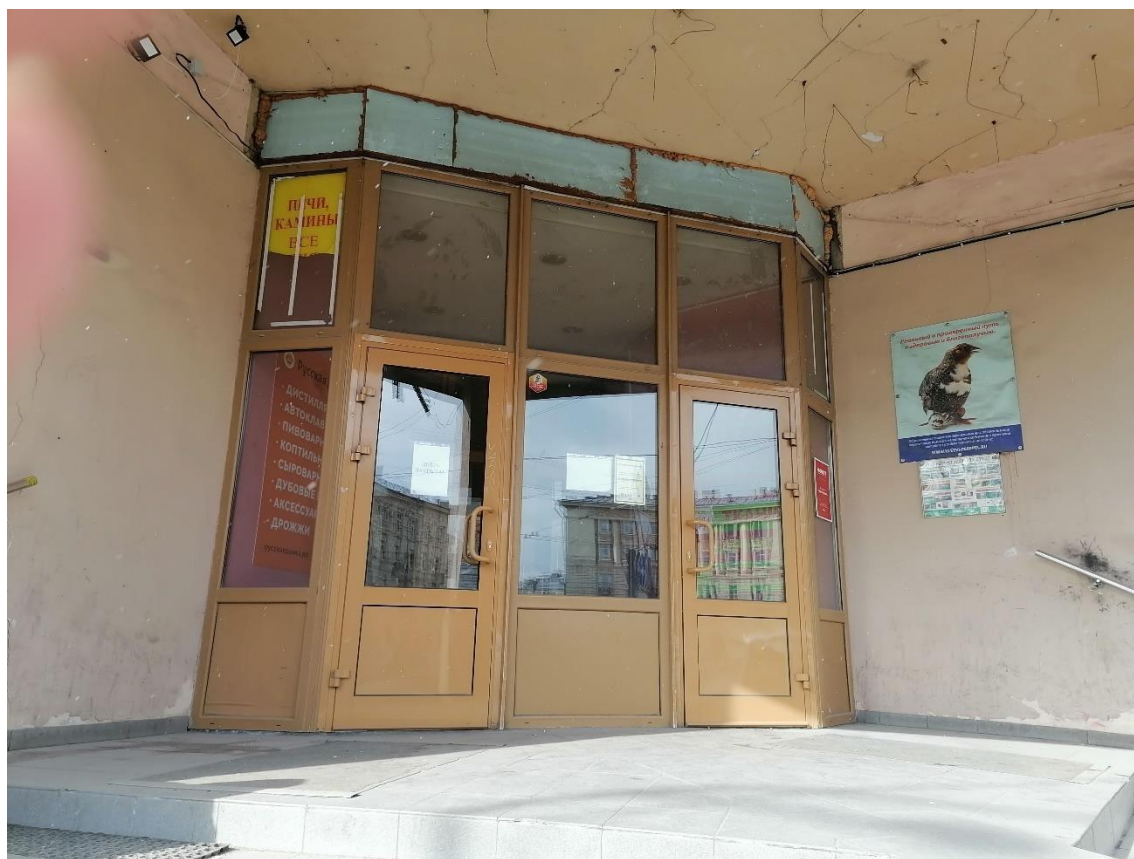
Илл.6. Центральный вход в здание Калининского универмага. 31.03.2022г.
