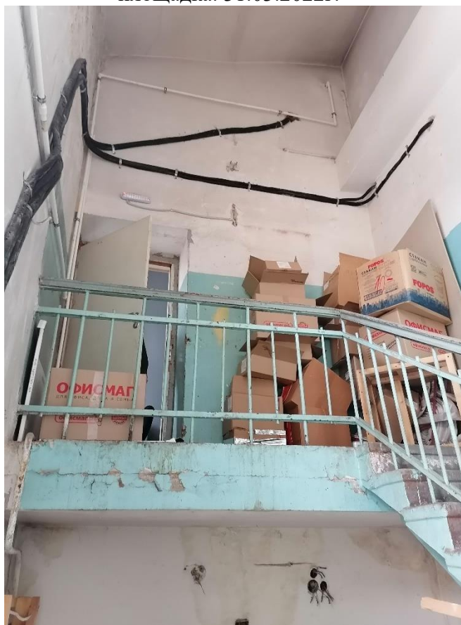
Илл.31. Лестничная клетка в части здания со стороны Кондратьевского проспекта. Верхняя площадка. 31.03.2022г.
