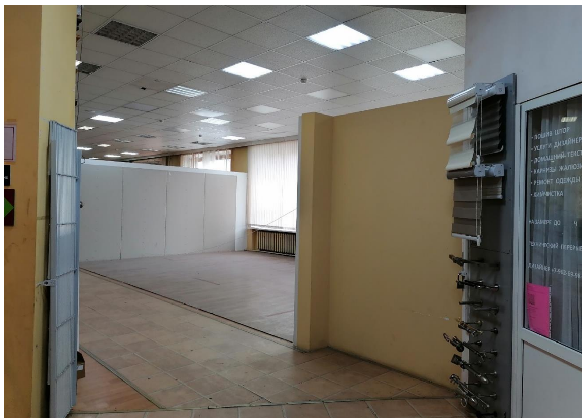
Илл.26. 2-ой этаж (помещение №5 в части здания со стороны Полюстровского проспекта). 31.03.2022г.
