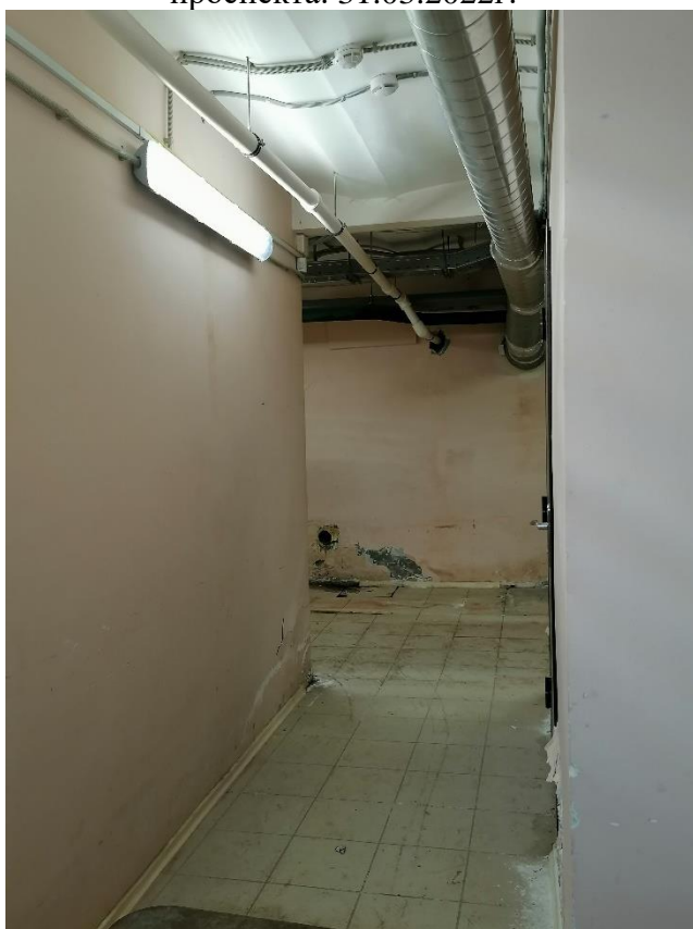
Илл.43. Подвал. Помещение №6 в части здания со стороны Полюстровского проспекта. 31.03.2022г.
