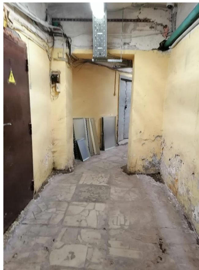
Илл.47-1. Подвал. Коридор в центральной части здания. 31.03.2022г.
