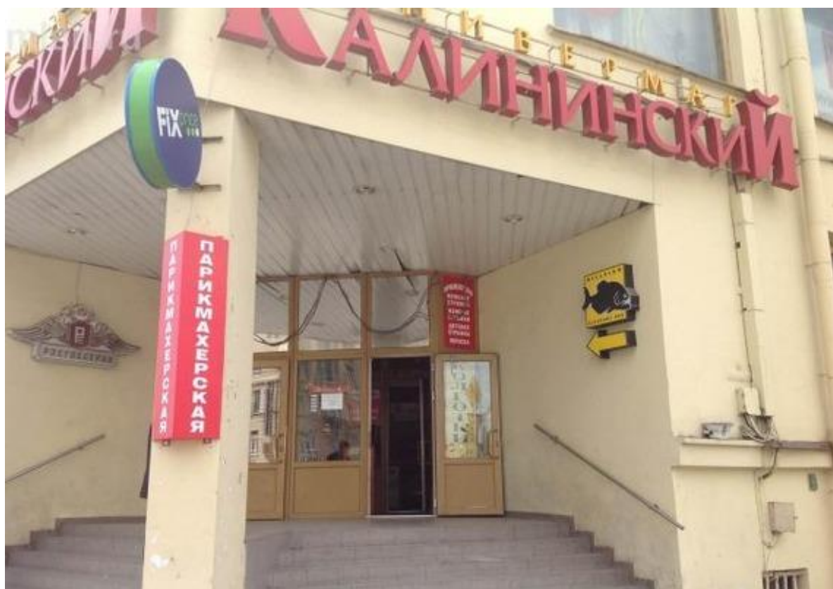
Илл.47. Вход в Калининский универмаг. Центральный пилон оштукатурен и не облицован плиткой. Период с 2013 по 2015гг.
