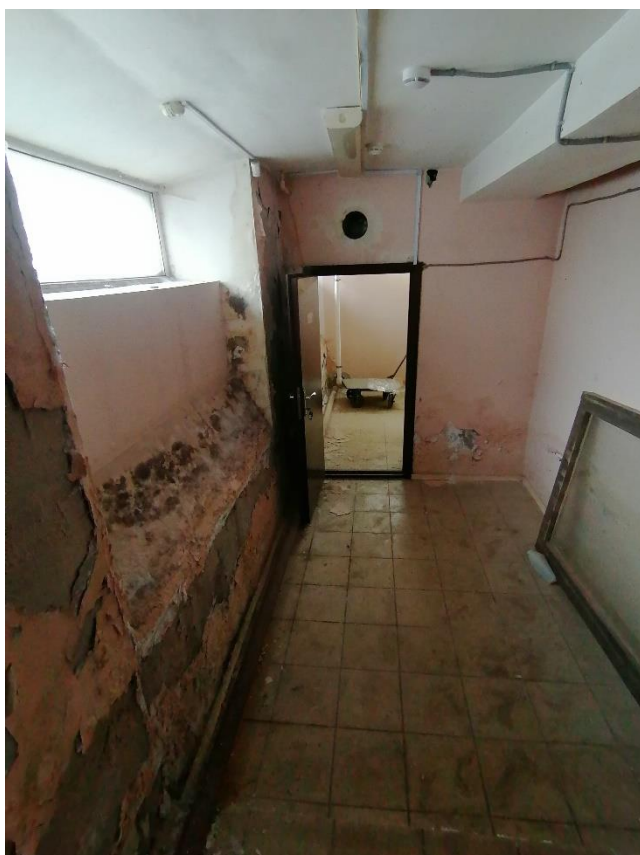
Илл.45. Подвал. Помещение №4 с лестницей в части здания со стороны Полюстровского проспекта. 31.03.2022г.
