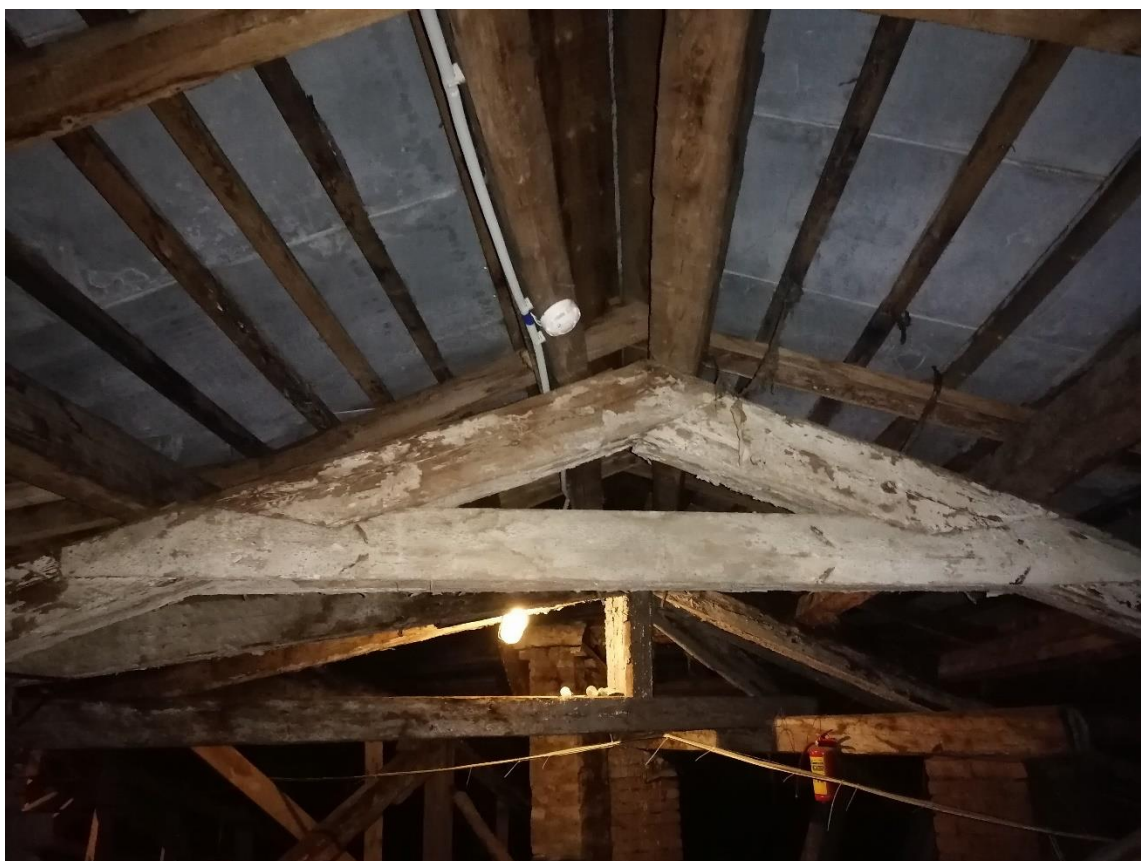
Илл.38. Фрагмент деревянных ферм чердачных конструкций. 31.03.2022г.
