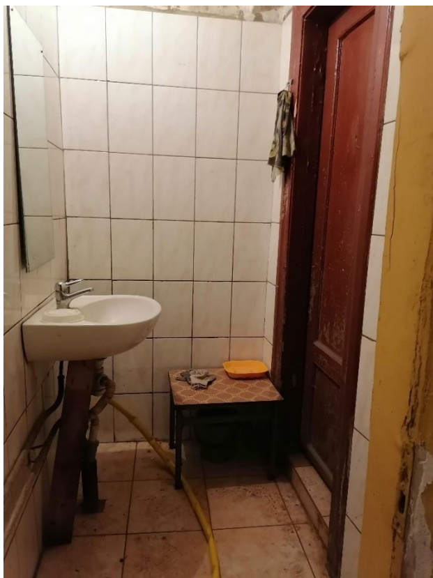
Илл.52. Подвал. Санузел. Помещение №31. 31.03.2022г.
