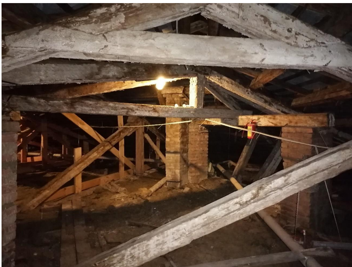
Илл.39. Фрагмент деревянных ферм чердачных конструкций. 31.03.2022г.
