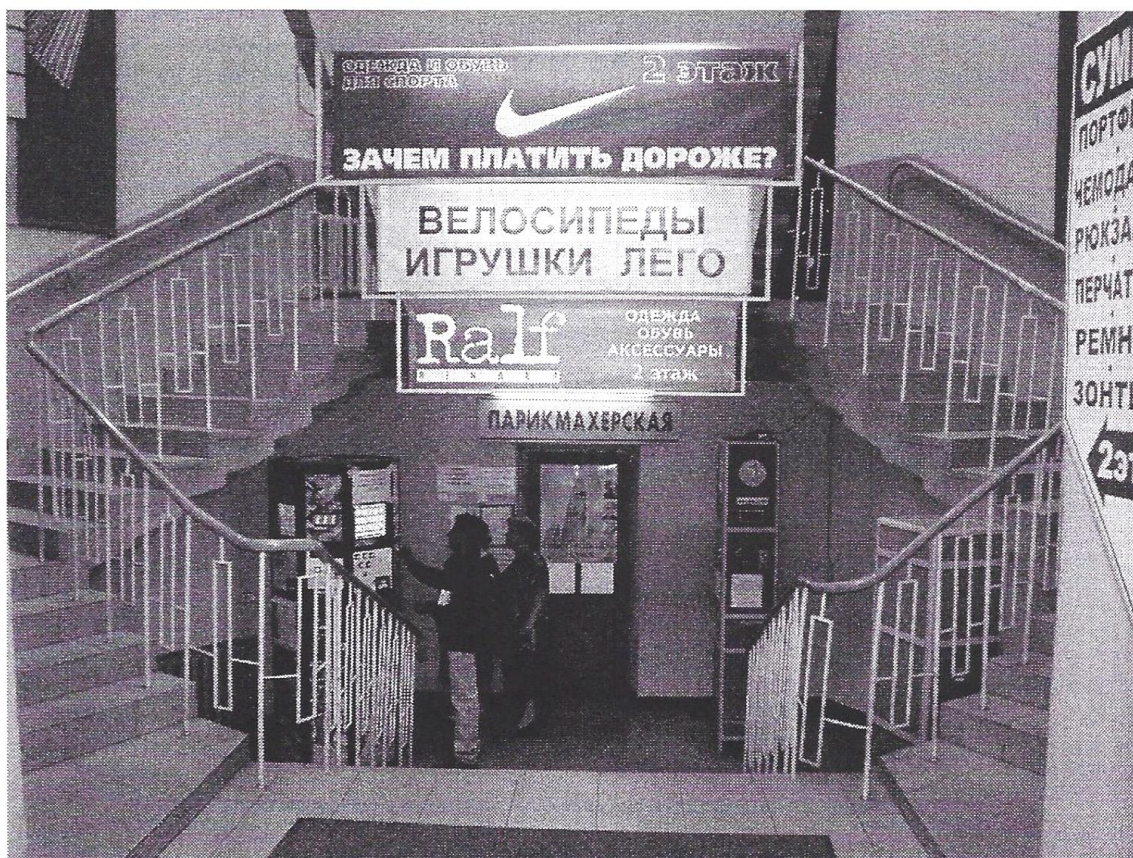
Илл.45. Вид центральной лестничной клетки. Калининский универмаг. Техническое заключение по обследованию конструкций здания» 2005г. ООО «Воплощение».
