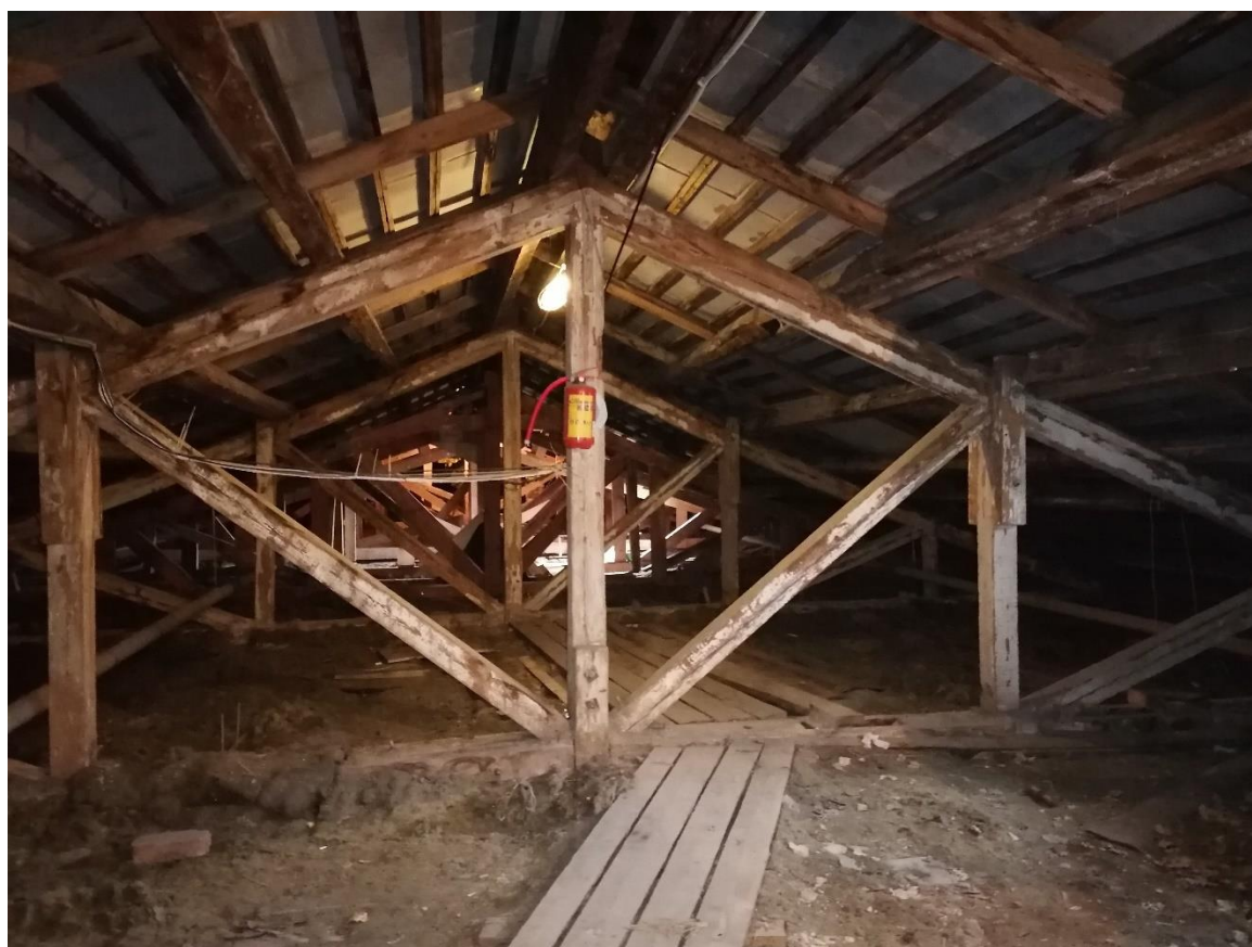
Илл.35. Фермы, балки-прогоны и обрешетка кровли. 31.03.2022г.
