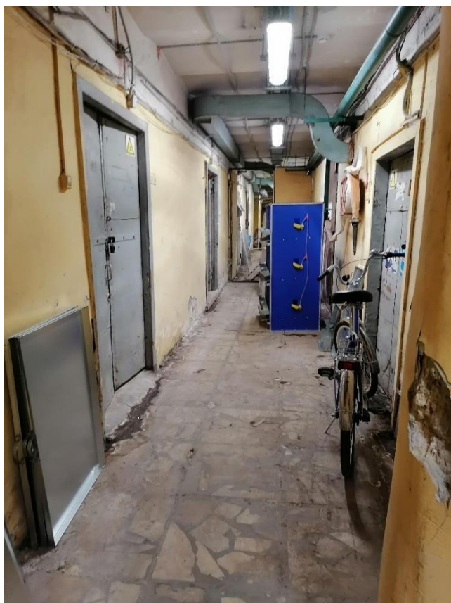
Илл.48. Подвал. Коридор (помещение №14) в части здания со стороны Кондратьевского проспекта. 31.03.2022г.
