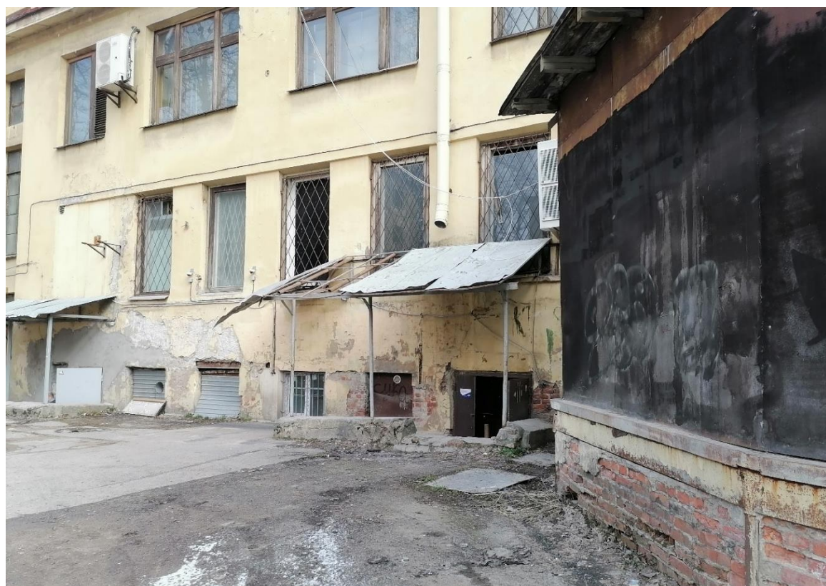
Илл.10. Фрагмент дворового фасада. Вход со стороны дворового фасада. 31.03.2022г.
