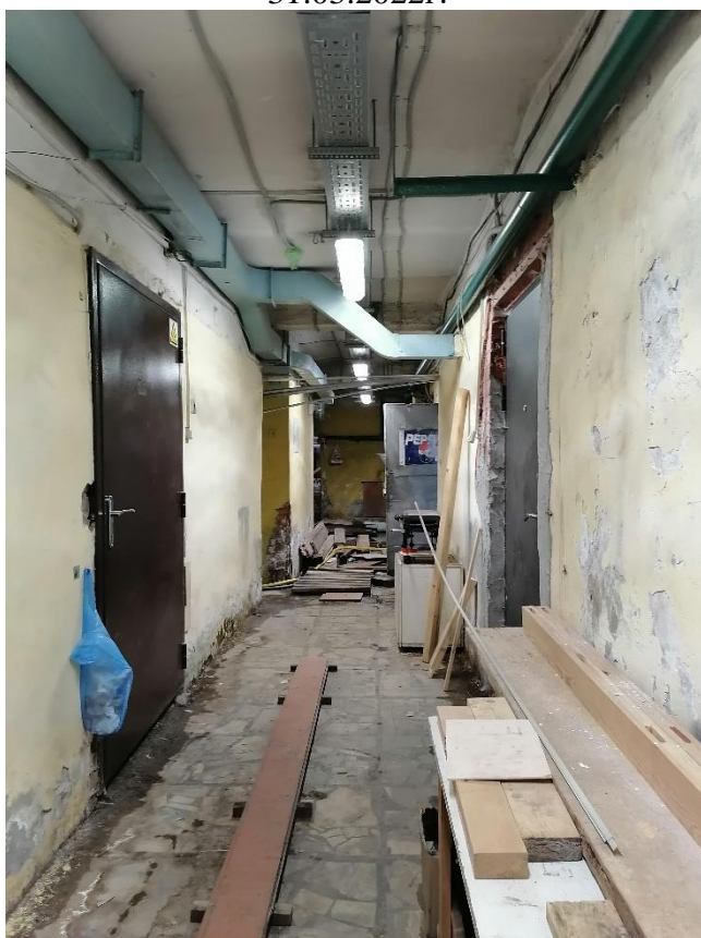
Илл.56. Подвал. Коридор (помещение №14) в части здания со стороны Кондратьевского проспекта. 31.03.2022г.
