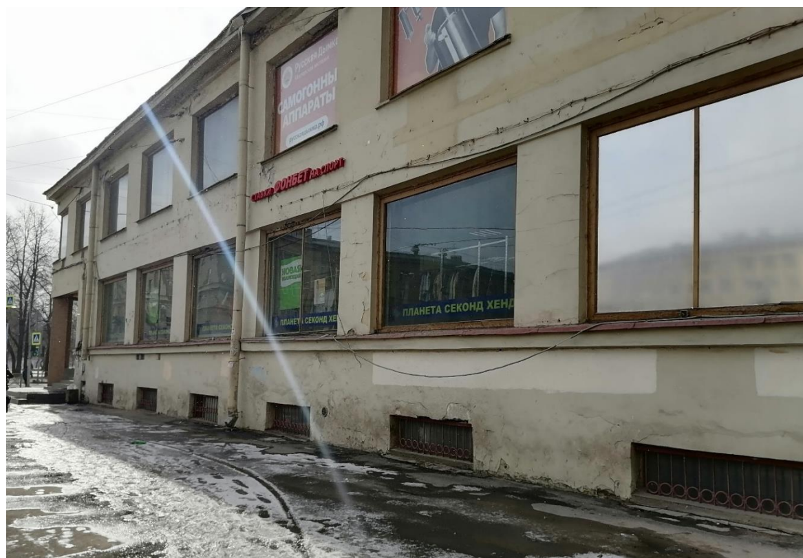
Илл.4.1. Фасад здания Калининского универмага по Полюстровскому проспекту. Фрагмент. 31.03.2021г.
