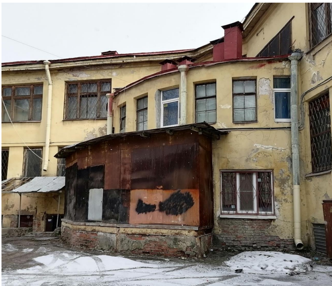
Илл.8. Дворовый фасад здания Калининского универмага. 31.03.2022г.
