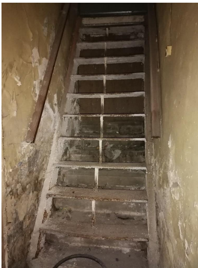
Илл.54. Лестница. Помещение №29. 31.03.2022г.
