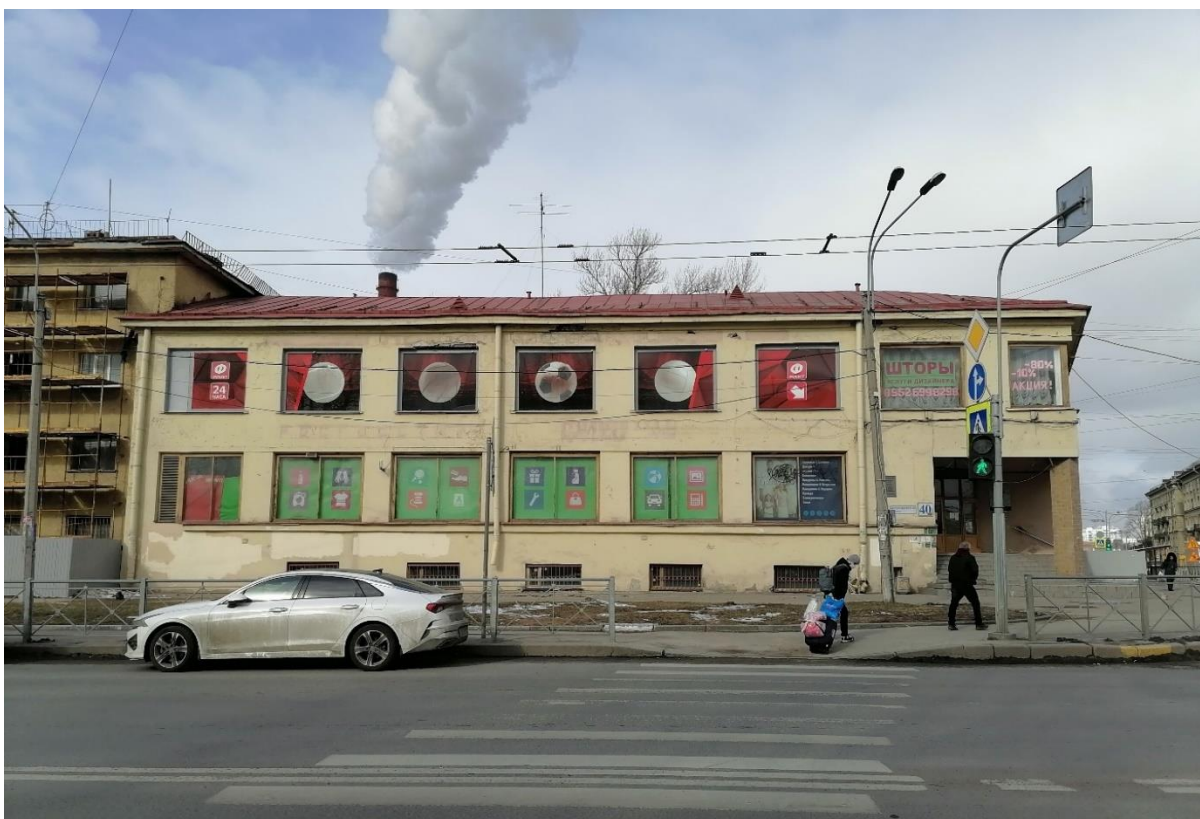
Илл.1 Фасад здания Калининского универмага на пересечении Кондратьевского и Полюстровского проспектов. Общий вид. 31.03.2022г.
