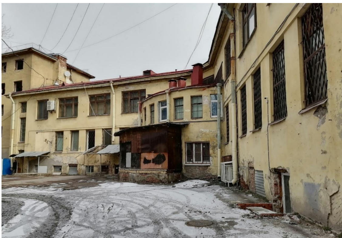
Илл.8.1. Дворовый фасад здания Калининского универмага. 31.03.2022г.
