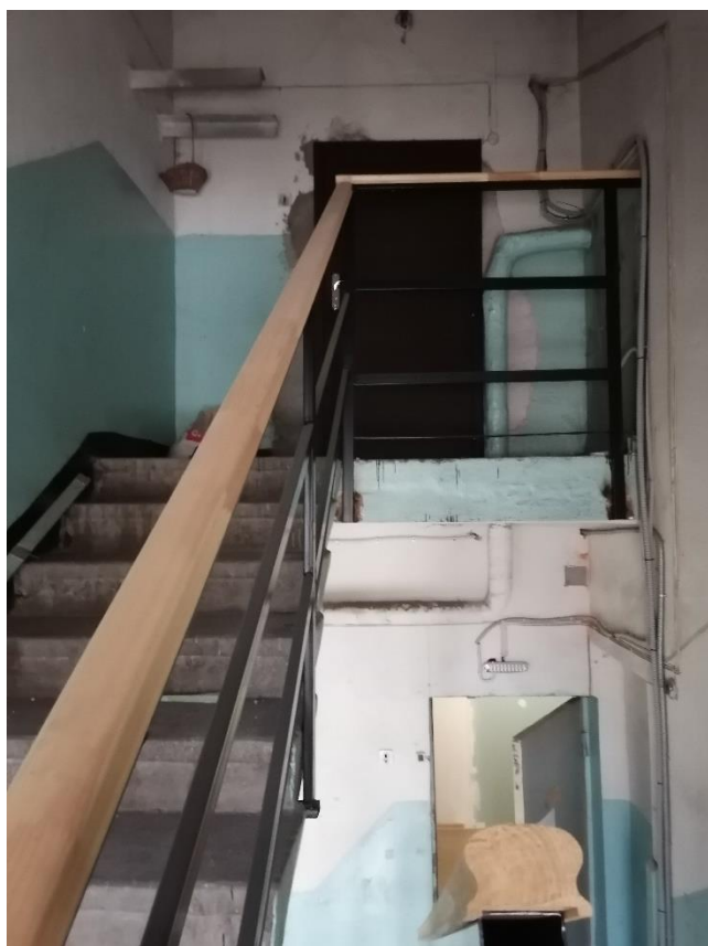
Илл.29. Лестничная клетка в части здания со стороны Полюстровского проспекта. Верхняя площадка. 31.03.2022г.
