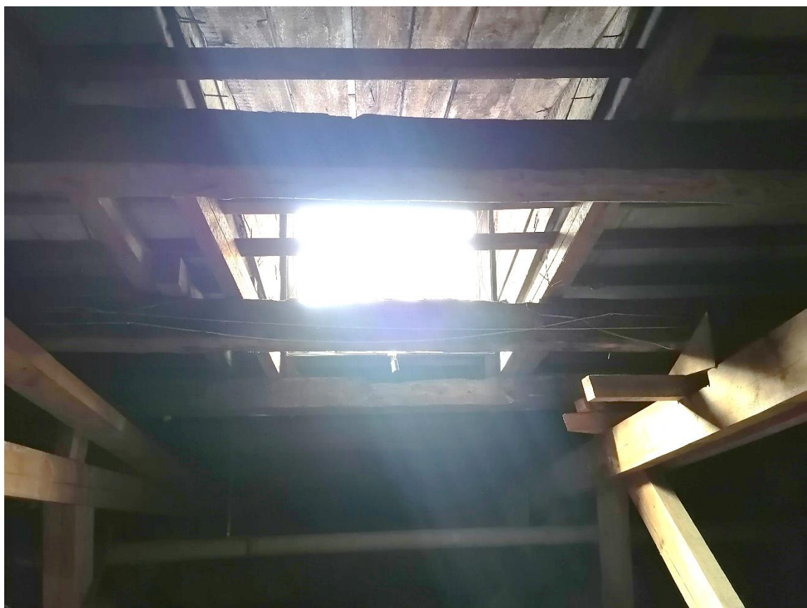
Илл.33. Продух в центральной части чердака выходит на дворовый фасад. 31.03.2022г.
