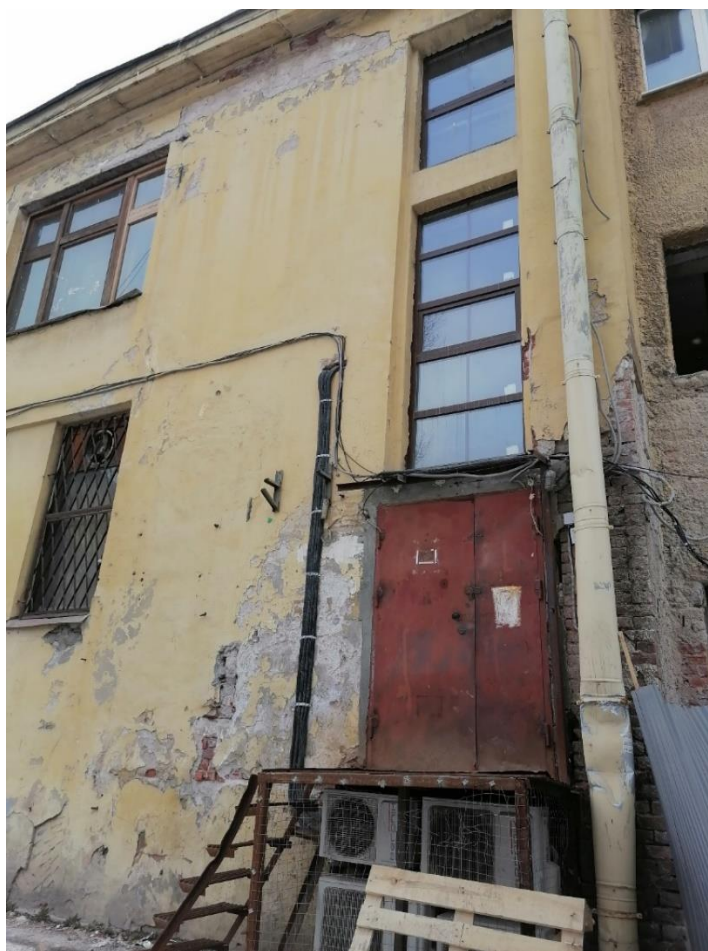
Илл.11. Фрагмент дворового фасада. Вход со стороны дворового фасада. 31.03.2022г.
