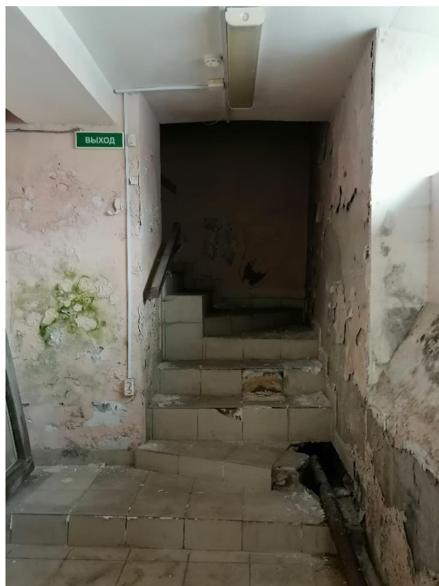
Илл.46. Подвал. Помещение №4 с лестницей в части здания со стороны Полюстровского проспекта. 31.03.2022г.
