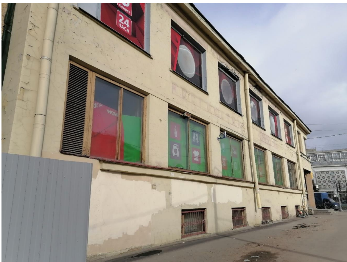
Илл.2.1. Фасад здания Калининского универмага по Кондратьевскому проспекту. Фрагмент. 31.03.2022.
