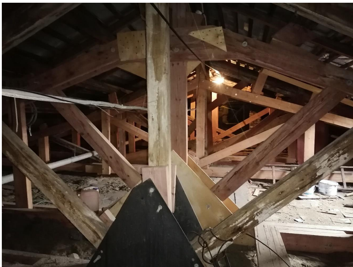
Илл.36. Фрагмент деревянных ферм чердачных конструкций. 31.03.2022г.
