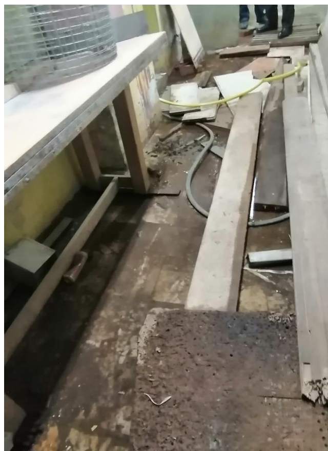
Илл.55. Подвал. Коридор (помещение №14) в части здания со стороны Кондратьевского проспекта. 31.03.2022г.
