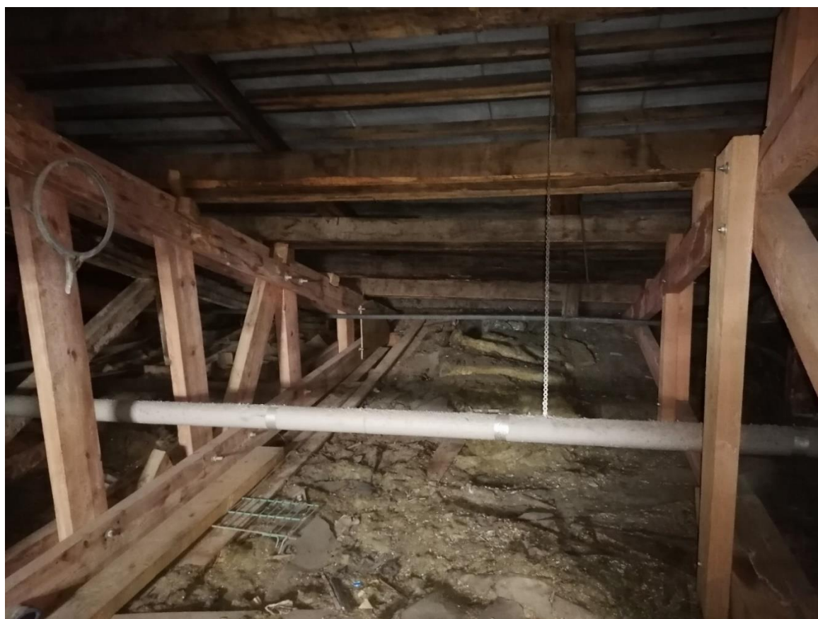
Илл.37. Фрагмент деревянных ферм чердачных конструкций. 31.03.2022г.
