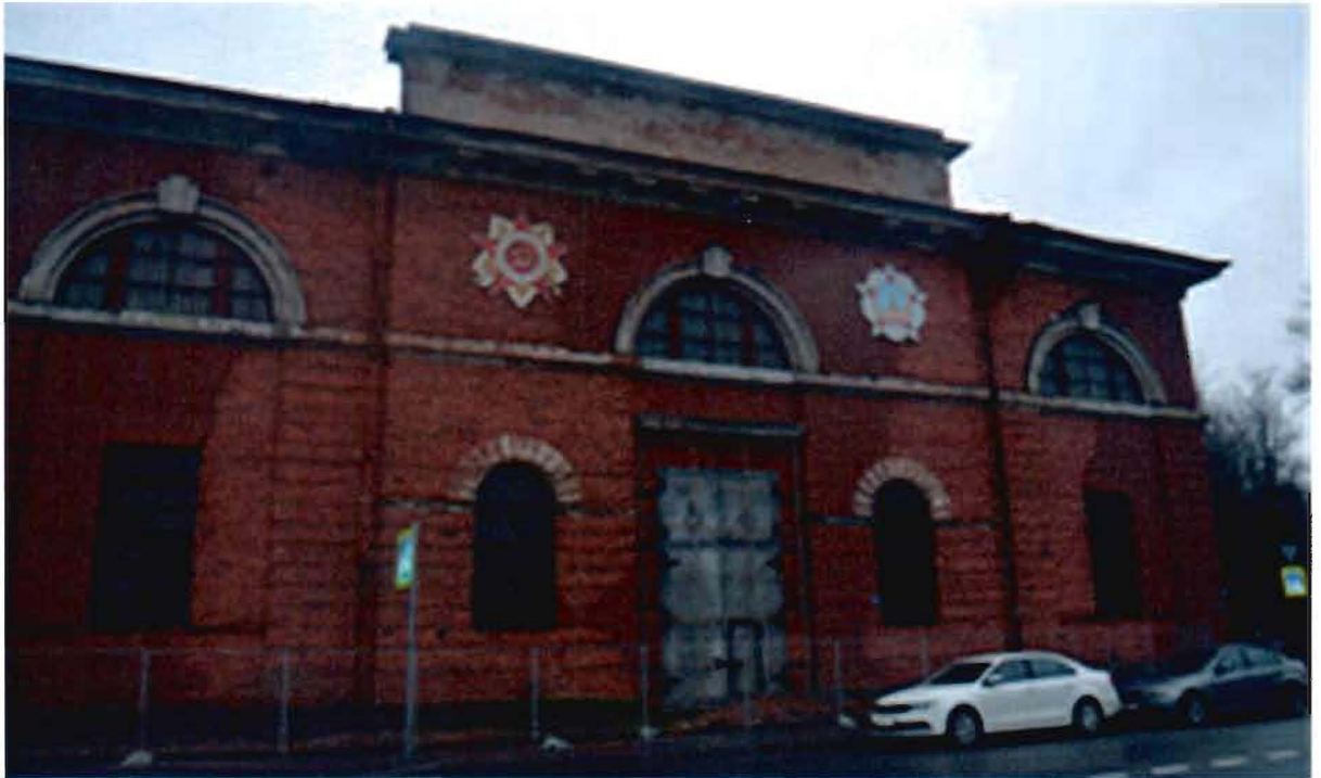
1. Торцевой северный фасад.
