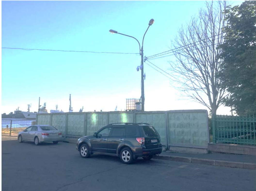
Илл. 18. Объект культурного наследия федерального значения «Набережные и молы со спусками...», г. Кронштадт. Вид от здания «Арсенала» на набережную. Направление съемки запад.
