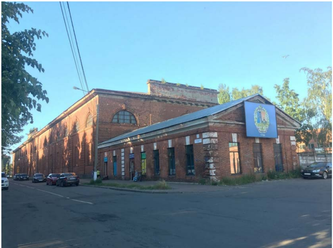
Илл. 12. Объект культурного наследия федерального значения «Арсенал», г. Кронштадт, ул. Макаровская, д. 2, лит А, Щ. Вид на фасад по пер. Арсенальному и со стороны набережной. Направление съемки северо-запад.
