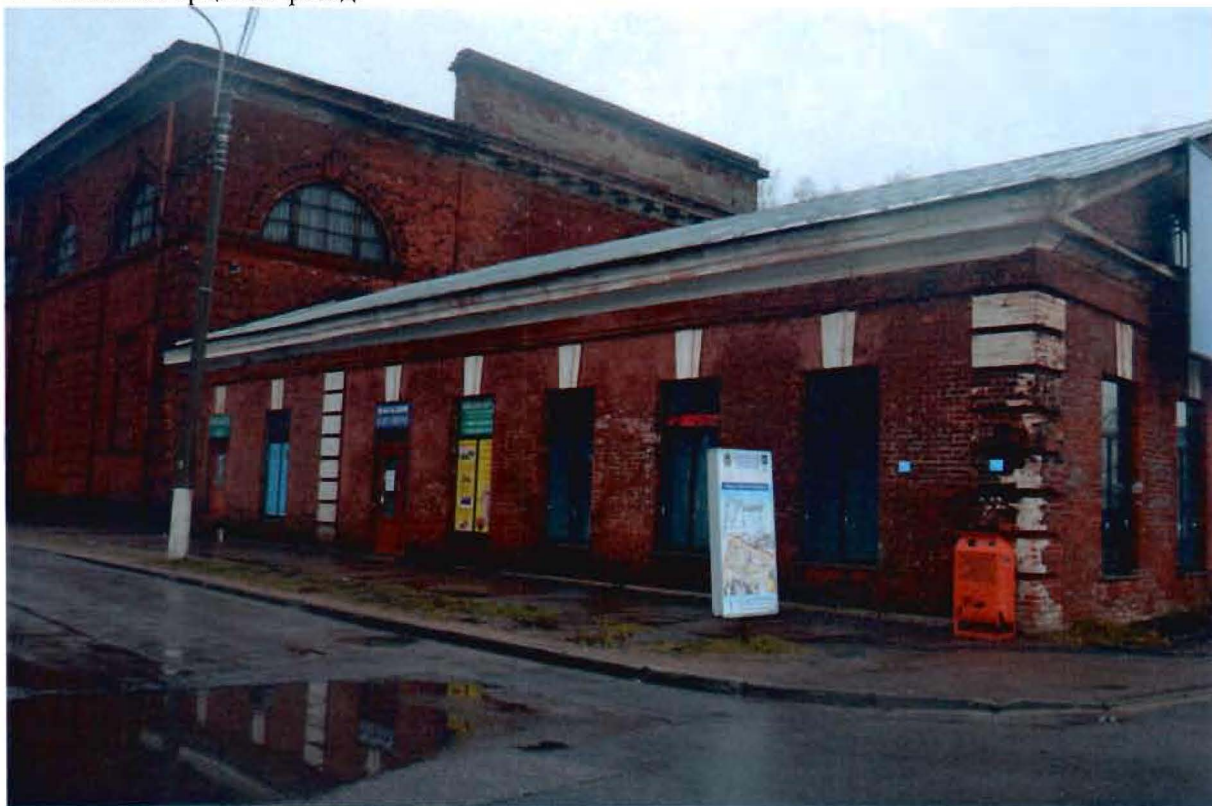
4. Южный торцевой фасад.
