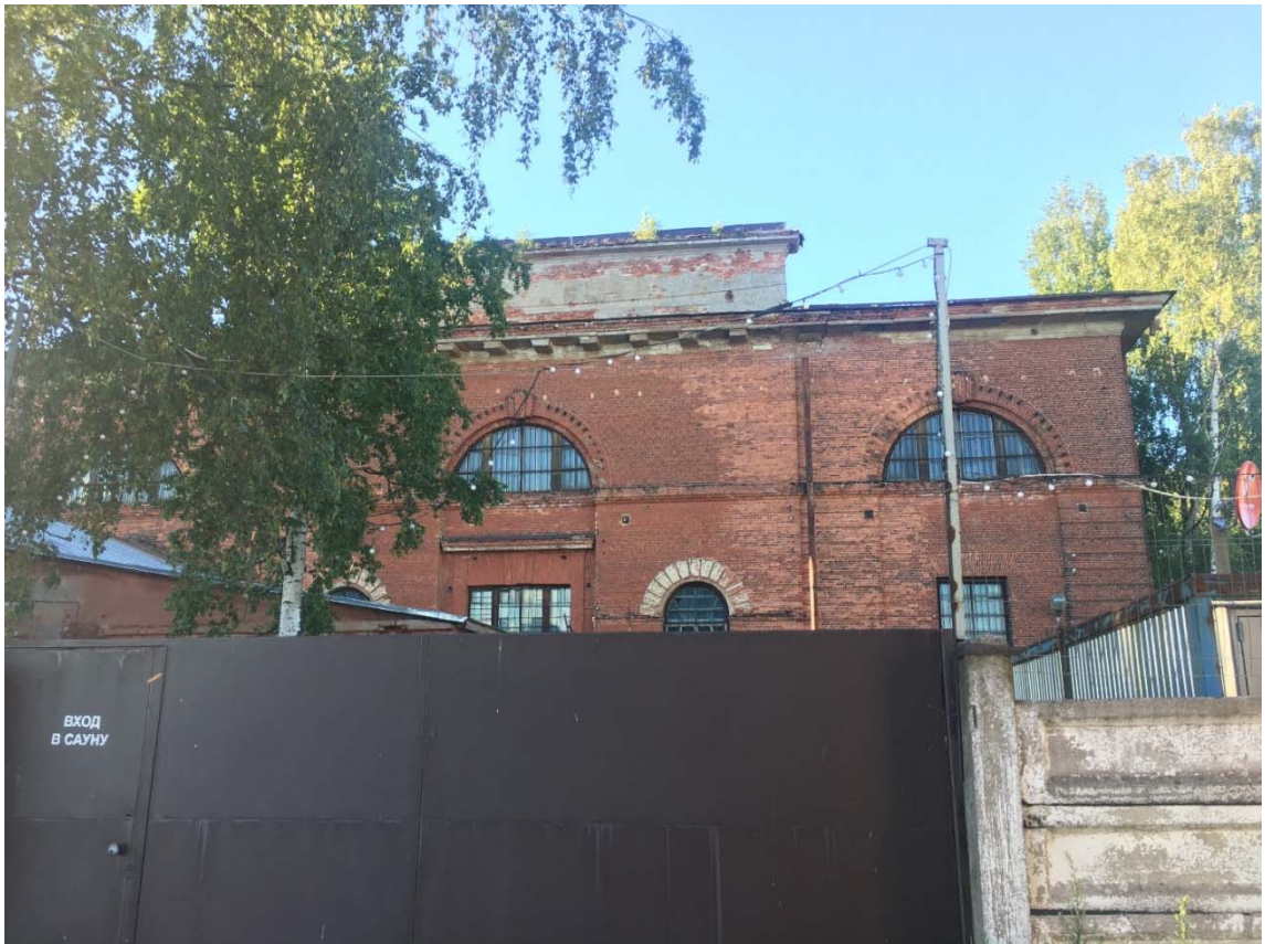
Илл. 15. Объект культурного наследия федерального значения «Арсенал», г. Кронштадт, ул. Макаровская, д. 2, лит А, Щ. Вид на фасад и дворовую территорию со стороны набережной. Направление съемки северо-восток.
