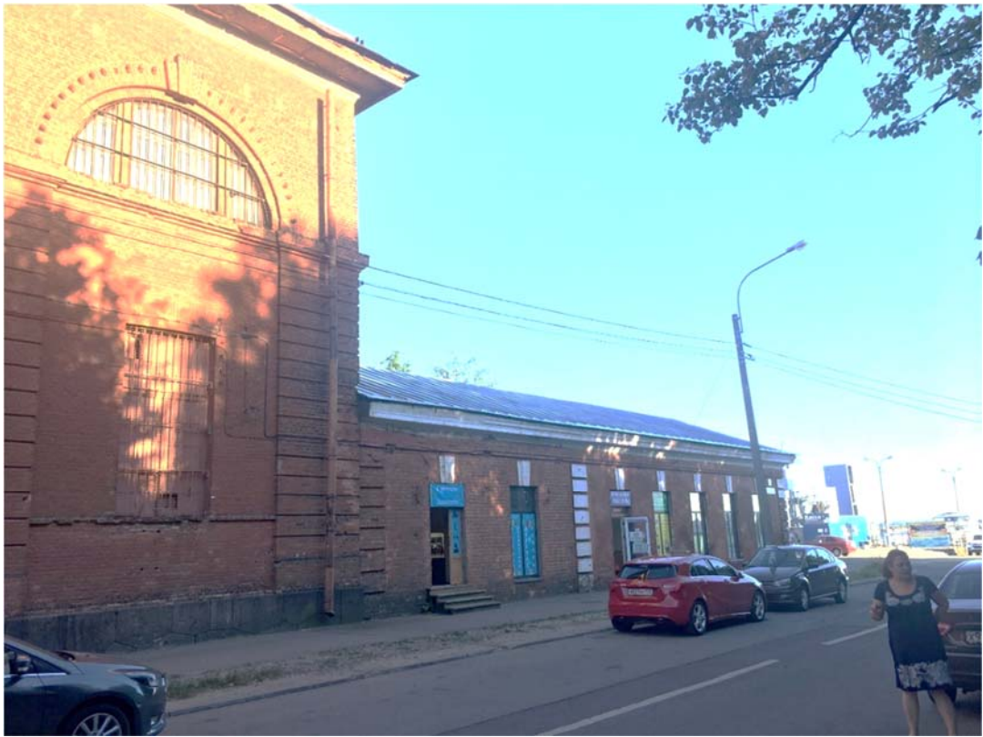
Илл. 11. Объект культурного наследия федерального значения «Арсенал», г. Кронштадт, ул. Макаровская, д. 2, лит А, Щ. Вид на фасад по пер. Арсенальному. Направление съемки юго-запад.
