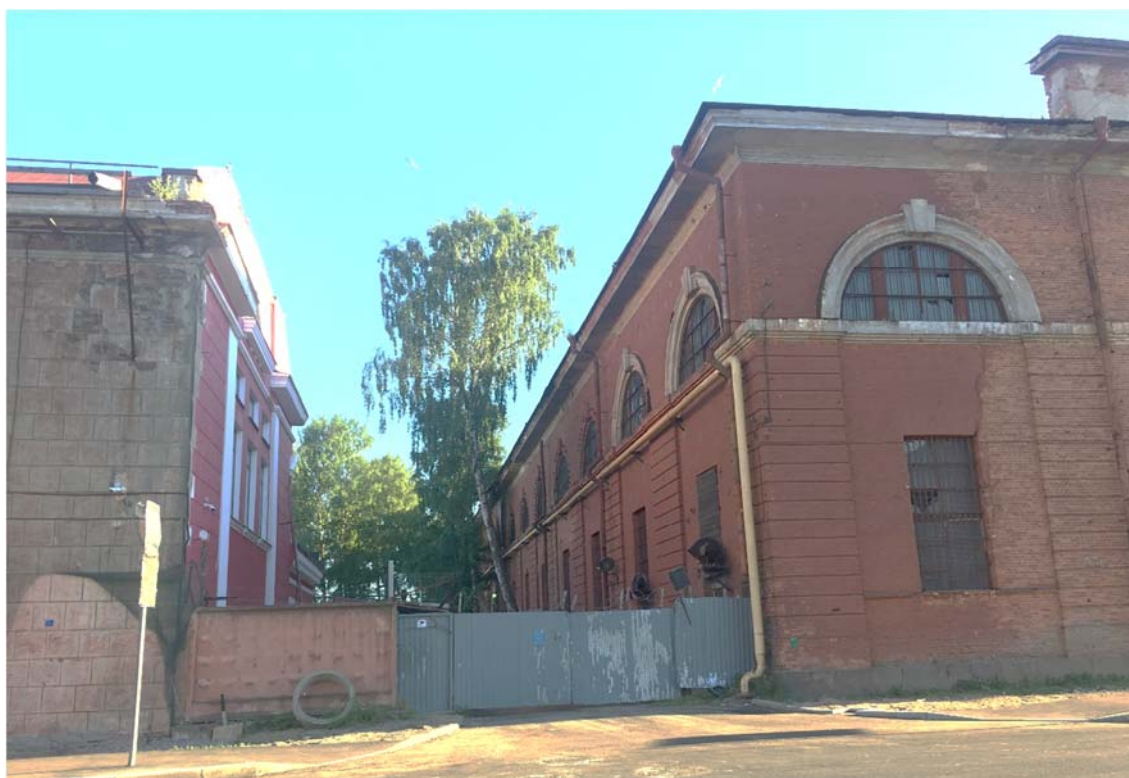
Илл. 4. Объект культурного наследия федерального значения «Арсенал», г. Кронштадт, ул. Макаровская, д. 2, лит А, Щ. Вид на фасад, выходящий на дворовую территорию с ул. Макаровской. Направление съемки юго-запад.
