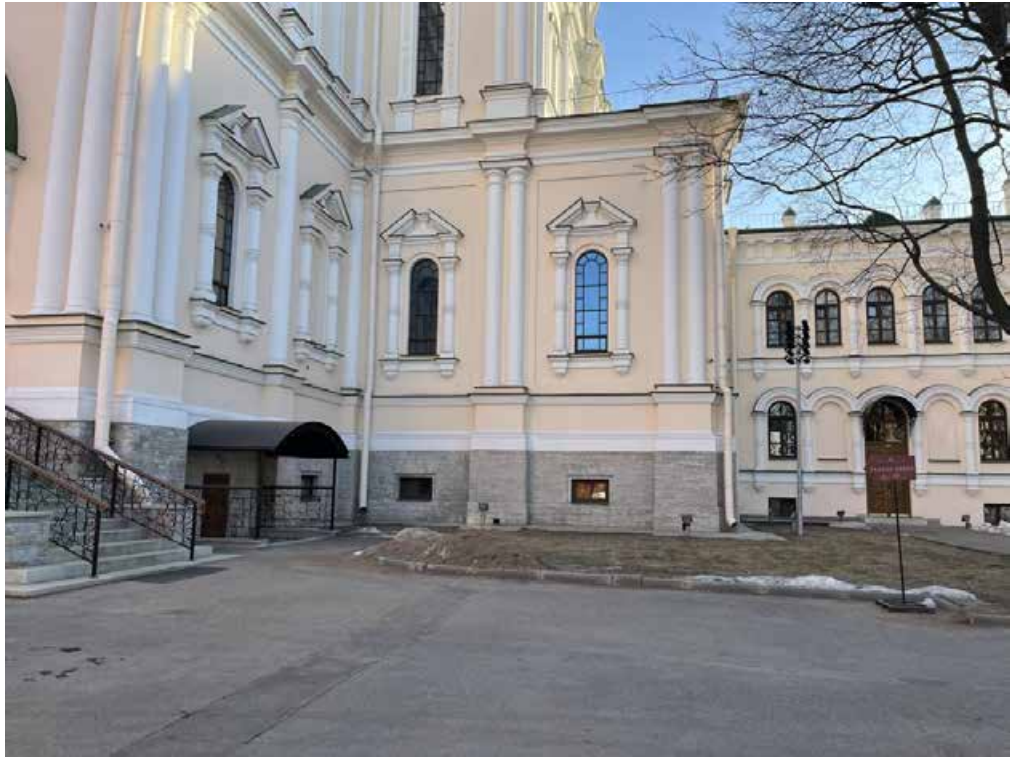
4. Объект культурного наследия федерального значения «Собор Воскресенский», входящий в состав объекта культурного наследия федерального значения «Монастырь Воскресенский Новодевичий», по адресу: г. Санкт-Петербург, Московский проспект, д. 100, лит. А. Вид на эвакуационный выход из Нижнего храма (с южной стороны).
