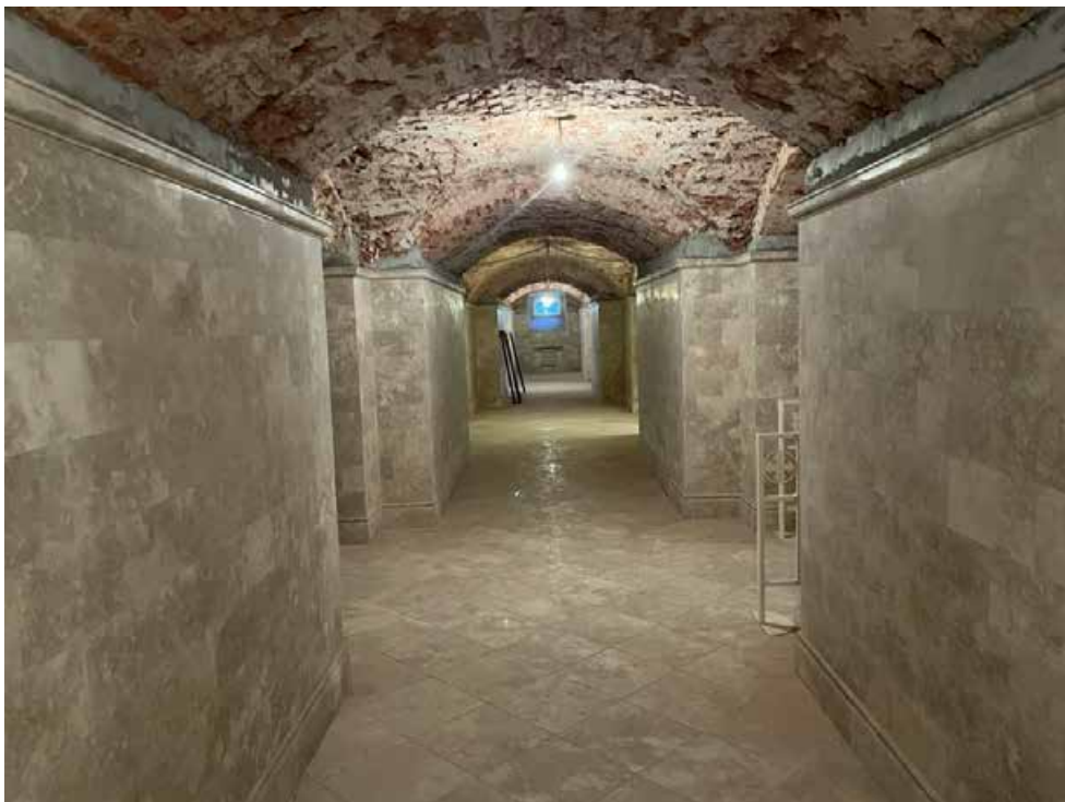
12. Объект культурного наследия федерального значения «Собор Воскресенский», входящий в состав объекта культурного наследия федерального значения «Монастырь Воскресенский Новодевичий», по адресу: г. Санкт-Петербург, Московский проспект, д. 100, лит. А. Подвальный (цокольный) этаж. Нижний храм. Фрагмент интерьера.
