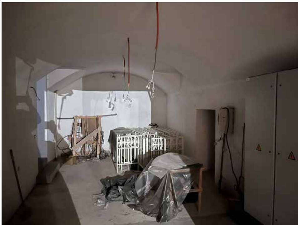
21. Объект культурного наследия федерального значения «Собор Воскресенский», входящий в состав объекта культурного наследия федерального значения «Монастырь Воскресенский Новодевичий», по адресу: г. Санкт-Петербург, Московский проспект, д. 100, лит. А. Подвальный (цокольный) этаж. Нижний храм. Фрагмент интерьера. Объем под притвором Воскресенского собора.
