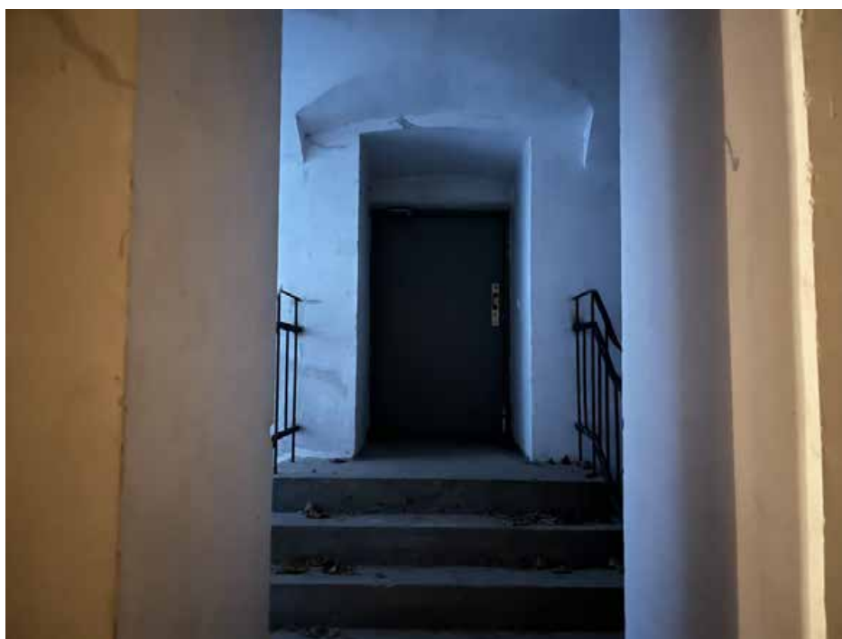
22. Объект культурного наследия федерального значения «Собор Воскресенский», входящий в состав объекта культурного наследия федерального значения «Монастырь Воскресенский Новодевичий», по адресу: г. Санкт-Петербург, Московский проспект, д. 100, лит. А. Подвальный (цокольный) этаж. Нижний храм. Фрагмент интерьера. Объем под притвором Воскресенского собора. Эвакуационный выход.
