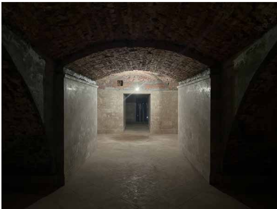
17. Объект культурного наследия федерального значения «Собор Воскресенский», входящий в состав объекта культурного наследия федерального значения «Монастырь Воскресенский Новодевичий», по адресу: г. Санкт-Петербург, Московский проспект, д. 100, лит. А. Подвальный (цокольный) этаж. Нижний храм. Фрагмент интерьера.
