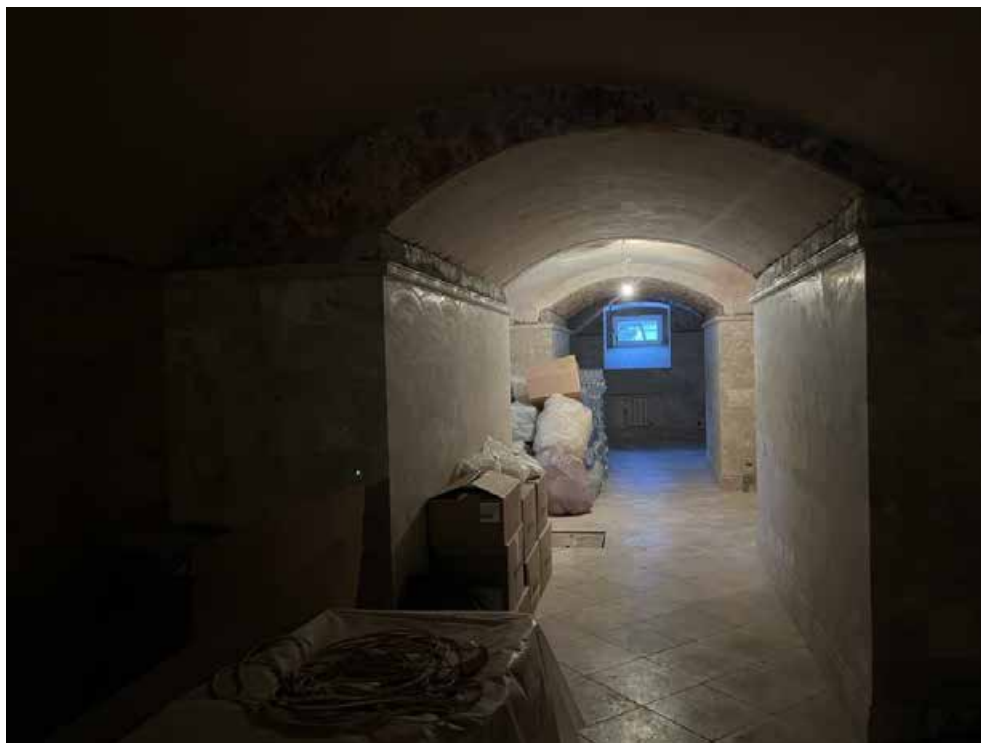
13. Объект культурного наследия федерального значения «Собор Воскресенский», входящий в состав объекта культурного наследия федерального значения «Монастырь Воскресенский Новодевичий», по адресу: г. Санкт-Петербург, Московский проспект, д. 100, лит. А. Подвальный (цокольный) этаж. Нижний храм. Фрагмент интерьера.
