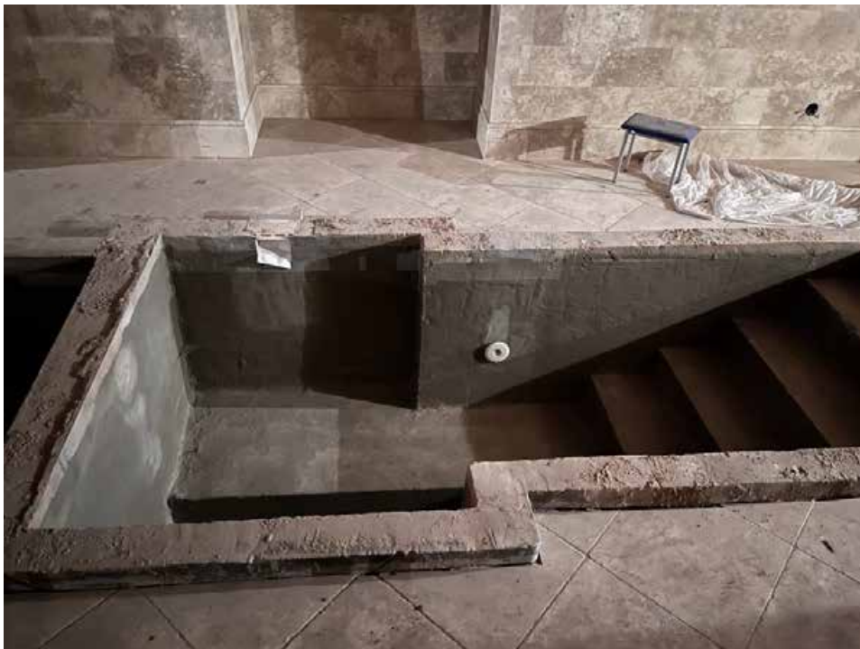
20. Объект культурного наследия федерального значения «Собор Воскресенский», входящий в состав объекта культурного наследия федерального значения «Монастырь Воскресенский Новодевичий», по адресу: г. Санкт-Петербург, Московский проспект, д. 100, лит. А. Подвальный (цокольный) этаж. Нижний храм. Фрагмент интерьера. Купель.
