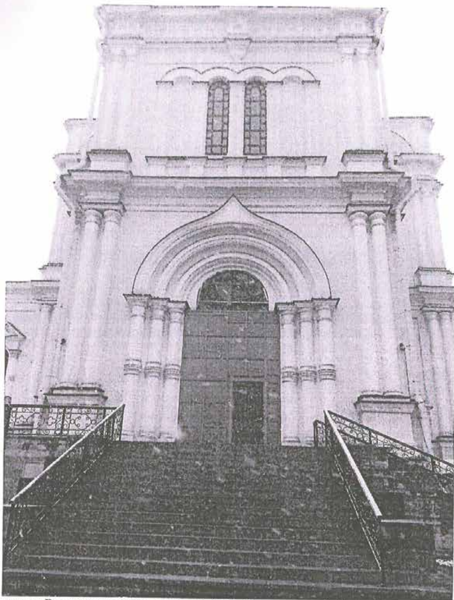
3. Монастырь Воскресенский Новодевичий. Собор Воскресенский. Главный вход Восточного фасада
