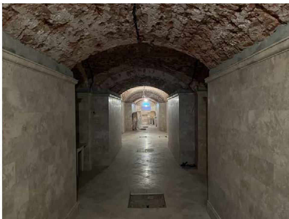
14. Объект культурного наследия федерального значения «Собор Воскресенский», входящий в состав объекта культурного наследия федерального значения «Монастырь Воскресенский Новодевичий», по адресу: г. Санкт-Петербург, Московский проспект, д. 100, лит. А. Подвальный (цокольный) этаж. Нижний храм. Фрагмент интерьера.
