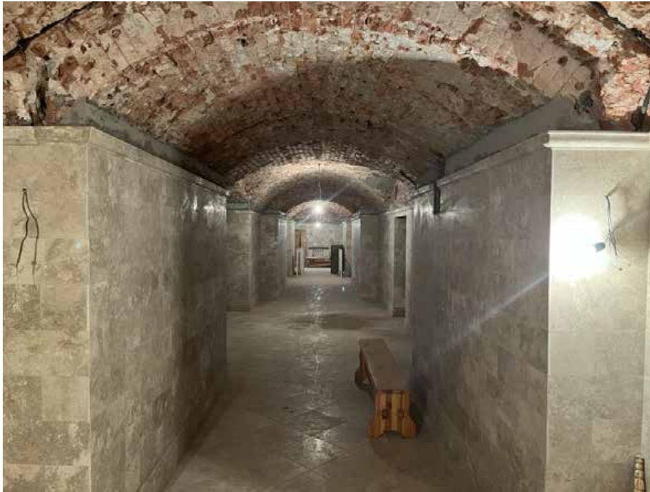
15. Объект культурного наследия федерального значения «Собор Воскресенский», входящий в состав объекта культурного наследия федерального значения «Монастырь Воскресенский Новодевичий», по адресу: г. Санкт-Петербург, Московский проспект, д. 100, лит. А. Подвальный (цокольный) этаж. Нижний храм. Фрагмент интерьера.
