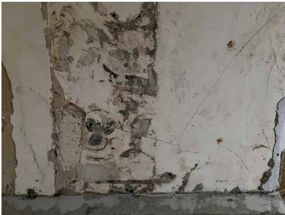
10. Объект культурного наследия федерального значения «Собор Воскресенский», входящий в состав объекта культурного наследия федерального значения «Монастырь Воскресенский Новодевичий», по адресу: г. Санкт-Петербург, Московский проспект, д. 100, лит. А. Подвальный (цокольный) этаж. Нижний храм. Фрагмент выявленной исторической орнаментальной живописи на сводах.
