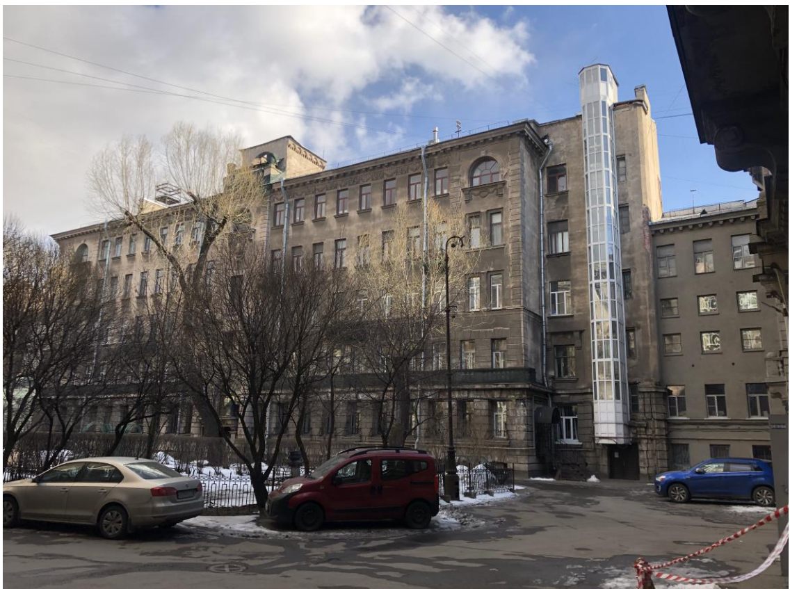
Фото 9. Вид на южный фасад дворового корпуса ансамбля.
