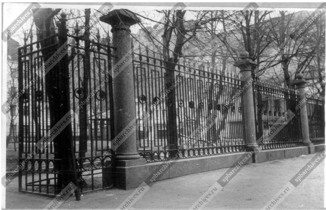
Илл. 40. Вид части ограды во дворе дома №46 на Литейном проспекте. 1975 г. Источник: ЦГАКФФД СПб, шифр Ар 135545
