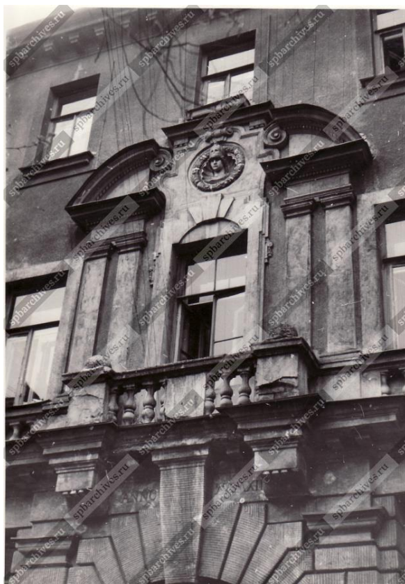
Илл. 43. Вид фрагмента фасада дома № 46-б на Литейном проспекте со стороны двора. 25 мая 1980. Источник: ЦГАКФФД СПб, шифр Ар 214973
