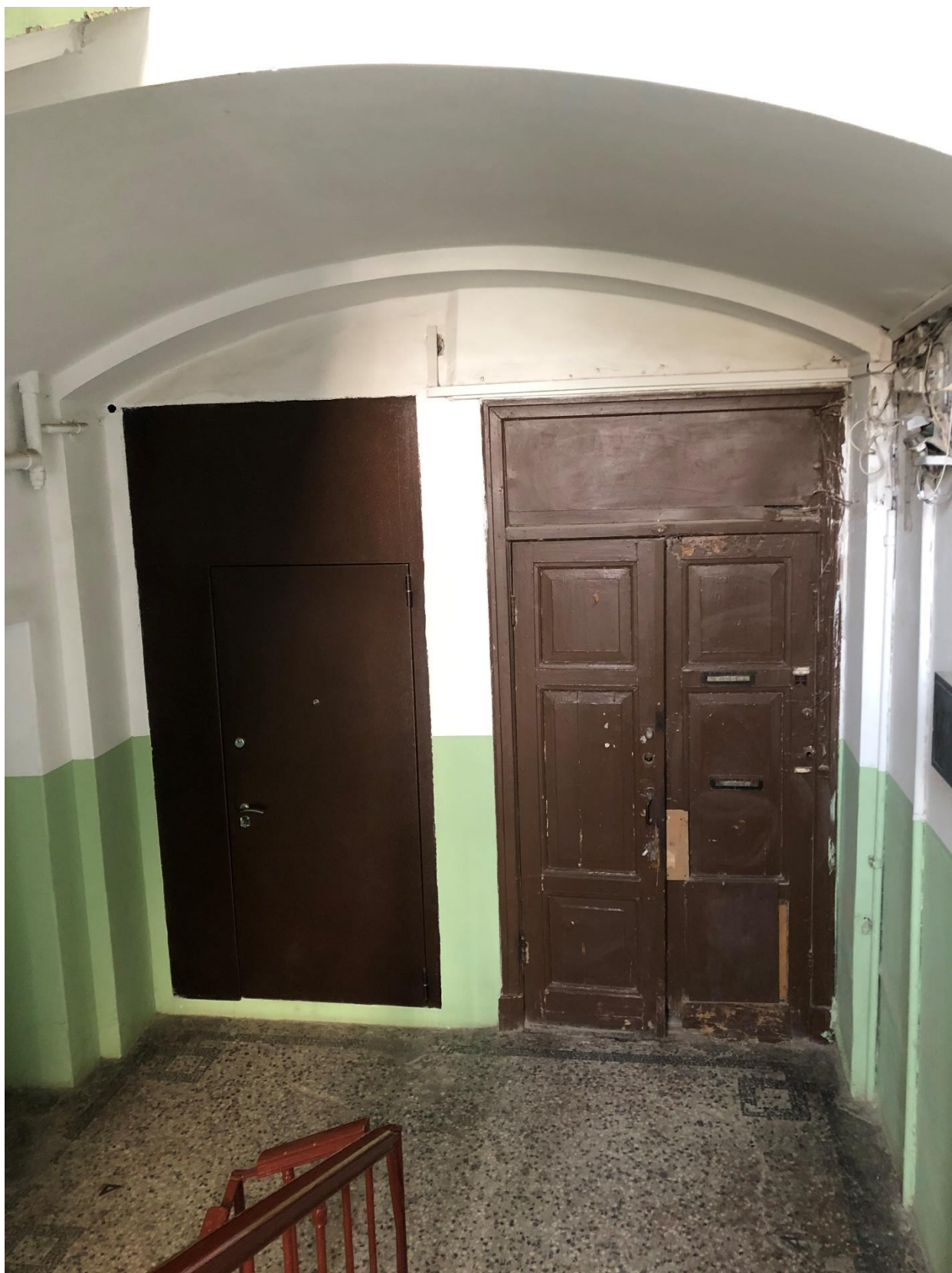
Фото 1. Вид на квартиру № 1 с парадной лестницы.
