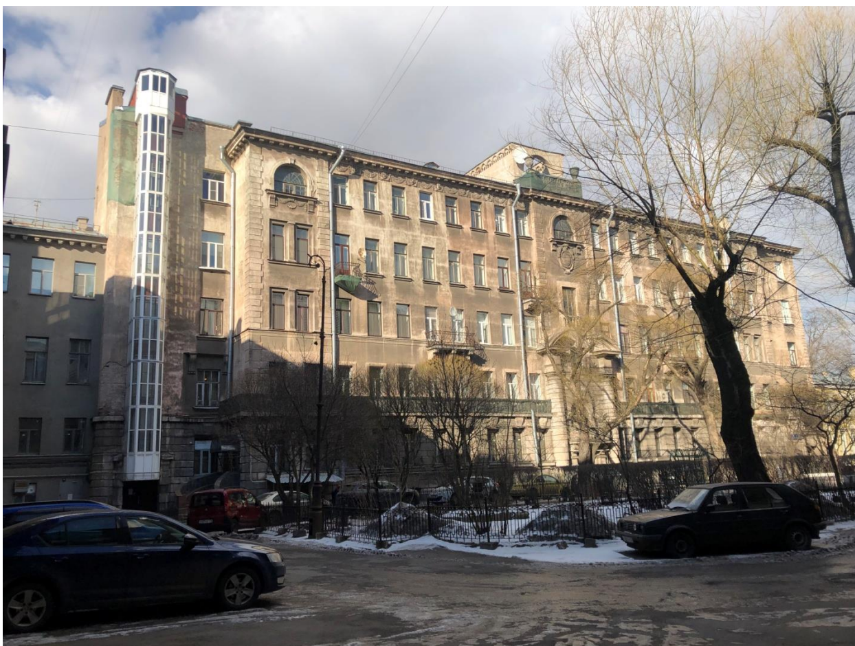
Фото 7. Вид на северный фасад дворового корпус ансамбля.
