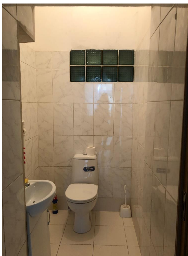
Фото 8. Вид на санузел.
