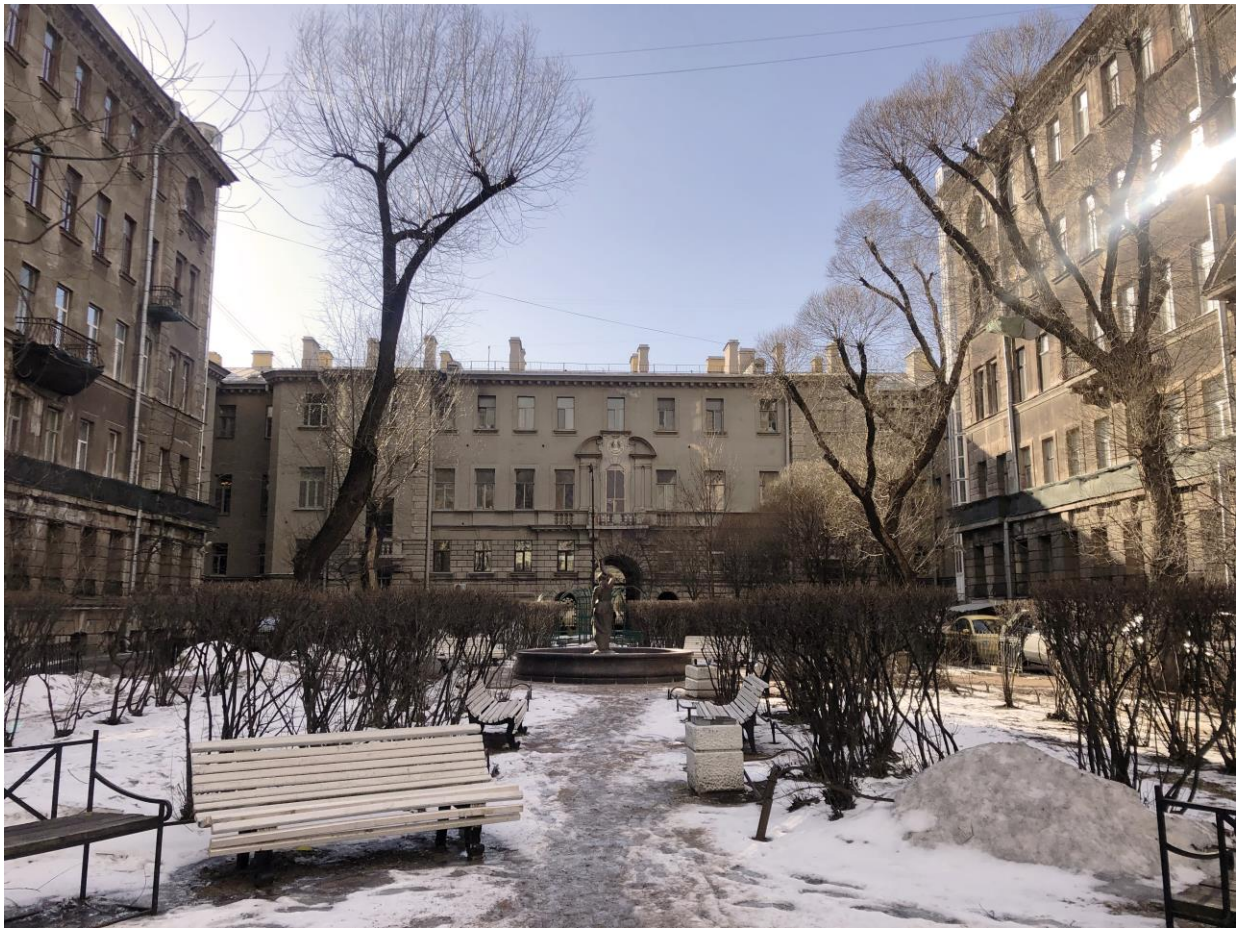
Фото 4. Вид на центральный дворовый фасад объекта культурного наследия.
