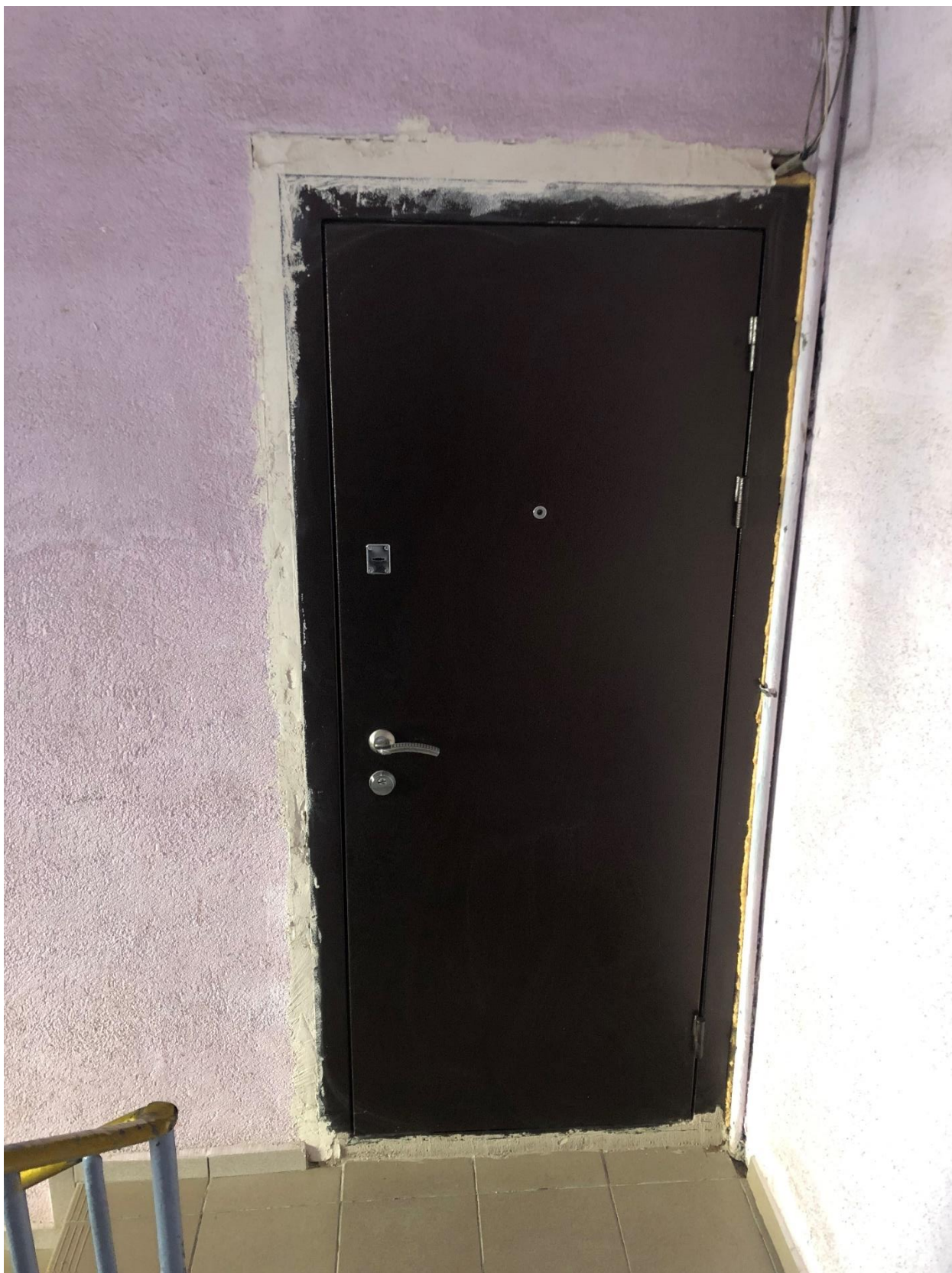
Фото 2. Вид на квартиру № 1 с черной лестницы.
