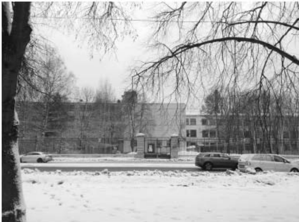
Фото 3. Территория проведения работ по реконструкции электрических сетей и устройств наружного освещения объекта: Политехническая ул. от пл. Мужества до Тихорецкого пр. Вид с ул. Политехнической на ОКН регионального значения «Здание фабрично-заводской школы». Направление съемки запад.
