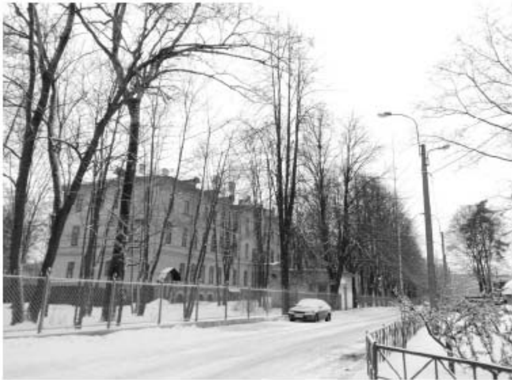
Фото 13. Территория проведения работ по реконструкции электрических сетей и устройств наружного освещения объекта: Политехническая ул. от пл. Мужества до Тихорецкого пр. Вид на ОКН регионального значения «Еленинская женская раковая больница им. А.Г. и Е.И. Елисеевых». Направление съемки северо-запад.
