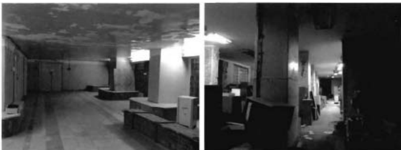
11, 12. Часть подвальных помещений.
