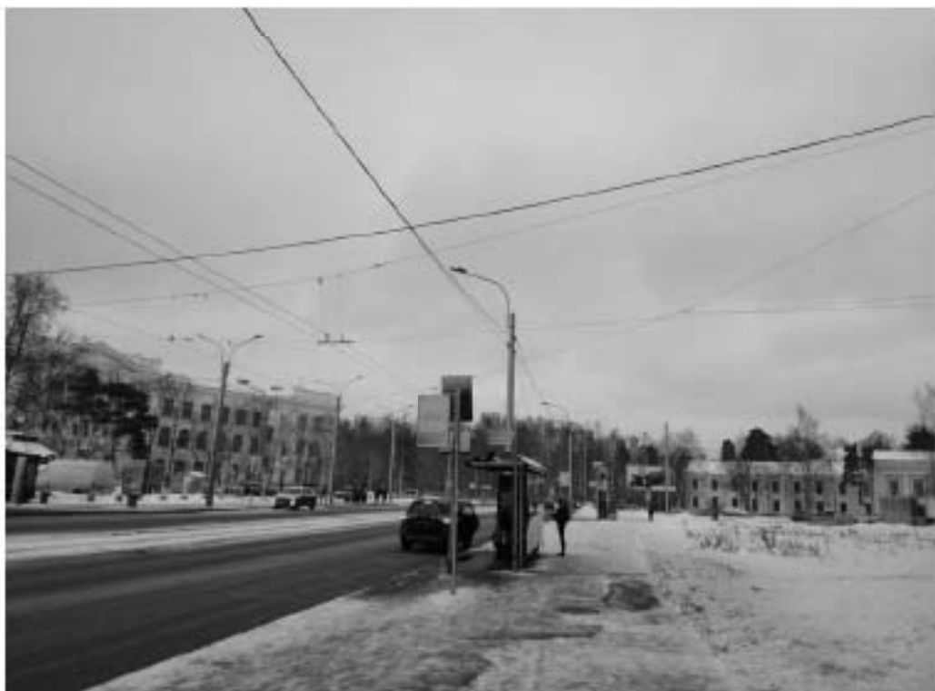
Фото 14. Территория проведения работ по реконструкции электрических сетей и устройств наружного освещения объекта: Политехническая ул. от пл. Мужества до Тихорецкого пр. Вид с ул. Политехнической на выявленный ОКН «Главный корпус Физико-технологического института РАН им. А.Ф. Иоффе (с курдонером, садом, оградой)» и ОКН федерального значения «Главное здание» и «Парк», входящие в состав ОКН федерального значения «Институт Санкт-Петербургский Политехнический императора Петра Великого». Направление съемки юг.
