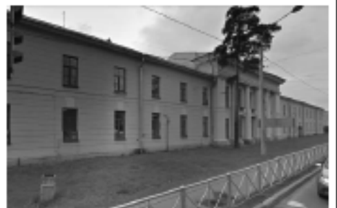
северный фасад северного крыла
