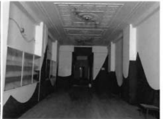
19. Оформление потолка в пом. №175.
