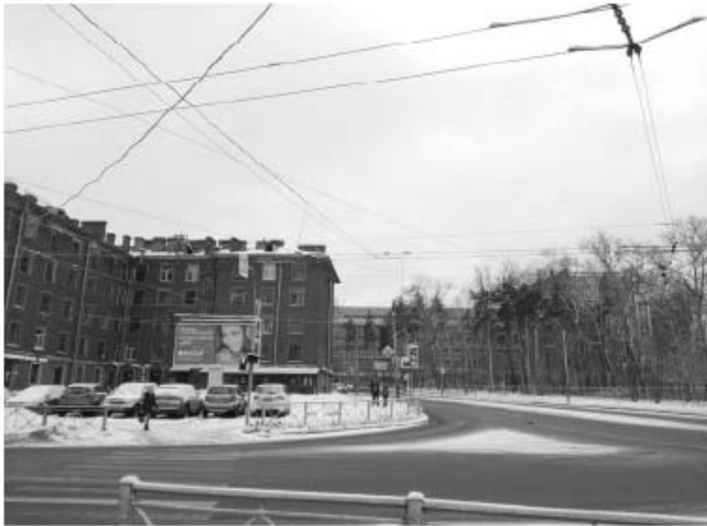
Фото 9. Территория проведения работ по реконструкции электрических сетей и устройств наружного освещения объекта: Политехническая ул. от пл. Мужества до Тихорецкого пр. Вид на ул. Политехническую и на ОКН федерального значения «Корпус жилой для служащих» входящий в состав ОКН федерального значения «Институт Санкт-Петербургский Политехнический императора Петра Великого». Направление съемки юго-запад.
