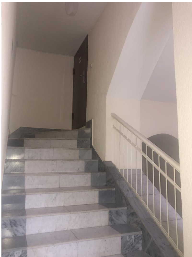
20. Объект культурного наследия федерального значения «Дом пастора», расположенный по адресу: г. Санкт-Петербург, г. Кронштадт, Ленинградская ул., д. 1, литера А, входящий в состав объекта культурного наследия федерального значения «Храм лютеранский святой Елизаветы», расположенный по адресу: г. Санкт-Петербург, г. Кронштадт, Ленинградская ул., д. 1, литеры А, Н. Центральна часть здания. Внутренняя лестница.
