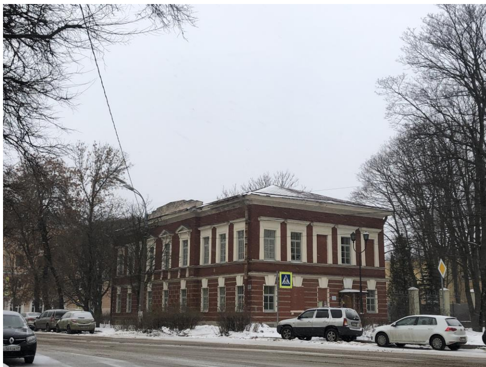
2. Объект культурного наследия федерального значения «Дом пастора», расположенный по адресу: г. Санкт-Петербург, г. Кронштадт, Ленинградская ул., д. 1, литера А, входящий в состав объекта культурного наследия федерального значения «Храм лютеранский святой Елизаветы», расположенный по адресу: г. Санкт-Петербург, г. Кронштадт, Ленинградская ул., д. 1, литеры А, Н. Общий вид со стороны Ленинградской улицы.
