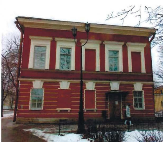
2. Северо-восточный торцевой фасад.
