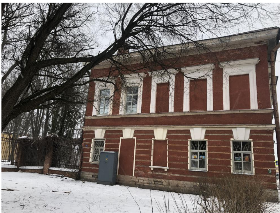
12. Объект культурного наследия федерального значения «Дом пастора», расположенный по адресу: г. Санкт-Петербург, г. Кронштадт, Ленинградская ул., д. 1, литера А, входящий в состав объекта культурного наследия федерального значения «Храм лютеранский святой Елизаветы», расположенный по адресу: г. Санкт-Петербург, г. Кронштадт, Ленинградская ул., д. 1, литеры А, Н. Северо-западный торцевой фасад. Общий вид.
