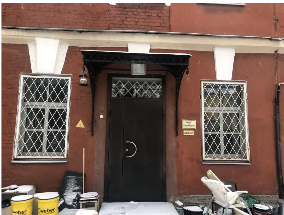
9. Объект культурного наследия федерального значения «Дом пастора», расположенный по адресу: г. Санкт-Петербург, г. Кронштадт, Ленинградская ул., д. 1, литера А, входящий в состав объекта культурного наследия федерального значения «Храм лютеранский святой Елизаветы», расположенный по адресу: г. Санкт-Петербург, г. Кронштадт, Ленинградская ул., д. 1, литеры А, Н. Фрагмент северо-восточного фасада. Оформление дверного проема.
