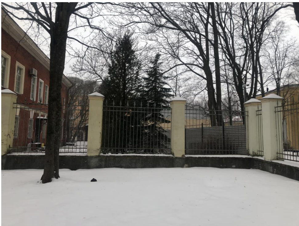
6. Объект культурного наследия федерального значения «Дом пастора», расположенный по адресу: г. Санкт-Петербург, г. Кронштадт, Ленинградская ул., д. 1, литера А, входящий в состав объекта культурного наследия федерального значения «Храм лютеранский святой Елизаветы», расположенный по адресу: г. Санкт-Петербург, г. Кронштадт, Ленинградская ул., д. 1, литеры А, Н. Вид на северо-восточный фасад в северо-западном направлении.
