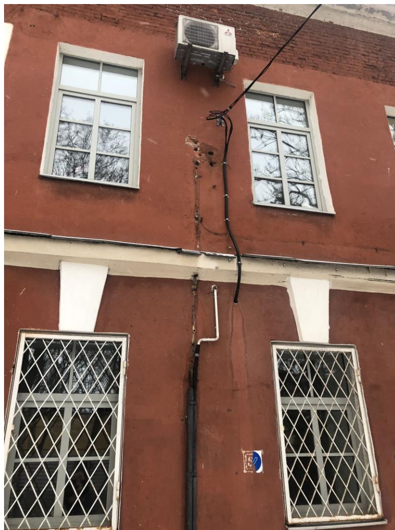
11. Объект культурного наследия федерального значения «Дом пастора», расположенный по адресу: г. Санкт-Петербург, г. Кронштадт, Ленинградская ул., д. 1, литера А, входящий в состав объекта культурного наследия федерального значения «Храм лютеранский святой Елизаветы», расположенный по адресу: г. Санкт-Петербург, г. Кронштадт, Ленинградская ул., д. 1, литеры А, Н. Фрагмент северо-восточного фасада. Оформление оконных проемов.
