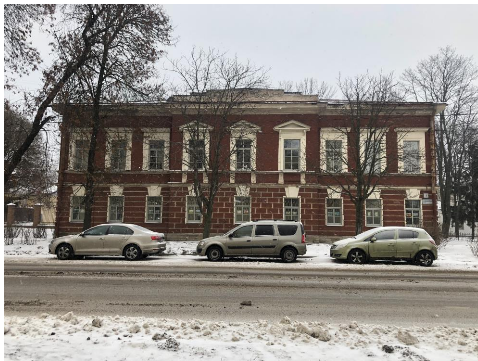
1. Объект культурного наследия федерального значения «Дом пастора», расположенный по адресу: г. Санкт-Петербург, г. Кронштадт, Ленинградская ул., д. 1, литера А, входящий в состав объекта культурного наследия федерального значения «Храм лютеранский святой Елизаветы», расположенный по адресу: г. Санкт-Петербург, г. Кронштадт, Ленинградская ул., д. 1, литеры А, Н. Юго-западный лицевой фасад. Общий вид со стороны Ленинградской улицы.
