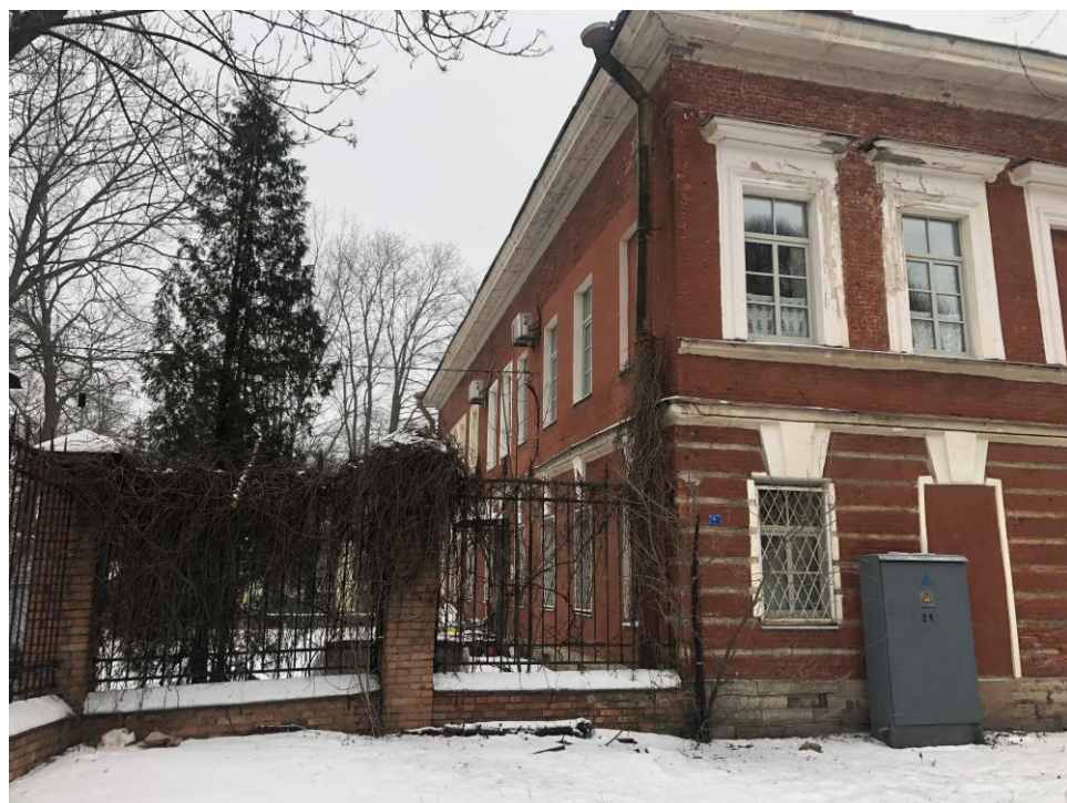
13. Объект культурного наследия федерального значения «Дом пастора», расположенный по адресу: г. Санкт-Петербург, г. Кронштадт, Ленинградская ул., д. 1, литера А, входящий в состав объекта культурного наследия федерального значения «Храм лютеранский святой Елизаветы», расположенный по адресу: г. Санкт-Петербург, г. Кронштадт, Ленинградская ул., д. 1, литеры А, Н. Общий вид на северо-западный торцевой и северо-восточный фасады.
