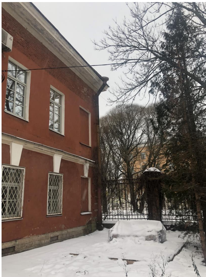
10. Объект культурного наследия федерального значения «Дом пастора», расположенный по адресу: г. Санкт-Петербург, г. Кронштадт, Ленинградская ул., д. 1, литера А, входящий в состав объекта культурного наследия федерального значения «Храм лютеранский святой Елизаветы», расположенный по адресу: г. Санкт-Петербург, г. Кронштадт, Ленинградская ул., д. 1, литеры А, Н. Фрагмент северо-восточного фасада.
