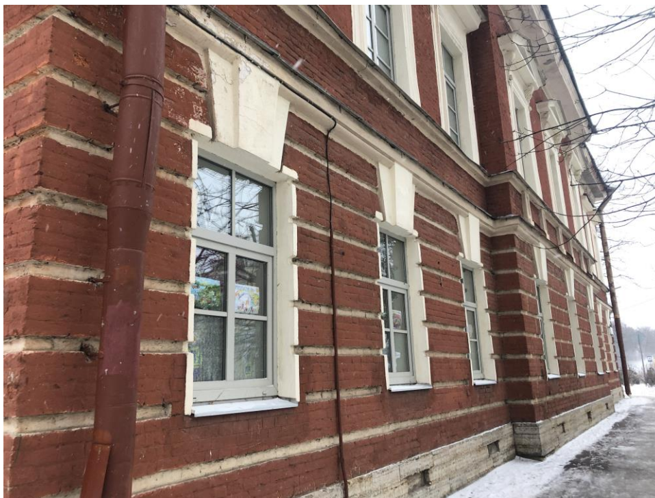
14. Объект культурного наследия федерального значения «Дом пастора», расположенный по адресу: г. Санкт-Петербург, г. Кронштадт, Ленинградская ул., д. 1, литера А, входящий в состав объекта культурного наследия федерального значения «Храм лютеранский святой Елизаветы», расположенный по адресу: г. Санкт-Петербург, г. Кронштадт, Ленинградская ул., д. 1, литеры А, Н. Вид на юго-западный лицевой фасад в юго-восточном направлении.
