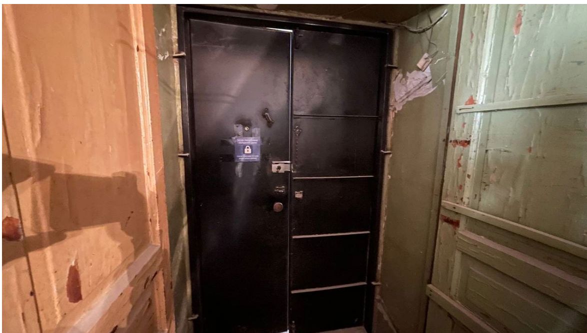
7. Вид на входную дверь в квартире;
