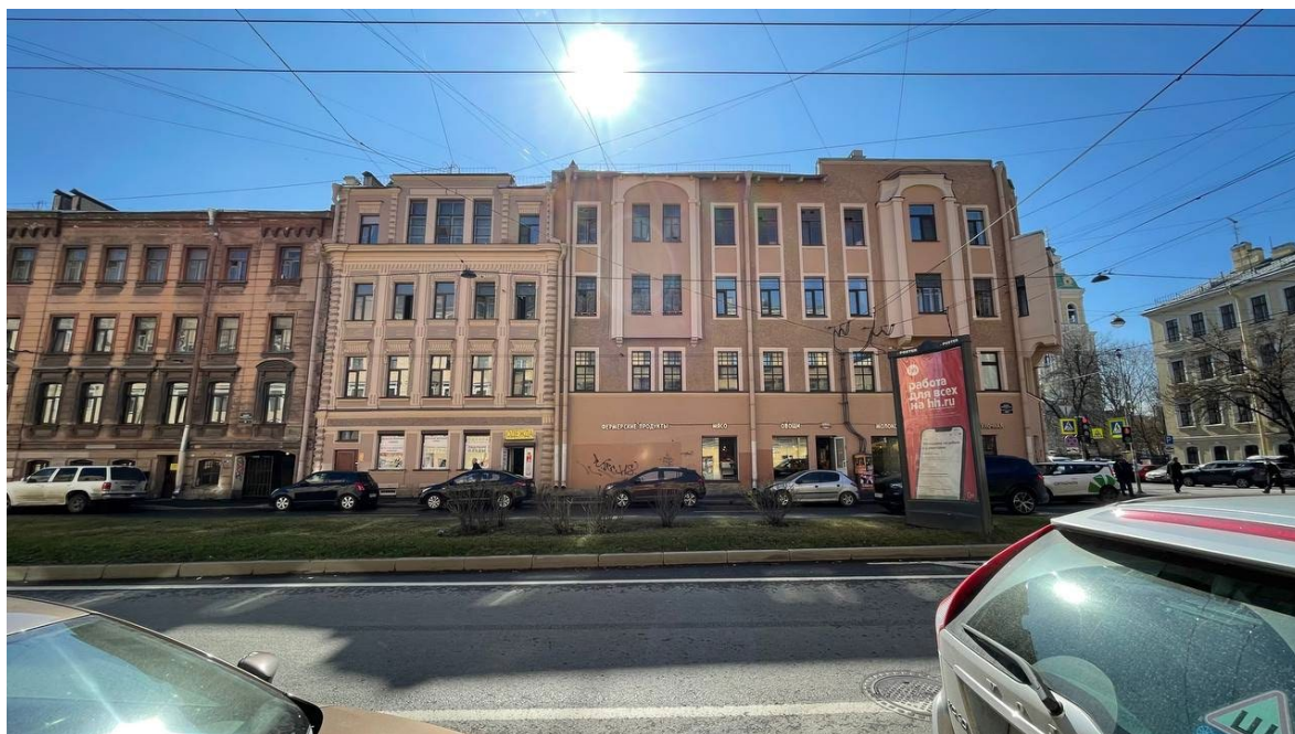
1. Вид на главный фасад;
