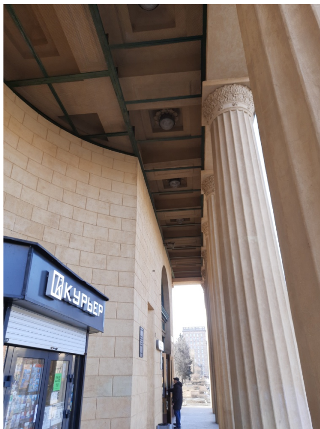
Фото 5 Фрагмент лицевого фасада объекта культурного наследия регионального значения «Станция метро «Кировский завод», г. Санкт-Петербург, пр. Стачек, д. 70, литера А.
