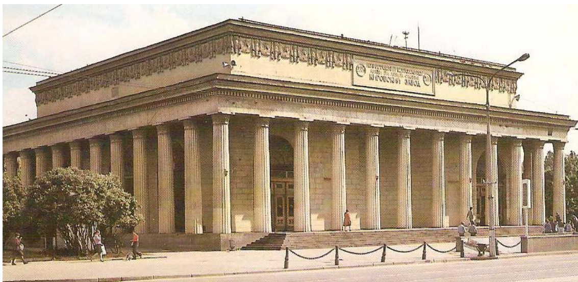
29. Станция метро «Кировский завод». Наземный вестибюль. 1986 г. — «PastVu» – ретро-фотографии стран и городов [Электронный ресурс]. URL: https://pastvu.com/p/124837 .
