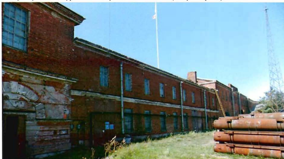
5. Правофланговая куртина с надстроенными объемами (северный фасад).
