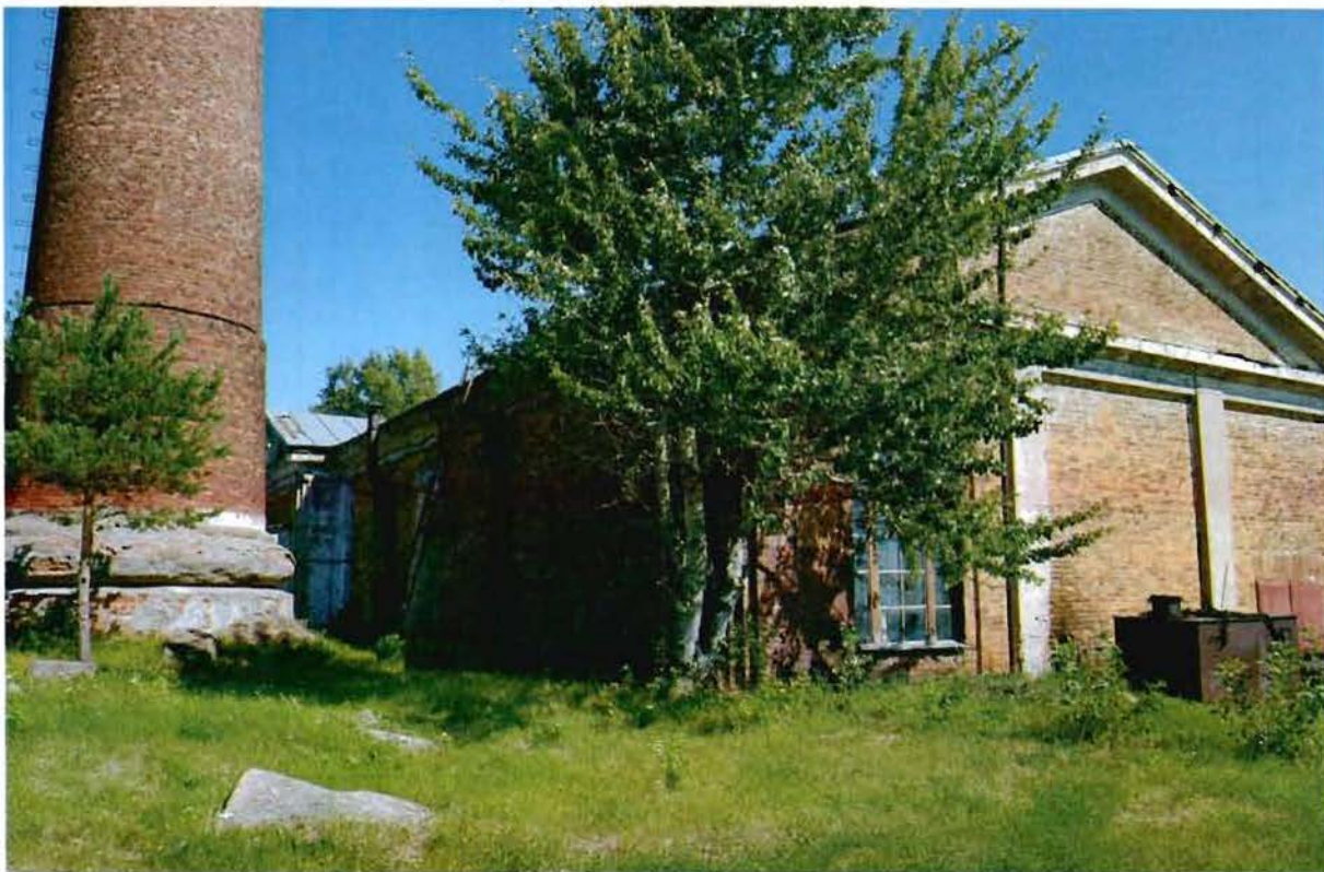
11. Котельная (западный и южный фасады).
