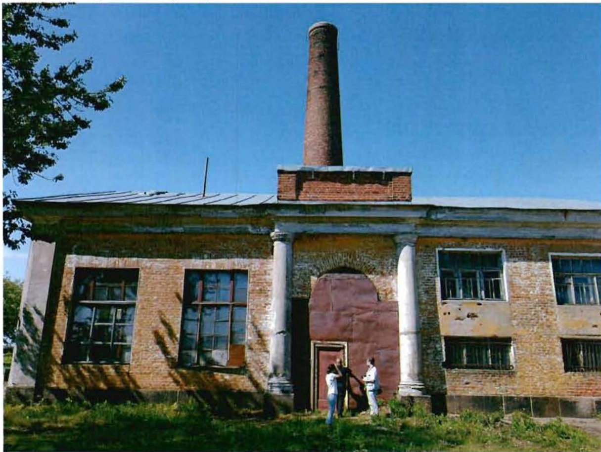
10. Котельная (восточный фасад).
