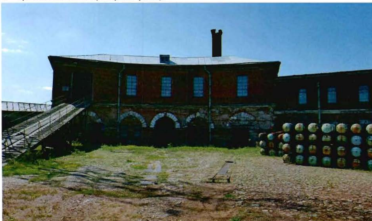
2. Фронтальная башня (северный фасад).
