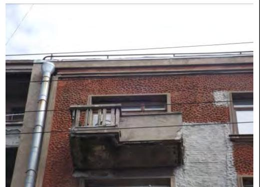
терраса в уровне первого этажа с полупрозрачным бетонным ограждением с металлическими вставками в профилированных рамах, рисунок геометрического характера - по лицевому фасаду ул. Плуталова;
