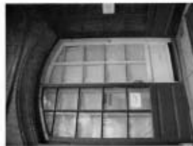
14). Деревянный проем северный лицевой фасад
