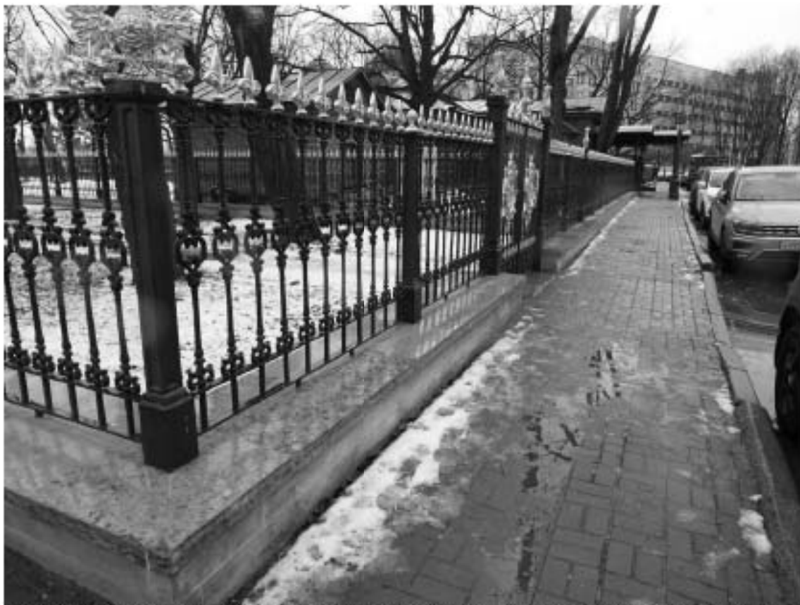
Фото 33. Трогуар вдоль объекта культурного наследия федерального значения «Домик Петра I» (Петровская наб., 6). Северный и восточный угол ограды. Вид на запад. Съемка 03.03.2022 г. Трушковский В.Э.
