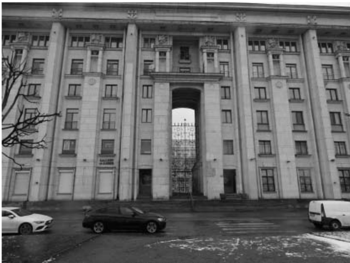
Фото 41. Вид на объект культурного наследия регионального значения «Жилой дом» (Мичуринская улица, д. 1, лит. А). Фрагмент лицевого фасада. Съемка 03.03.2022 г. Трушковский В.Э.
