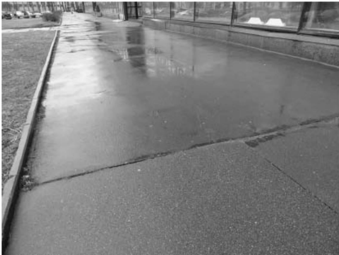
Фото 74. Трогуар вдоль дома по адресу: Петровская набережная, д 4, лит. А. Вид на север. Съемка 03.03.2022 г. Трушковский В.Э.
