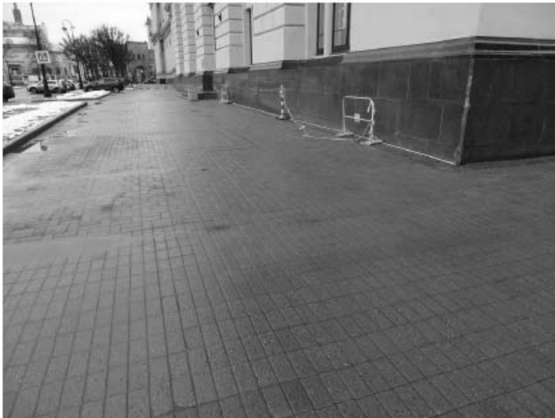
Фото 32. Тротуар вдоль Троицкой площади П.С., д. 3, лит. А. Вид на север. Съемка 03.03.2022 г. Трушковский В.Э.
