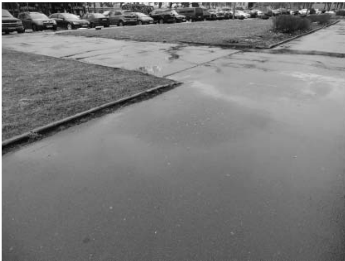
Фото 75. Тротуар вдоль ЗНОП городского значения № 13041 «Сквер Товстоногова между д.1, д.3 по Троицкой пл. П. С. и д. 1/5 по ул. Куйбышева и д. 4 по Петровской наб.». Вид на юго-запад. Съемка 03.03.2022 г. Трушковский В.Э.
