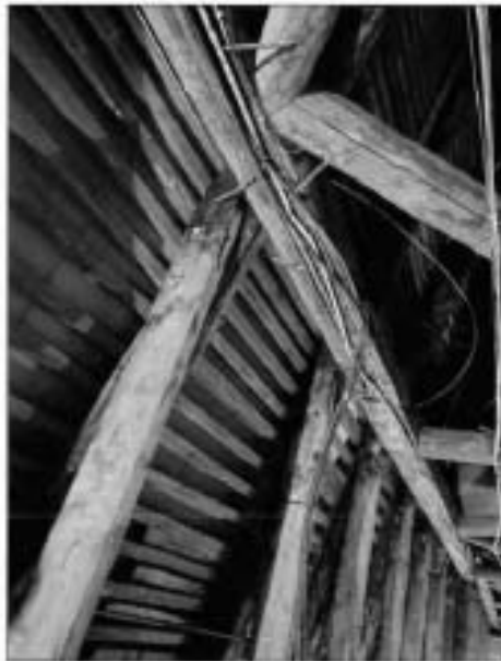
11. Фрагмент стропильной системы объекта культурного наследия.
