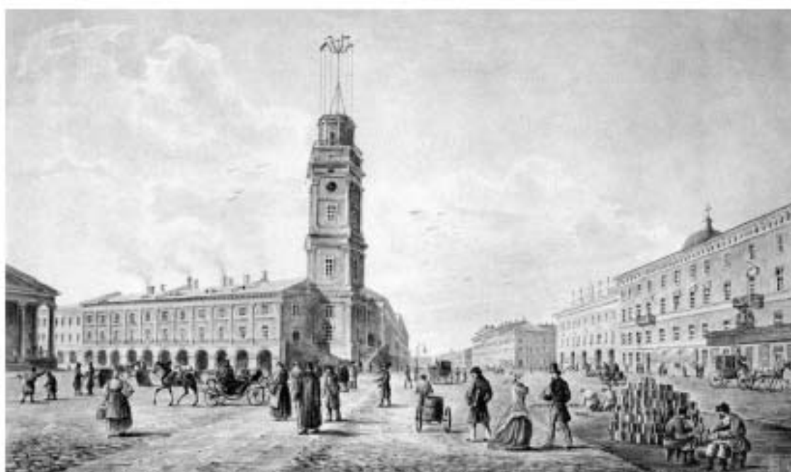
Илл. 8. Укладка торцовой мостовой на Невском проспекте. 1820-е гг. https://architectstyle.livejournal.com/164041.html
