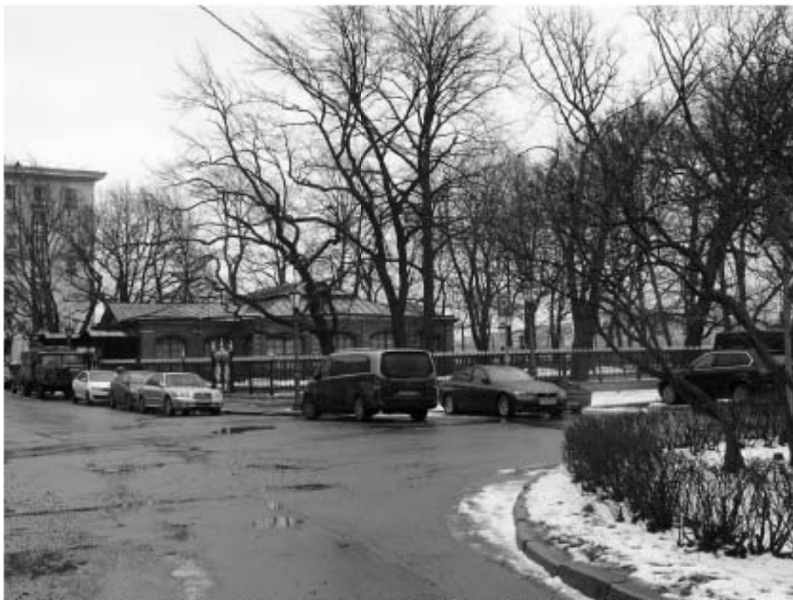
Фото 19. Объект культурного наследия федерального значения «Домик Петра I» (Петровская наб., 6). Общий вид. Съемка 03.03.2022 г. Трушковский В.Э.
