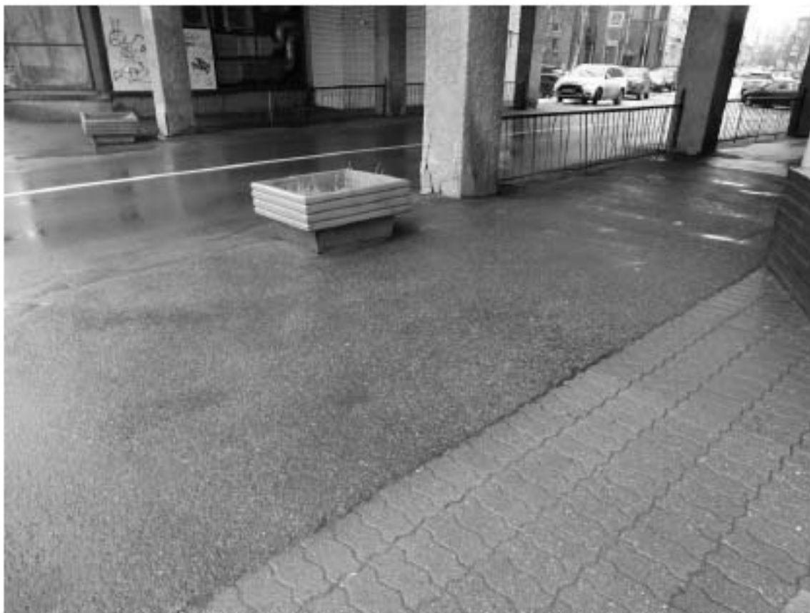
Фото 61. Тротуар по Мичуринской ул. в проезде дома на Петровской наб., д. 4, лит. А. Съемка 03.03.2022 г. Трушковский В.Э.
