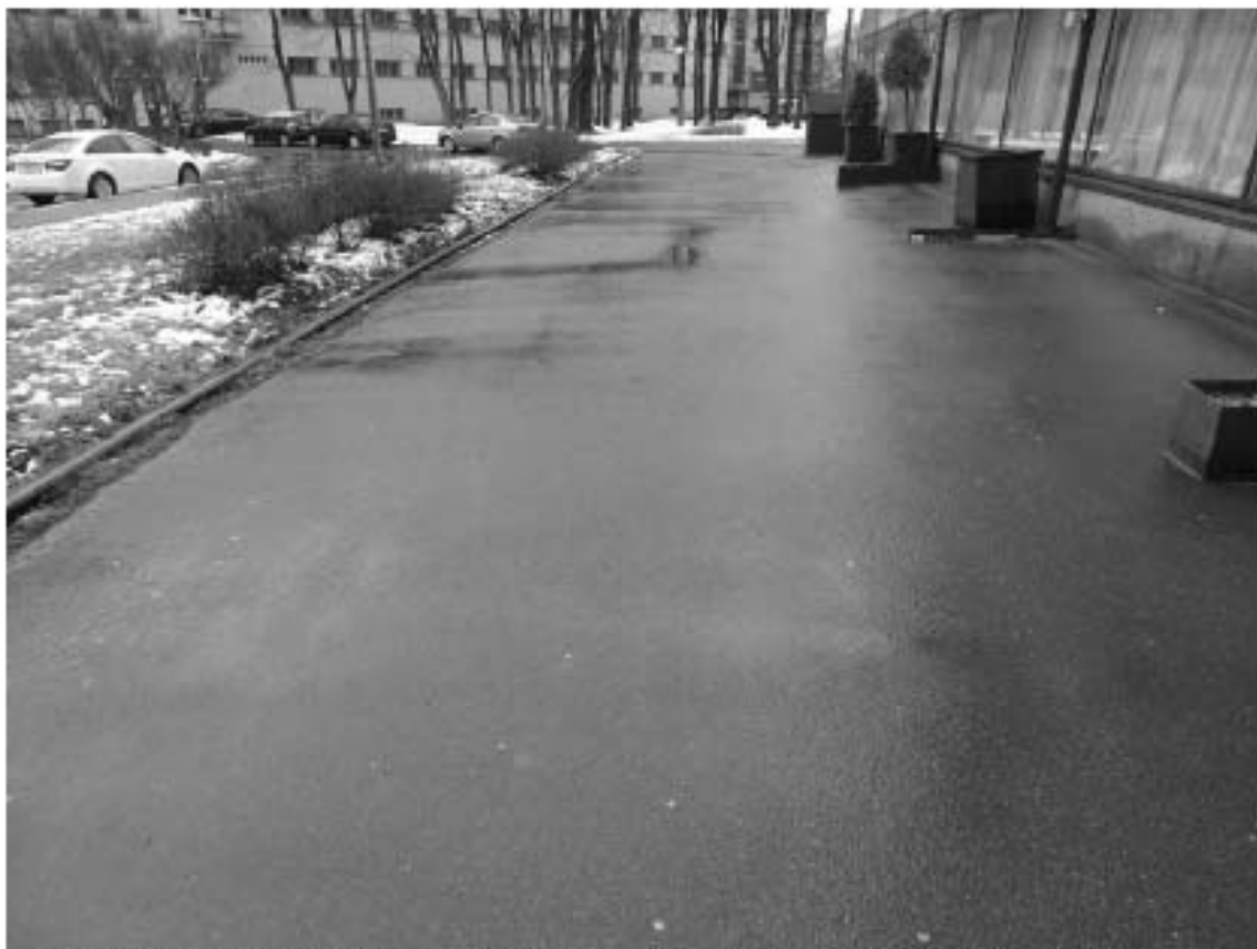
Фото 79. Трогуар вдоль дома по адресу: Петровская набережная, д. 4, лит. А. Вид на запад. Съемка 03.03.2022 г. Трушковский В.Э.
