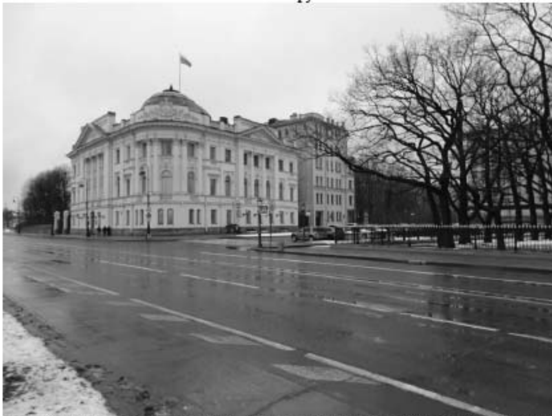
Фото 2. Объект культурного наследия федерального значения «Дворец Великого князя Николая Николаевича с доходным домом» (Петровская наб., д. 2, корп. 1, лит. А; корп. 2, лит. Б). Общий вид. Съемка 03.03.2022 г. Трушковский В.Э.
