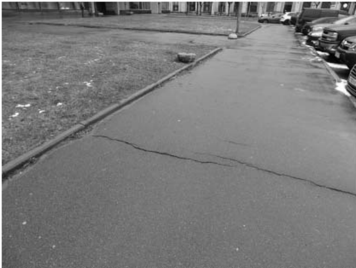
Фото 72. Тротуар вдоль ЗНОП городского значения № 13041 «Сквер Товстоногова между д.1, д.3 по Троицкой пл. П. С. и д. 1/5 по ул. Куйбышева и д. 4 по Петровской наб.». Вид на восток. Съемка 03.03.2022 г. Трушковский В.Э.
