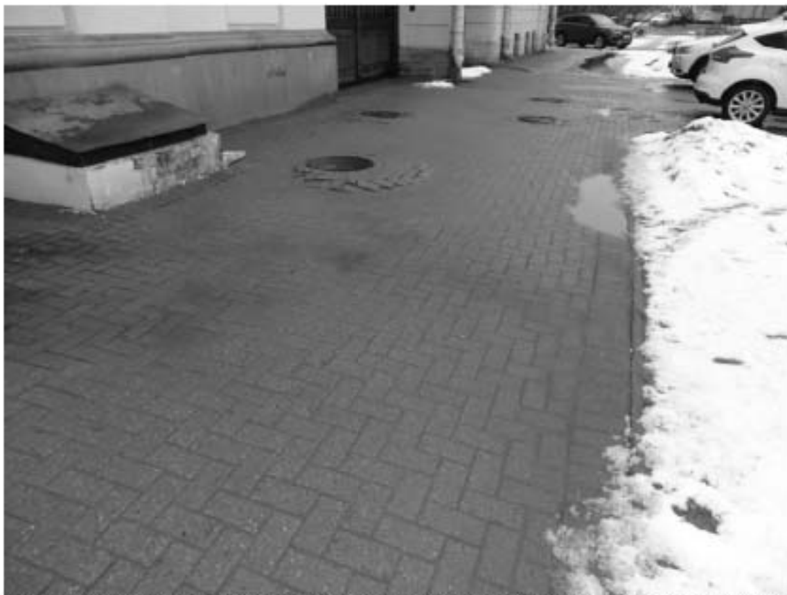
Фото 11. Тротуар вдоль объекта культурного наследия федерального значения «Дворец Великого князя Николая Николаевича с доходным домом». (Петровская наб., д. 2, корп. 1, лит. А; корп. 2, лит. Б). Вид на север. Съемка 03.03.2022 г. Трушковский В.Э.
