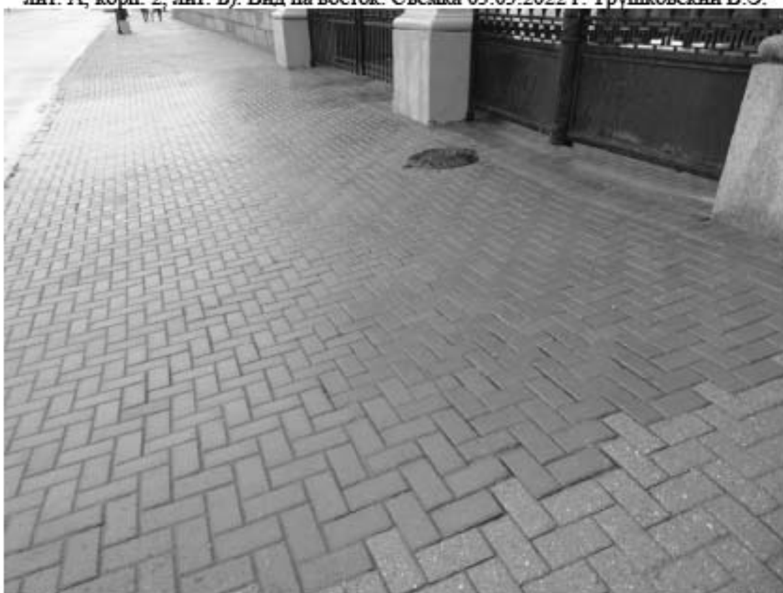
Фото 6. Трогуар вдоль объекта культурного наследия федерального значения «Дворец Великого князя Николая Николаевича с доходным домом». (Петровская наб., д. 2, корп. 1, лит. А; корп. 2, лит. Б). Вид на запад. Съемка 03.03.2022 г. Трушковский В.Э.
