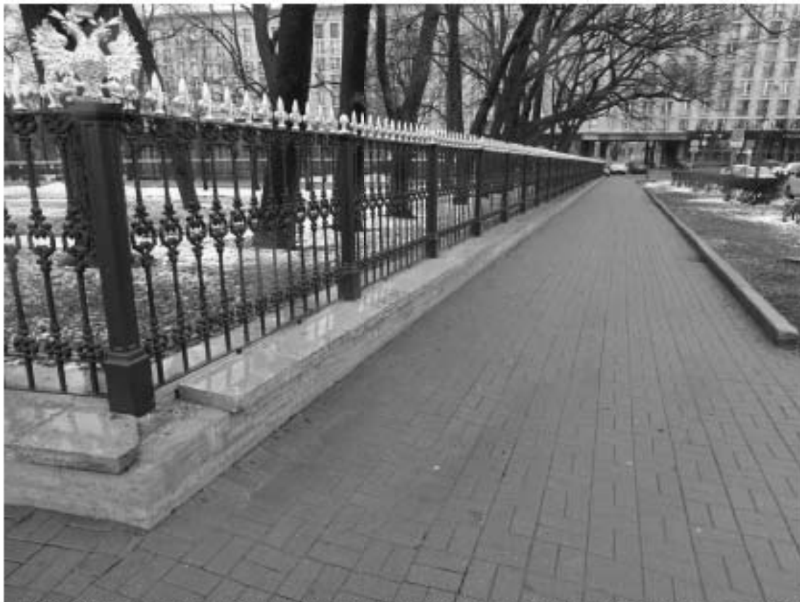
Фото 30. Трогуар вдоль объекта культурного наследия федерального значения «Домик Петра I» (Петровская наб., 6). Южный и восточный угол. Вид на север. Съемка 03.03.2022 г. Трушковский В.Э.
