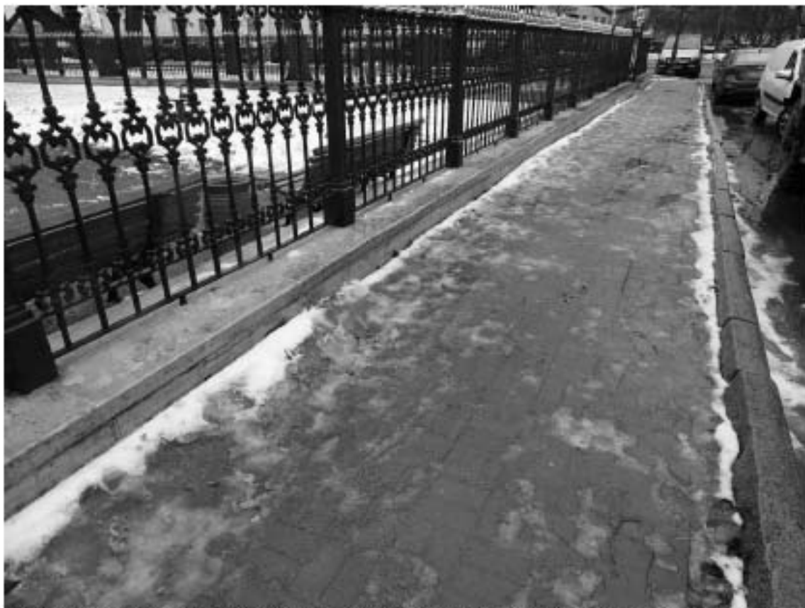
Фото 35. Трогуар вдоль объекта культурного наследия федерального значения «Домик Петра I» (Петровская наб., 6). Вид на запад. Съемка 03.03.2022 г. Трушковский В.Э.
