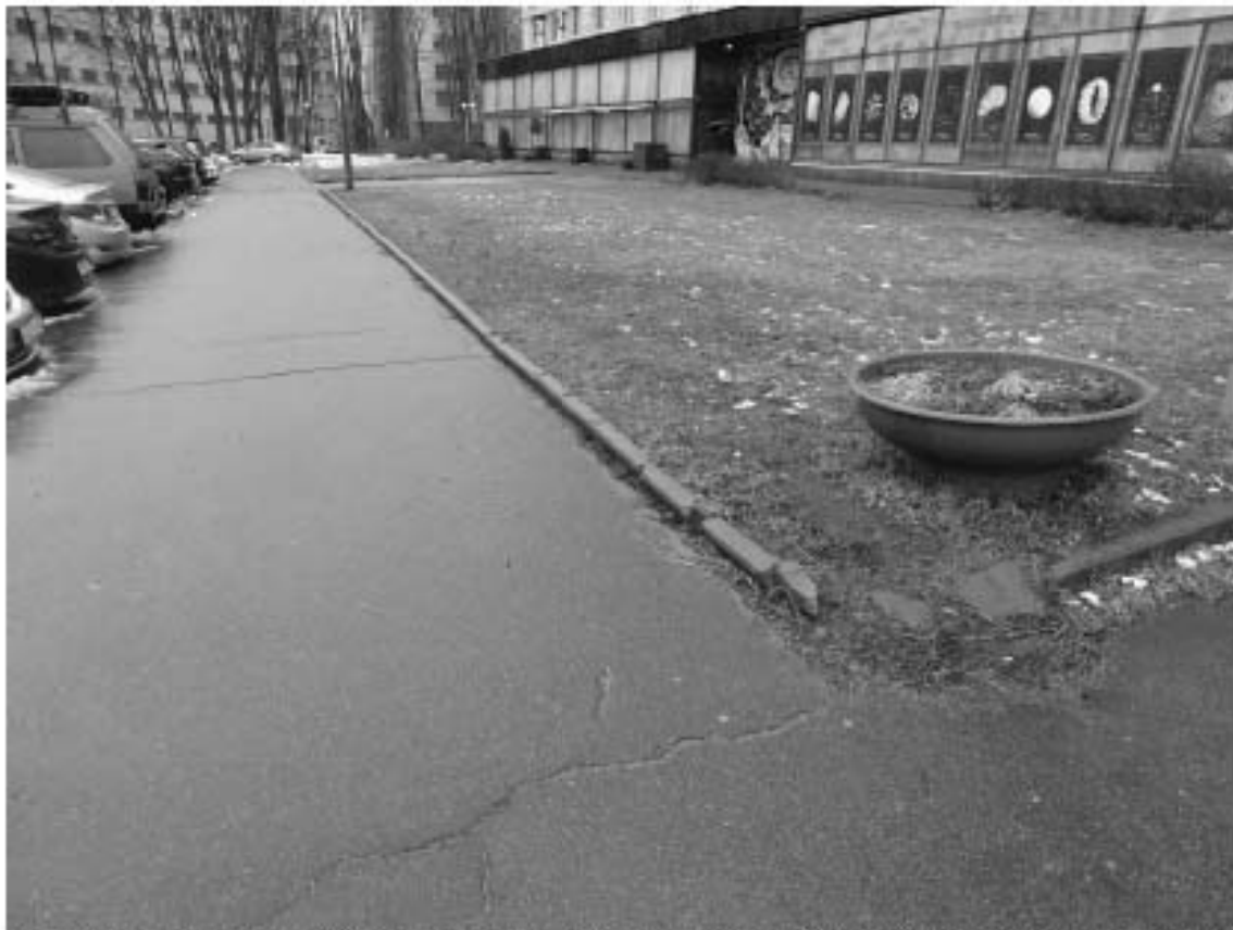
Фото 76. Тротуар вдоль ЗНОП городского значения № 13041 «Сквер Товстоногова между д.1, д.3 по Троицкой пл. П. С. и д. 1/5 по ул. Куйбышева и д. 4 по Петровской наб.». Вид на запад. Съемка 03.03.2022 г. Трушковский В.Э.
