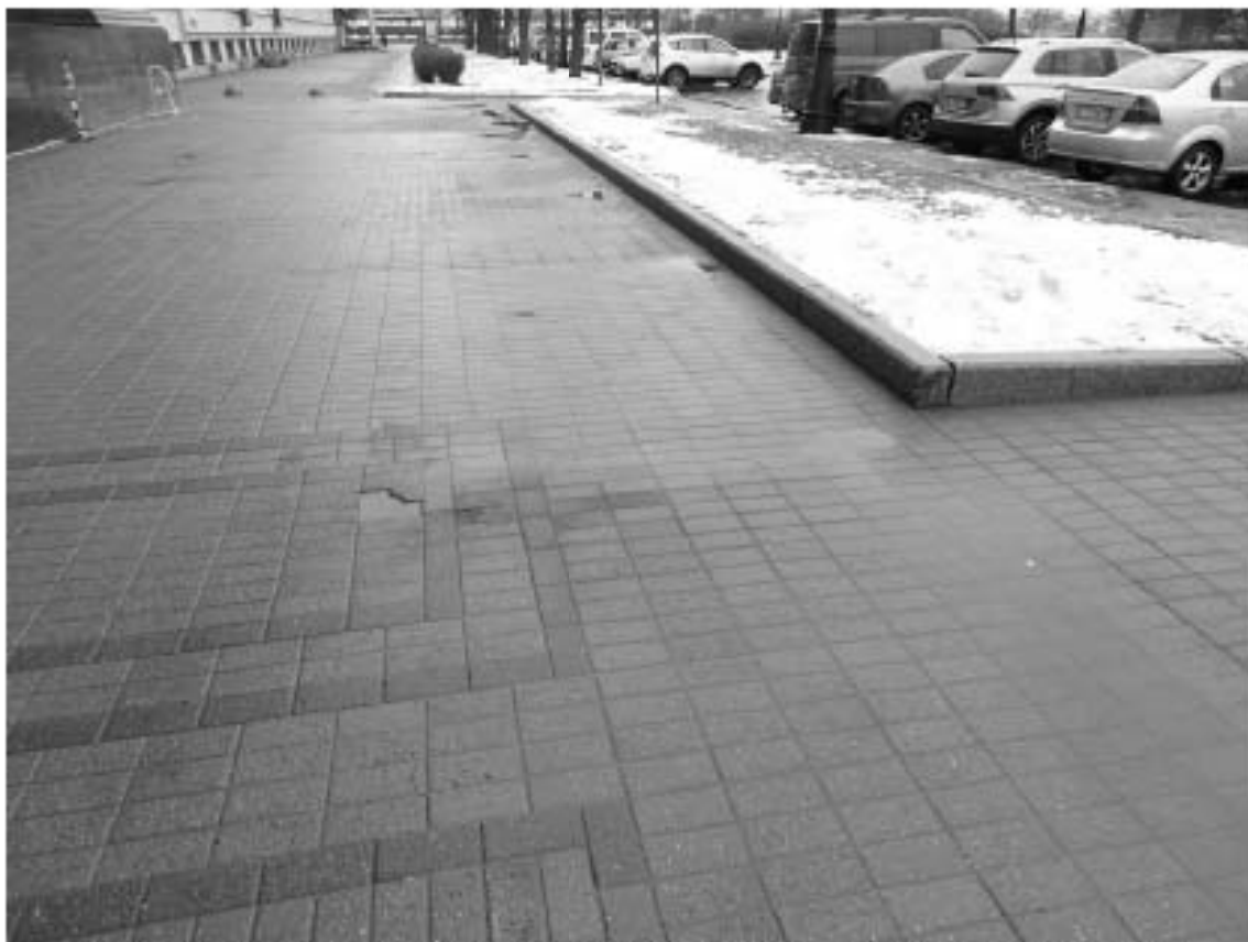
Фото 31. Тротуар вдоль Троицкой площади П.С., д. 3, лит. А. Вид на юг. Съемка 03.03.2022 г. Трушковский В.Э.
