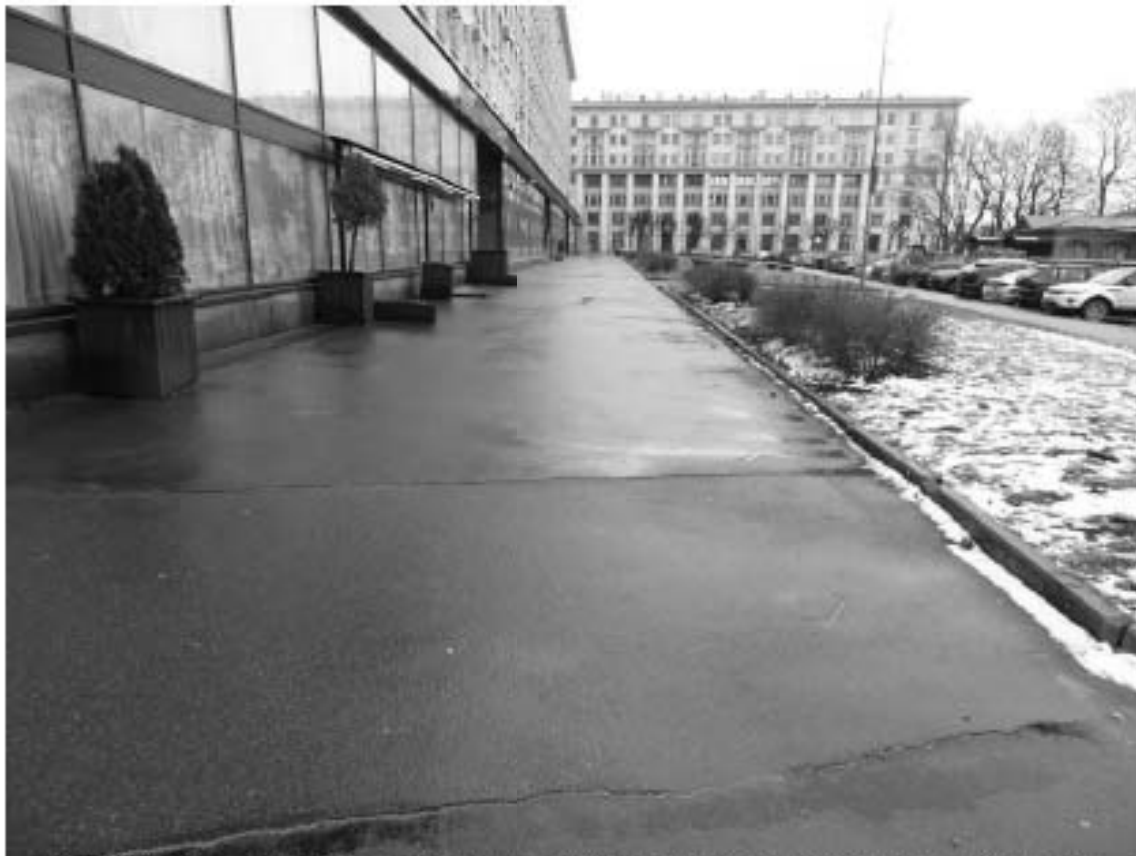
Фото 68. Тротуар вдоль дома по адресу: Петровская набережная, д. 4, лит. А. Вид на восток. Съемка 03.03.2022 г. Трушковский В.Э.
