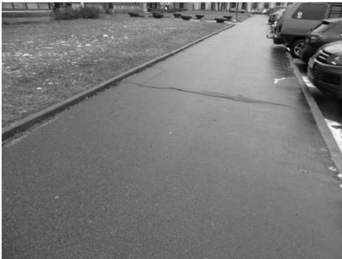
Фото 71. Тротуар вдоль ЗНОП городского значения № 13041 «Сквер Товстоногова между д.1, д.3 по Троицкой пл. П. С. и д. 1/5 по ул. Куйбышева и д. 4 по Петровской наб.». Вид на восток. Съемка 03.03.2022 г. Трушковский В.Э.
