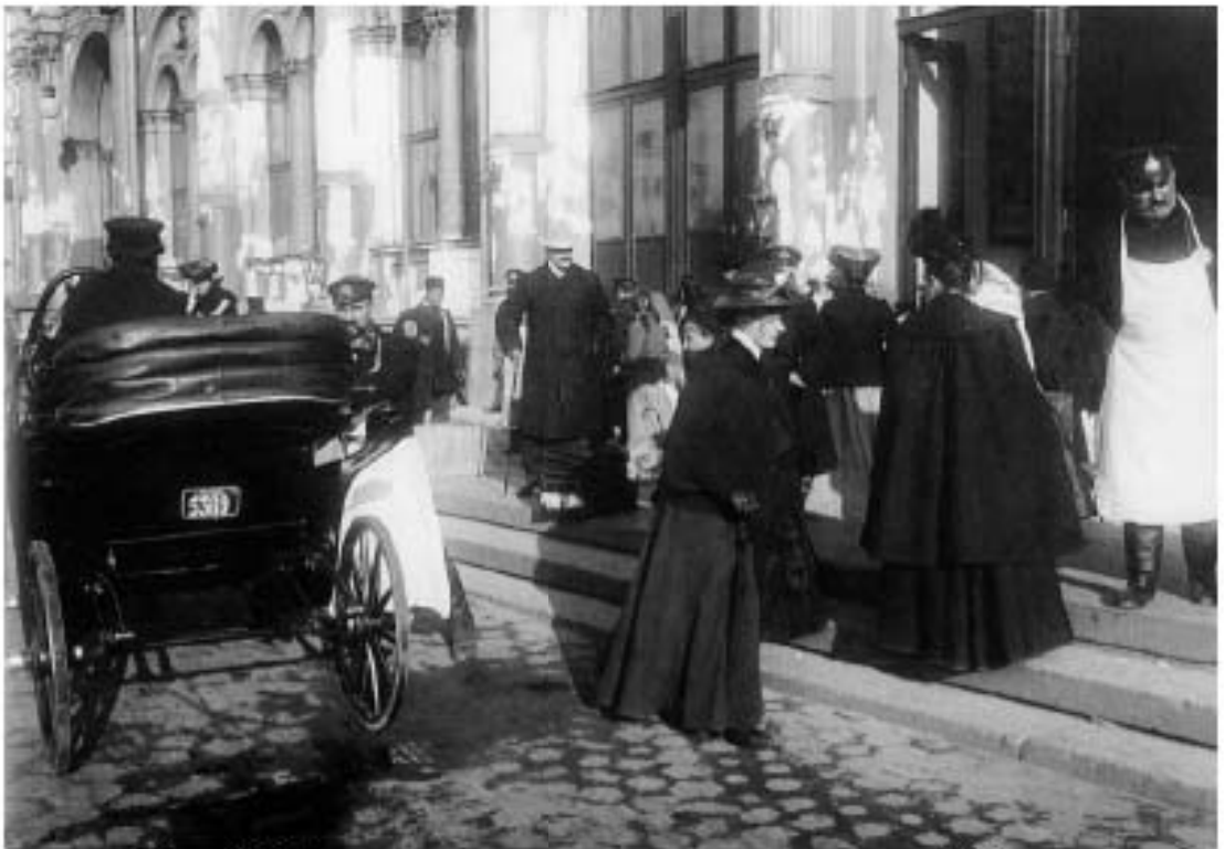
Илл. 10. Мощение улицы шестигранными торцами. 1900-е гг. https://architectstyle.livejournal.com/164041.html
