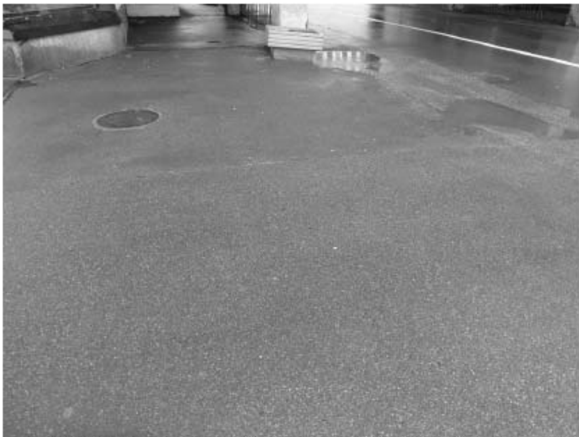
Фото 73. Трогуар вдоль дома по адресу: Петровская набережная, д 4, лит. А. Вид на север. Съемка 03.03.2022 г. Трушковский В.Э.
