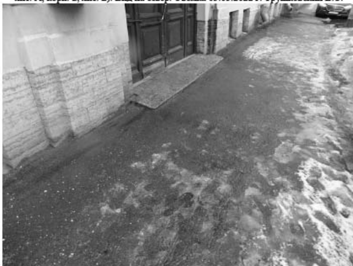
Фото 14. Трогуар вдоль объекта культурного наследия федерального значения «Дом доходный», входящий в состав объекта культурного наследия «Дворец Великого князя Николая Николаевича с доходным домом». (Петровская наб., д. 2, корп. 1, лит. А; корп. 2, лит. Б). Вид на северо-запад. Съемка 03.03.2022 г. Трушковский В.Э.
