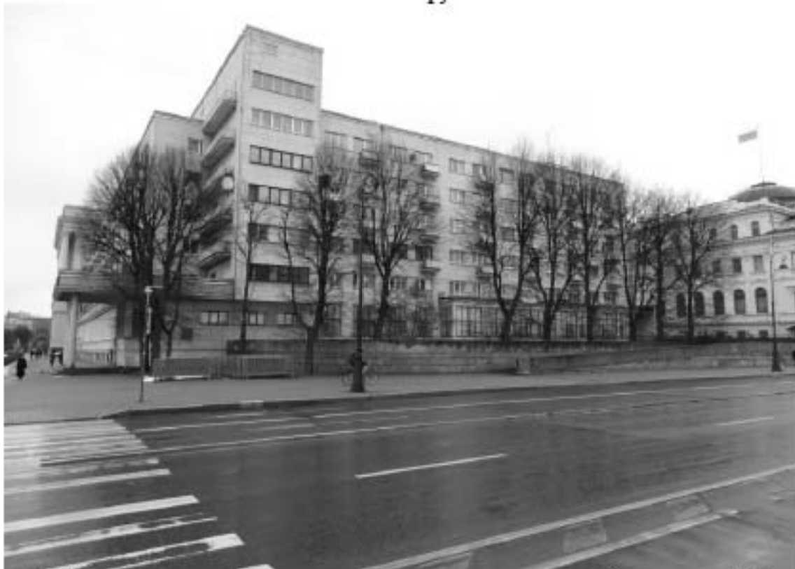
Фото 46. Объект культурного наследия регионального значения «Дом-коммуна Общества бывших политкаторжан и ссыльнопоселенцев» (Троицкая площадь П.С., д. 1, лит. А). Общий вид. Съемка 03.03.2022 г. Трушковский В.Э.
