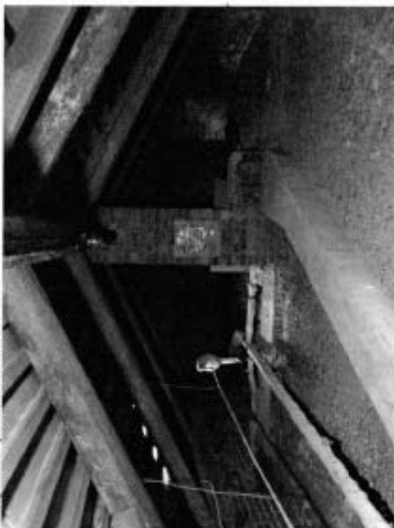
15. Крыша. Стропильная система.
