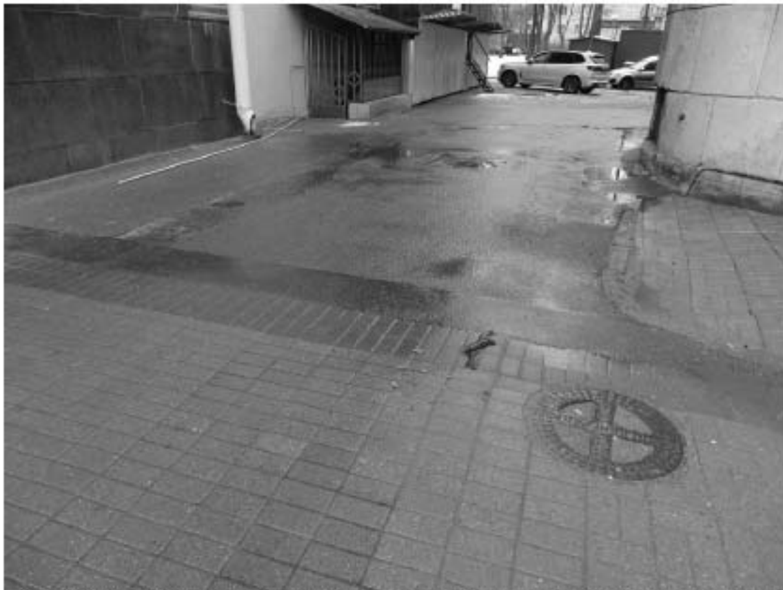
Фото 38. Тротуар вдоль объекта культурного наследия регионального значения «Дом-коммуна Общества бывших политкаторжан и ссыльнопоселенцев» (Троицкая площадь П.С., д. 1, лит. А). Съемка 03.03.2022 г. Трушковский В.Э.
