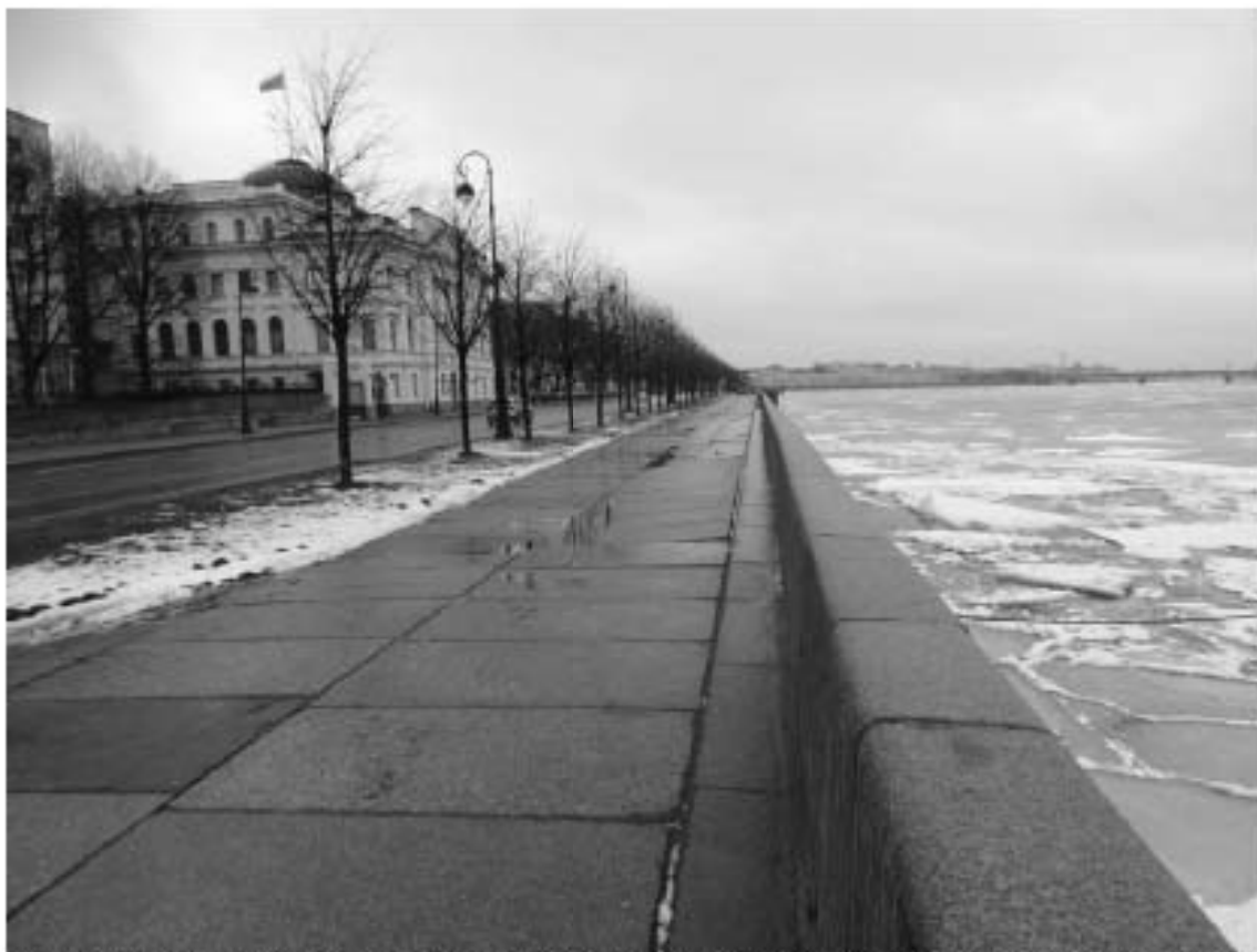
Фото 1. Объект культурного наследия федерального значения «Набережная императора Петра Великого (ныне Петровская)» (участок набережной рек Невы и Большой Невки "Троицкий мост-Сампсониевский мост", лит. А). Вид на восток. Съемка 03.03.2022 г. Трушковский В.Э.
