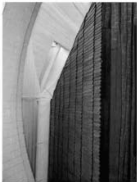
5). Фрагмент кровли дровяка (золотые сосновые клиновидные дощечки)
