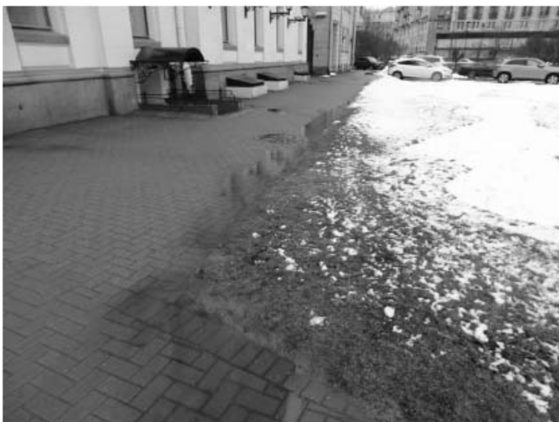
Фото 10. Тротуар вдоль объекта культурного наследия федерального значения «Дворец Великого князя Николая Николаевича с доходным домом». (Петровская наб., д. 2, корп. 1, лит. А; корп. 2, лит. Б). Вид на север. Съемка 03.03.2022 г. Трушковский В.Э.
