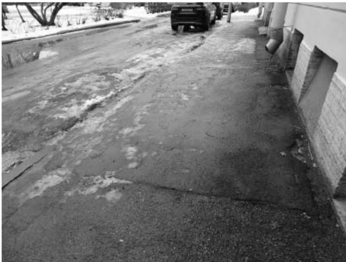
Фото 15. Тротуар вдоль объекта культурного наследия федерального значения «Дом доходный» входящий в состав объекта культурного наследия «Дворец Великого князя Николая Николаевича с доходным домом». (Петровская наб., д. 2, корп. 1, лит. А; корп. 2, лит. Б). Вид на юго-восток. Съемка 03.03.2022 г. Трушковский В.Э.
