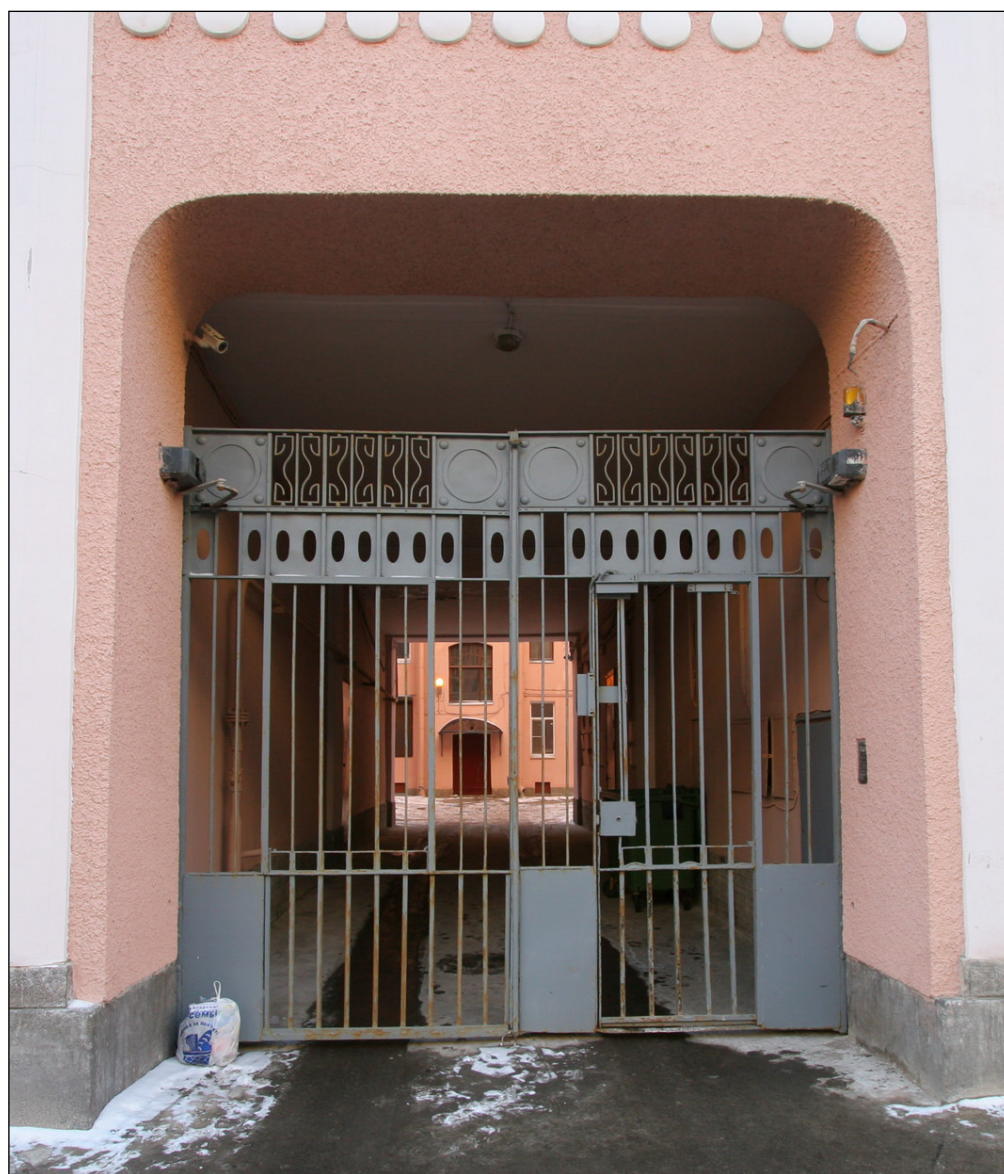
5. Фрагмент главного фасада выявленного объекта культурного наследия «Дом А. М. Стрелина». Металлические ворота проезда во двор. Дата съемки: 9 марта 2022 г. Фотограф: Аверьянова А. Е.
