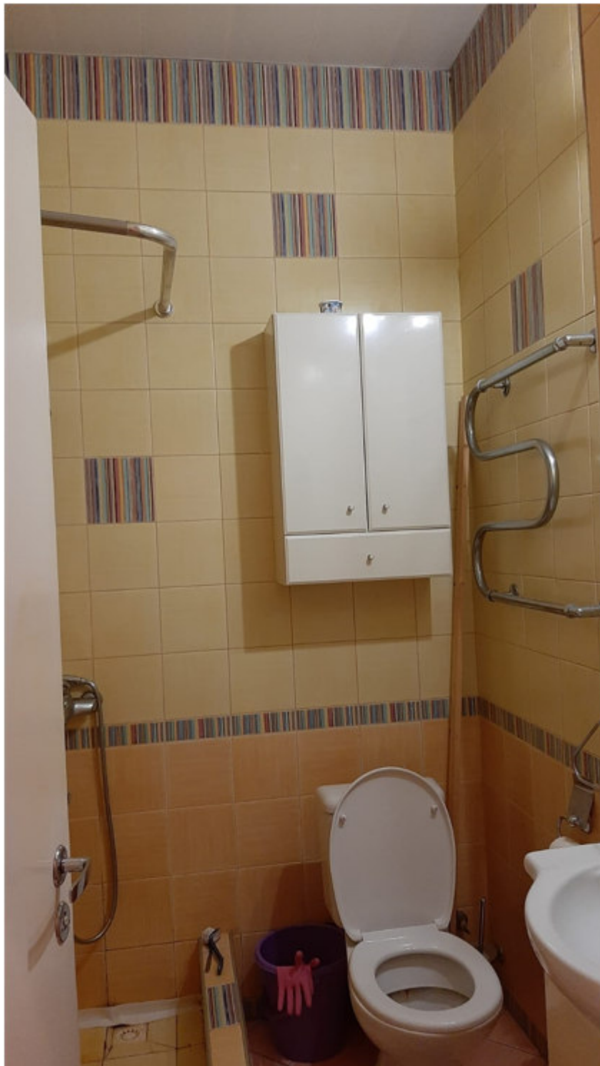
18. Фрагмент помещения № 8. Дата съемки 09.03.2022г. Фотограф Аверьянова А.Е.
