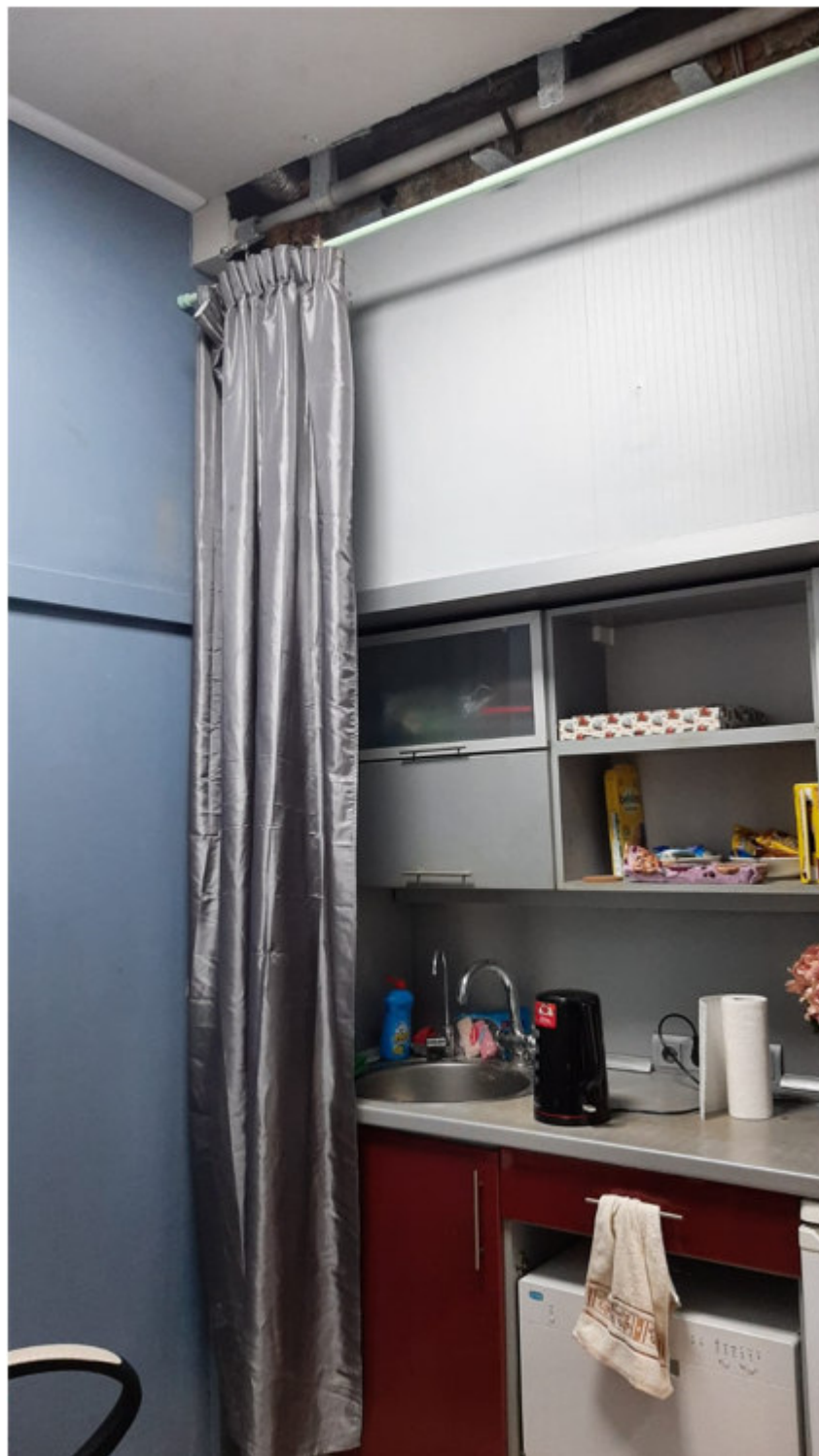
12.Фрагмент помещения №2 Дата съёмки 09.03.2022
