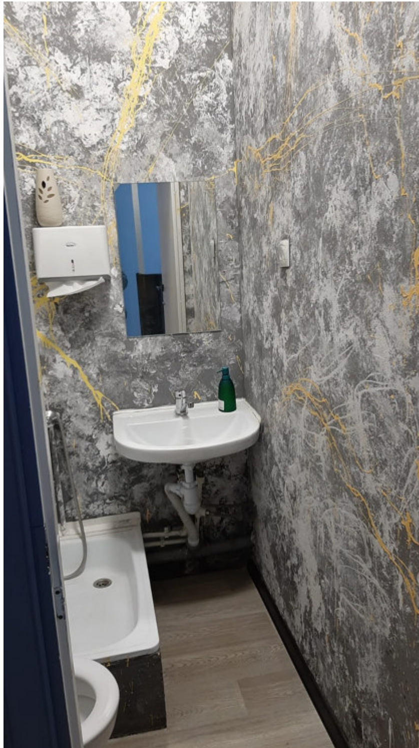
13. Фрагмент помещения №3. Дата съёмки 09.03.2022г.
