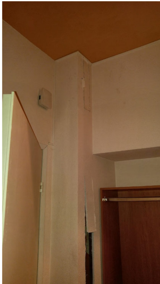
8. Фрагмент помещения №6. Дата съёмки 09.03.2022г. фотограф Аверьянова А.Е.
