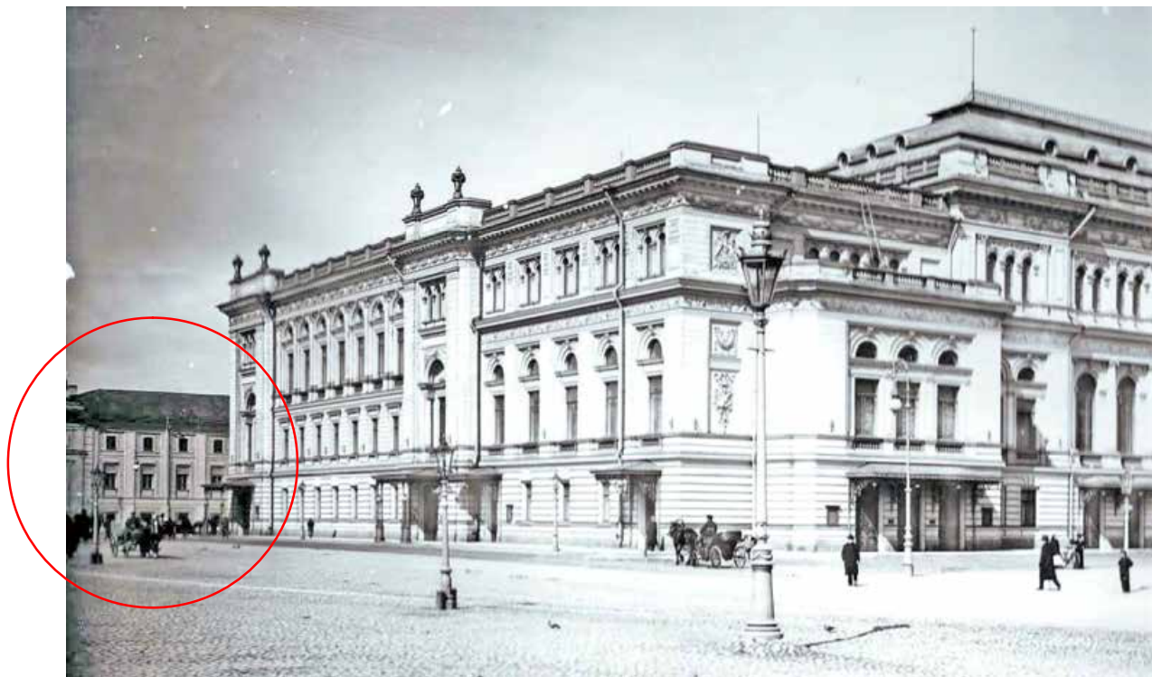
Илл. 13. Общий вид здания Петербургской консерватории (Театральная пл., 3). 1903 г. Фрагмент южного лицевого фасада здания Главного Криминалистического управления.
