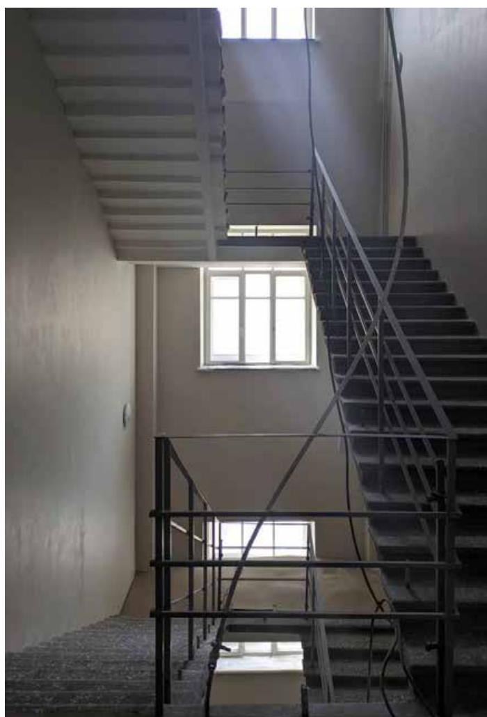
159. Вид на лестничную клетку зоны «Консерватория» в уровне 3-го этажа западного корпуса.
