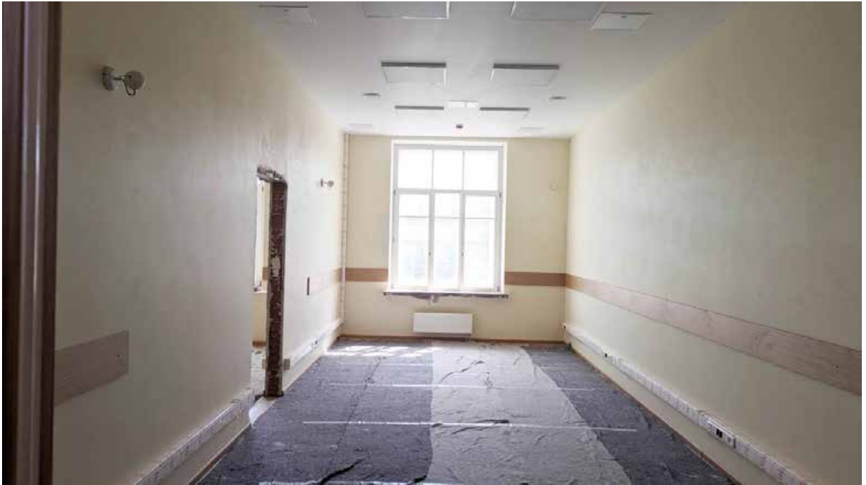
224. Вид в интерьере зоны «Консерватория» в уровне 4-го этажа южного корпуса.
