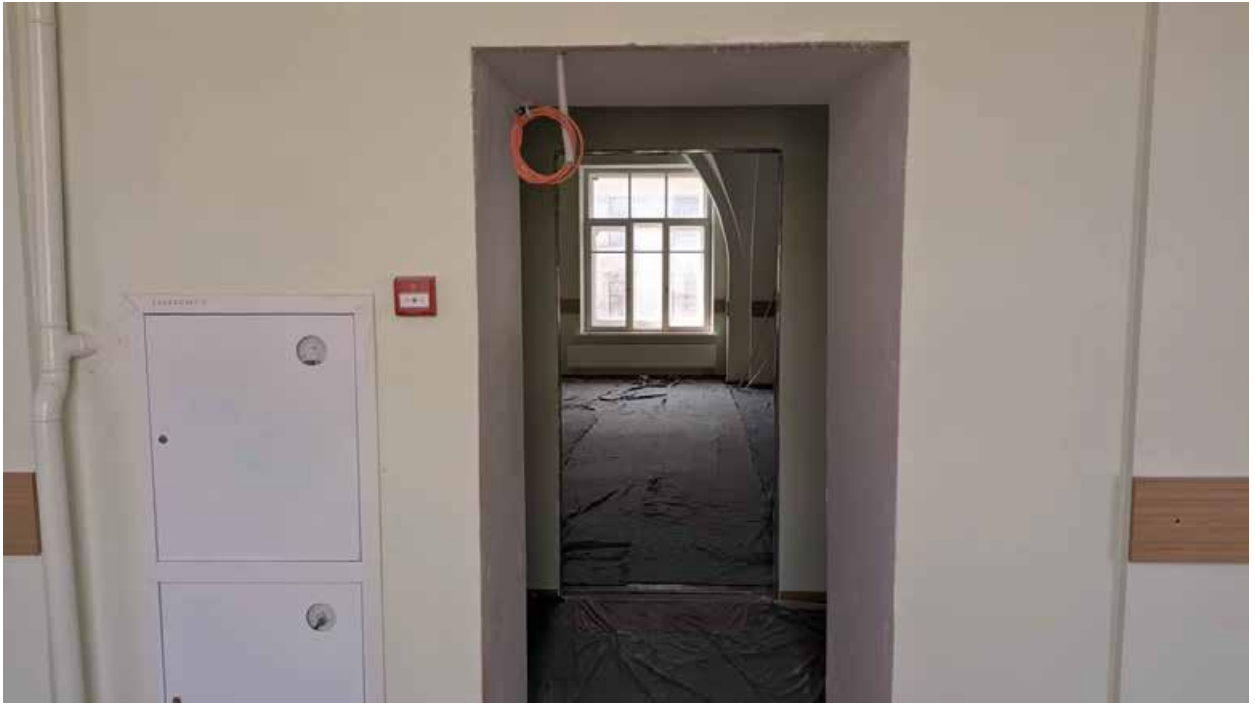
167. Вид в интерьере зоны «Консерватория» в уровне 3-го этажа западного корпуса.
