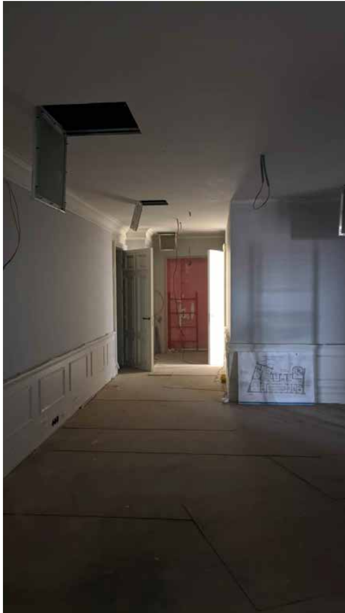
127. Вид в интерьере зоны «РВИО» в уровне 5-го этажа северного корпуса.
