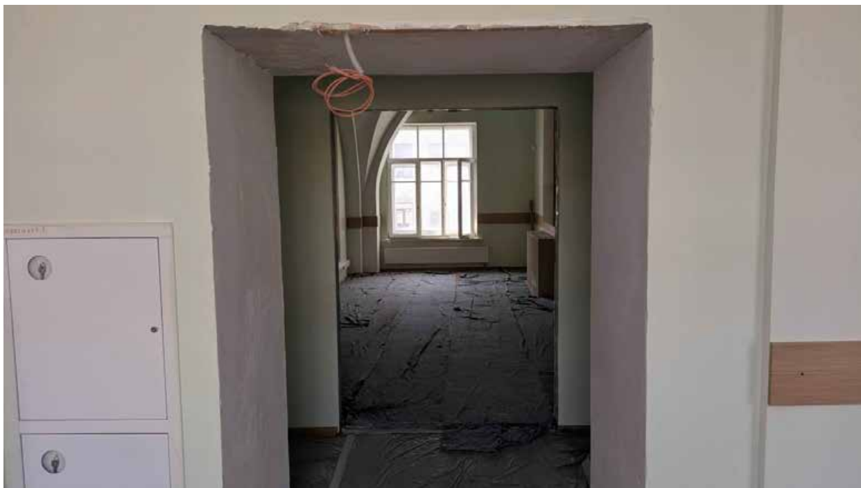
166. Вид в интерьере зоны «Консерватория» в уровне 3-го этажа западного корпуса.
