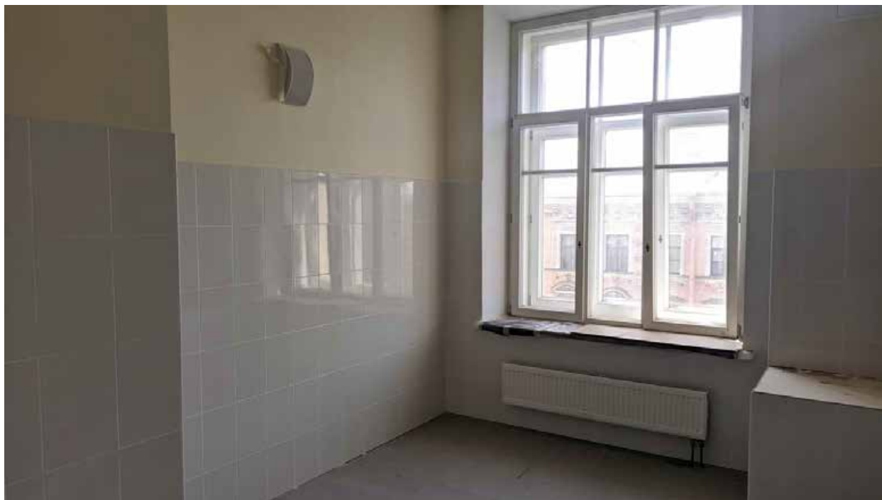
190. Вид в интерьере санузла зоны «Консерватория» в уровне 4-го этажа западного корпуса.
