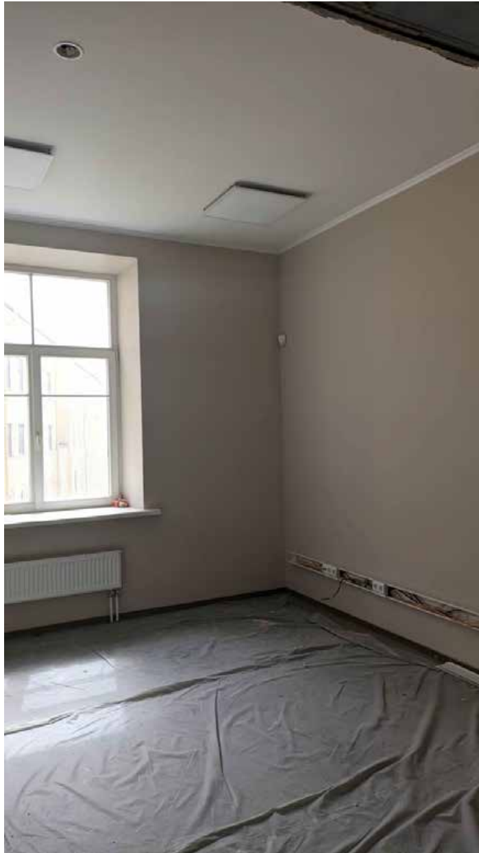
96. Вид в интерьере зоны «РВИО» в уровне 4-го этажа северного корпуса.
