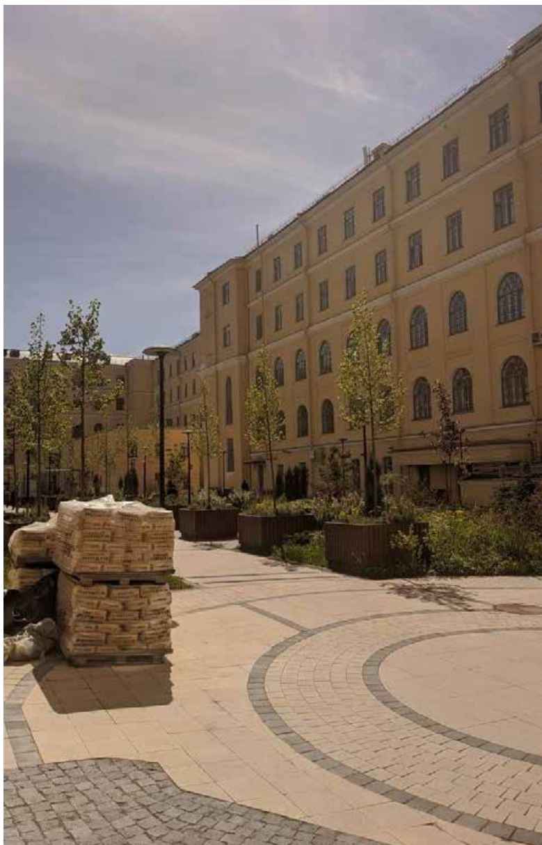
21. Вид на западный корпус со стороны внутреннего двора (дополнительная фотофиксация от 26.04.2022г.).
