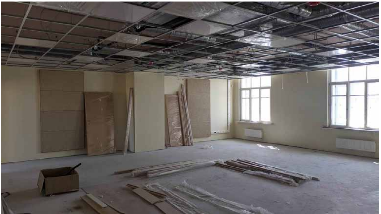
307. Вид в интерьере зоны «Консерватория» в уровне 5-го этажа западного корпуса.
