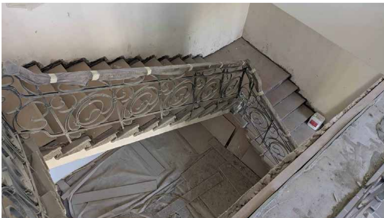
289. Вид в интерьере лестничной клетки зоны «Консерватория» в уровне 5-го этажа южного корпуса.
