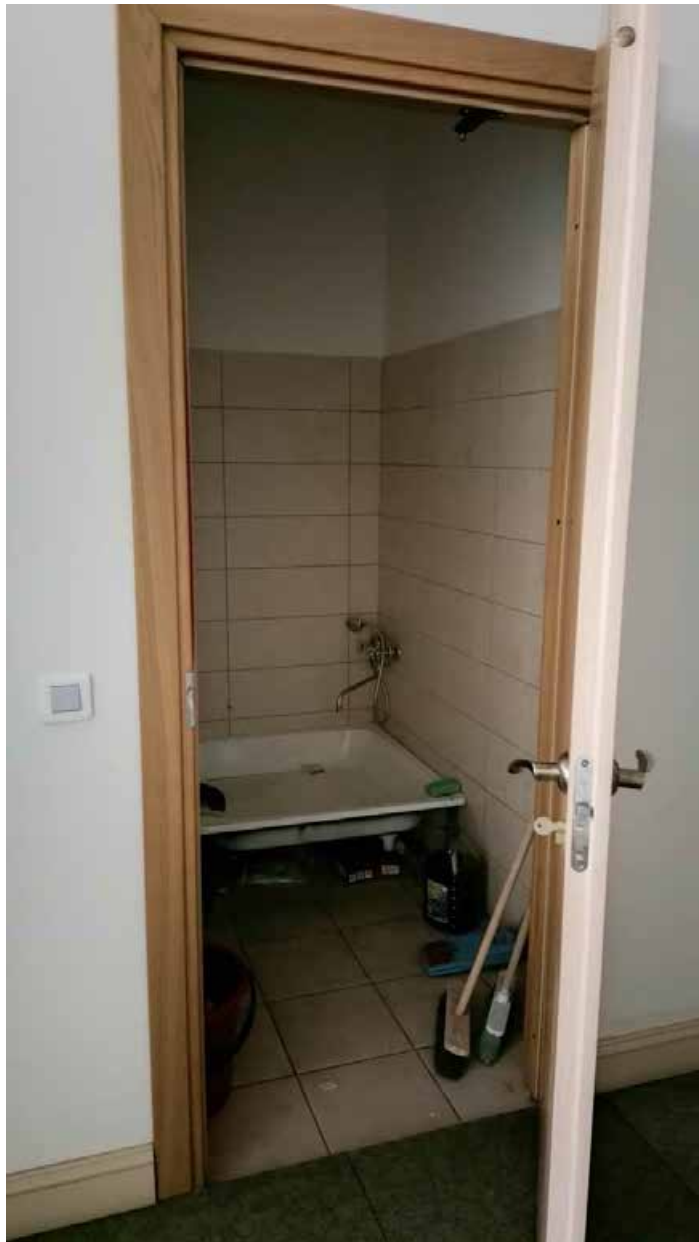
109. Вид в интерьере зоны «РВИО» в уровне 4-го этажа северного корпуса.
