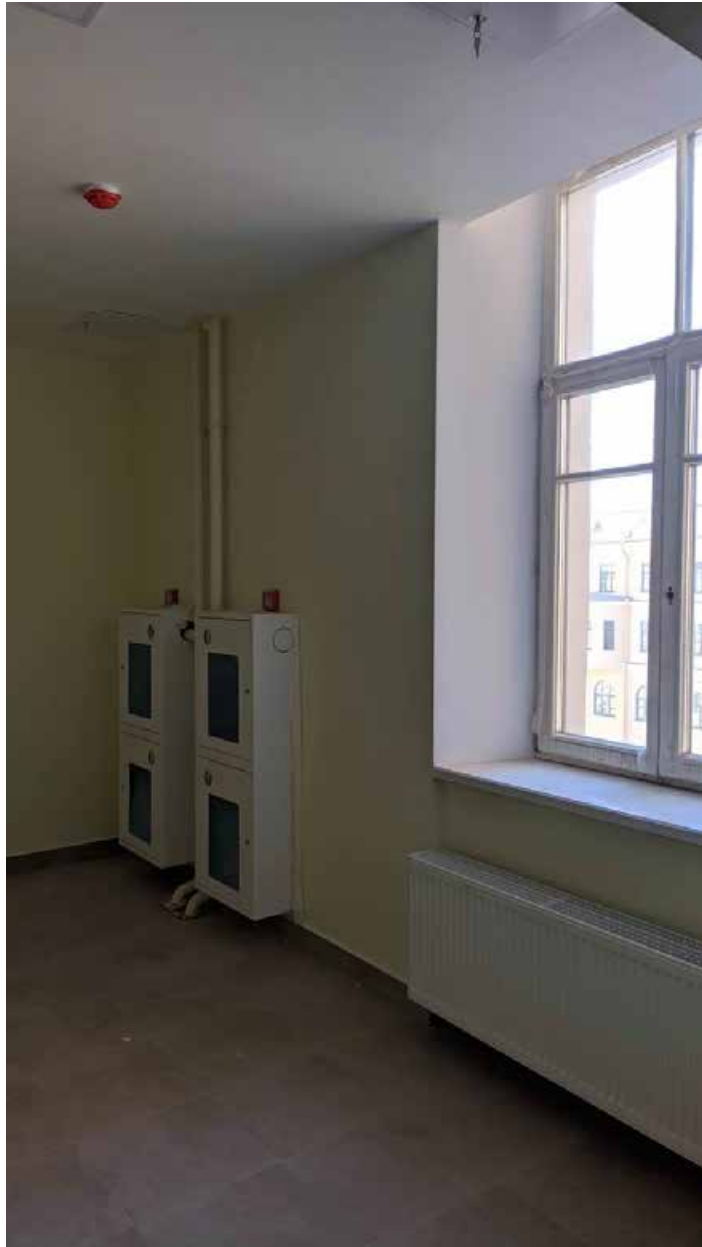
310. Вид в интерьере коридора зоны «Консерватория» в уровне 5-го этажа западного корпуса.
