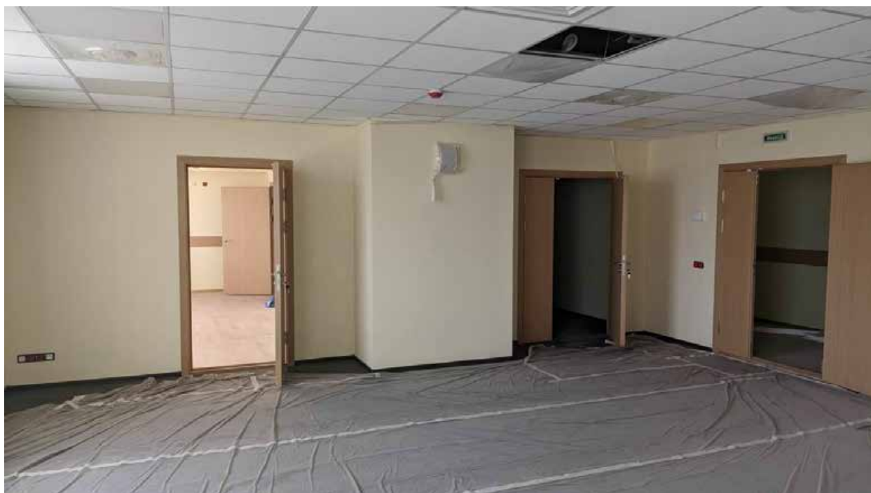
286. Вид в интерьере зоны «Консерватория» в уровне 5-го этажа южного корпуса.
