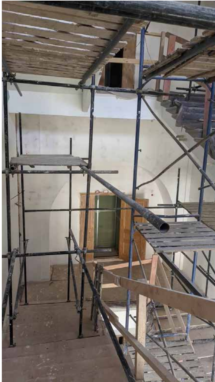
181. Вид на лестничную клетку зоны «Консерватория» в уровне 3-го этажа западного корпуса.
