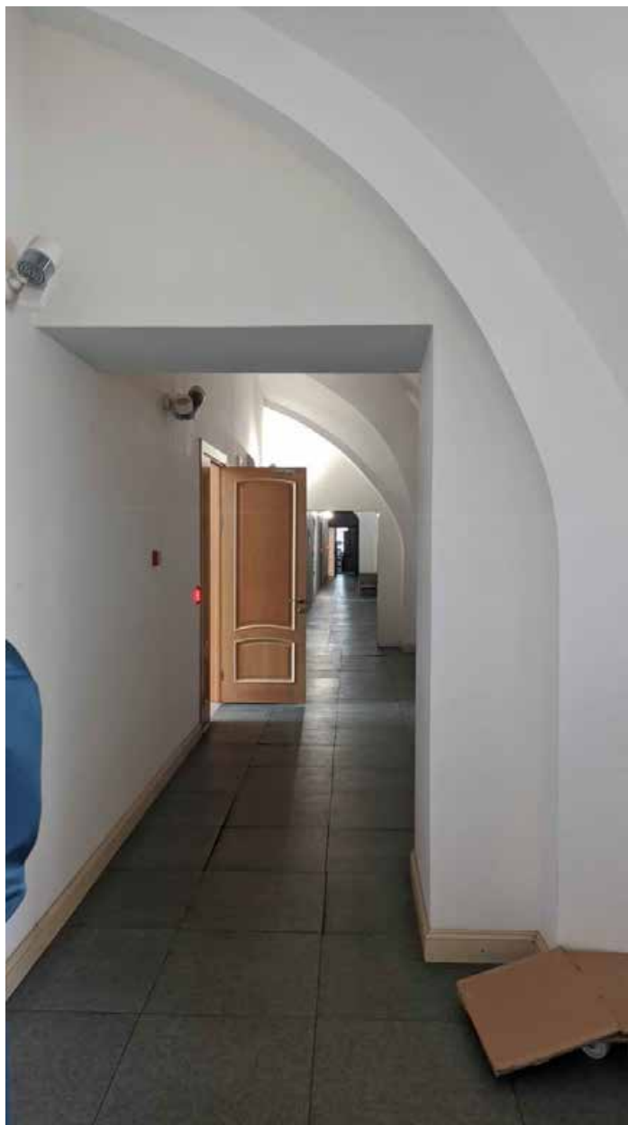
43. Вид в коридоре зоны «СЗД» в уровне 2-го этажа южного корпуса.
