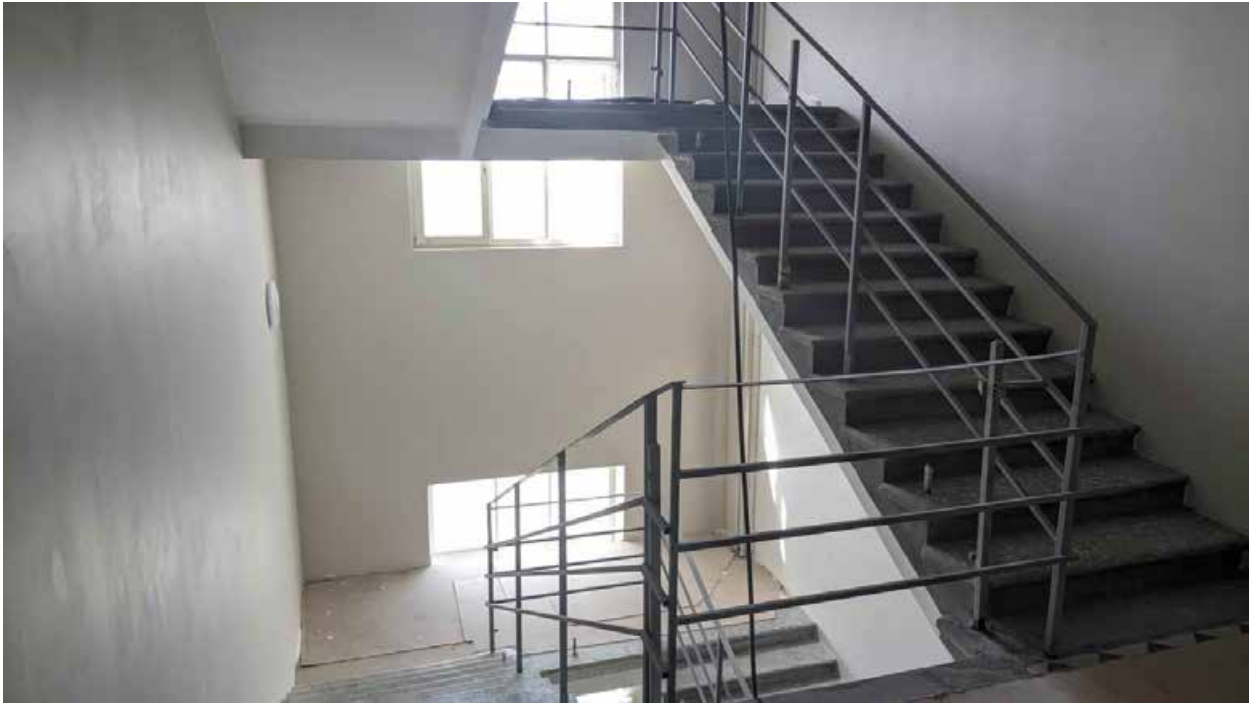
258.1. Вид в интерьере лестничной клетки зоны «Консерватория» в уровне 5-го этажа западного корпуса.
