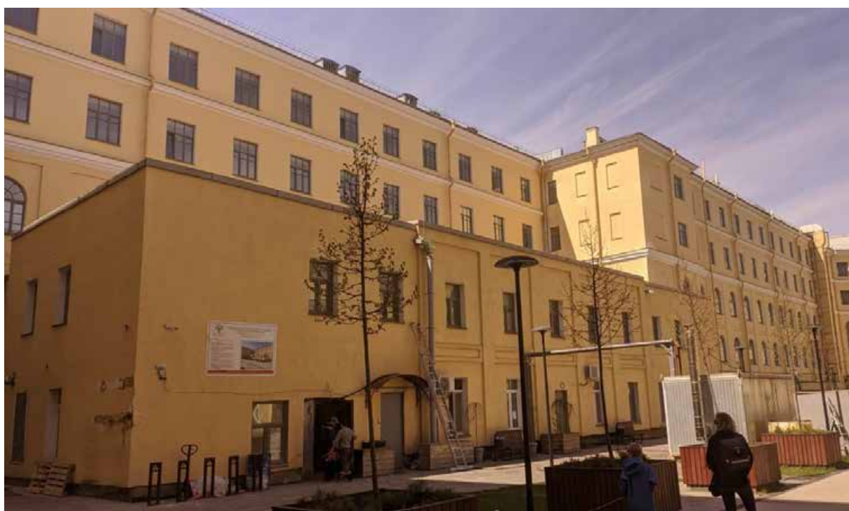
12. Вид на западный корпус со стороны внутреннего двора (дополнительная фотофиксация от 26.04.2022г.).
