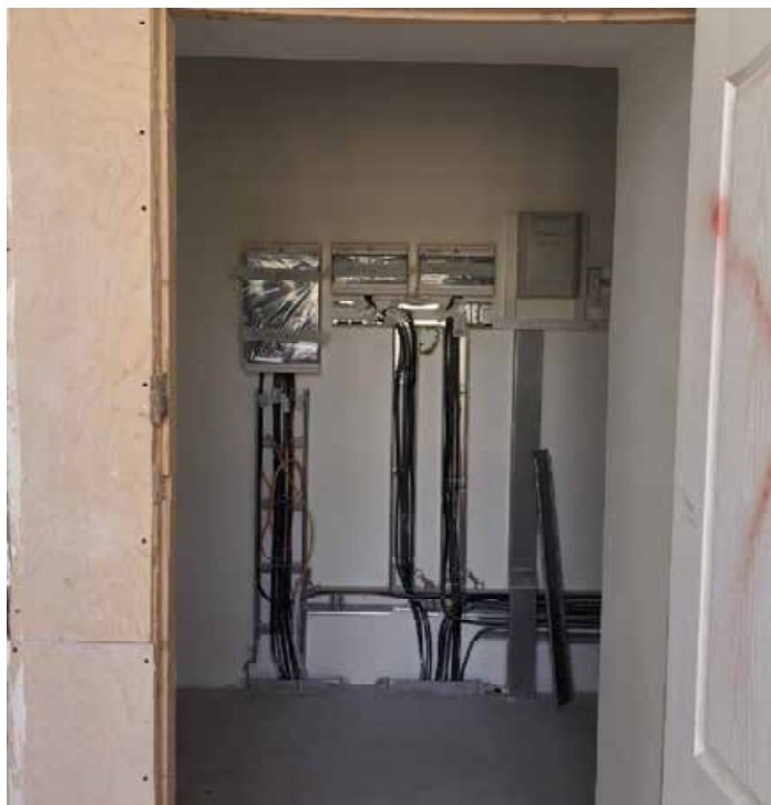
169. Вид в интерьере зоны «Консерватория» в уровне 3-го этажа западного корпуса.
