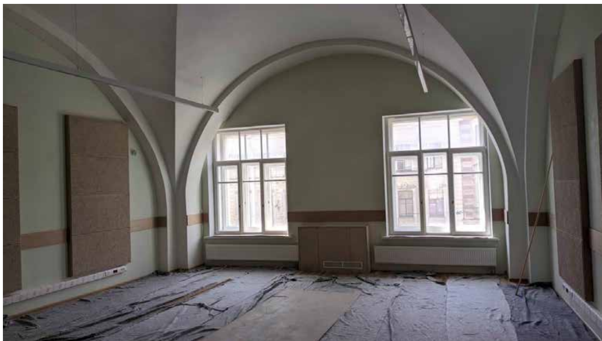
170. Вид в интерьере зоны «Консерватория» в уровне 3-го этажа западного корпуса.
