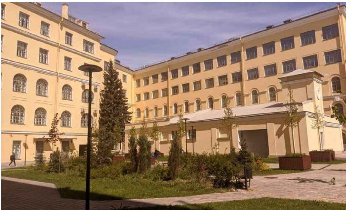
23. Вид на северный и восточный корпус со стороны внутреннего двора (дополнительная фотофиксация от 26.04.2022г.).
