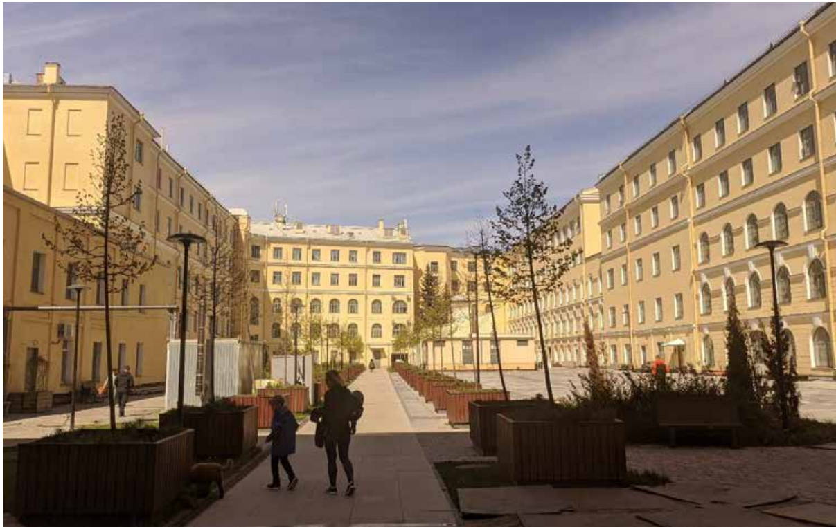
10. Вид на северный корпус со стороны внутреннего двора (дополнительная фотофиксация от 26.04.2022г.).
