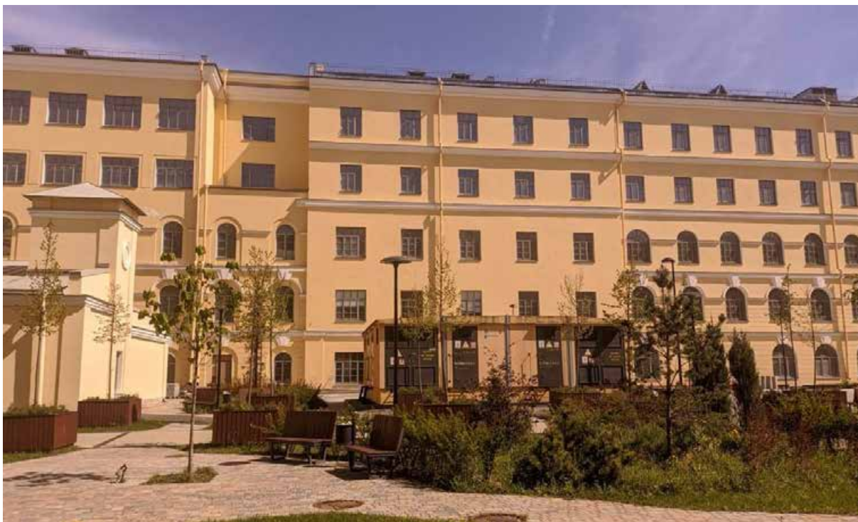
24. Вид на восточный корпус со стороны внутреннего двора (дополнительная фотофиксация от 26.04.2022г.).
