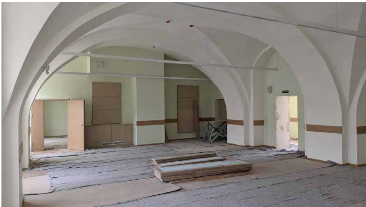
175. Вид в интерьере зоны «Консерватория» в уровне 3-го этажа западного корпуса.
