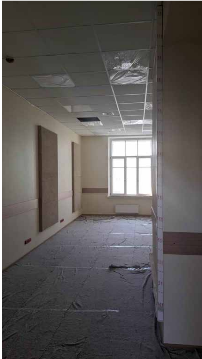
201. Вид в интерьере зоны «Консерватория» в уровне 4-го этажа западного корпуса.
