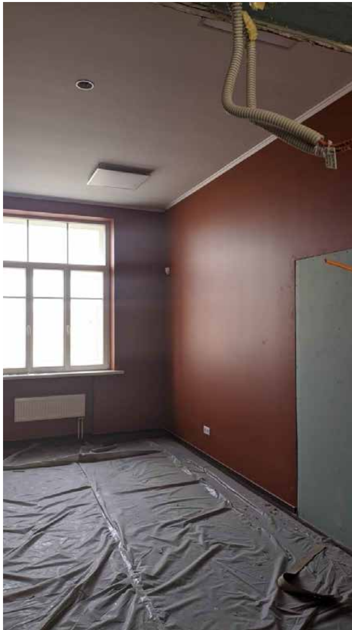
97. Вид в интерьере зоны «РВИО» в уровне 4-го этажа северного корпуса.
