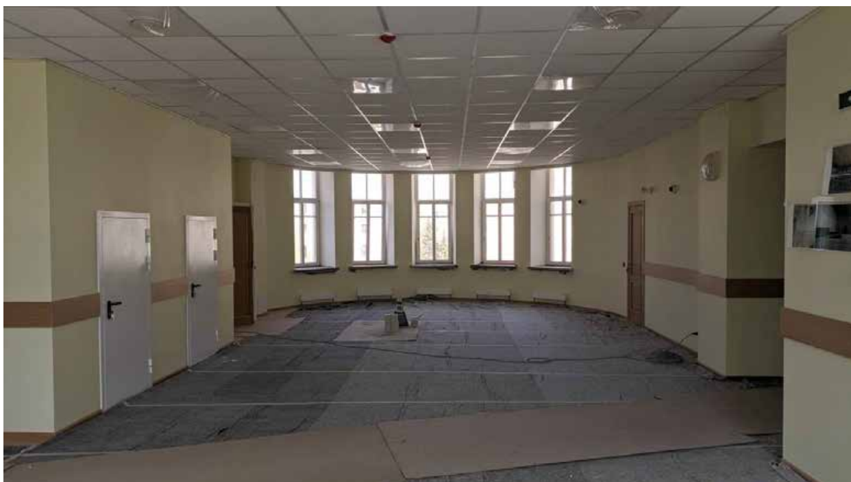
237. Вид в интерьере зоны «Консерватория» в уровне 4-го этажа южного корпуса.
