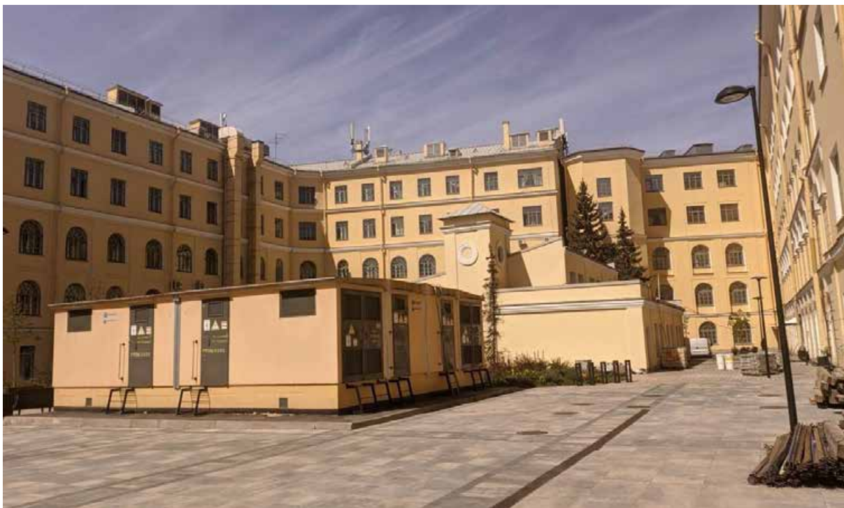
15. Вид на западный и северный корпус со стороны внутреннего двора (дополнительная фотофиксация от 26.04.2022г.).
