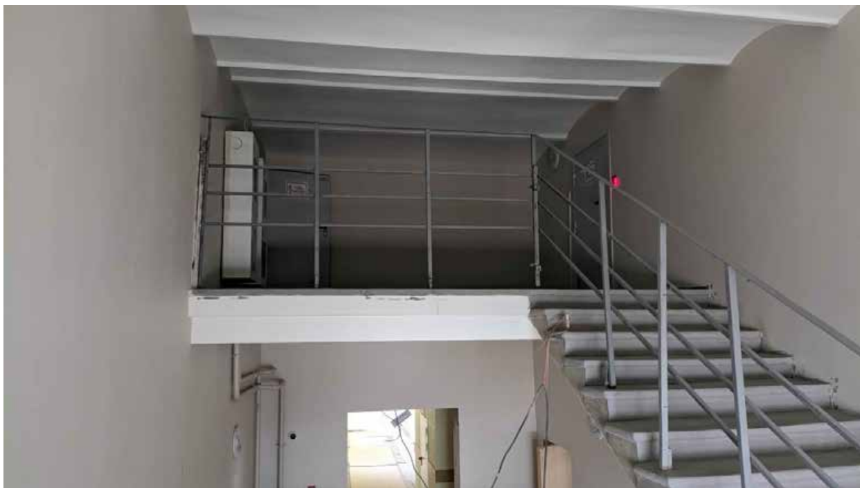
259.1. Вид в интерьере лестничной клетки зоны «Консерватория» в уровне 5-го этажа западного корпуса.
