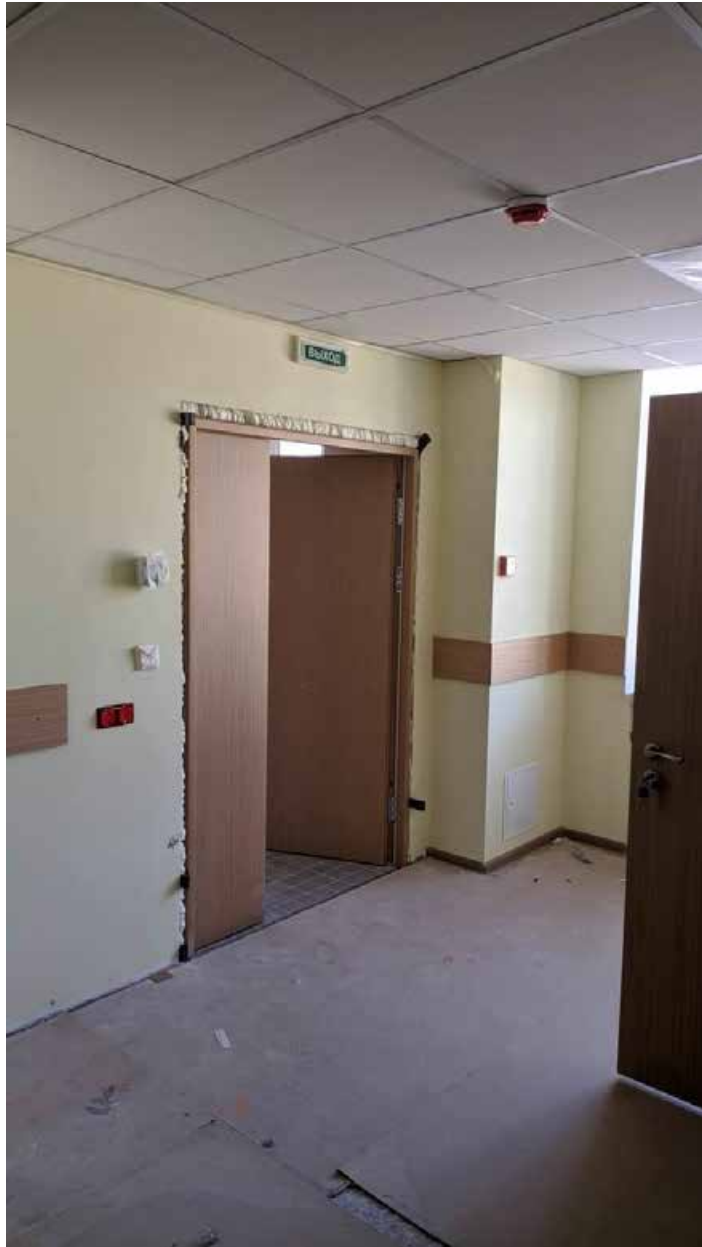
287. Вид в интерьере коридора зоны «Консерватория» в уровне 5-го этажа южного корпуса.
