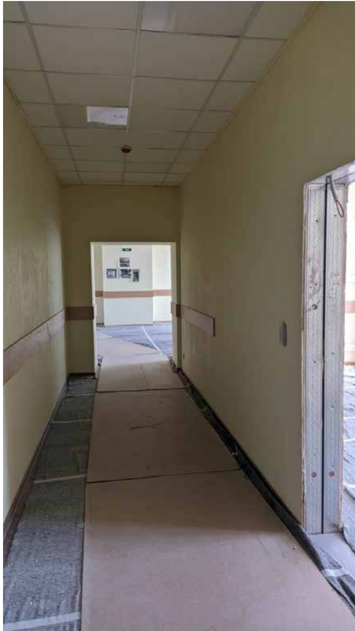
233. Вид в интерьере коридора зоны «Консерватория» в уровне 4-го этажа южного корпуса.
