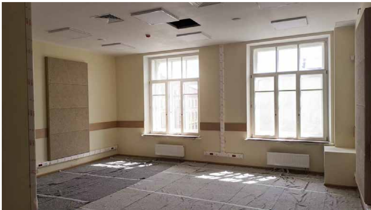
251. Вид в интерьере зоны «Консерватория» в уровне 4-го этажа южного корпуса.
