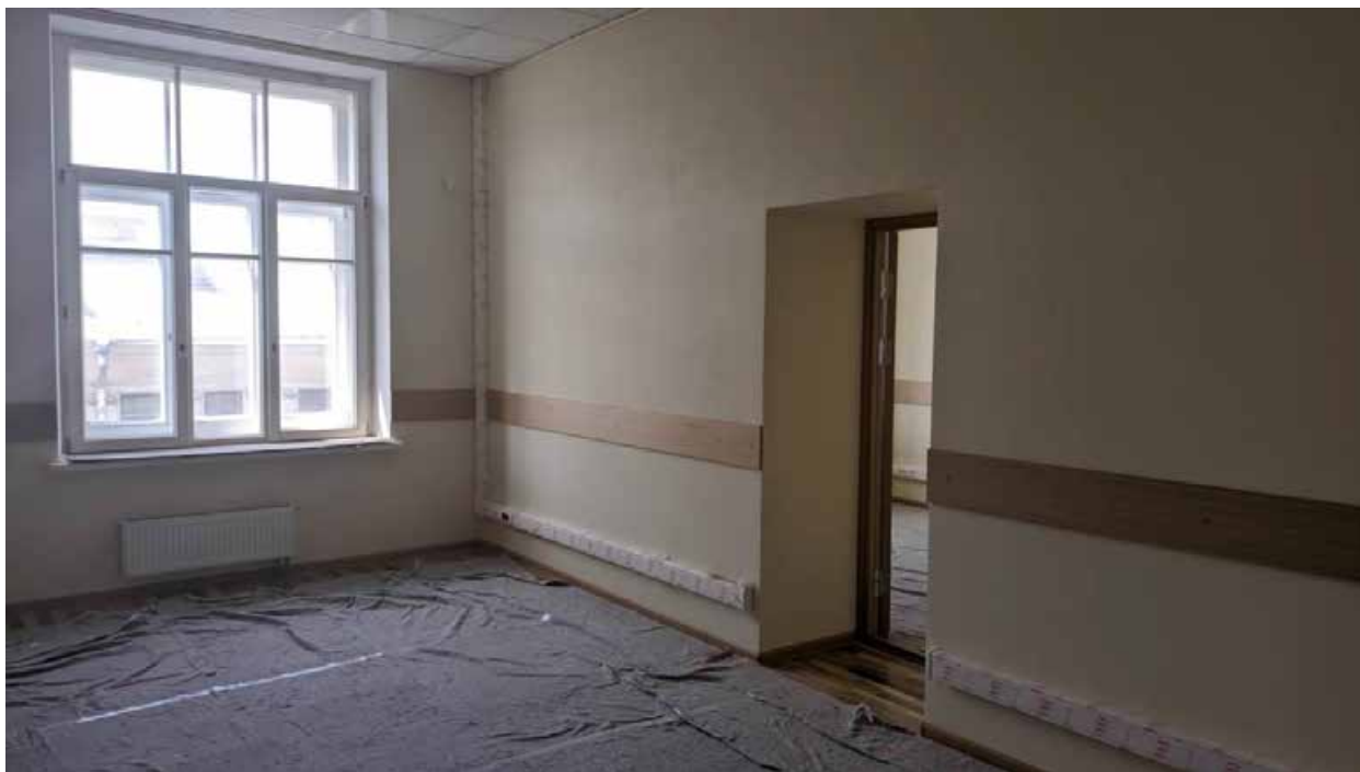
202. Вид в интерьере зоны «Консерватория» в уровне 4-го этажа западного корпуса.
