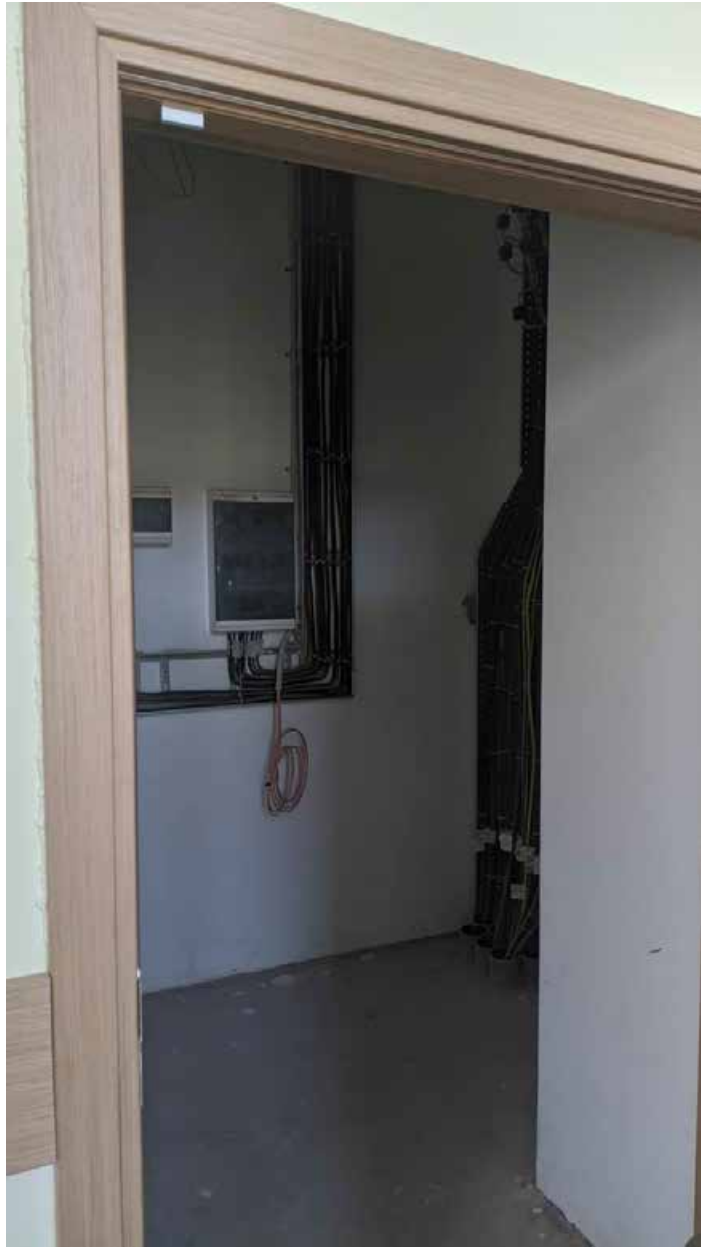
197. Вид в интерьере зоны «Консерватория» в уровне 4-го этажа западного корпуса.
