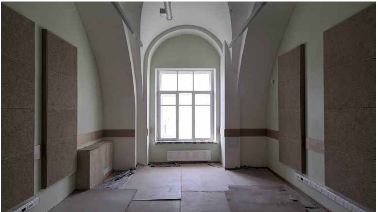
164. Вид в интерьере зоны «Консерватория» в уровне 3-го этажа западного корпуса.
