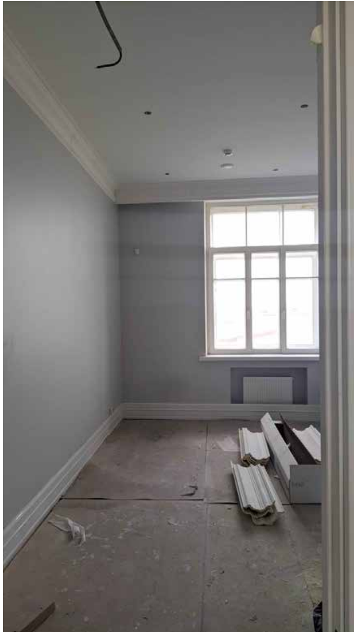
117. Вид в интерьере зоны «РВИО» в уровне 5-го этажа северного корпуса.
