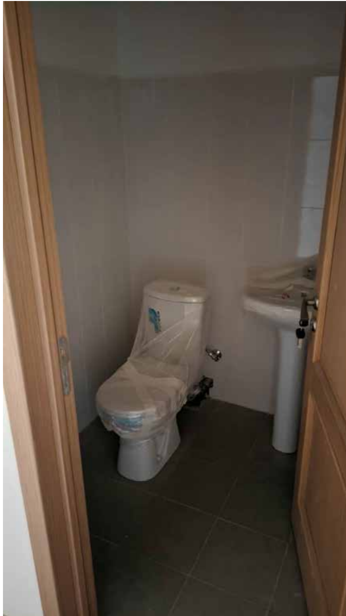
311. Вид в интерьере санузла зоны «Консерватория» в уровне 5-го этажа западного корпуса.
