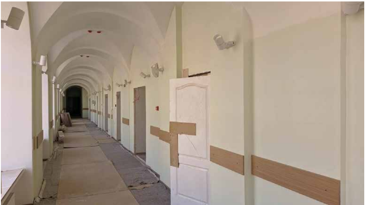
172. Вид в интерьере коридора зоны «Консерватория» в уровне 3-го этажа западного корпуса.
