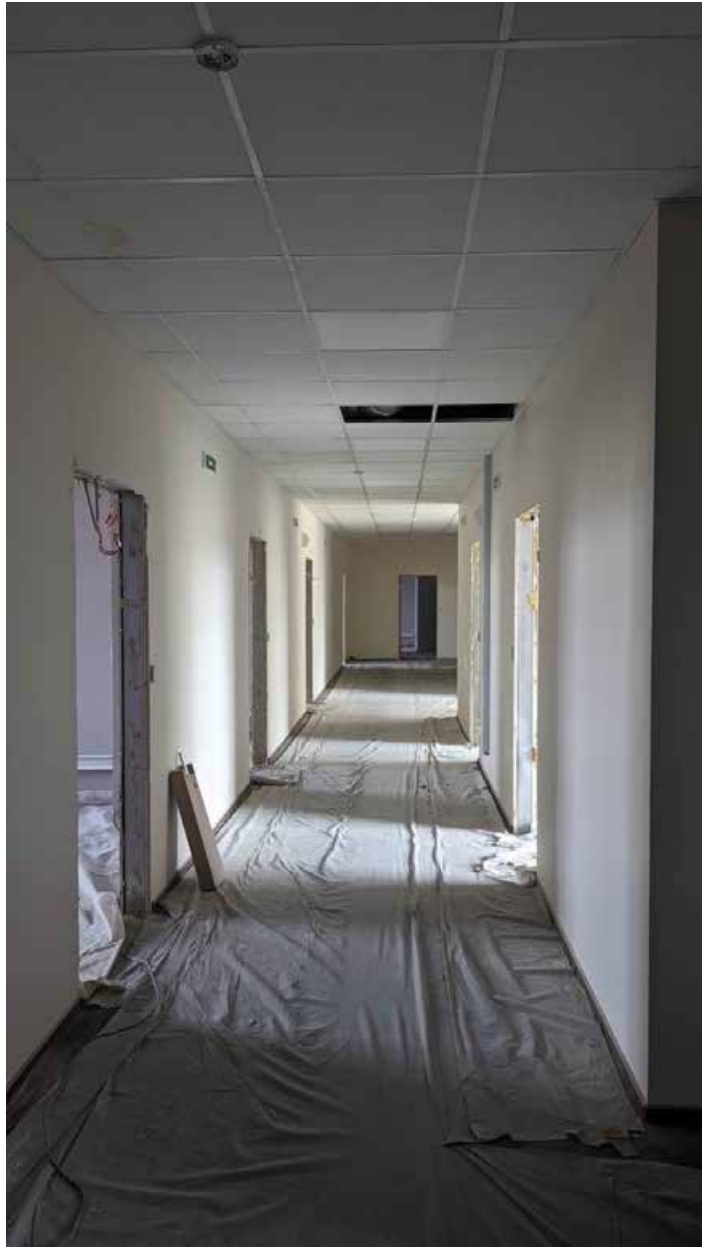
90. Вид в коридор зоны «РВИО» в уровне 4-го этажа северного корпуса.
