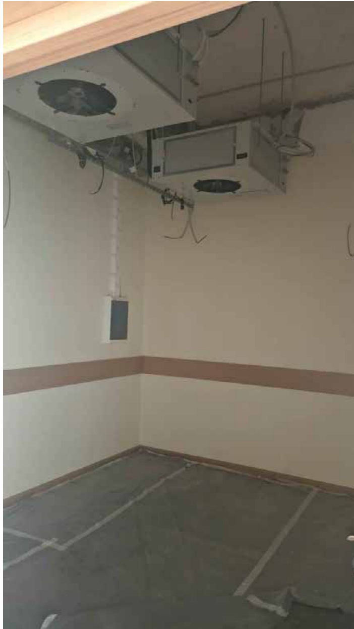
253. Вид в интерьере зоны «Консерватория» в уровне 4-го этажа южного корпуса.
