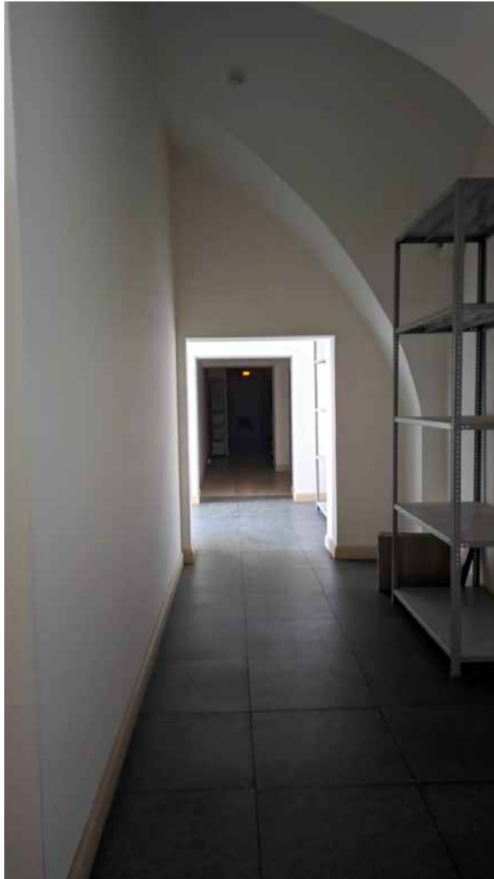
67. Вид в интерьере коридора зоны «СЗД» в уровне 3-го этажа восточного корпуса.
