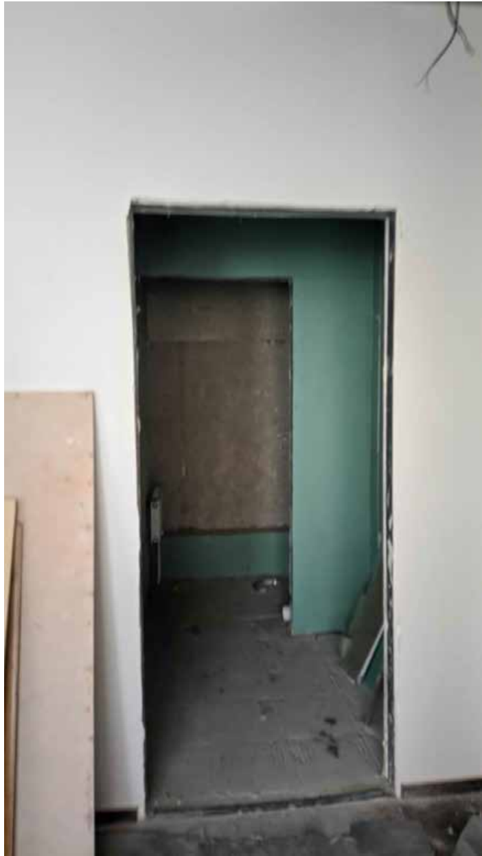
106. Вид в интерьере зоны «РВИО» в уровне 4-го этажа северного корпуса.
