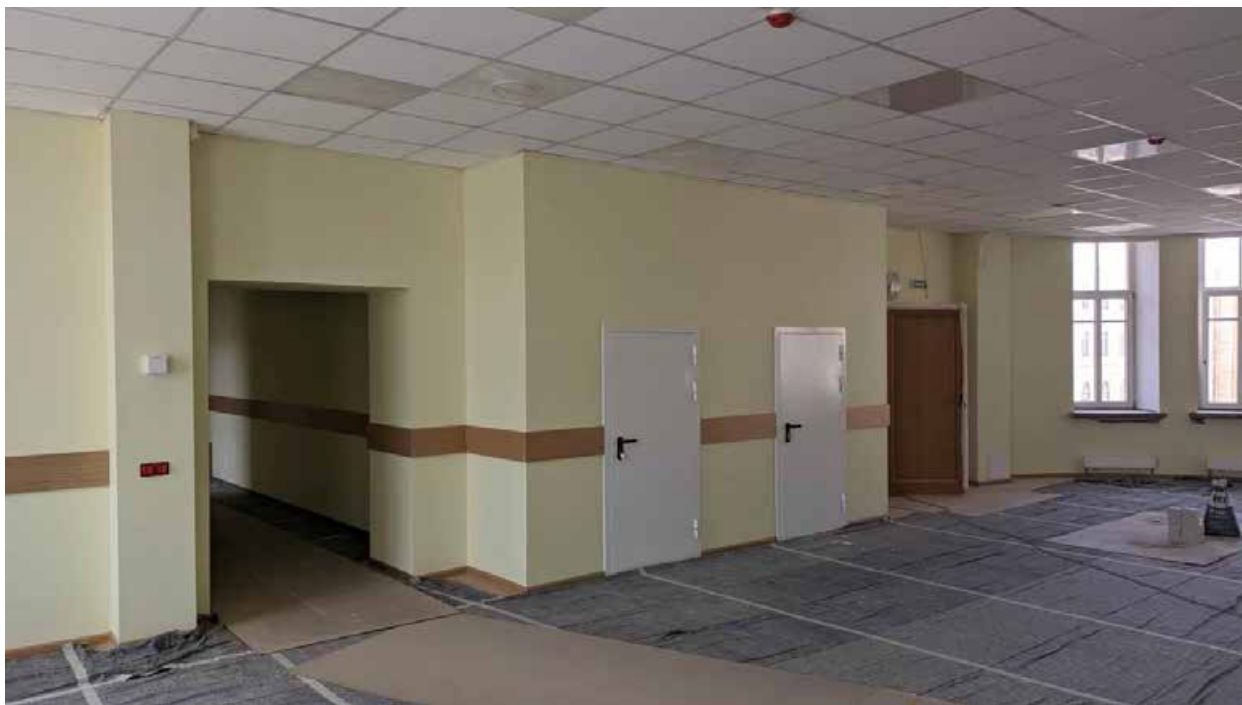
238. Вид в интерьере зоны «Консерватория» в уровне 4-го этажа южного корпуса.
