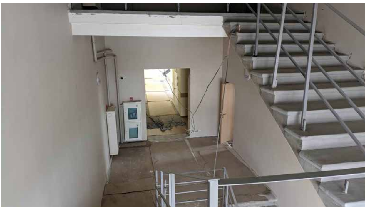
259.2. Вид в интерьере лестничной клетки зоны «Консерватория» в уровне 5-го этажа западного корпуса.
