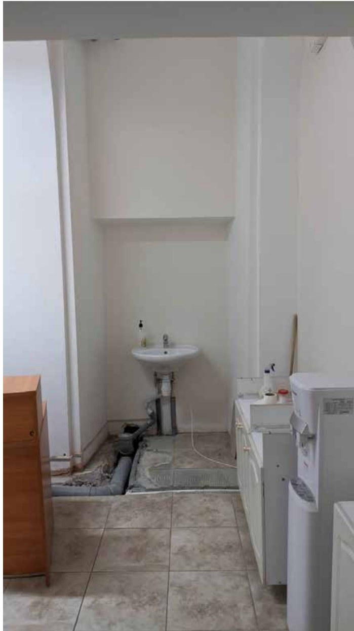
51. Вид в интерьере зоны «СЗД» в уровне 2-го этажа южного корпуса.
