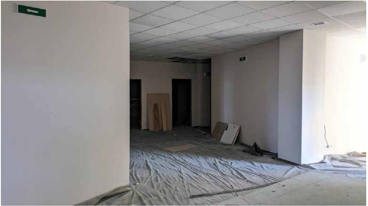
100. Вид в интерьере коридора зоны «РВИО» в уровне 4-го этажа северного корпуса.
