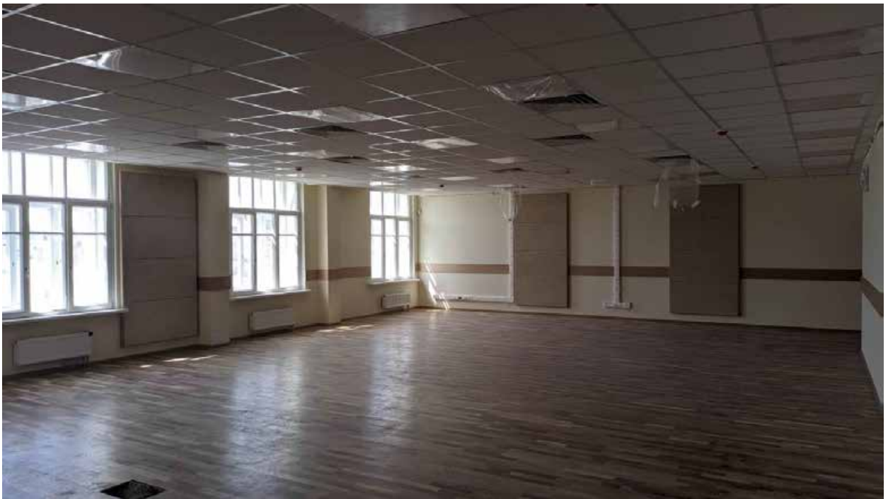
303. Вид в интерьере зоны «Консерватория» в уровне 5-го этажа западного корпуса.
