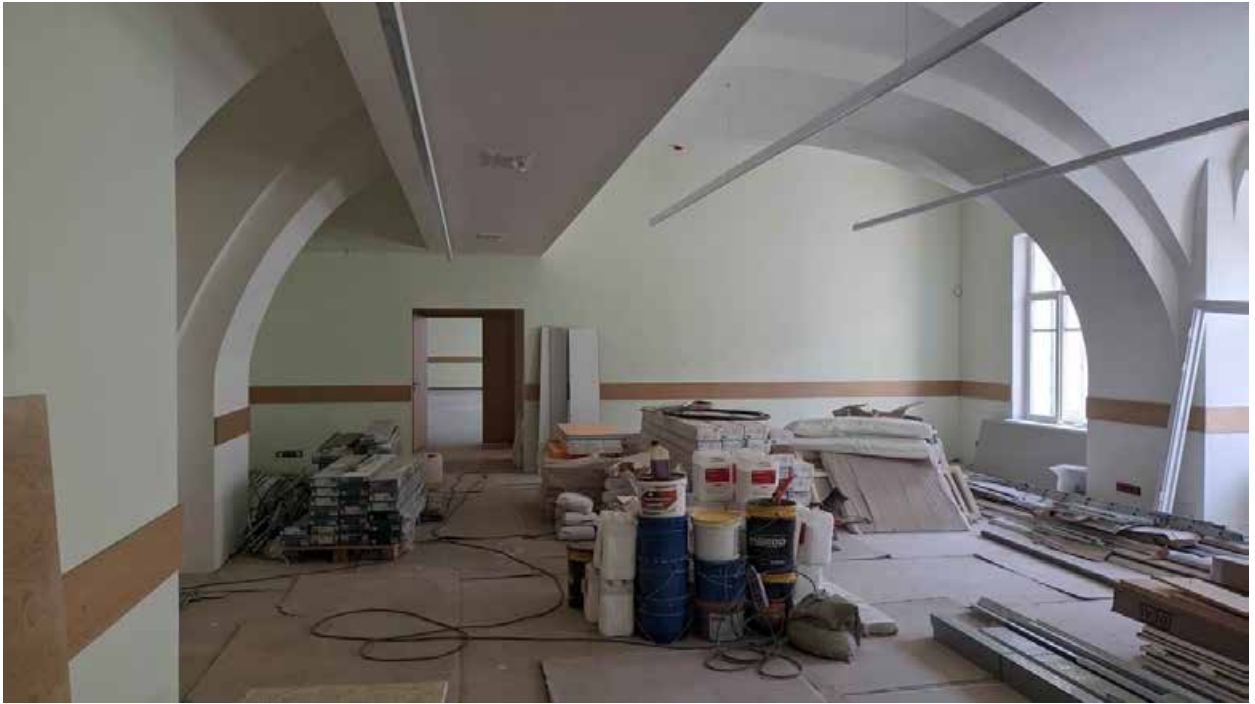
149. Вид в интерьере зоны «Консерватория» в уровне 2-го этажа западного корпуса.
