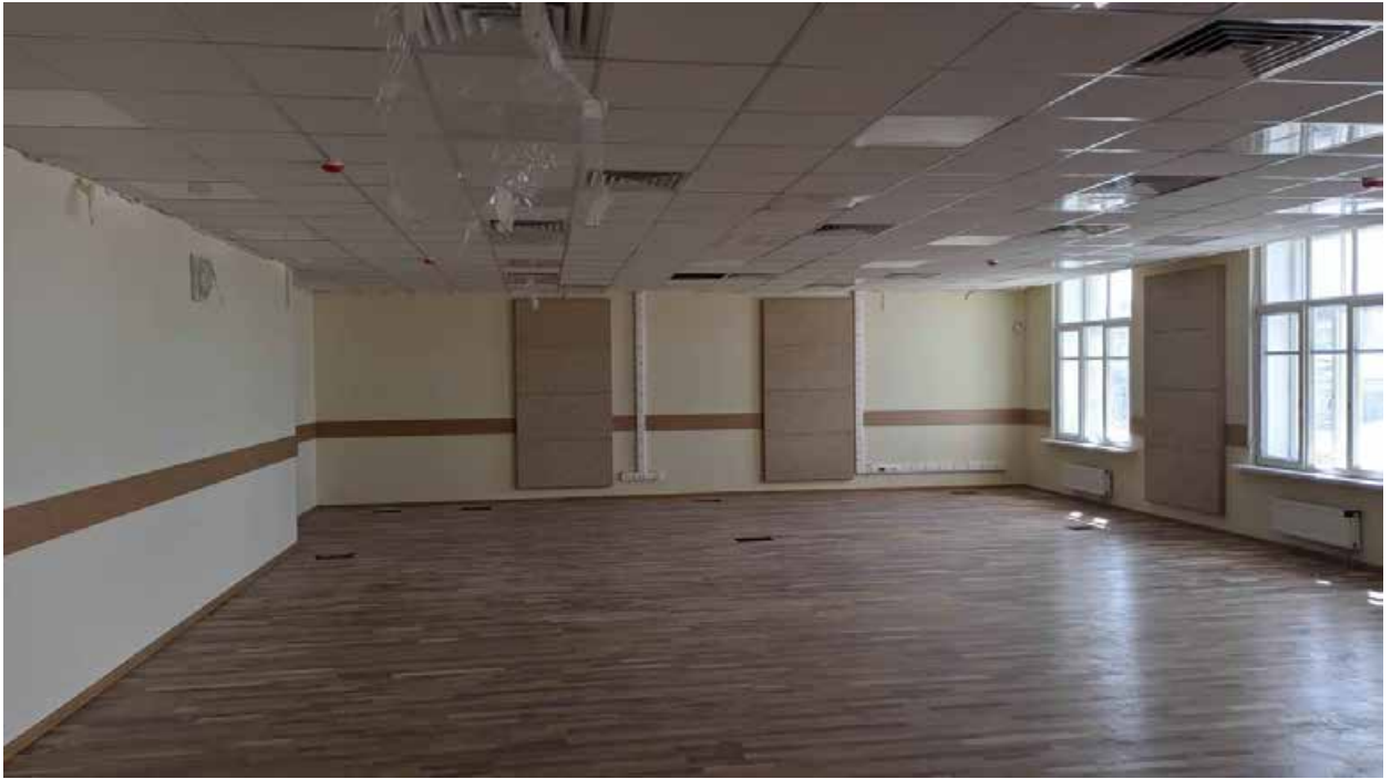
304. Вид в интерьере зоны «Консерватория» в уровне 5-го этажа западного корпуса.
