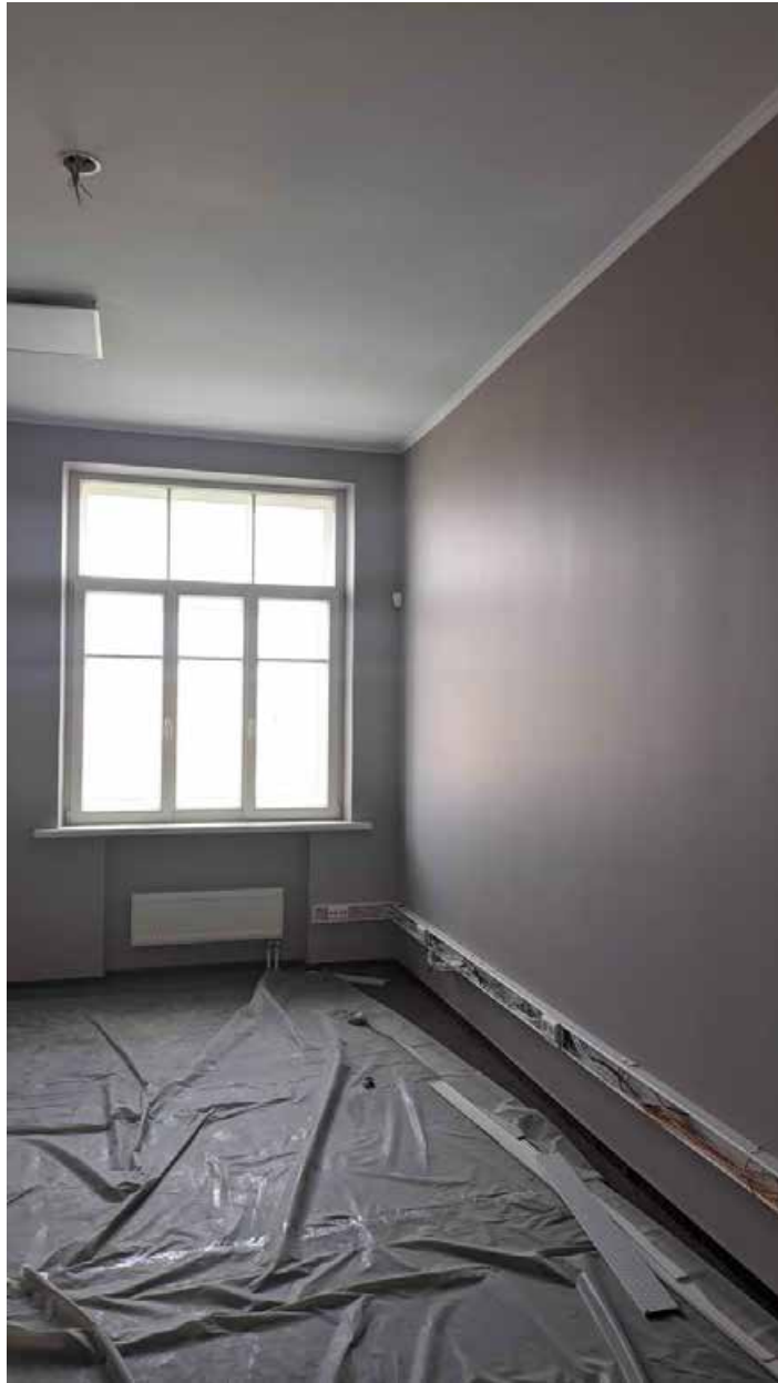
101. Вид в интерьере зоны «РВИО» в уровне 4-го этажа северного корпуса.
