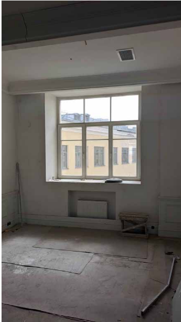
111. Вид в интерьере зоны «РВИО» в уровне 5-го этажа северного корпуса.
