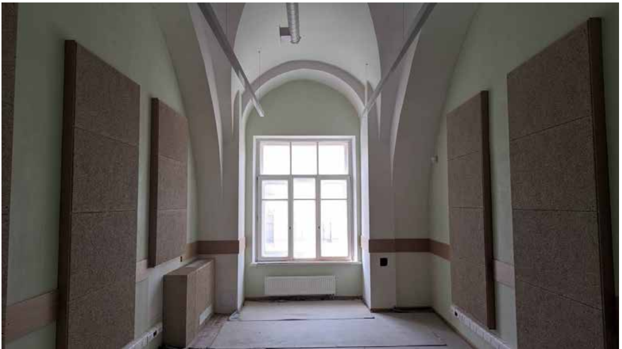
168. Вид в интерьере зоны «Консерватория» в уровне 3-го этажа западного корпуса.
