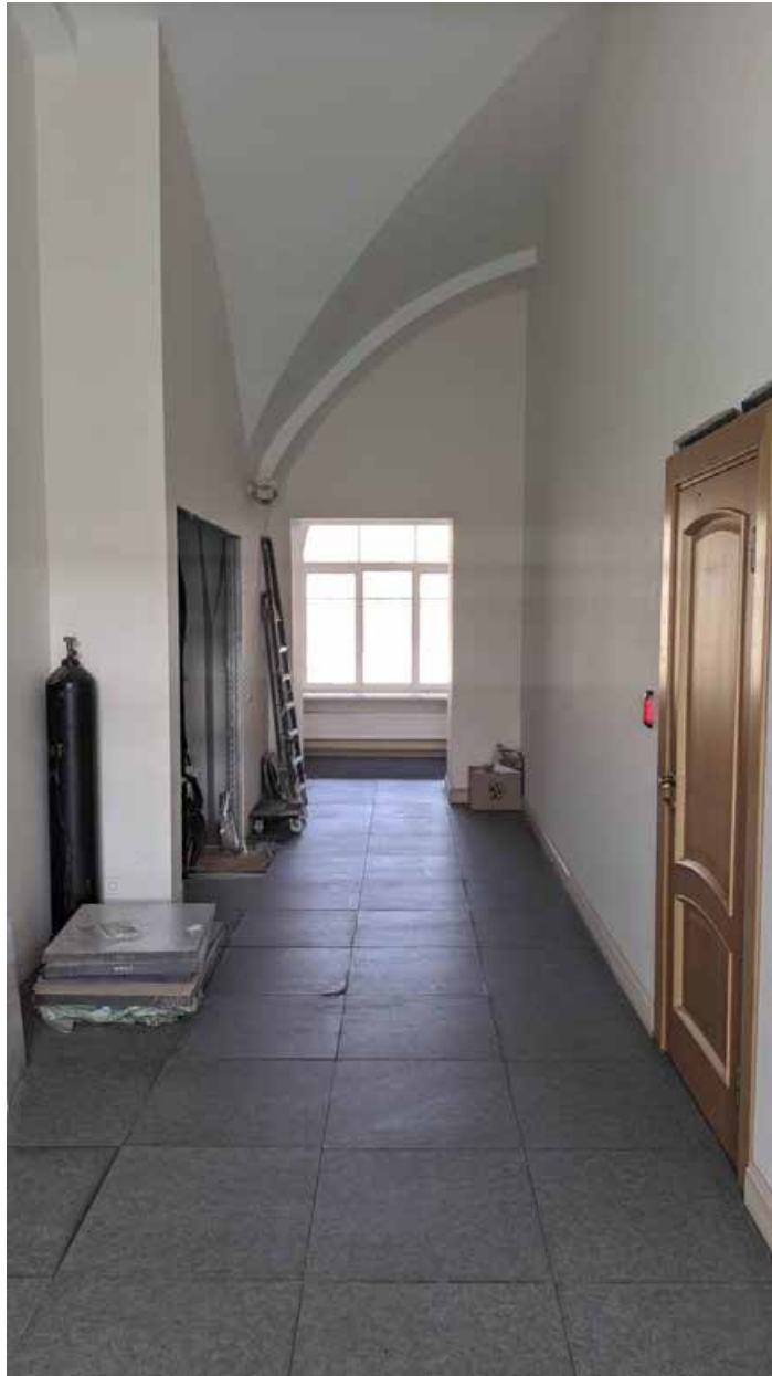
63. Вид в интерьере коридора зоны «СЗД» в уровне 3-го этажа южного корпуса.
