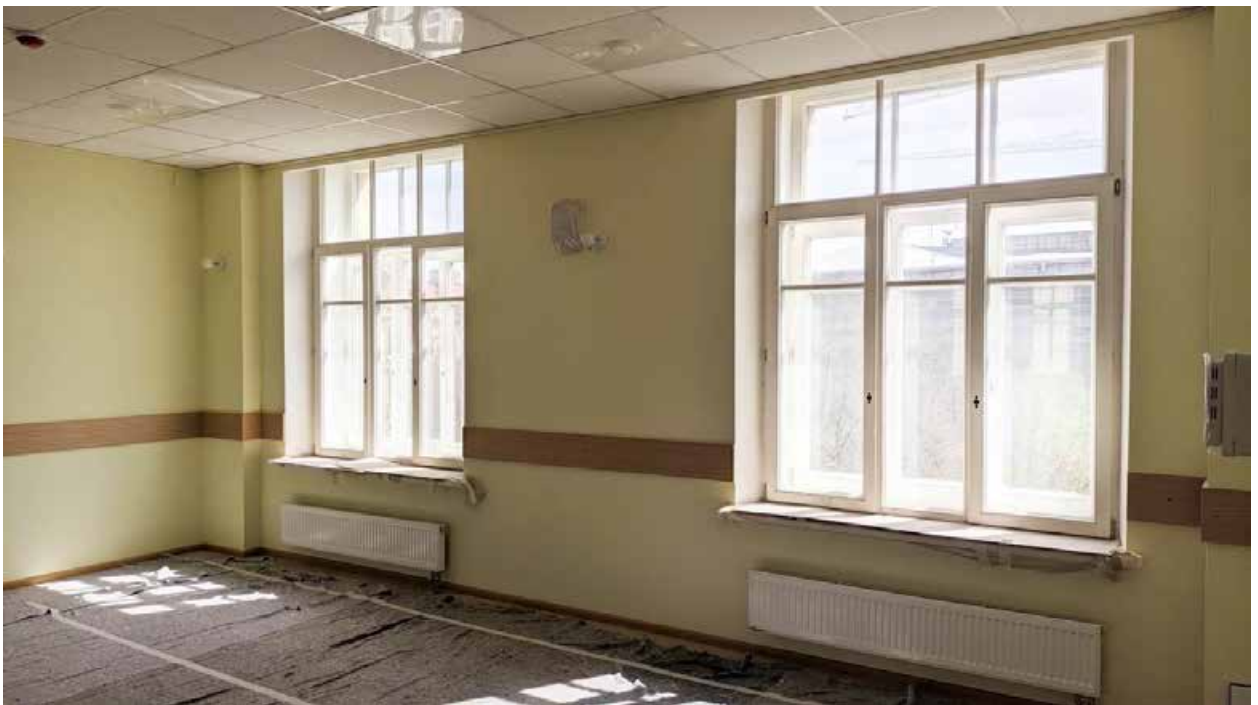
235. Вид в интерьере зоны «Консерватория» в уровне 4-го этажа южного корпуса.
