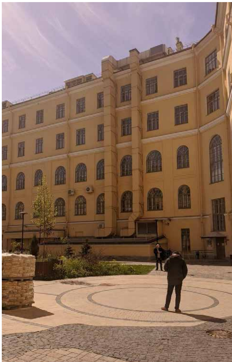
20. Вид на западный корпус со стороны внутреннего двора (дополнительная фотофиксация от 26.04.2022г.).
