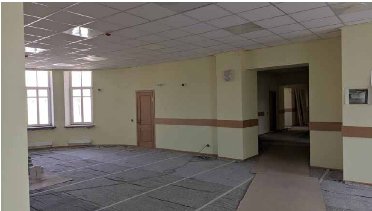
236. Вид в интерьере зоны «Консерватория» в уровне 4-го этажа южного корпуса.
