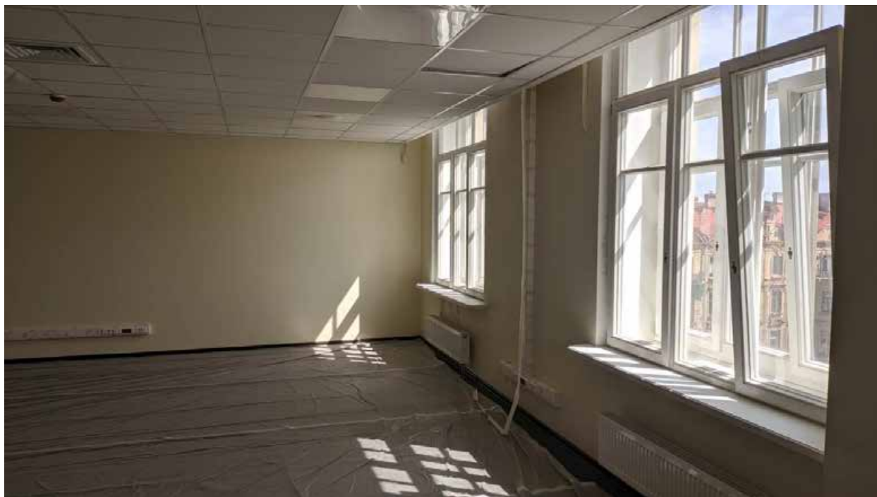
285. Вид в интерьере зоны «Консерватория» в уровне 5-го этажа южного корпуса.
