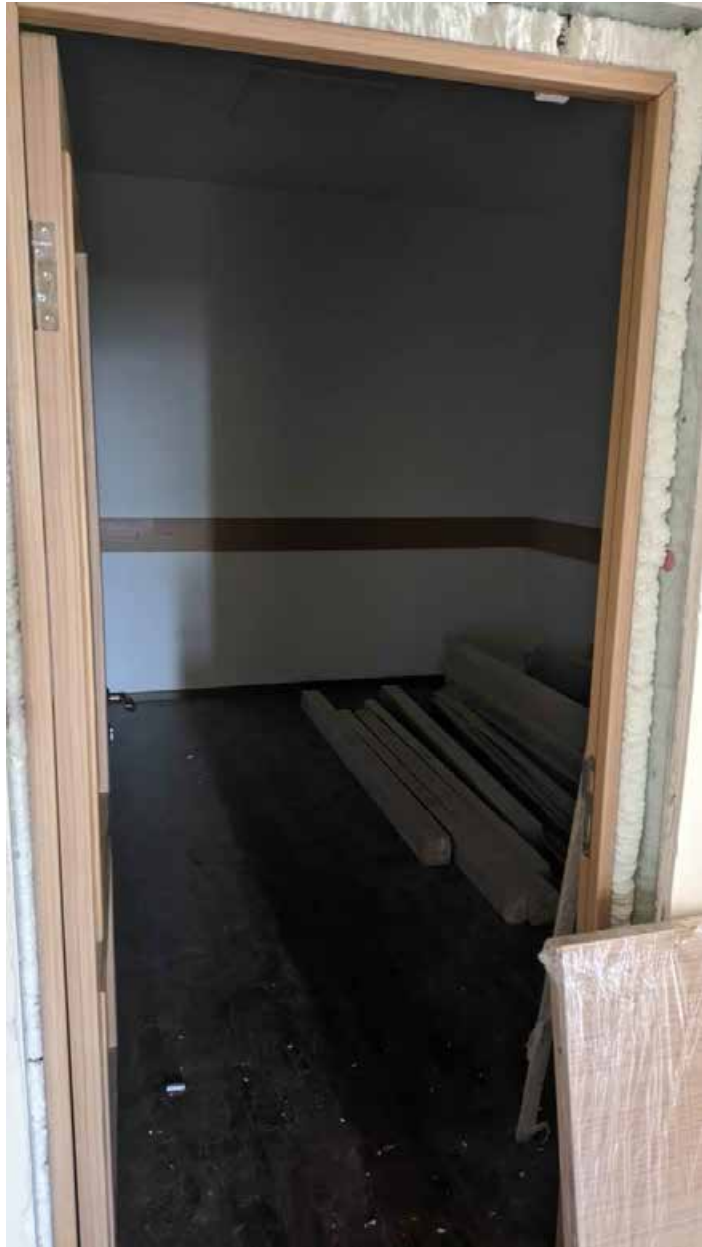
213. Вид в интерьере зоны «Консерватория» в уровне 4-го этажа западного корпуса.
