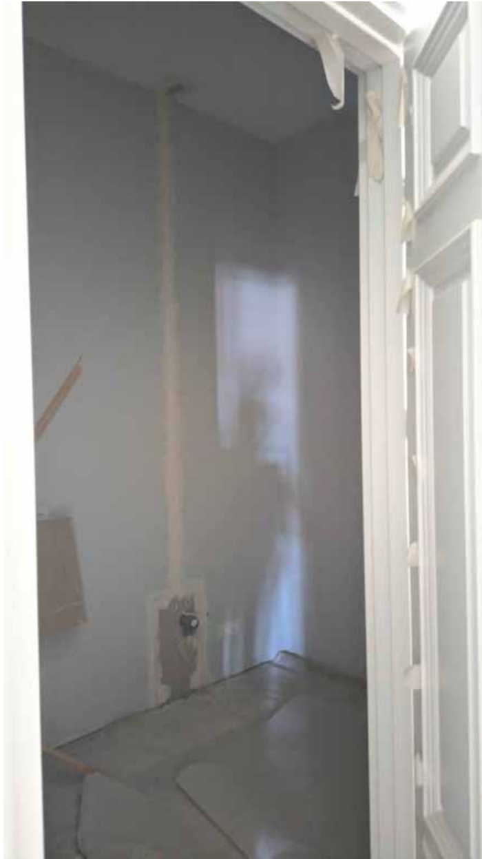
128. Вид в интерьере зоны «РВИО» в уровне 5-го этажа северного корпуса.
