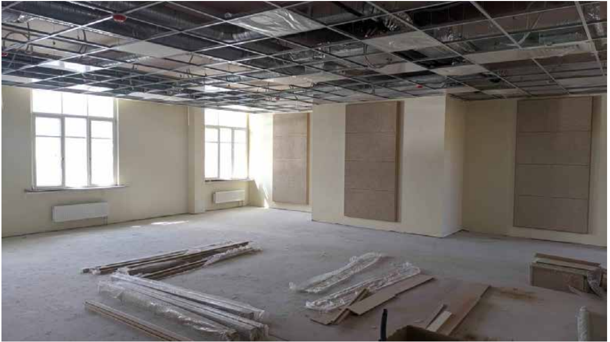
306. Вид в интерьере зоны «Консерватория» в уровне 5-го этажа западного корпуса.
