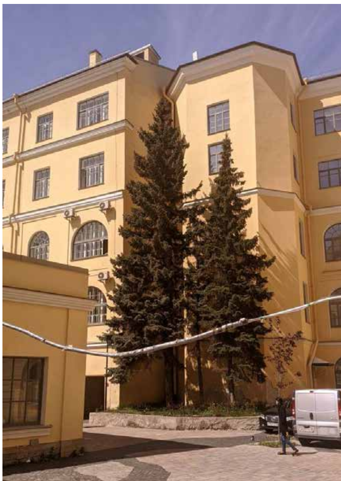
18. Вид на северный корпус со стороны внутреннего двора (дополнительная фотофиксация от 26.04.2022г.).
