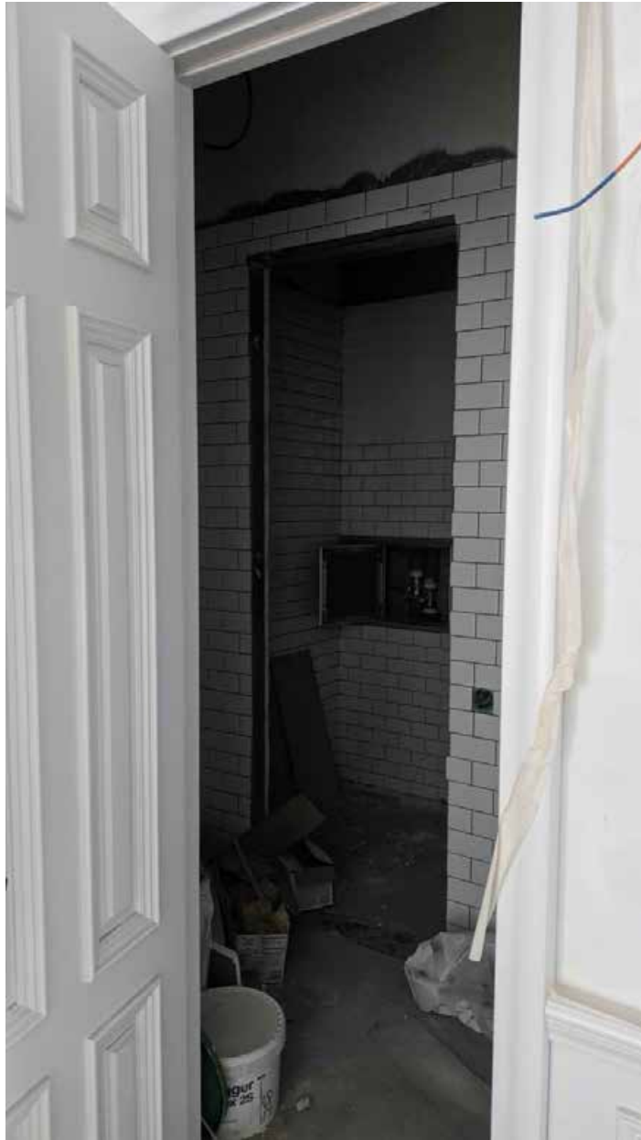
113. Вид в интерьере зоны «РВИО» в уровне 5-го этажа северного корпуса.
