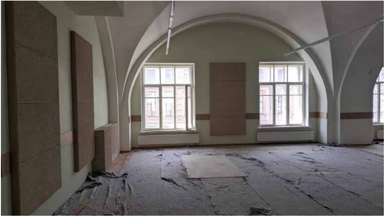
173. Вид в интерьере зоны «Консерватория» в уровне 3-го этажа западного корпуса.
