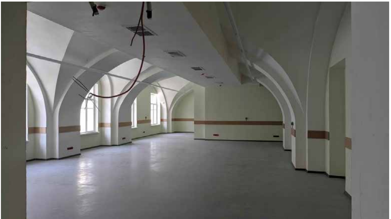
148. Вид в интерьере зоны «Консерватория» в уровне 2-го этажа западного корпуса.
