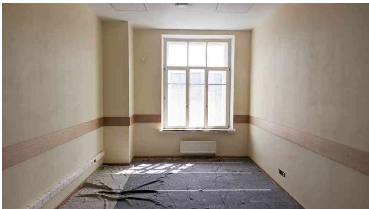
250. Вид в интерьере зоны «Консерватория» в уровне 4-го этажа южного корпуса.
