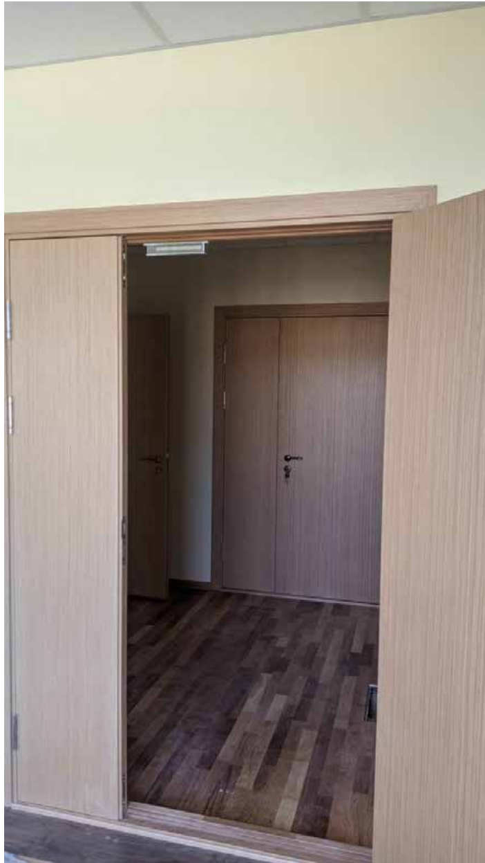
297. Вид в интерьере зоны «Консерватория» в уровне 5-го этажа западного корпуса.
