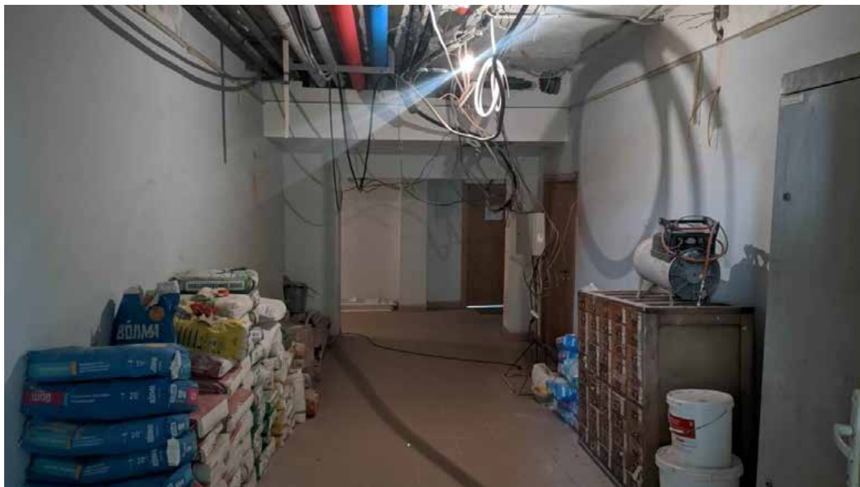
152. Вид в интерьере зоны «Консерватория» в уровне 2-го этажа западного корпуса.
