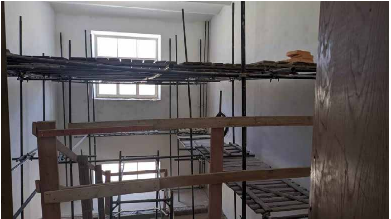
316. Вид в интерьере лестничной клетки зоны «Консерватория» в уровне 5-го этажа западного корпуса.
