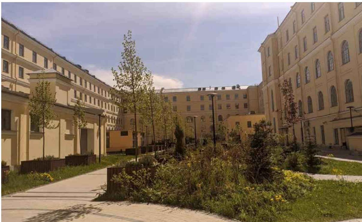
22. Вид на южный корпус со стороны внутреннего двора (дополнительная фотофиксация от 26.04.2022г.).
