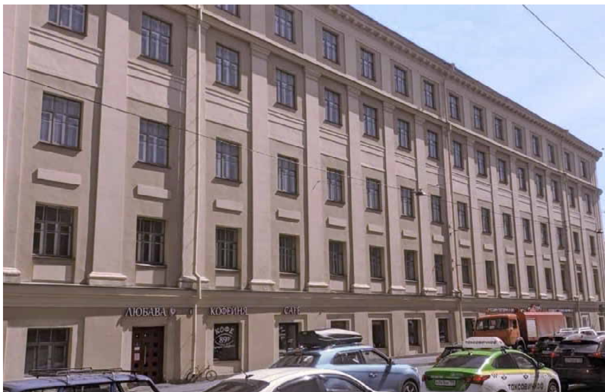
3. Вид на лицевой фасад западного корпуса со стороны улицы Глинки.
