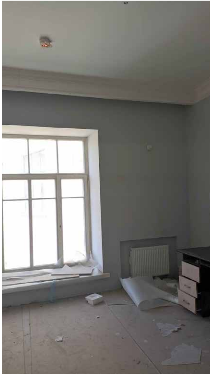
129. Вид в интерьере зоны «РВИО» в уровне 5-го этажа северного корпуса.
