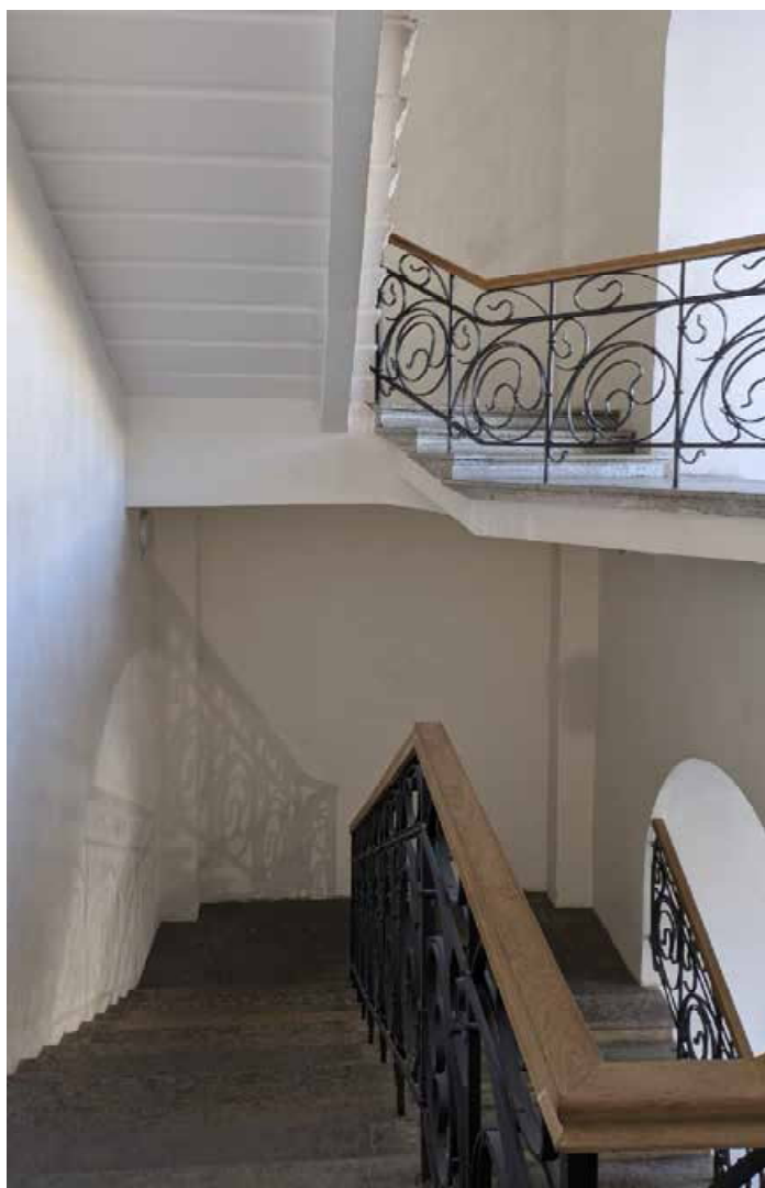
36. Виды в интерьере парадной лестницы зоны «СЗД» в уровне 2-го этажа южного корпуса.
