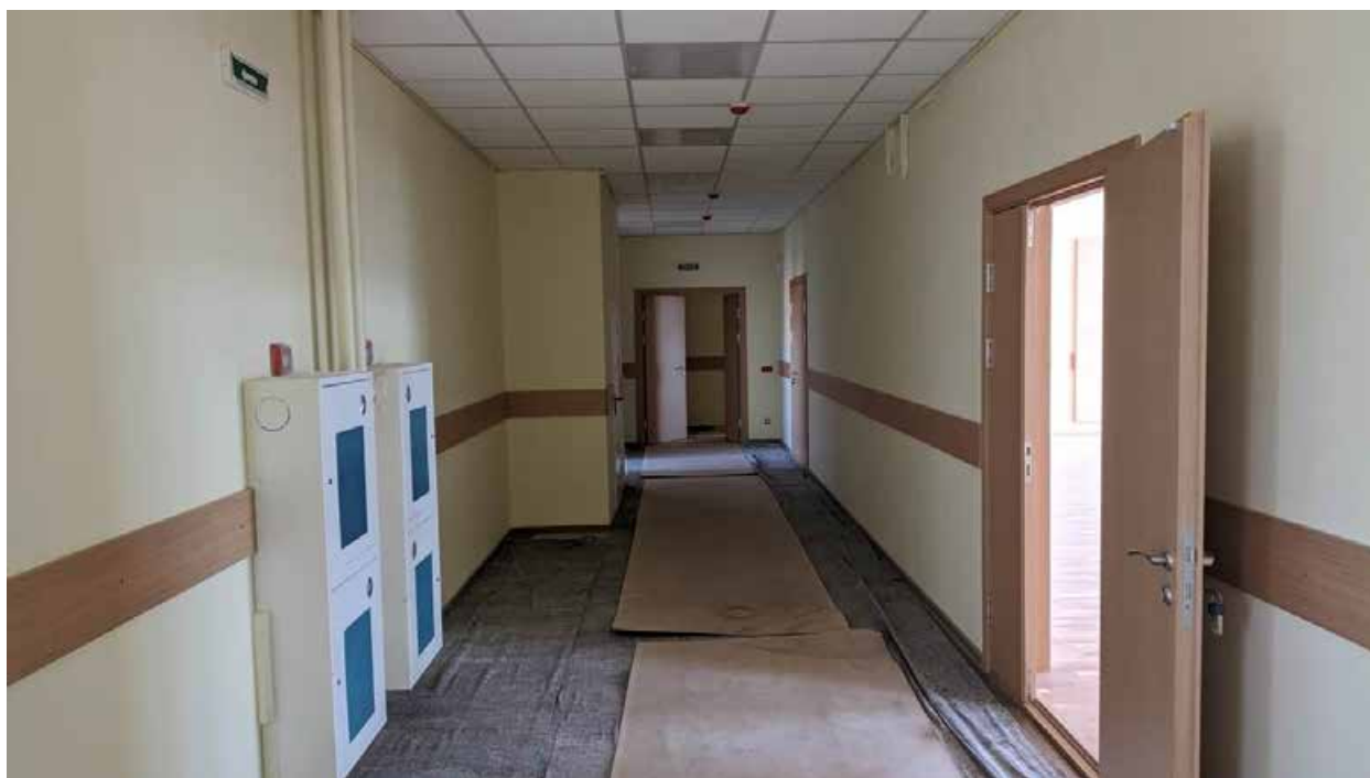
274. Вид в интерьере коридора зоны «Консерватория» в уровне 5-го этажа южного корпуса.
