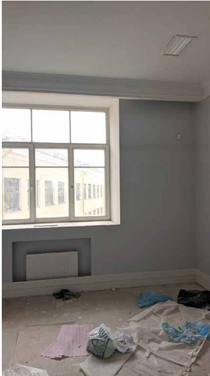
119. Вид в интерьере зоны «РВИО» в уровне 5-го этажа северного корпуса.
