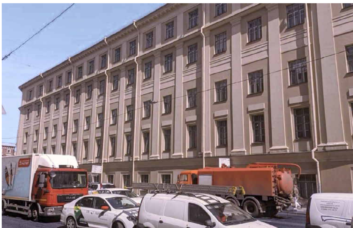
4. Вид на лицевой фасад западного корпуса со стороны улицы Глинки.
