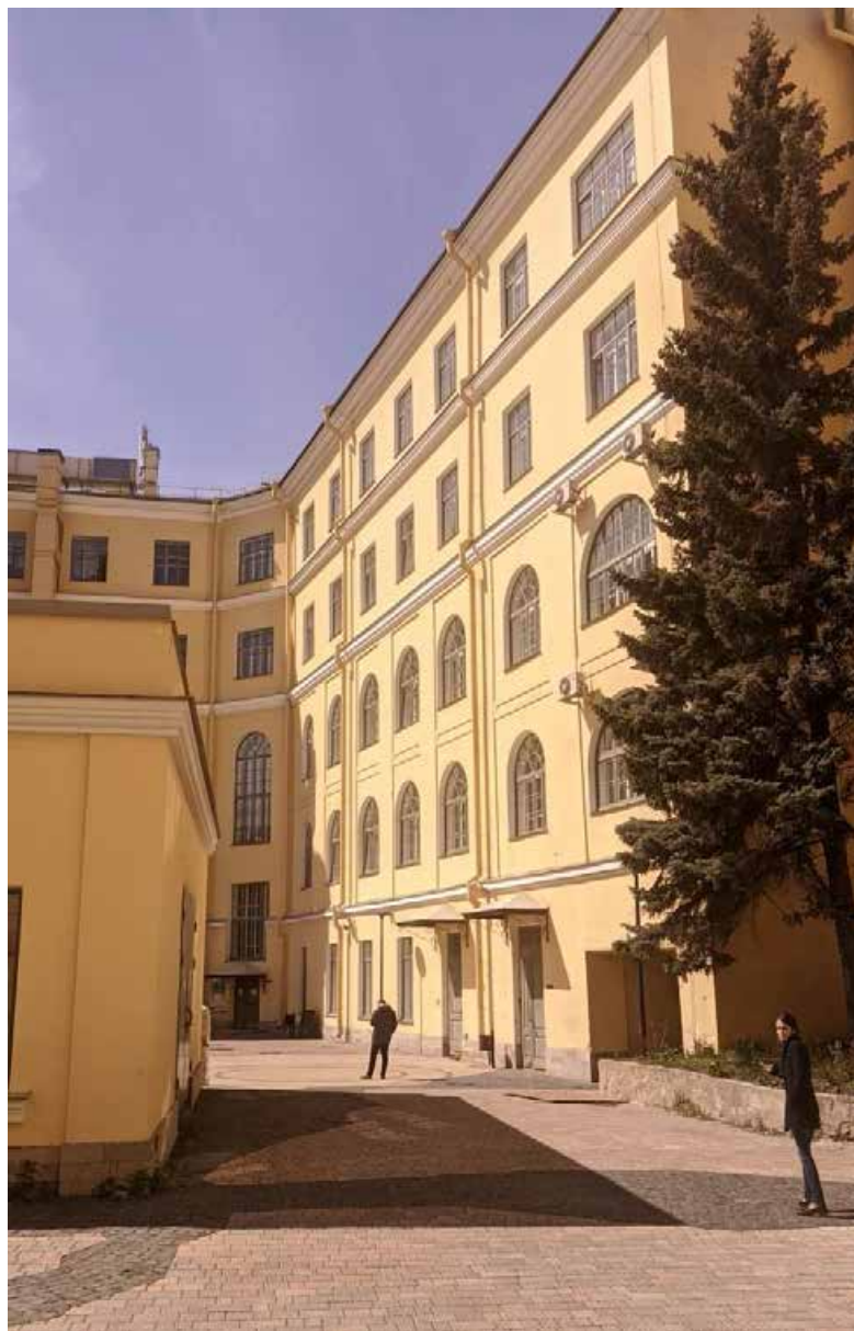
19. Вид на угол северного и западного корпусов со стороны внутреннего двора (дополнительная фотофиксация от 26.04.2022г.).
