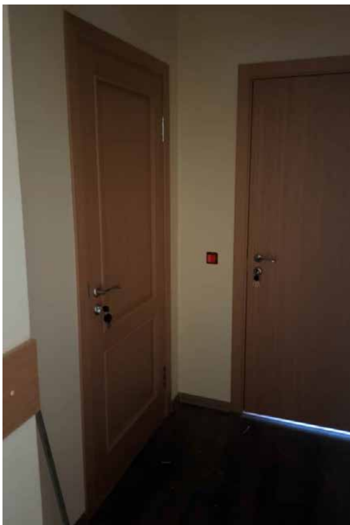
188. Вид в коридоре зоны «Консерватория» в уровне 4-го этажа западного корпуса.
