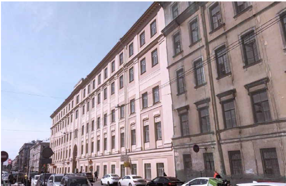
9. Вид на лицевой фасад южного корпуса со стороны улицы Декабристов.
