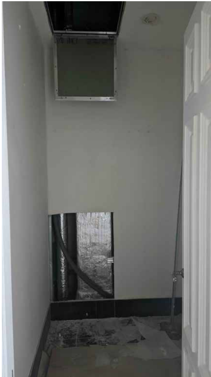
114. Вид в интерьере зоны «РВИО» в уровне 5-го этажа северного корпуса.
