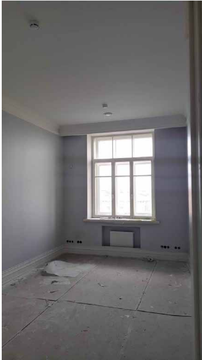
116. Вид в интерьере зоны «РВИО» в уровне 5-го этажа северного корпуса.
