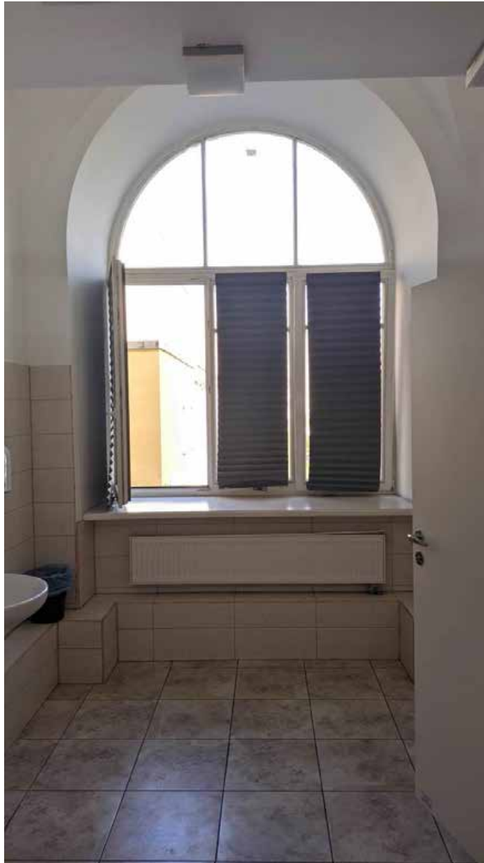
55. Вид в интерьере санузла зоны «СЗД» в уровне 2-го этажа южного корпуса.
