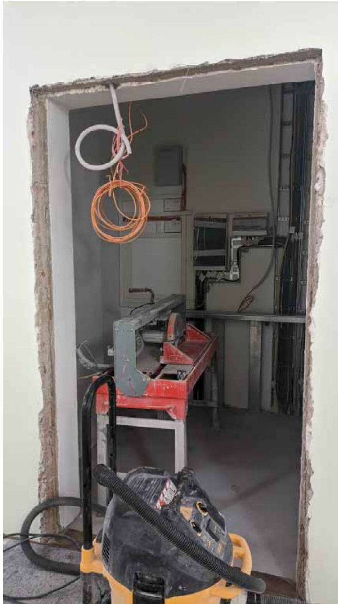
150. Вид в интерьере зоны «Консерватория» в уровне 2-го этажа западного корпуса.
