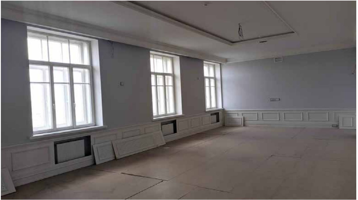
118. Вид в интерьере зоны «РВИО» в уровне 5-го этажа северного корпуса.
