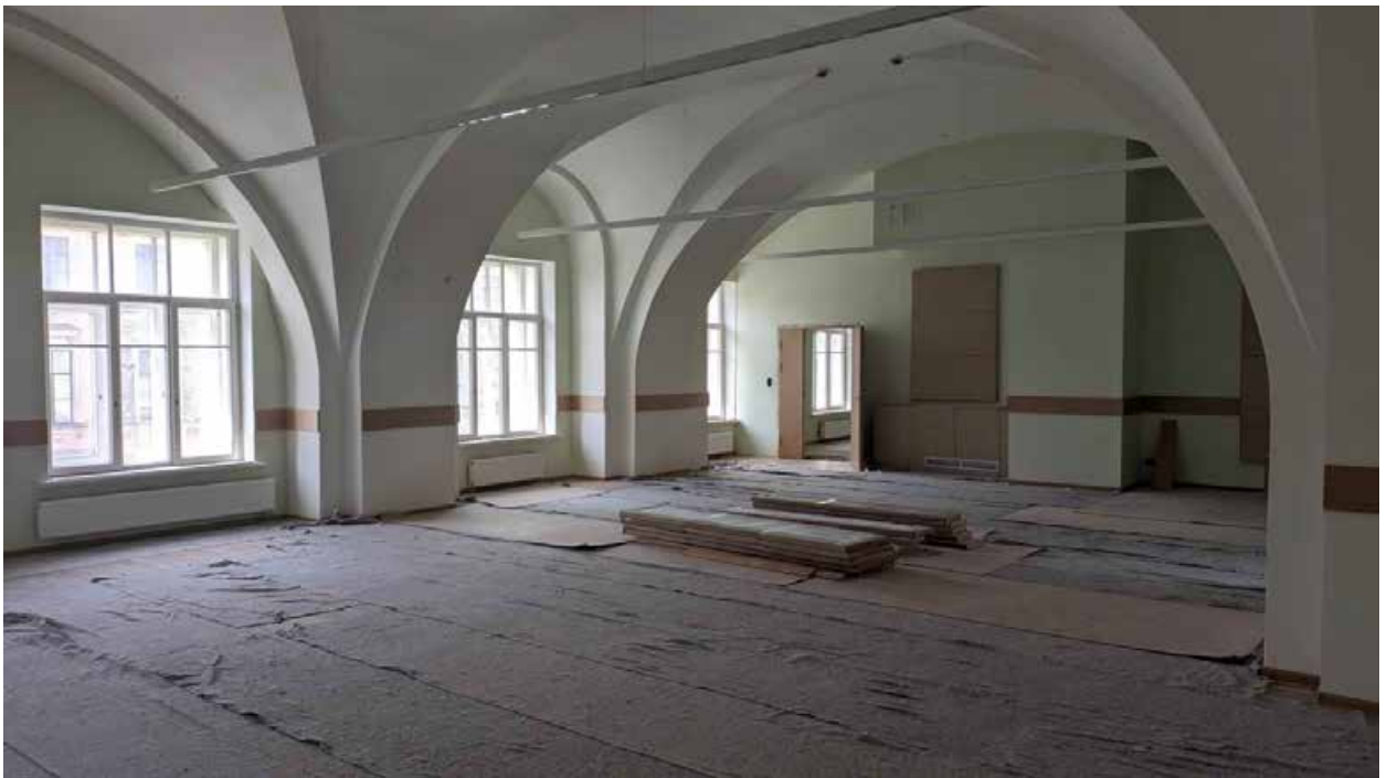
174. Вид в интерьере зоны «Консерватория» в уровне 3-го этажа западного корпуса.
