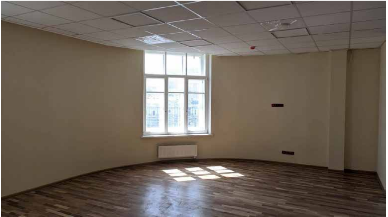
263. Вид в интерьере зоны «Консерватория» в уровне 5-го этажа южного корпуса.
