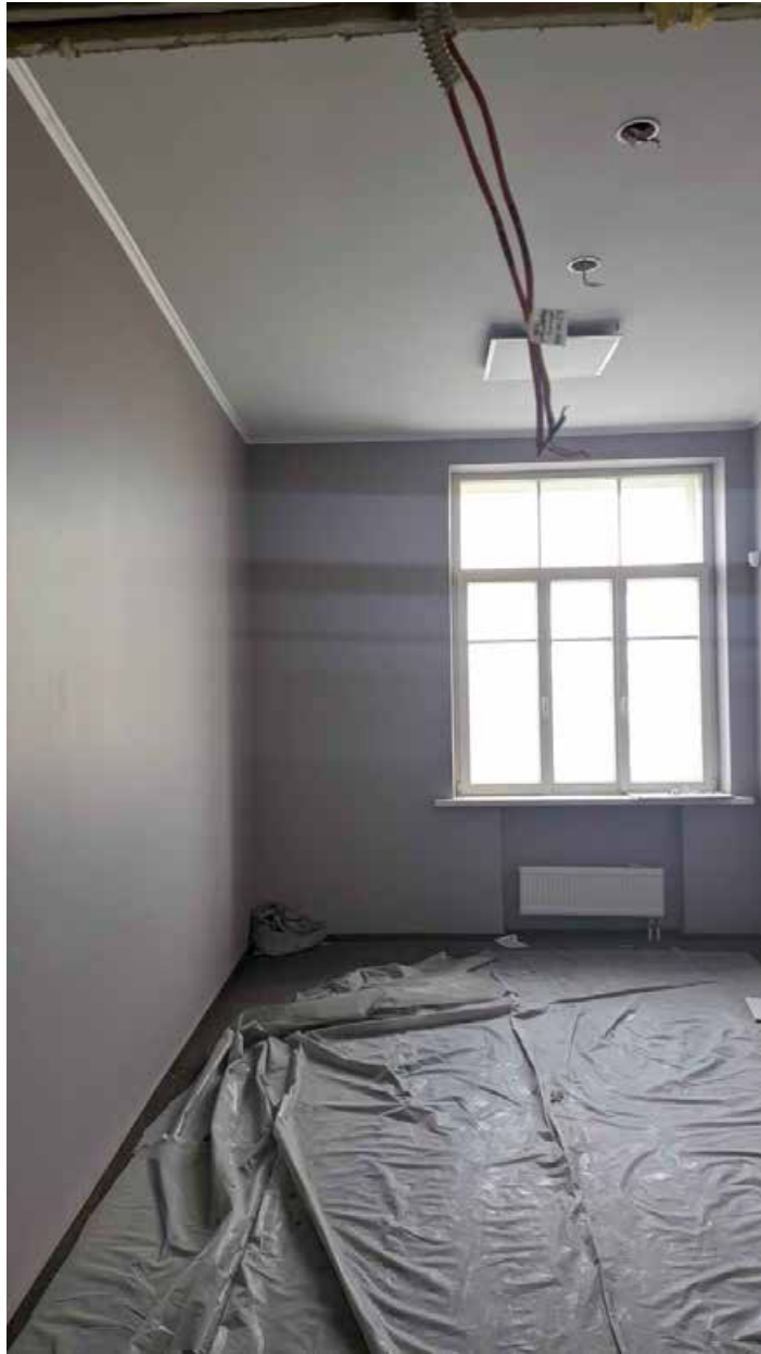
95. Вид в интерьере зоны «РВИО» в уровне 4-го этажа северного корпуса.
