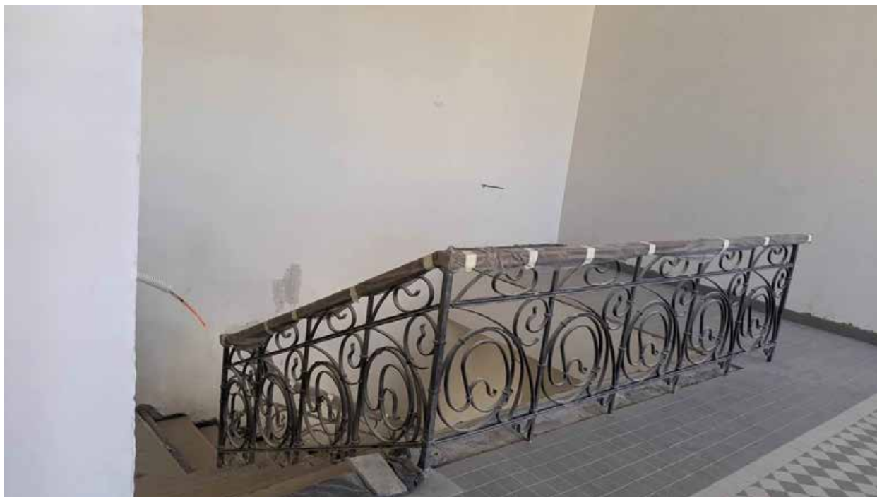
288.2. Вид в интерьере лестничной клетки зоны «Консерватория» в уровне 5-го этажа южного корпуса.
