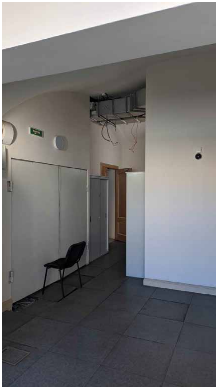
42. Вид в коридоре зоны «СЗД» в уровне 2-го этажа южного корпуса.
