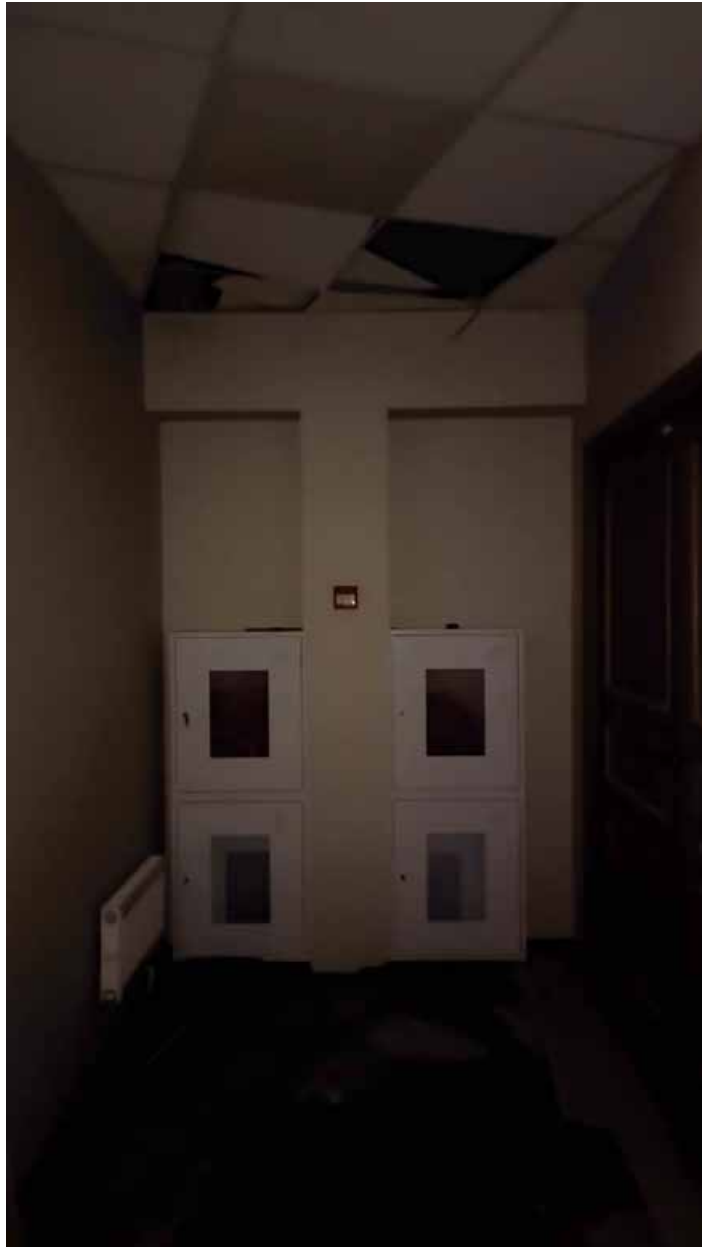
108. Вид в интерьере зоны «РВИО» в уровне 4-го этажа северного корпуса.
