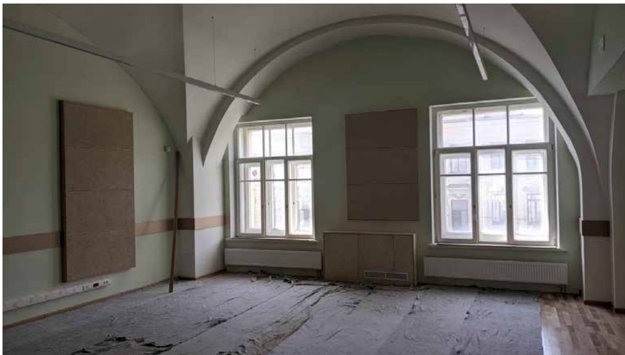
165. Вид в интерьере зоны «Консерватория» в уровне 3-го этажа западного корпуса.
