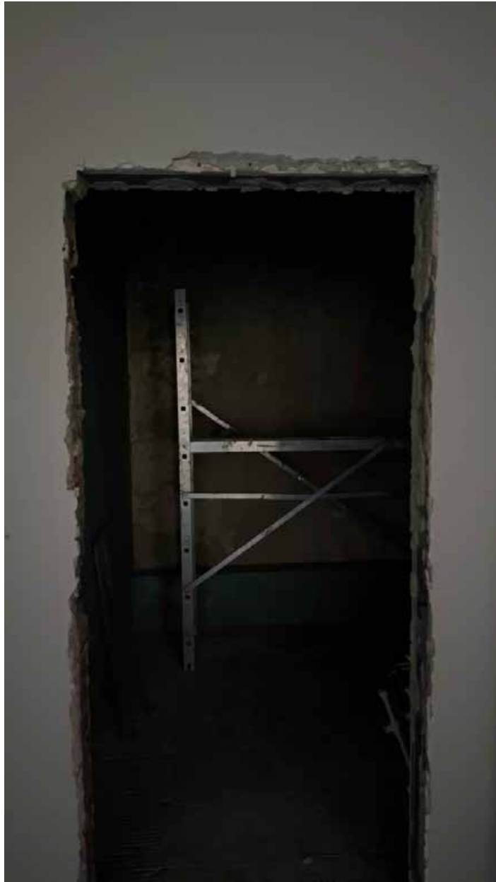
105. Вид в интерьере зоны «РВИО» в уровне 4-го этажа северного корпуса.
