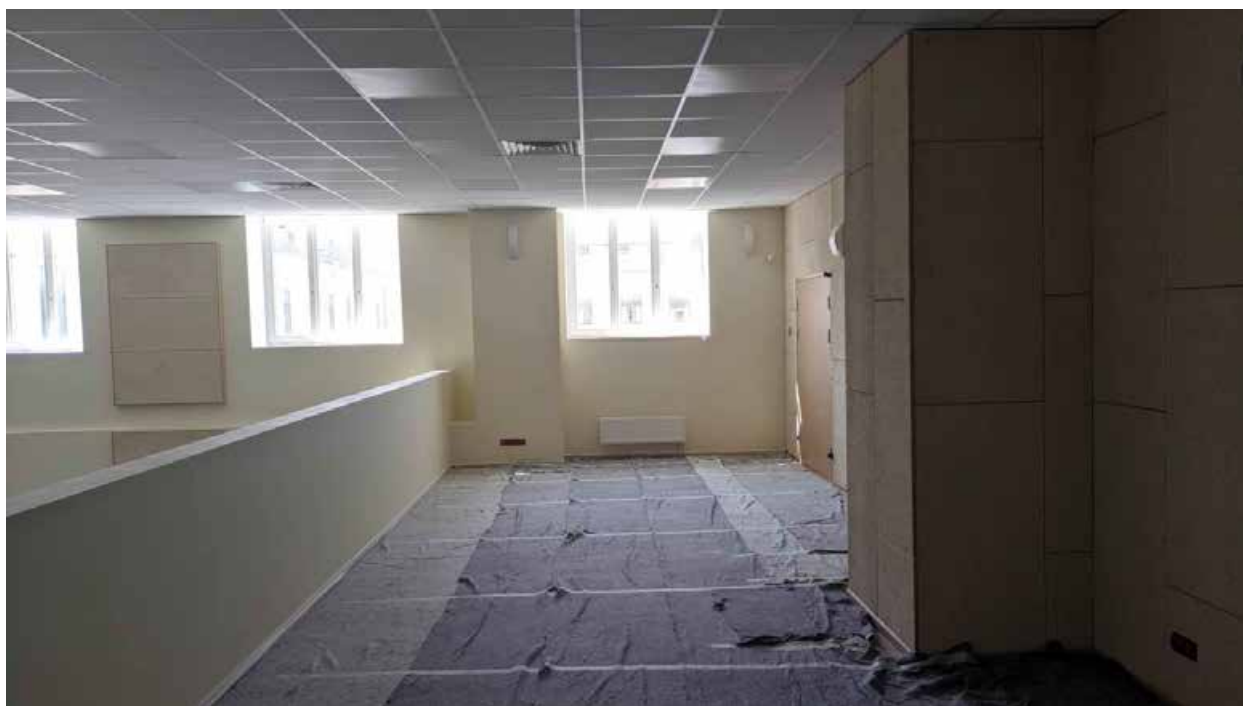
255. Вид в интерьере балкона репетиционного зала зоны «Консерватория» в уровне 5-го этажа южного корпуса.
