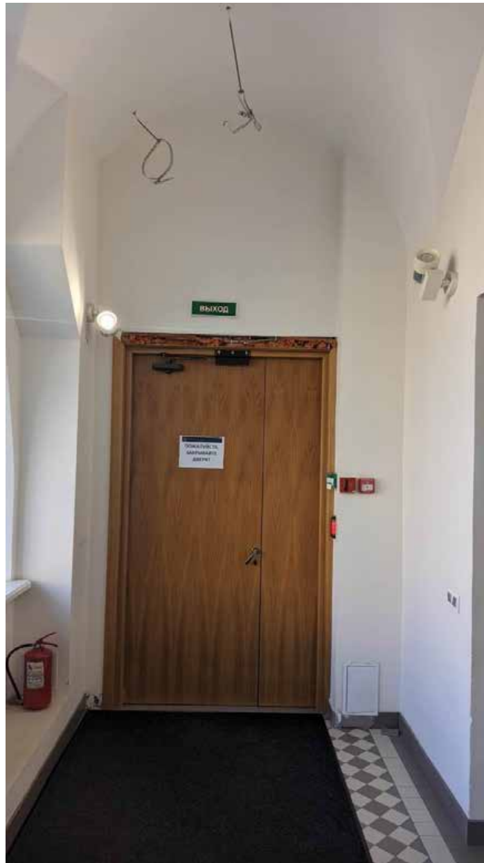
41. Вид в интерьере зоны «СЗД» в уровне 2-го этажа южного корпуса.
