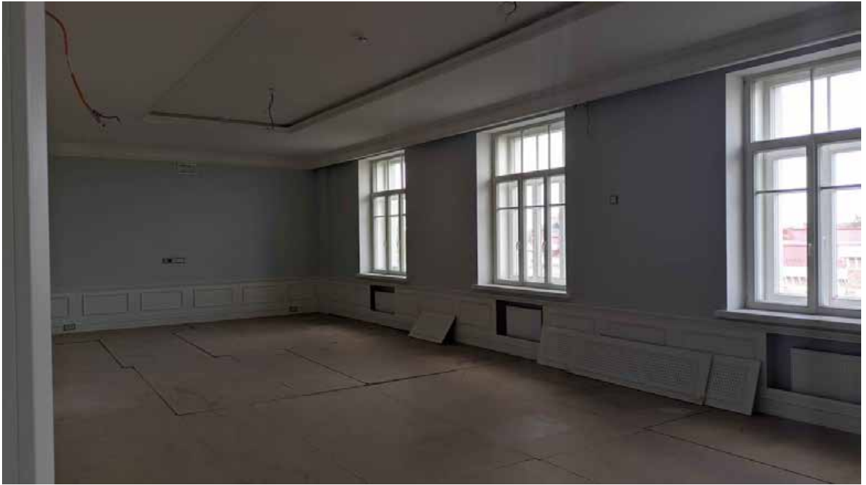
123. Вид в интерьере зоны «РВИО» в уровне 5-го этажа северного корпуса.
