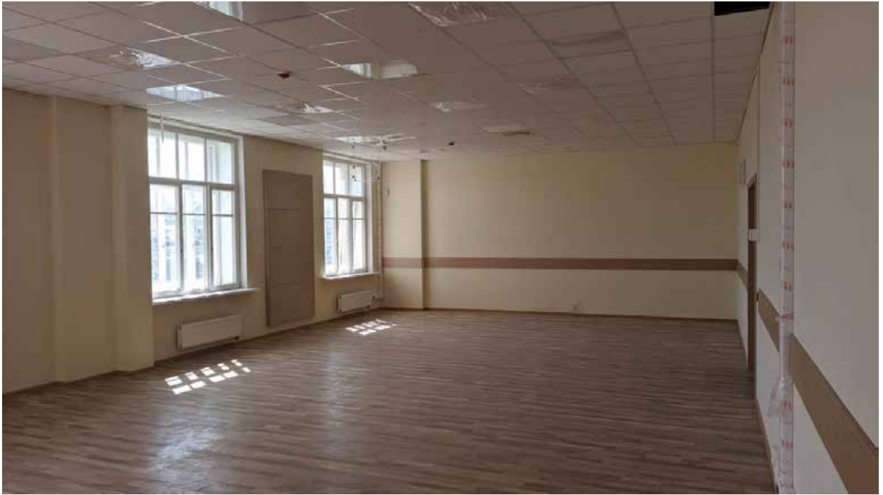
278. Вид в интерьере зоны «Консерватория» в уровне 5-го этажа южного корпуса.
