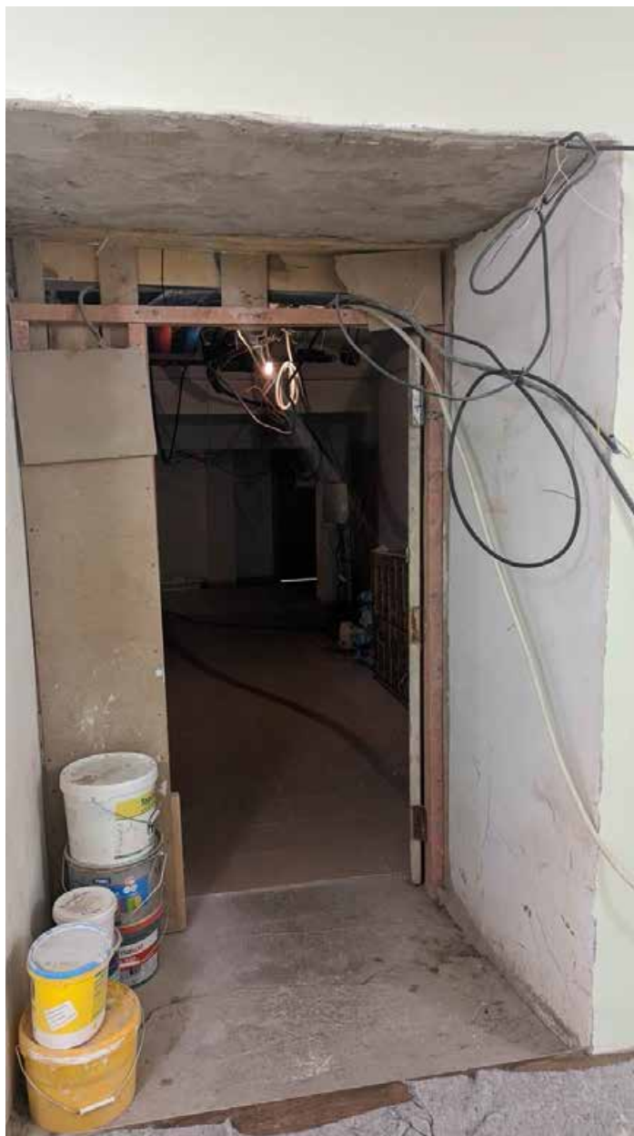
151. Вид в интерьере зоны «Консерватория» в уровне 2-го этажа западного корпуса.
