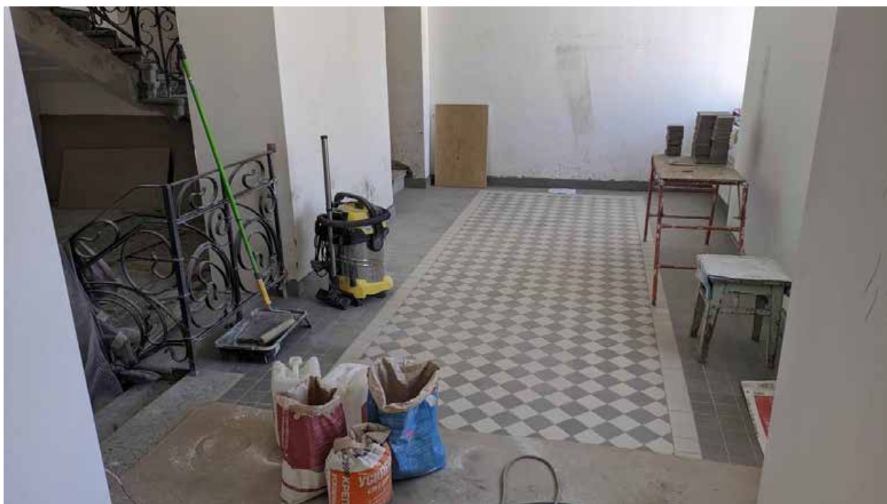
239. Вид в интерьере лестничной клетки зоны «Консерватория» в уровне 4-го этажа южного корпуса.
