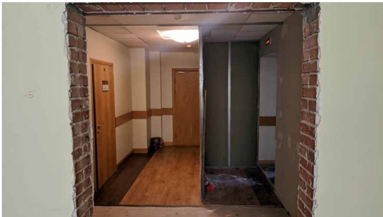
187. Вид в коридоре зоны «Консерватория» в уровне 4-го этажа западного корпуса.
