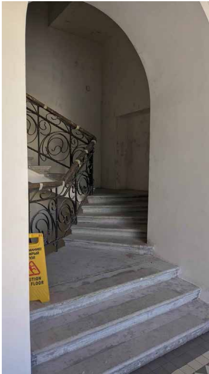
59. Вид в интерьере лестничной клетки зоны «СЗД» в уровне 3-го этажа южного корпуса.
