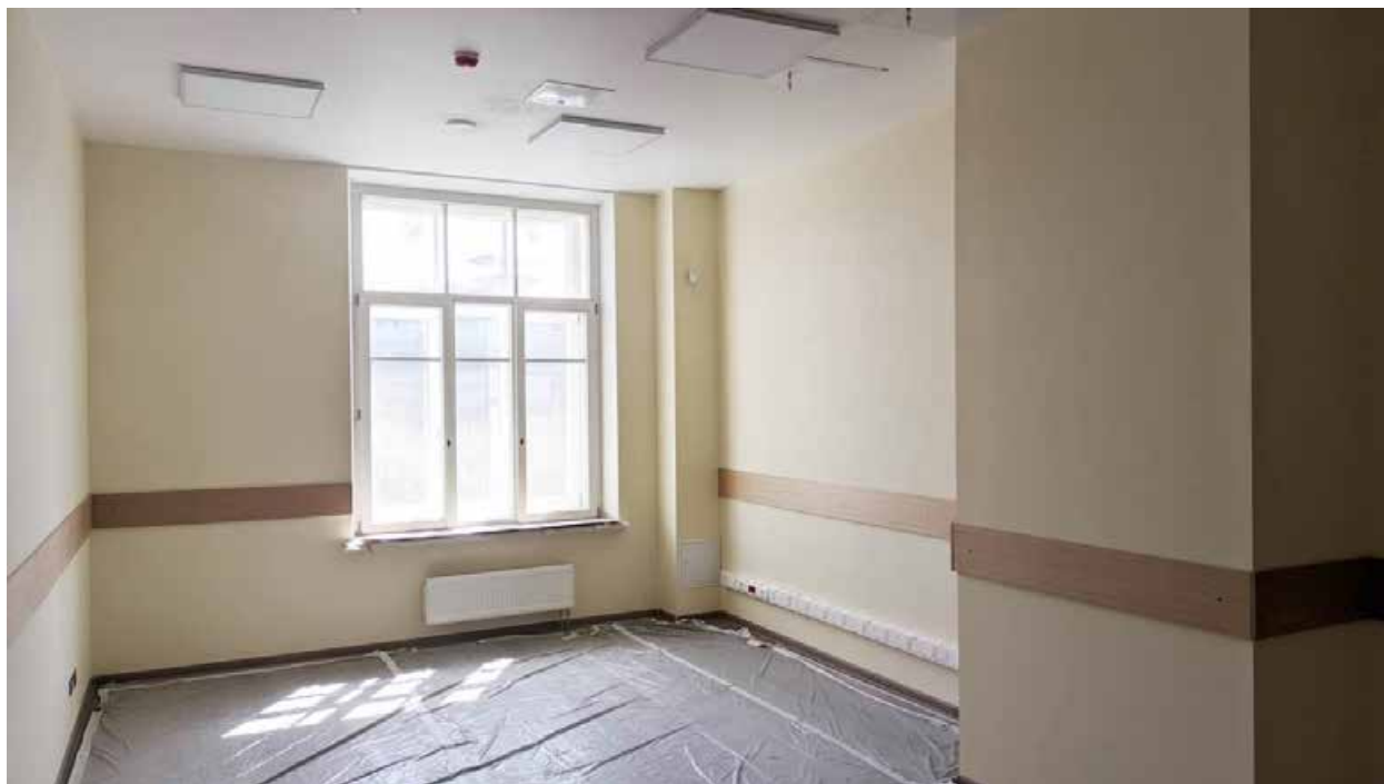
245. Вид в интерьере зоны «Консерватория» в уровне 4-го этажа южного корпуса.
