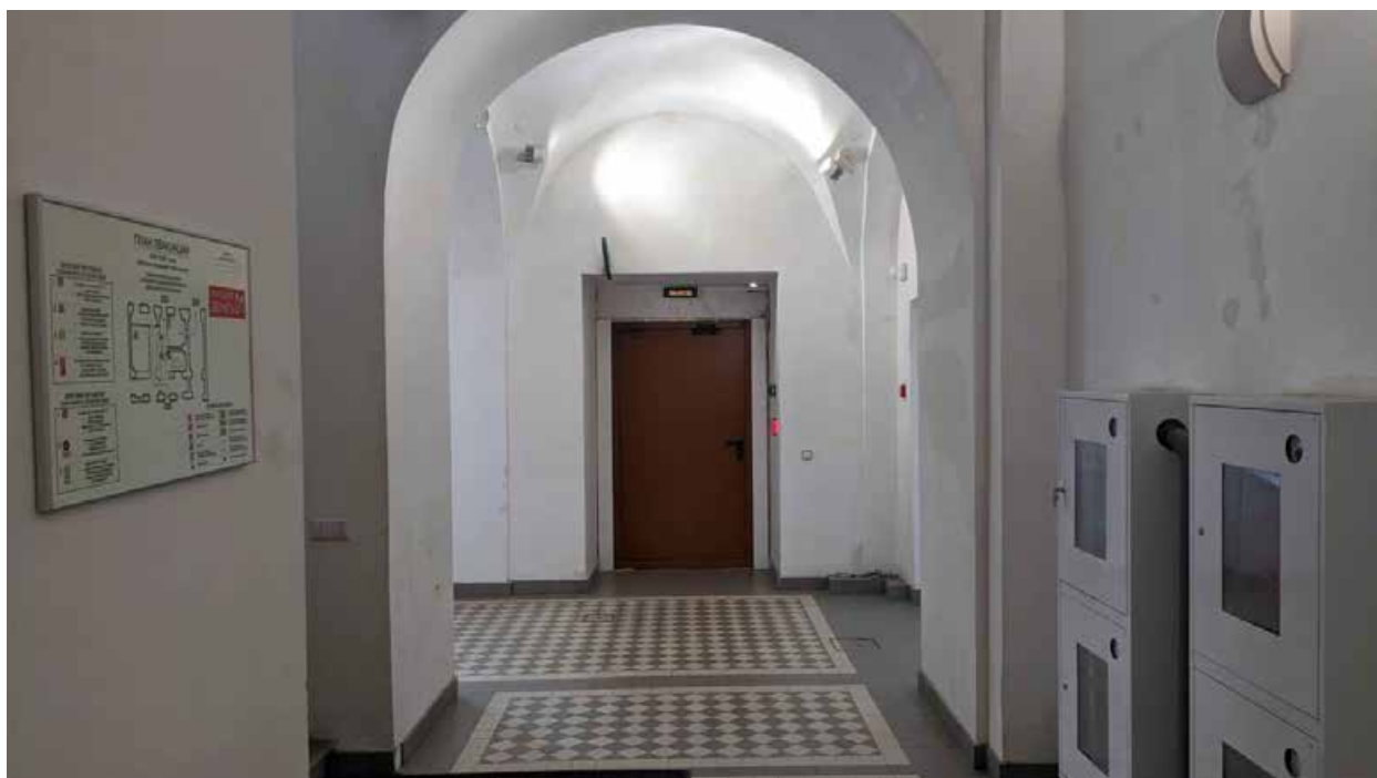
27. Вид входной группы зоны «СЗД» в уровне 1-го этажа южного корпуса.
