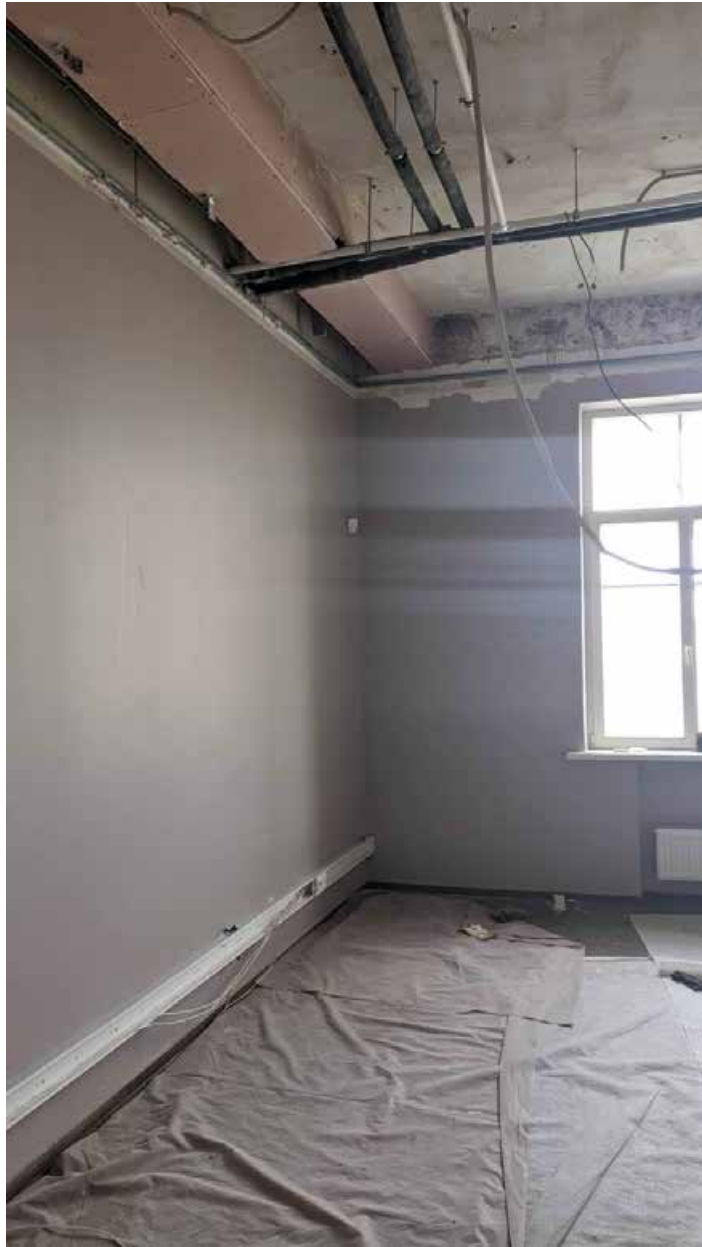
93. Вид в интерьере зоны «РВИО» в уровне 4-го этажа северного корпуса.
