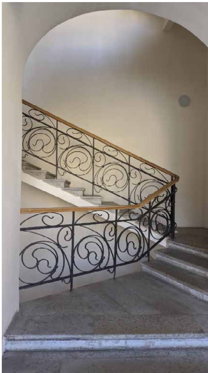
38. Виды в интерьере парадной лестницы зоны «СЗД» в уровне 2-го этажа южного корпуса.
