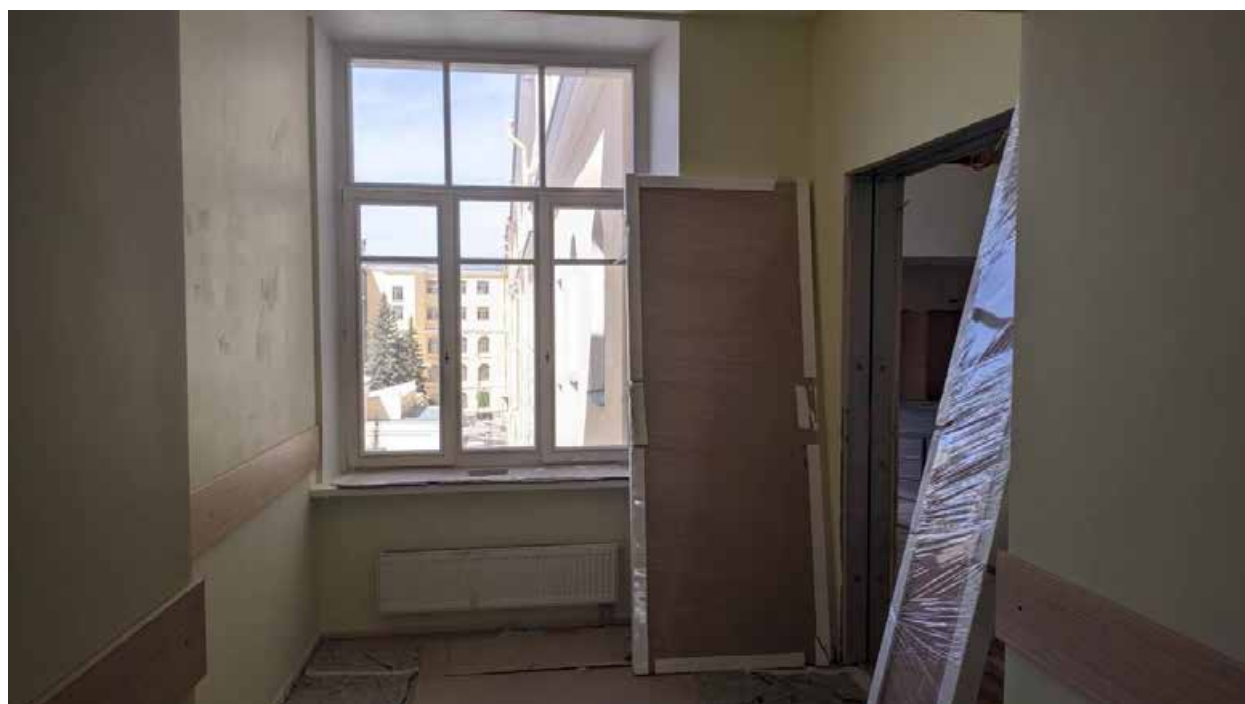
246. Вид в интерьере коридора зоны «Консерватория» в уровне 4-го этажа южного корпуса.
