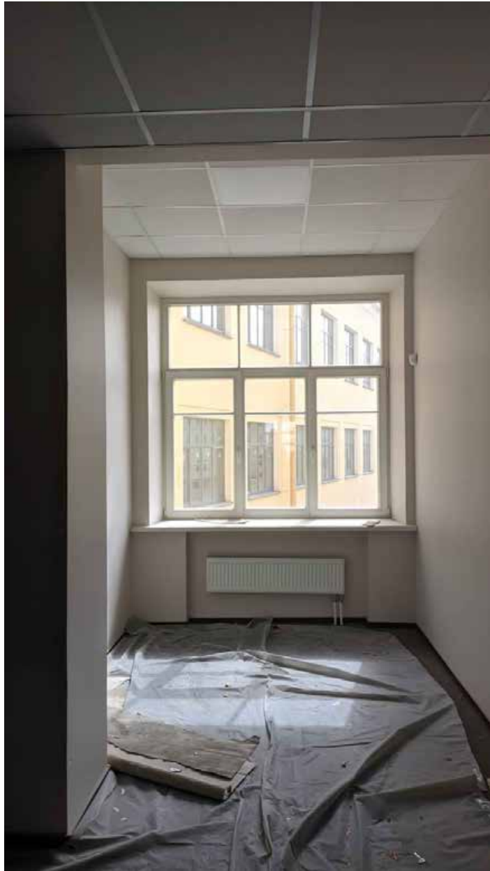
98. Вид в интерьере зоны «РВИО» в уровне 4-го этажа северного корпуса.
