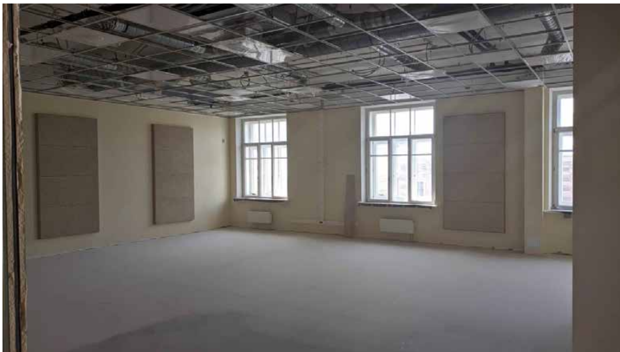
193. Вид в интерьере зоны «Консерватория» в уровне 4-го этажа западного корпуса.
