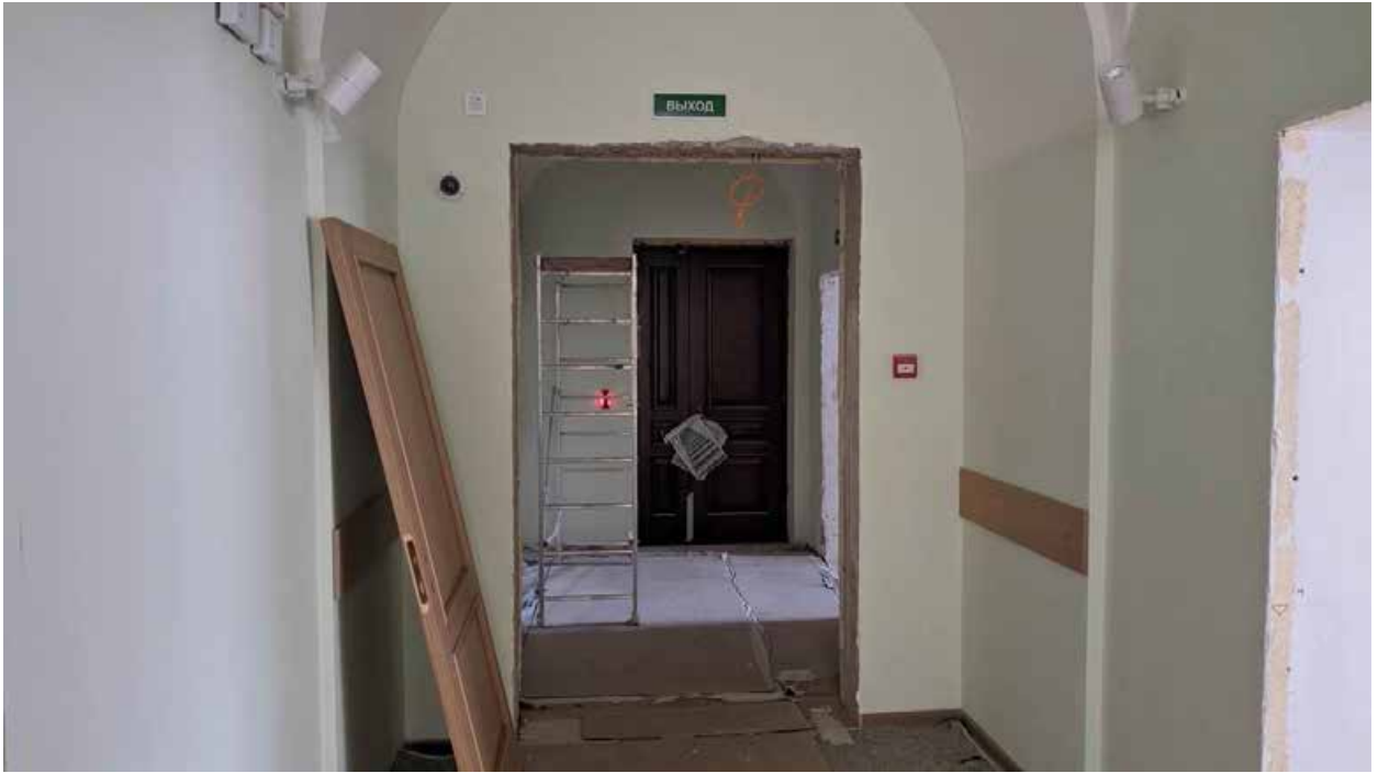
163. Вид в интерьере коридора зоны «Консерватория» в уровне 3-го этажа западного корпуса.
