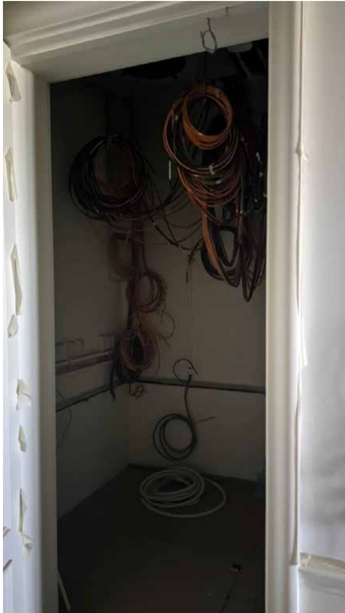
130. Вид в интерьере зоны «РВИО» в уровне 5-го этажа северного корпуса.
