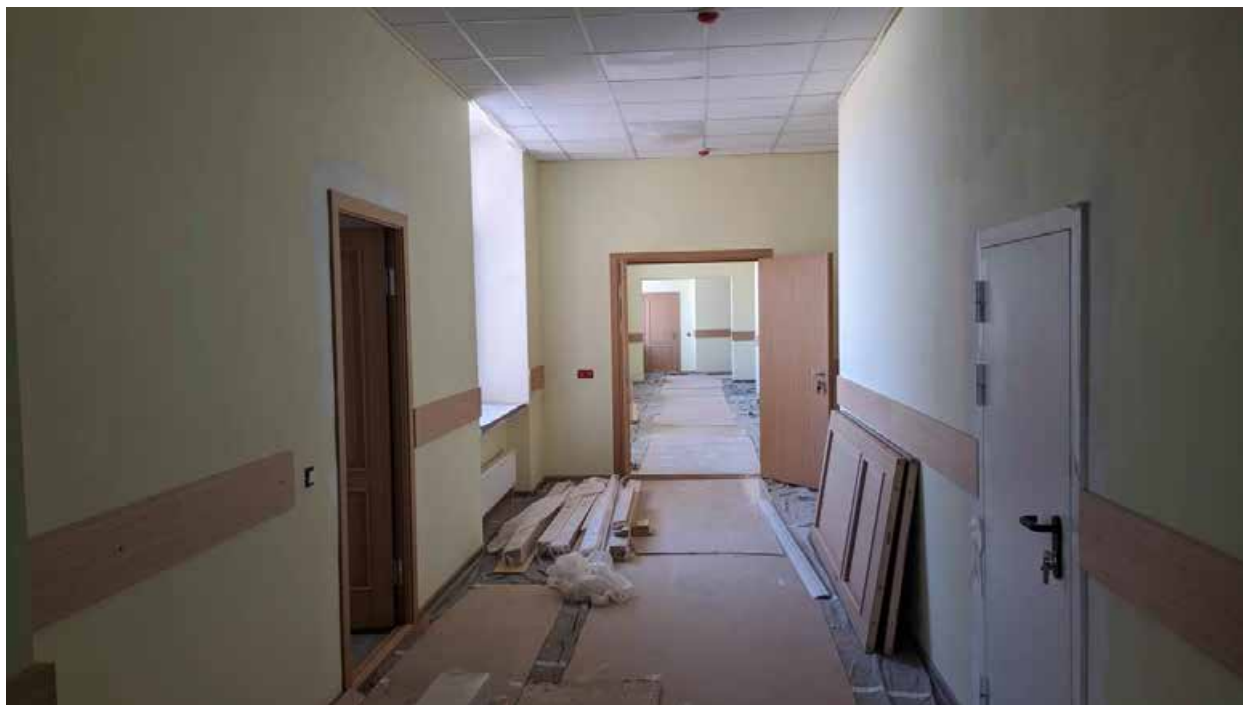
220. Вид в интерьере коридора зоны «Консерватория» в уровне 4-го этажа западного корпуса.
