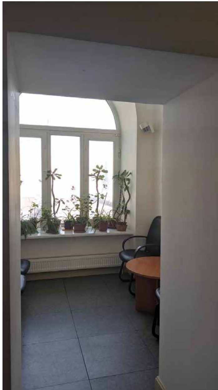
81. Вид в интерьере зоны «СЗД» в уровне 3-го этажа южного корпуса.
