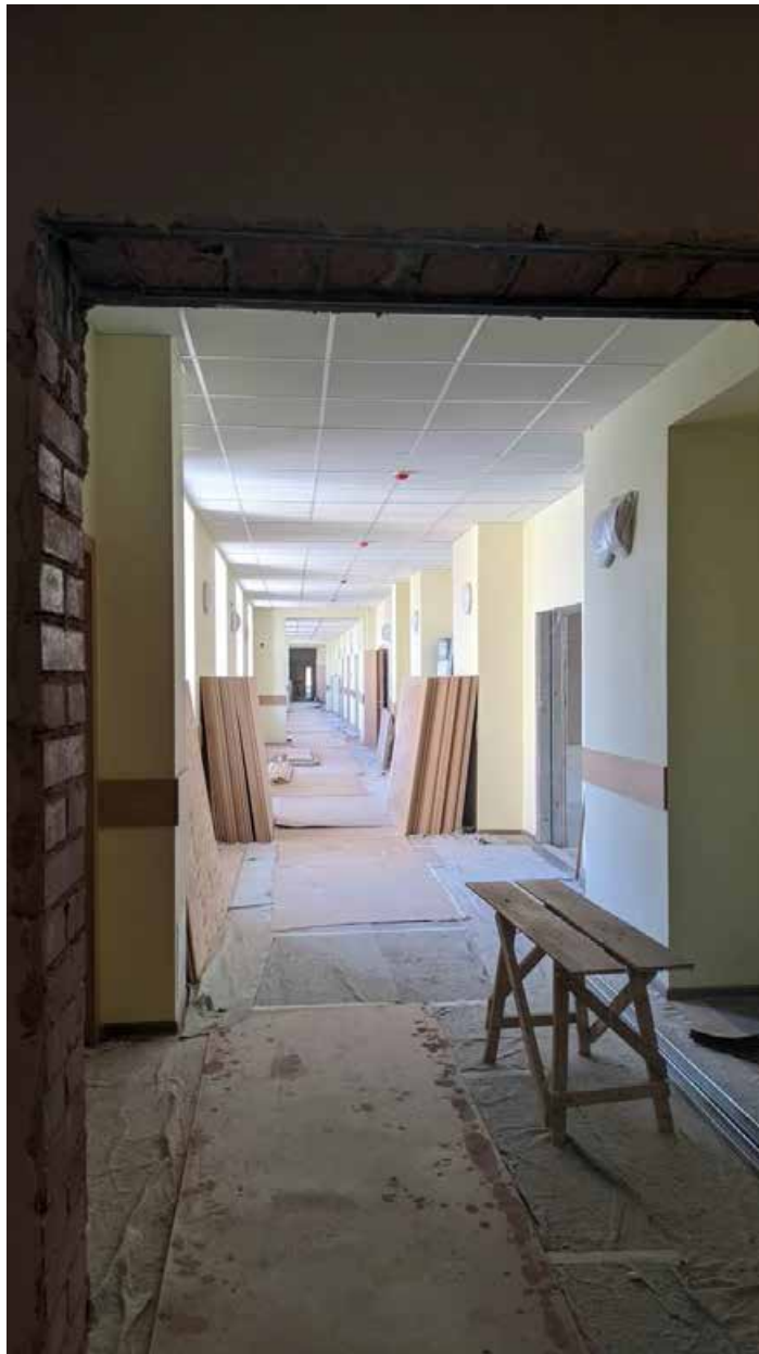
186. Вид в коридоре зоны «Консерватория» в уровне 4-го этажа западного корпуса.
