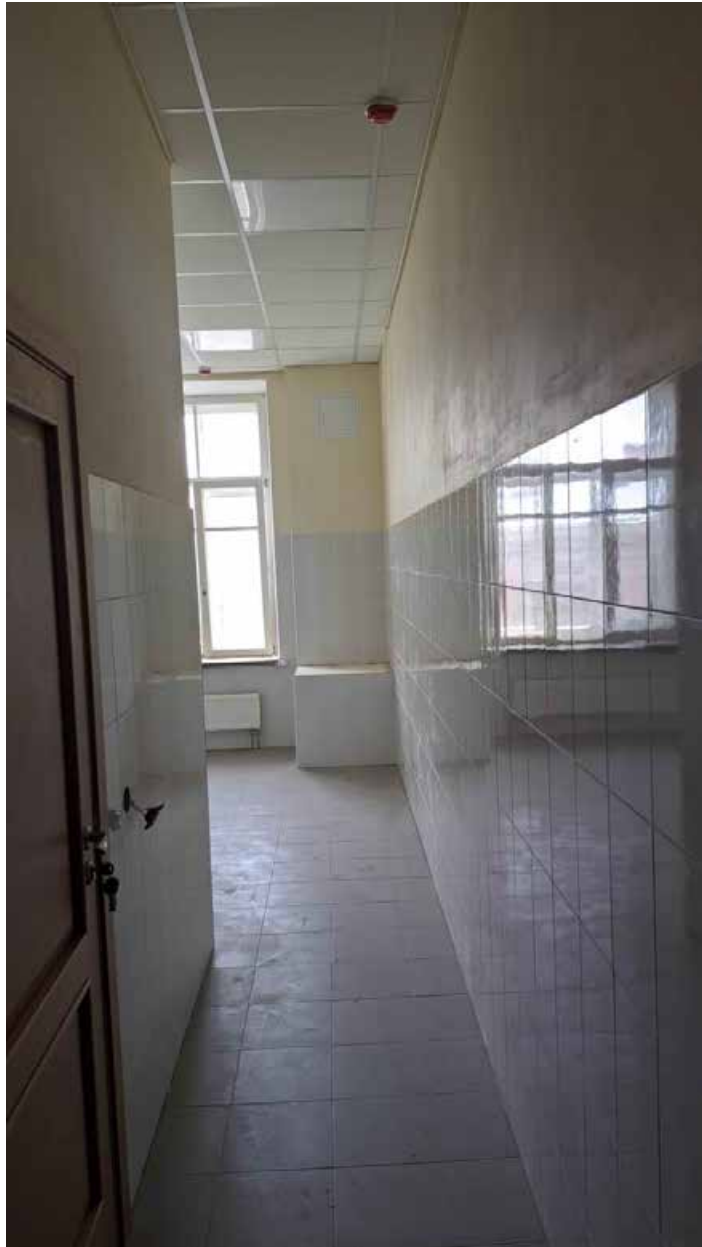
189. Вид в интерьере санузла зоны «Консерватория» в уровне 4-го этажа западного корпуса.
