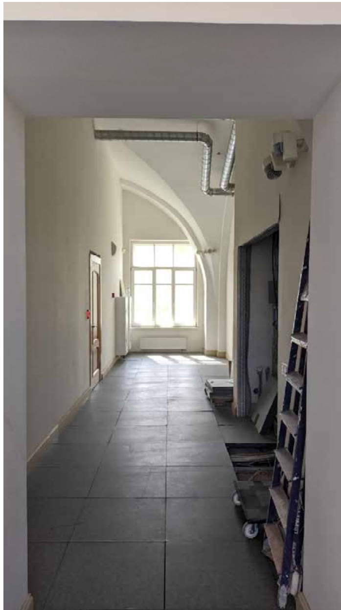
62. Вид в интерьере коридора зоны «СЗД» в уровне 3-го этажа южного корпуса.
