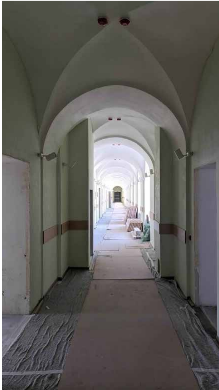
160. Вид в интерьере коридора зоны «Консерватория» в уровне 3-го этажа западного корпуса.
