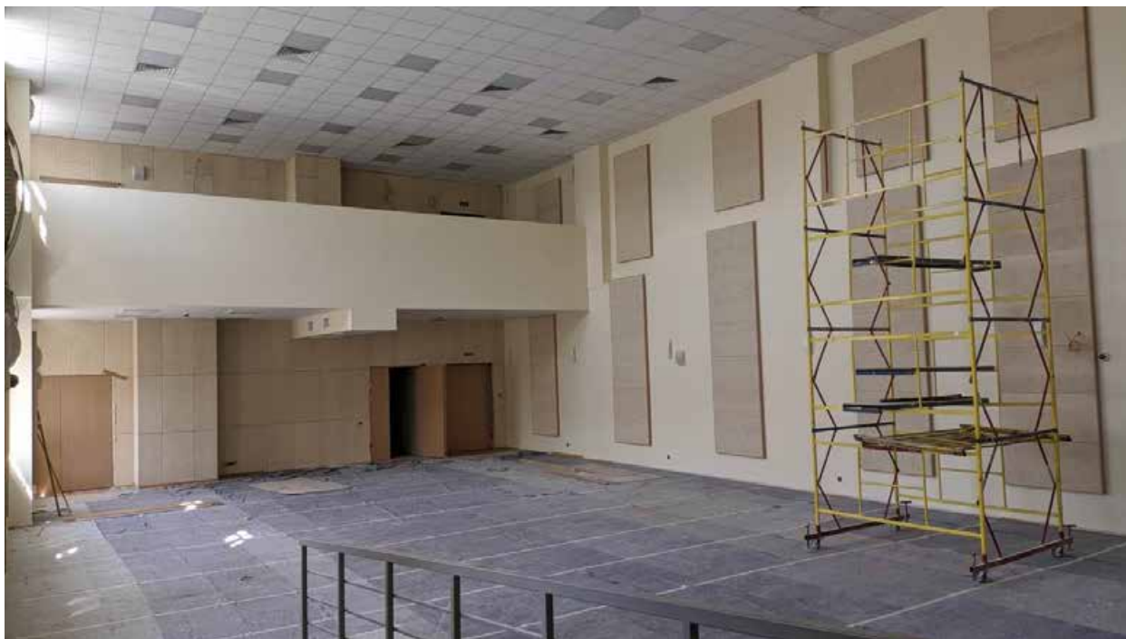
247. Вид в интерьере репетиционного зала зоны «Консерватория» в уровне 4-го этажа южного корпуса.
