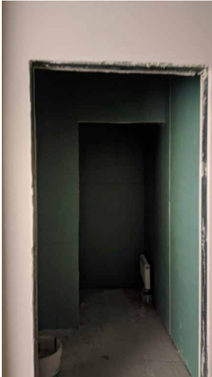
107. Вид в интерьере зоны «РВИО» в уровне 4-го этажа северного корпуса.
