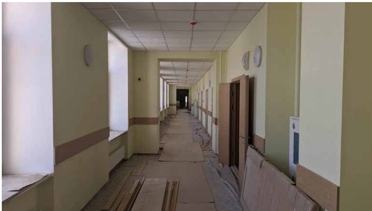
195. Вид в интерьере коридора зоны «Консерватория» в уровне 4-го этажа западного корпуса.
