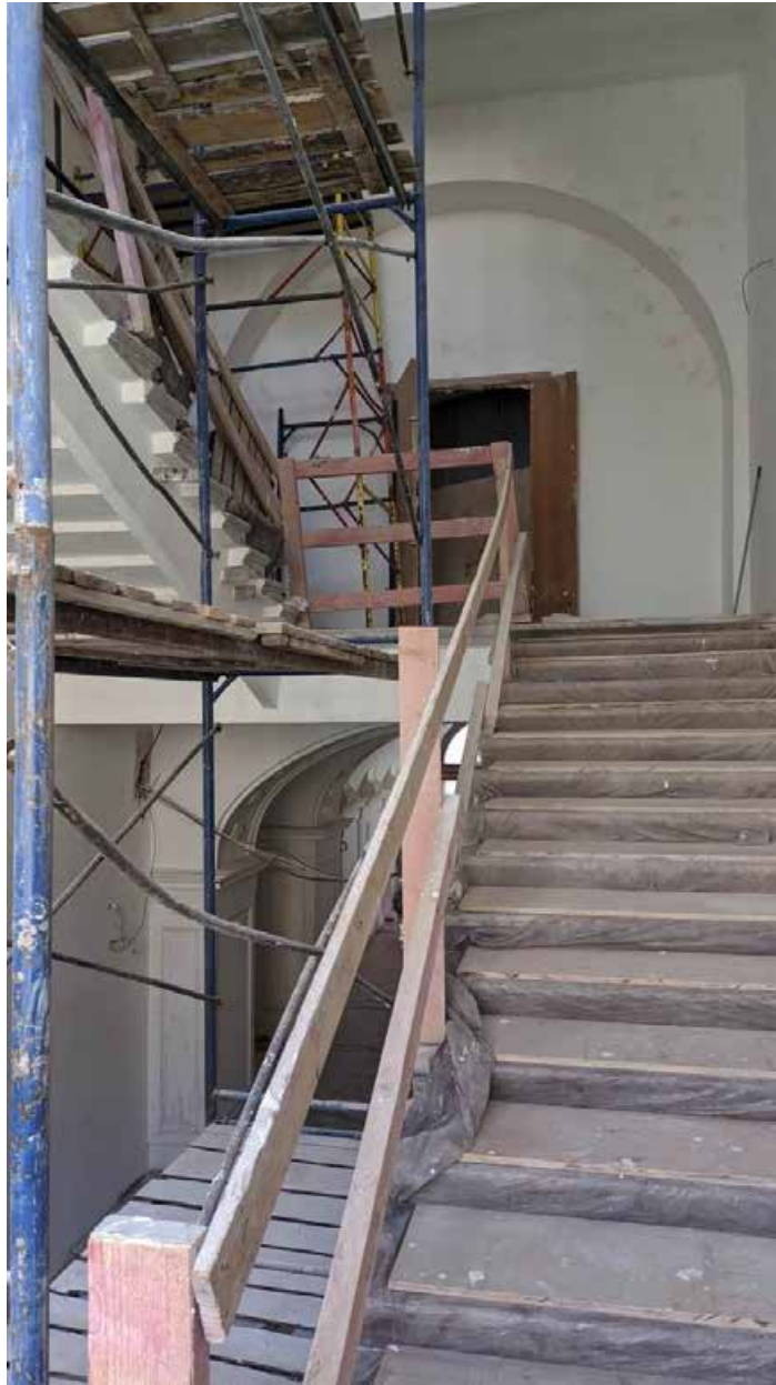
139. Виды в интерьере парадной лестницы зоны «Консерватория» в уровне 1-го этажа западного корпуса.
