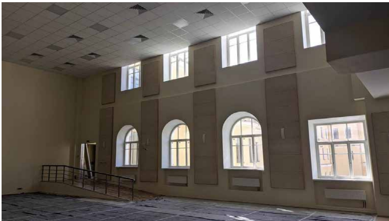
249. Вид в интерьере репетиционного зала зоны «Консерватория» в уровне 4-го этажа южного корпуса.
