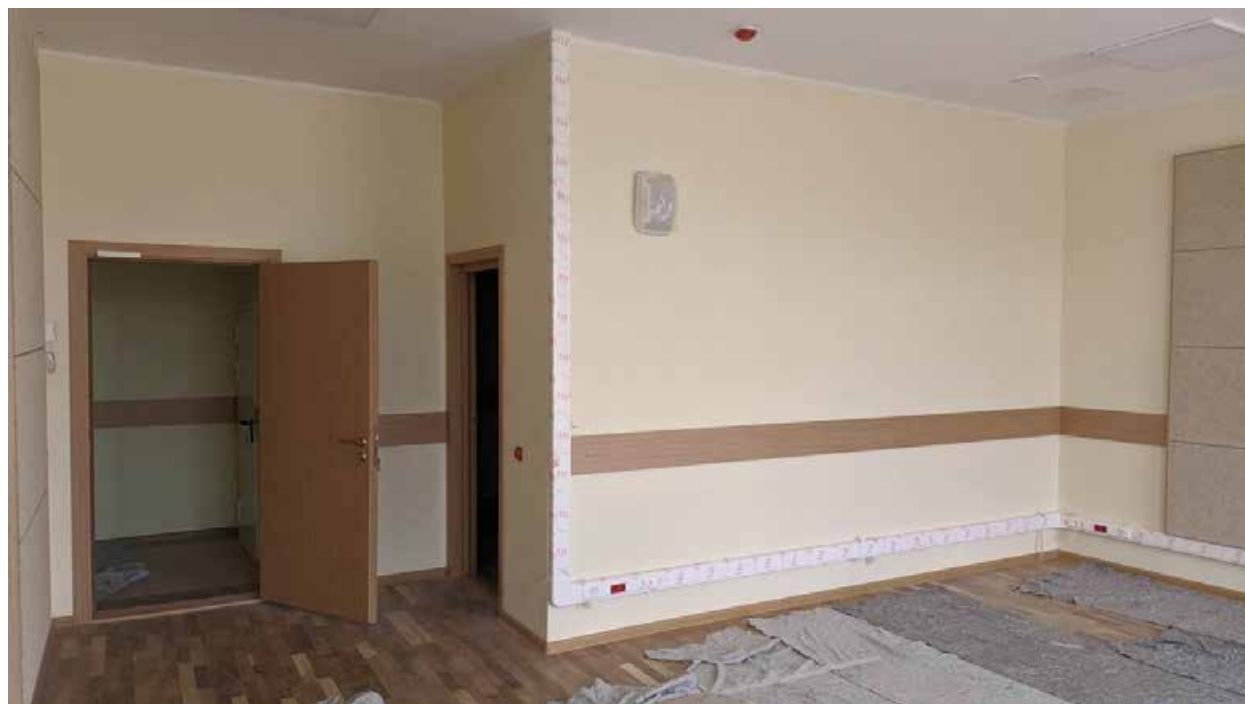
252. Вид в интерьере зоны «Консерватория» в уровне 4-го этажа южного корпуса.
