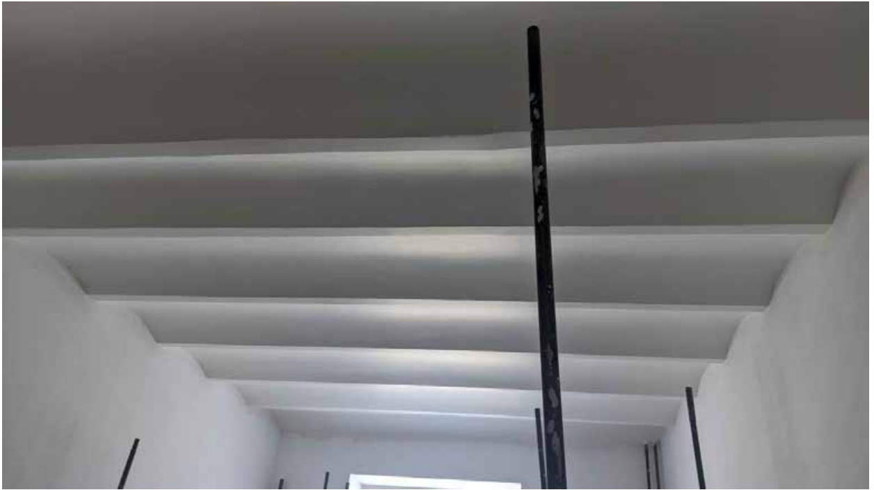
318. Вид в интерьере лестничной клетки зоны «Консерватория» в уровне 5-го этажа западного корпуса.
