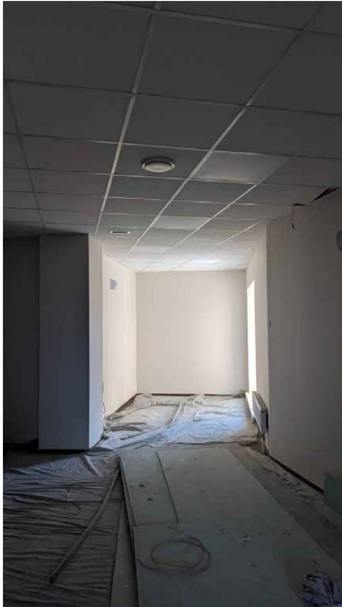
102. Вид в интерьере зоны «РВИО» в уровне 4-го этажа северного корпуса.
