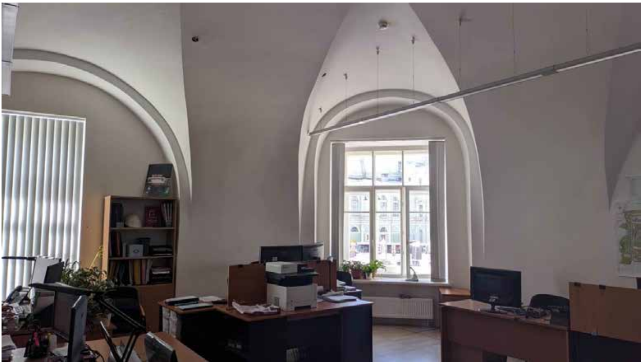
50. Вид в интерьере зоны «СЗД» в уровне 2-го этажа южного корпуса.
