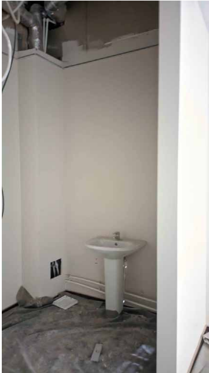
91. Вид в интерьере зоны «РВИО» в уровне 4-го этажа северного корпуса.
