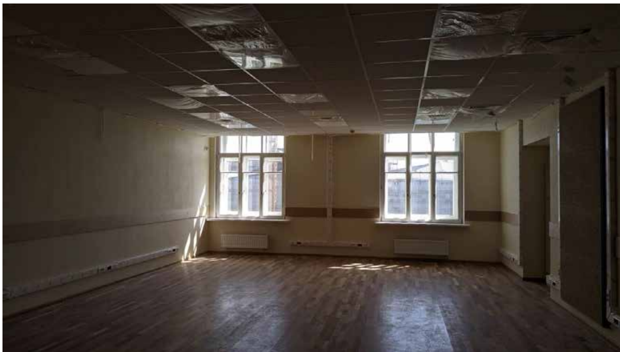
271. Вид в интерьере зоны «Консерватория» в уровне 5-го этажа южного корпуса.
