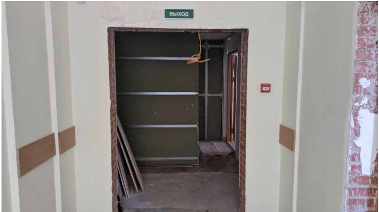
178. Вид в интерьере коридора зоны «Консерватория» в уровне 3-го этажа западного корпуса.
