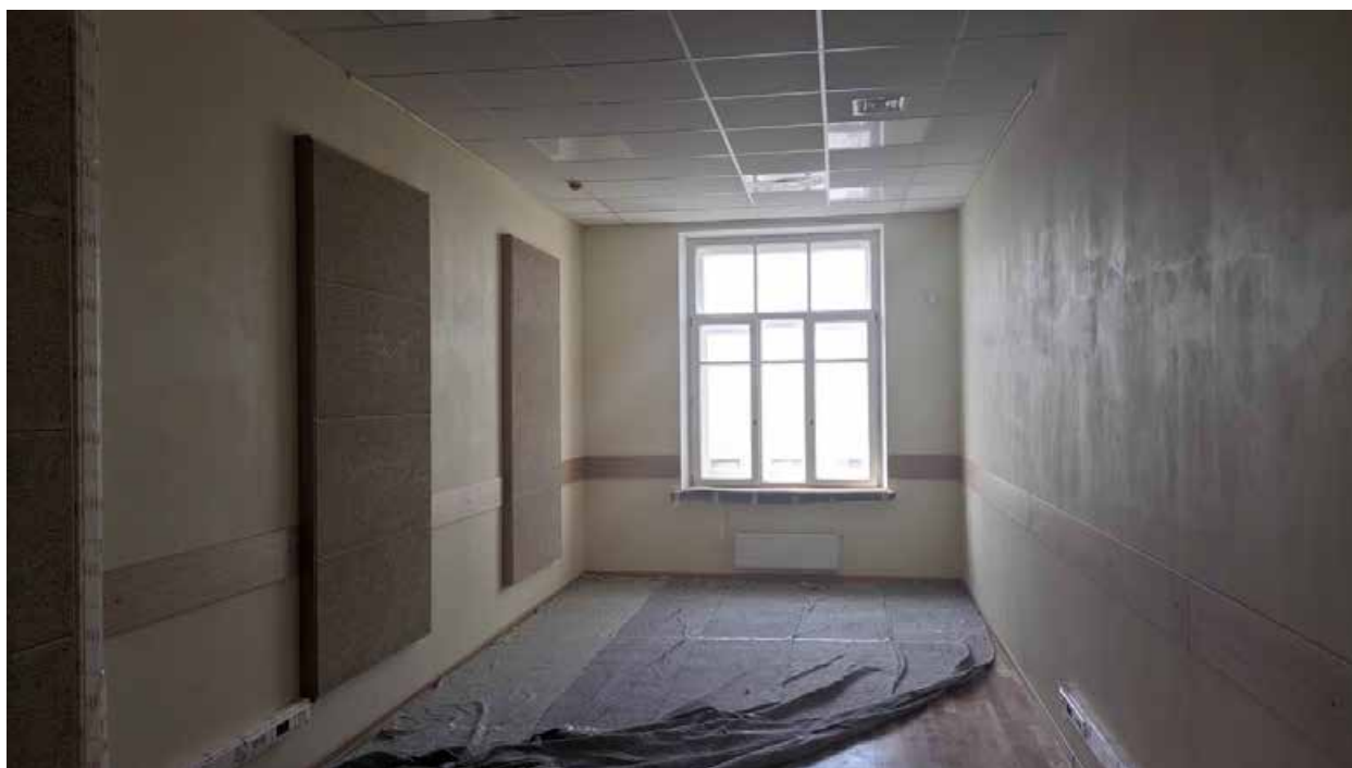
199. Вид в интерьере зоны «Консерватория» в уровне 4-го этажа западного корпуса.
