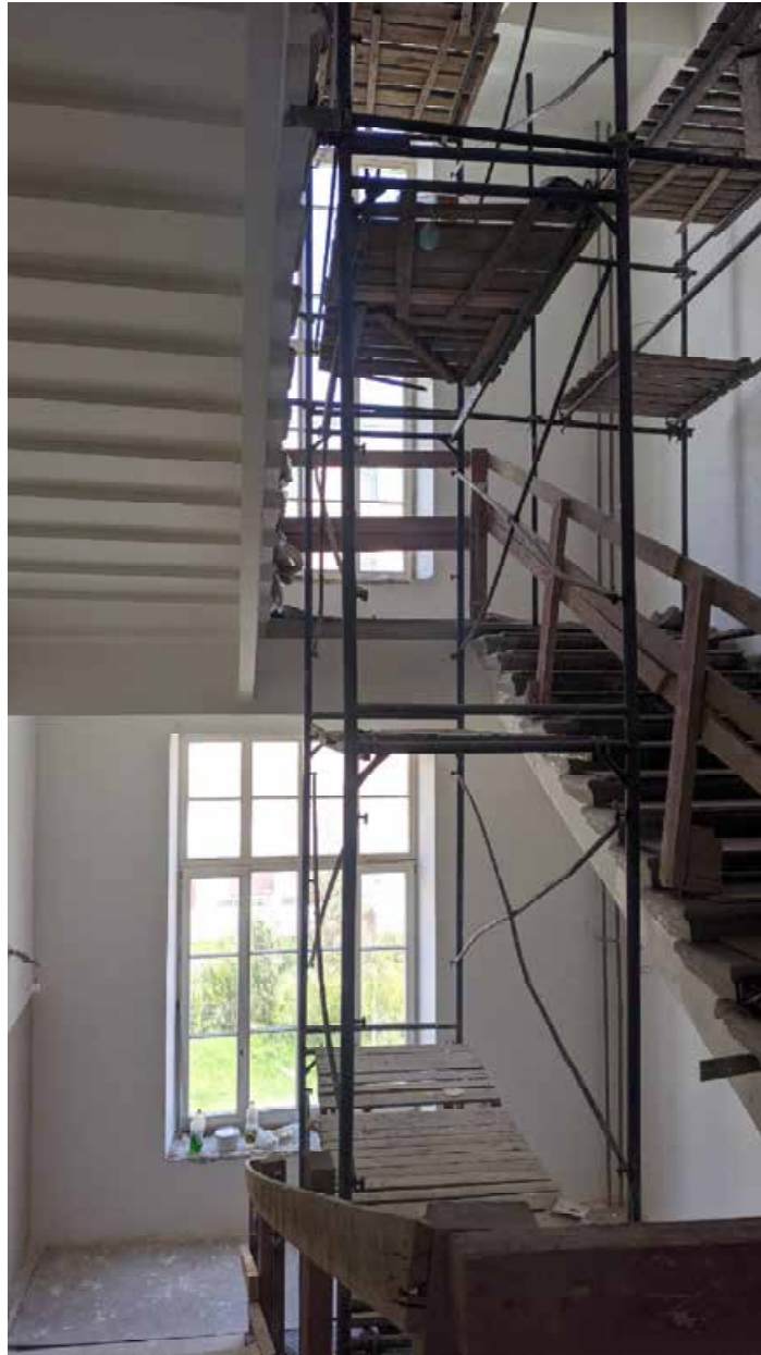
143. Вид на лестничную клетку зоны «Консерватория» в уровне 2-го этажа западного корпуса.
