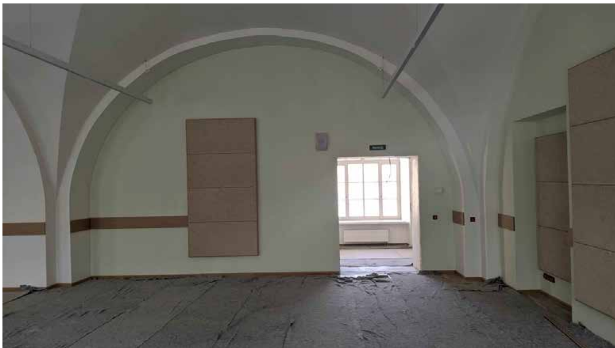
176. Вид в интерьере зоны «Консерватория» в уровне 3-го этажа западного корпуса.
