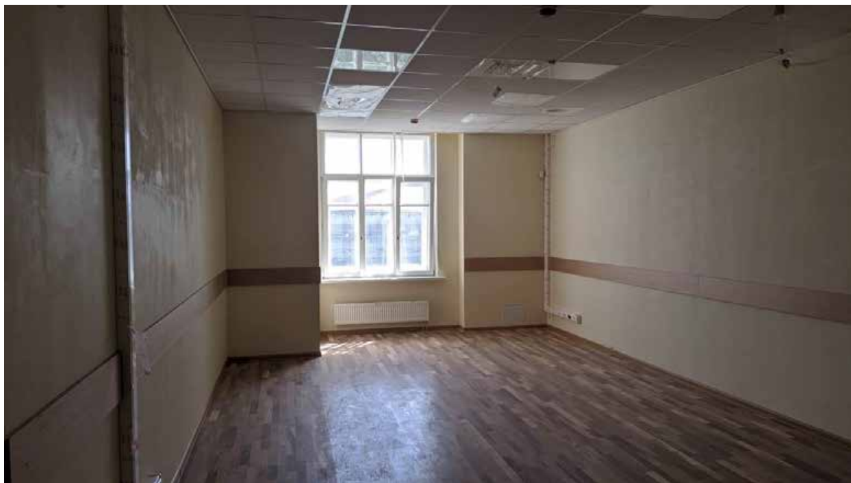
273. Вид в интерьере зоны «Консерватория» в уровне 5-го этажа южного корпуса.
