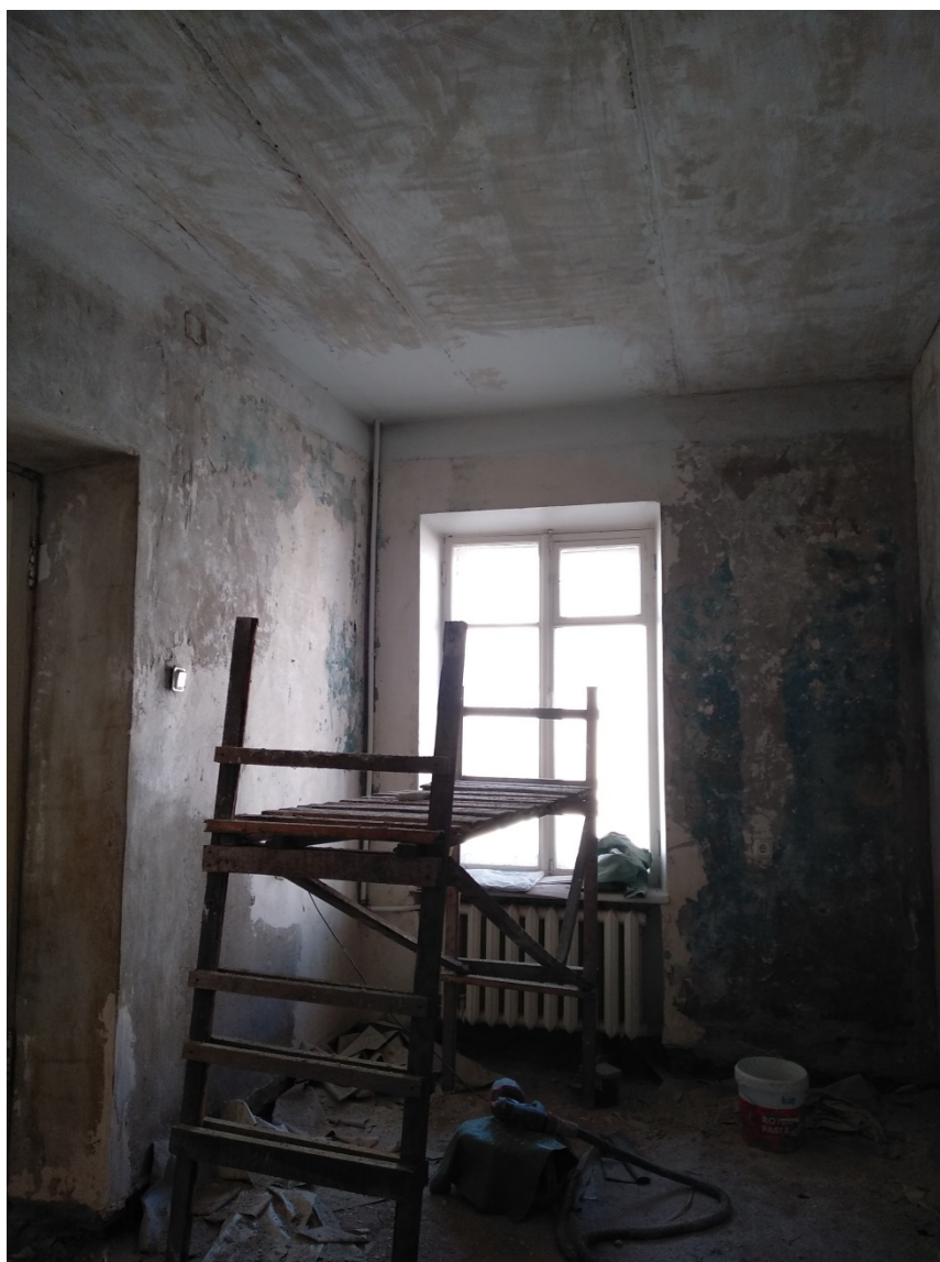
Фото 13. Комната (пом. №6 по проектной экспликации).
