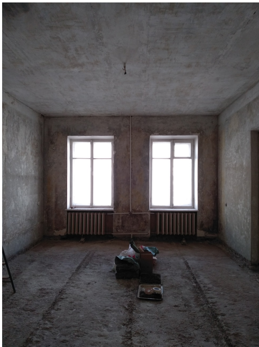
Фото 11. Комната (пом. №5 по проектной экспликации).
