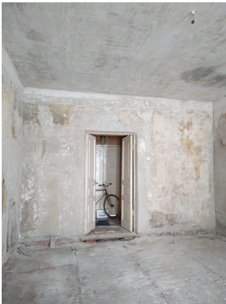
Фото 12. Комната (пом. №5 по проектной экспликации).
