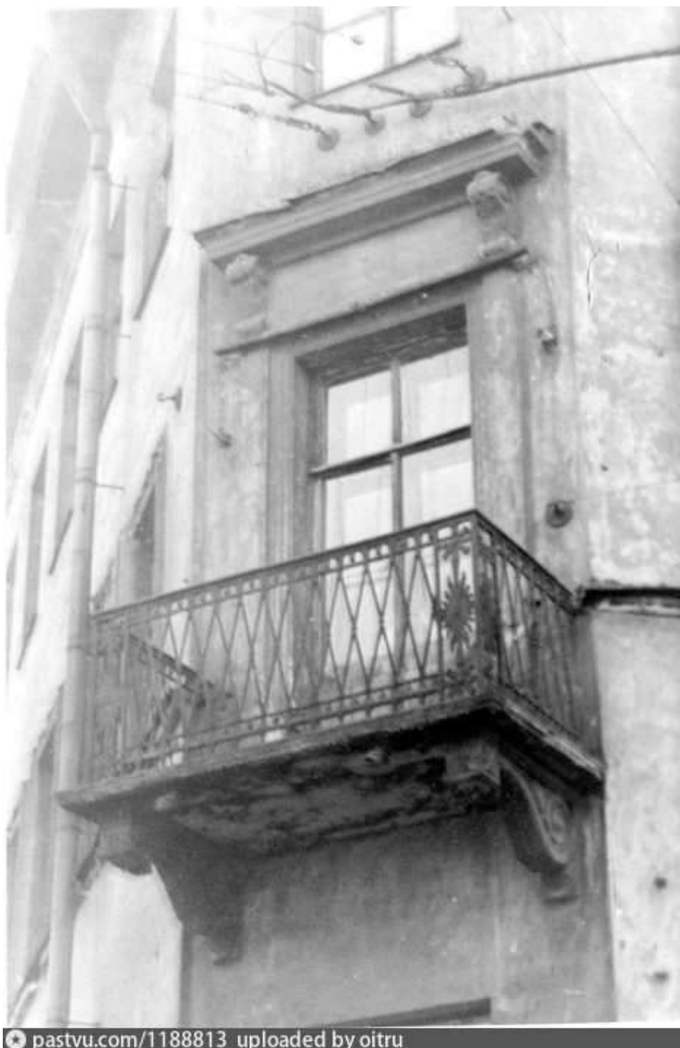
9. Балкон дома 1 по Гражданской улице. 1950г.
