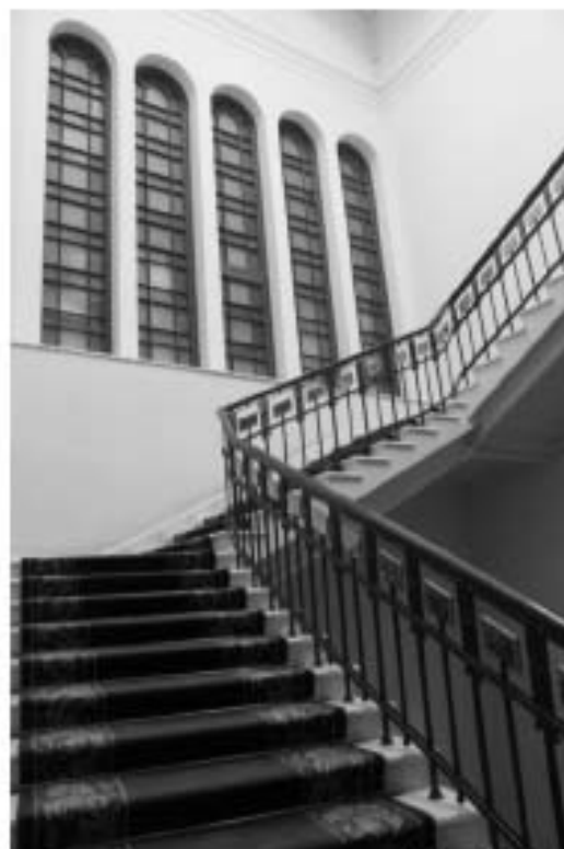
73. Парадная лестница с мраморными ступенями и металлическим ограждением. Витражное заполнение оконных проемов с полуциркульным завершением. Объект культурного наследия федерального значения «Дом, где в первой половине XIX в. размещалась Российско-Американская компания. Здесь в 1820-х гг. жили декабристы Бестужев-Марлинский А.А. и Рылеев К.Ф.», расположенный по адресу: Санкт-Петербург, Адмиралтейский район, набережная реки Мойки, дом 72, литера А. Дата съемки: 07.04.2021.
