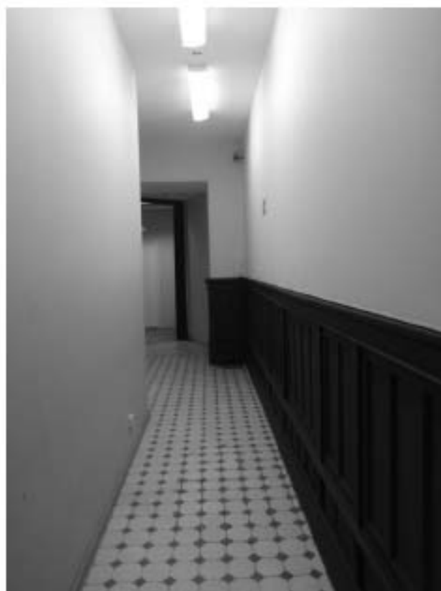
35. Коридор. Вид на запад. Объект культурного наследия федерального значения «Дом, где в первой половине XIX в. размещалась Российско-Американская компания. Здесь в 1820-х гг. жили декабристы Бестужев-Марлинский А.А. и Рылеев К.Ф.», расположенный по адресу: Санкт-Петербург, Адмиралтейский район, набережная реки Мойки, дом 72, литера А. Дата съемки: 07.04.2021.
