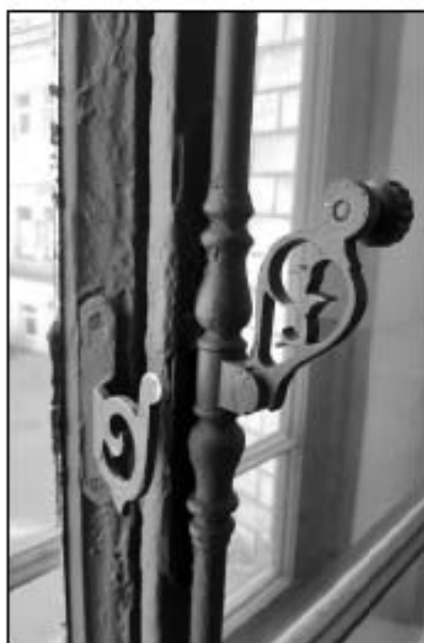
24–25. Оконные приборы оконных заполнений второго этажа. Объект культурного наследия федерального значения «Дом, где в первой половине XIX в. размещалась Российско-Американская компания. Здесь в 1820-х гг. жили декабристы Бестужев-Марлинский А.А. и Рылеев К.Ф.», расположенный по адресу: Санкт-Петербург, Адмиралтейский район, набережная реки Мойки, дом 72, литера А. Дата съемки: 07.04.2021.
