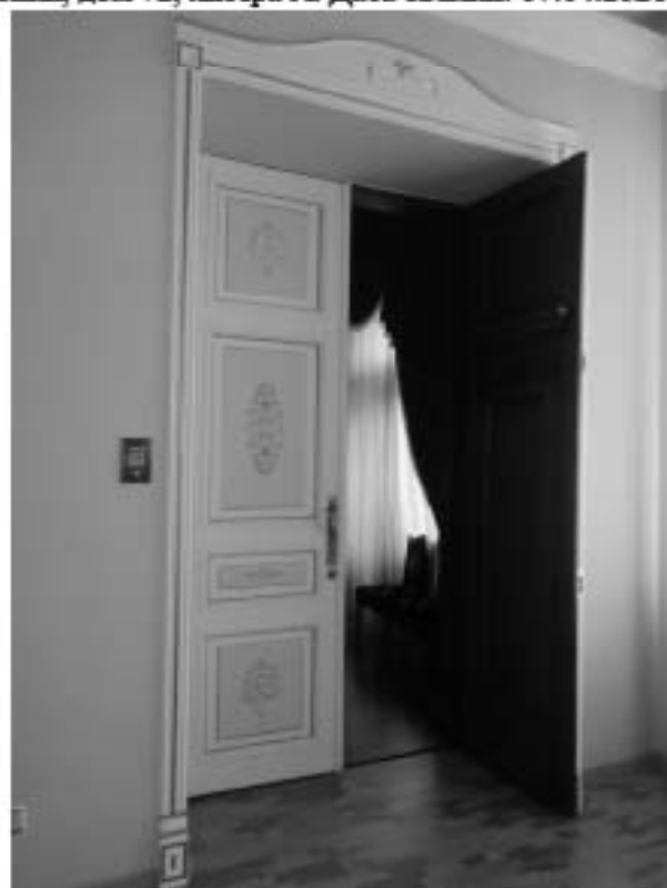
56. Входная группа помещения 2-Н(3). Объект культурного наследия федерального значения «Дом, где в первой половине XIX в. размещалась Российско-Американская компания. Здесь в 1820-х гг. жили декабристы Бестужев-Марлинский А.А. и Рылеев К.Ф.», расположенный по адресу: Санкт-Петербург, Адмиралтейский район, набережная реки Мойки, дом 72, литера А. Дата съемки: 07.04.2021.
