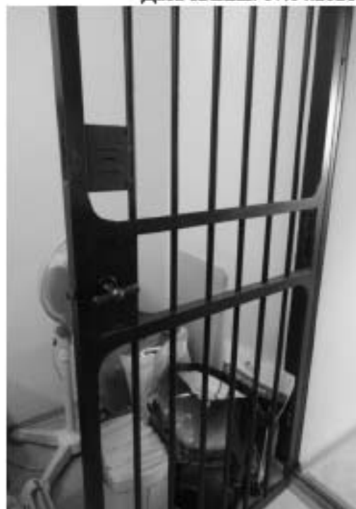
46. Решетка на лестничной клетке. Объект культурного наследия федерального значения «Дом, где в первой половине XIX в. размещалась Российско-Американская компания. Здесь в 1820-х гг. жили декабристы Бестужев-Марлинский А.А. и Рылеев К.Ф.», расположенный по адресу: Санкт-Петербург, Адмиралтейский район, набережная реки Мойки, дом 72, литера А. Дата съемки: 07.04.2021.
