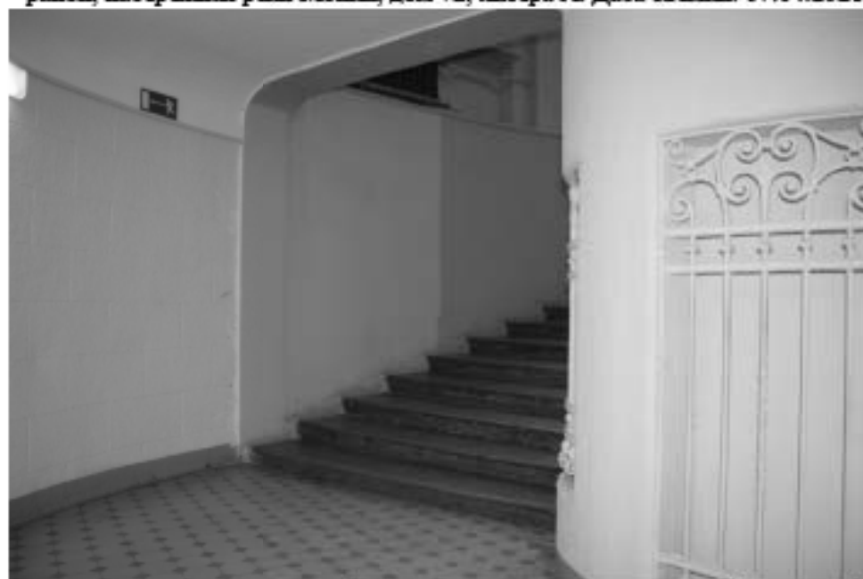
72. Полукруглая в плане лестница дворового фасада лицевого корпуса: ступени (известняк), материал облицовки площадок (метлахская плитка), решетчатый нише служебного помещения под лестницей (ковка). Объект культурного наследия федерального значения «Дом, где в первой половине XIX в. размещалась Российско-Американская компания. Здесь в 1820-х гг. жили декабристы Бестужев-Марлинский А.А. и Рылеев К.Ф.», расположенный по адресу: Санкт-Петербург, Адмиралтейский район, набережная реки Мойки, дом 72, литера А. Дата съемки: 07.04.2021.
