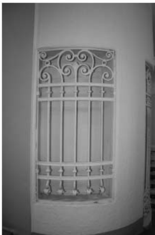
71. Кованое ограждение полукруглой в плане лестницы дворового фасада лицевого корпуса. Объект культурного наследия федерального значения «Дом, где в первой половине XIX в. размещалась Российско-Американская компания. Здесь в 1820-х гг. жили декабристы Бестужев-Марлинский А.А. и Рылеев К.Ф.», расположенный по адресу: Санкт-Петербург, Адмиралтейский район, набережная реки Мойки, дом 72, литера А. Дата съемки: 07.04.2021.
