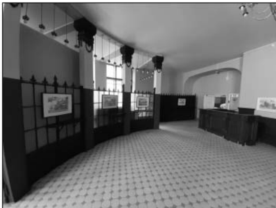
30. Второй этаж. Общий вид. Объект культурного наследия федерального значения «Дом, где в первой половине XIX в. размещалась Российско-Американская компания. Здесь в 1820-х гг. жили декабристы Бестужев-Марлинский А.А. и Рылеев К.Ф.», расположенный по адресу: Санкт-Петербург, Адмиралтейский район, набережная реки Мойки, дом 72, литера А. Дата съемки: 07.04.2021.
