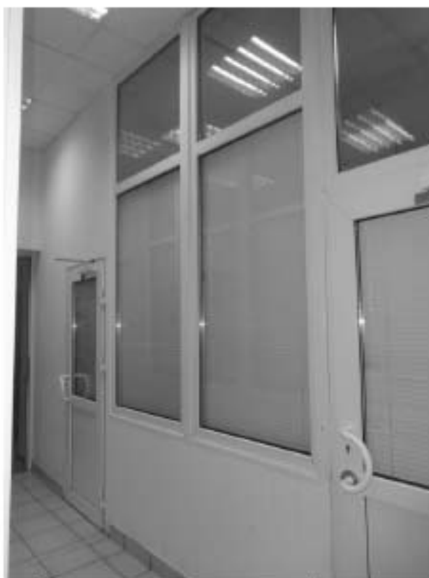
61. Коридор. Западный фасад. Вид на юг. Объект культурного наследия федерального значения «Дом, где в первой половине XIX в. размещалась Российско-Американская компания. Здесь в 1820-х гг. жили декабристы Бестужев-Марлинский А.А. и Рылеев К.Ф.», расположенный по адресу: Санкт-Петербург, Адмиралтейский район, набережная реки Мойки, дом 72, литера А. Дата съемки: 07.04.2021.
