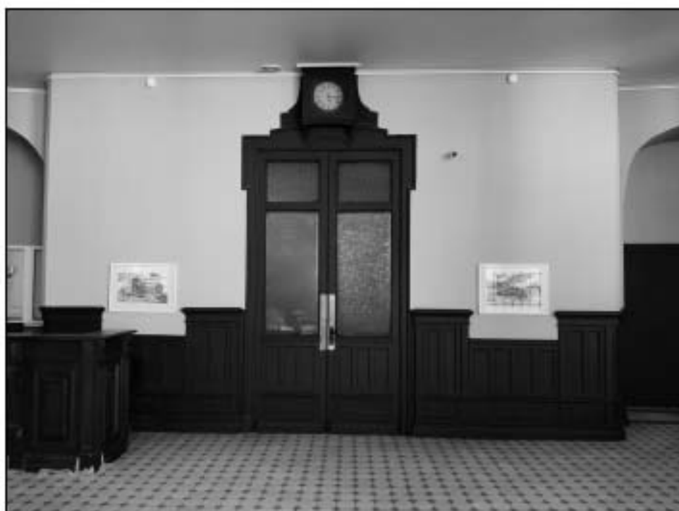
31. Второй этаж. Детали интерьера. Объект культурного наследия федерального значения «Дом, где в первой половине XIX в. размещалась Российско-Американская компания. Здесь в 1820-х гг. жили декабристы Бестужев-Марлинский А.А. и Рылеев К.Ф.», расположенный по адресу: Санкт-Петербург, Адмиралтейский район, набережная реки Мойки, дом 72, литера А. Дата съемки: 07.04.2021.
