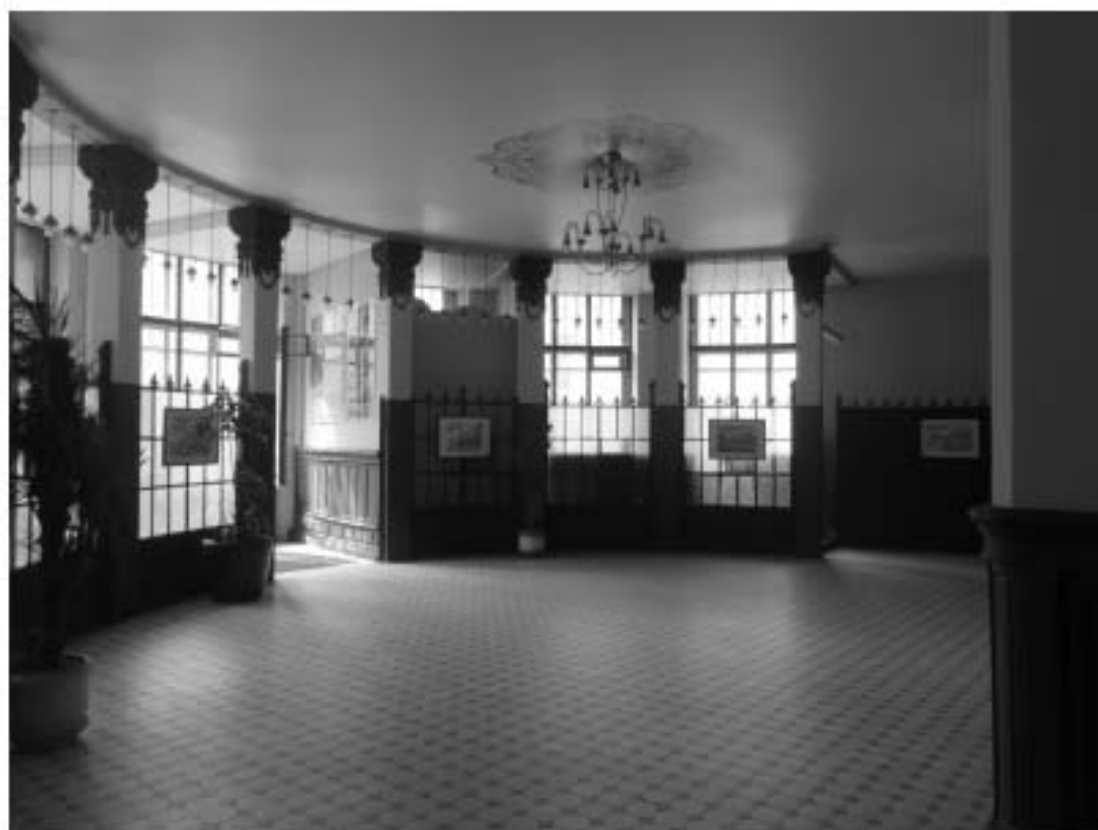
63. Помещение 1-Н (бывший «Операционный зал»). Покрытие пола – метлахская плитка, рисунок «соты». Объект культурного наследия федерального значения «Дом, где в первой половине XIX в. размещалась Российско-Американская компания. Здесь в 1820-х гг. жили декабристы Бестужев-Марлинский А.А. и Рылеев К.Ф.», расположенный по адресу: Санкт-Петербург, Адмиралтейский район, набережная реки Мойки, дом 72, литера А. Дата съемки: 07.04.2021.
