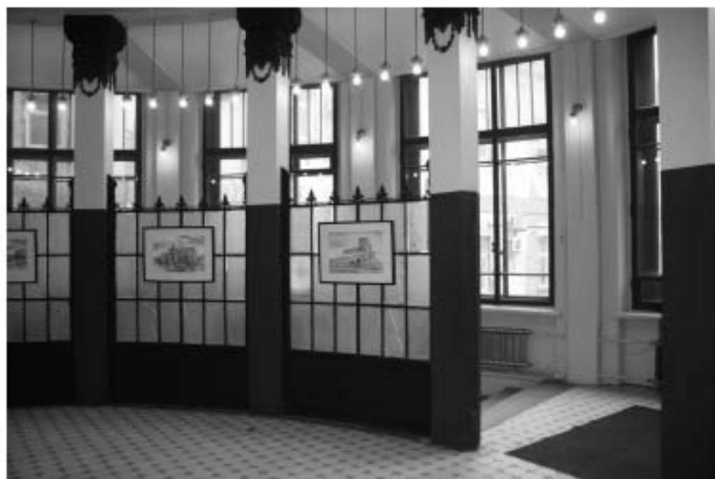
67. Помещение 1-Н (бывший «Операционный зал»). Перегородки между пилонами, с остеклением бесцветным офактуренным стеклом с рисунком «мороз». Объект культурного наследия федерального значения «Дом, где в первой половине XIX в. размещалась Российско-Американская компания. Здесь в 1820-х гг. жили декабристы Бестужев-Марлинский А.А. и Рылеев К.Ф.», расположенный по адресу: Санкт-Петербург, Адмиралтейский район, набережная реки Мойки, дом 72, литера А. Дата съемки: 07.04.2021.
