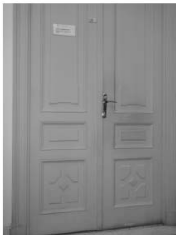
81. Дверное заполнение помещения. Объект культурного наследия федерального значения «Дом, где в первой половине XIX в. размещалась Российско-Американская компания. Здесь в 1820-х гг. жили декабристы Бестужев-Марлинский А.А. и Рылеев К.Ф.», расположенный по адресу: Санкт-Петербург, Адмиралтейский район, набережная реки Мойки, дом 72, литера А. Дата съемки: 07.04.2021.
