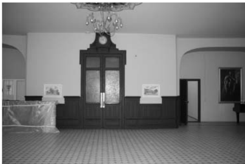
69. Помещение 1-Н (бывший «Операционный зал»). Панели стеновые тонированного дуба. Дверь с порталом. Объект культурного наследия федерального значения «Дом, где в первой половине XIX в. размещалась Российско-Американская компания. Здесь в 1820-х гг. жили декабристы Бестужев-Марлинский А.А. и Рылеев К.Ф.», расположенный по адресу: Санкт-Петербург, Адмиралтейский район, набережная реки Мойки, дом 72, литера А. Дата съемки: 07.04.2021.
