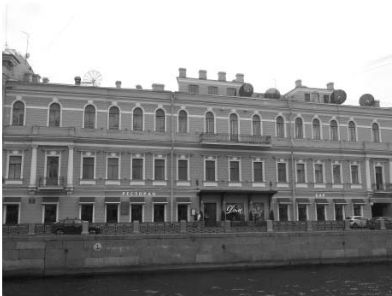
94. Лицевой фасад. 2018г.
