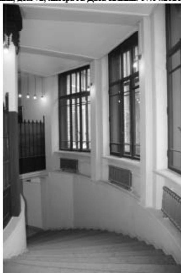
68. Полукруглая в плане лестница дворового фасада лицевого корпуса. Объект культурного наследия федерального значения «Дом, где в первой половине XIX в. размещалась Российско-Американская компания. Здесь в 1820-х гг. жили декабристы Бестужев-Марлинский А.А. и Рылеев К.Ф.», расположенный по адресу: Санкт-Петербург, Адмиралтейский район, набережная реки Мойки, дом 72, литера А. Дата съемки: 07.04.2021.
