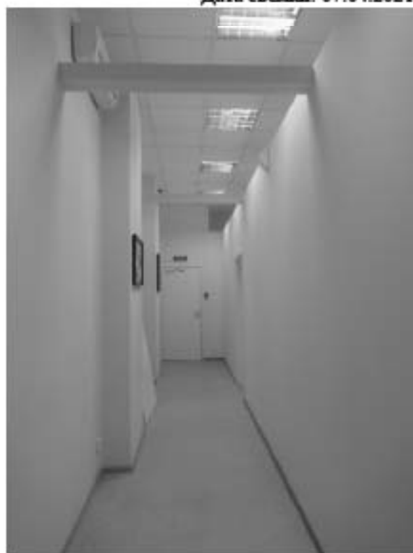
16. Коридор. Вид на север. Объект культурного наследия федерального значения «Дом, где в первой половине XIX в. размещалась Российско-Американская компания. Здесь в 1820-х гг. жили декабристы Бестужев-Марлинский А.А. и Рылеев К.Ф.», расположенный по адресу: Санкт-Петербург, Адмиралтейский район, набережная реки Мойки, дом 72, литера А. Дата съемки: 07.04.2021.
