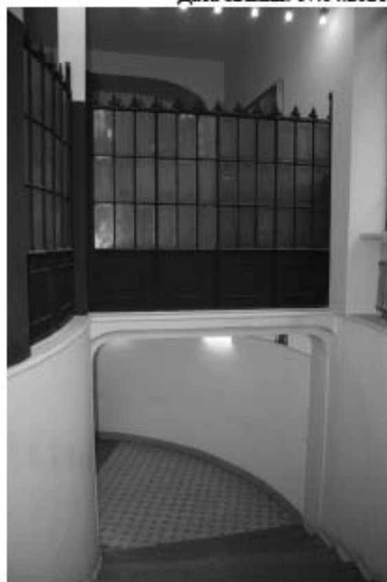
70. Перегородки помещения 1-Н (бывший «Операционный зал»). Часть полукруглой в плане лестницы дворового фасада лицевого корпуса. Объект культурного наследия федерального значения «Дом, где в первой половине XIX в. размещалась Российско-Американская компания. Здесь в 1820-х гг. жили декабристы Бестужев-Марлинский А.А. и Рылеев К.Ф.», расположенный по адресу: Санкт-Петербург, Адмиралтейский район, набережная реки Мойки, дом 72, литера А. Дата съемки: 07.04.2021.
