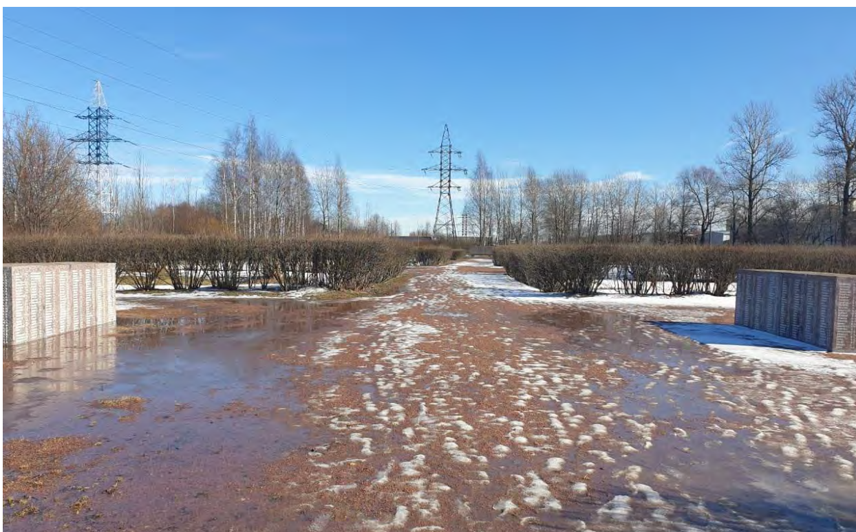
Фото 10. Вид по оси центральной аллеи.
