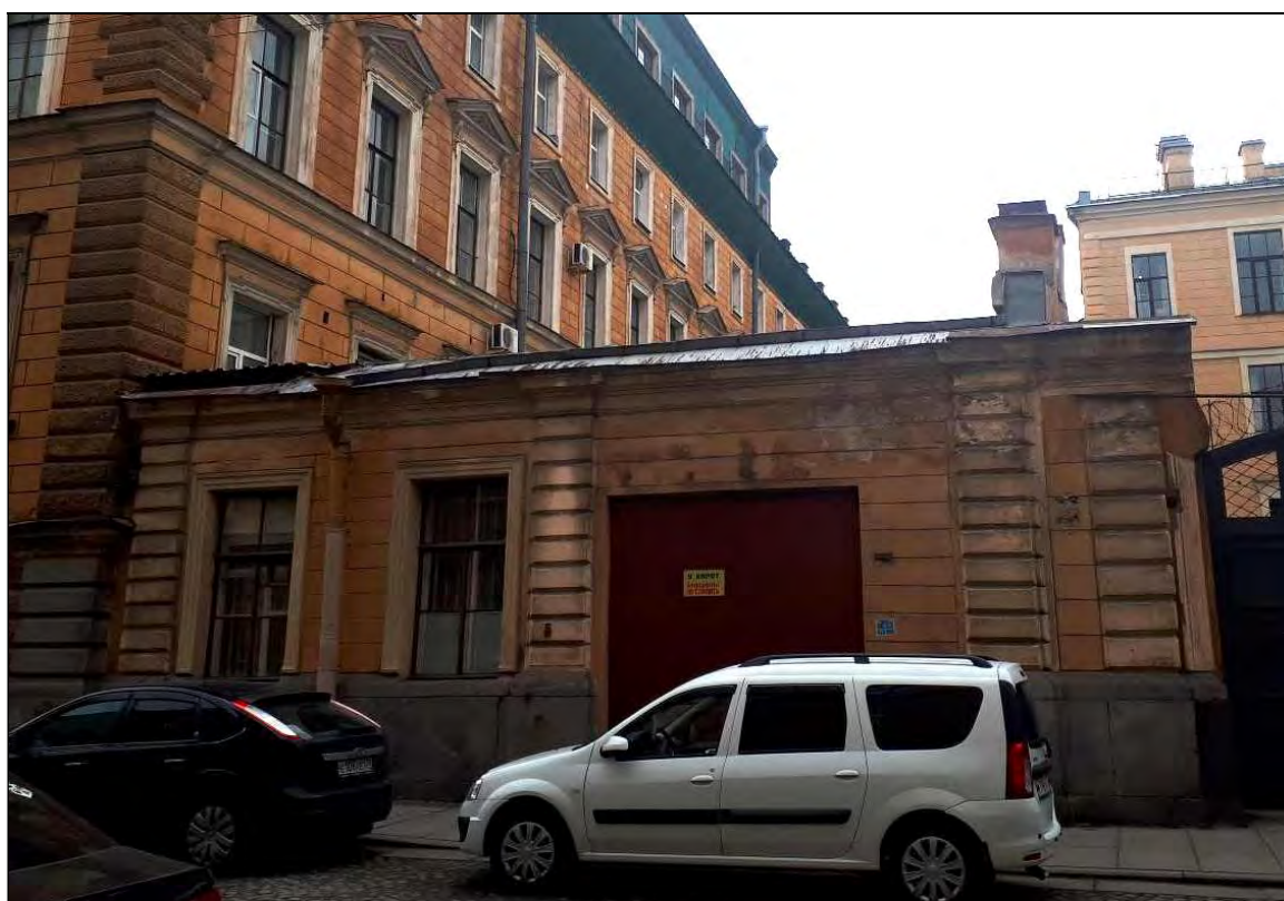
13. Объект культурного наследия «Корпус для прислуги», в составе комплекса «Дворец Великого князя Николая Николаевича (Ксенинский институт)», расположенного по адресу: г. Санкт-Петербург, площадь Труда, дом 4, литера А. Пристройка к западному фасаду. Вид на юго-восток от улицы Галерной. 20.04.2021 г.
