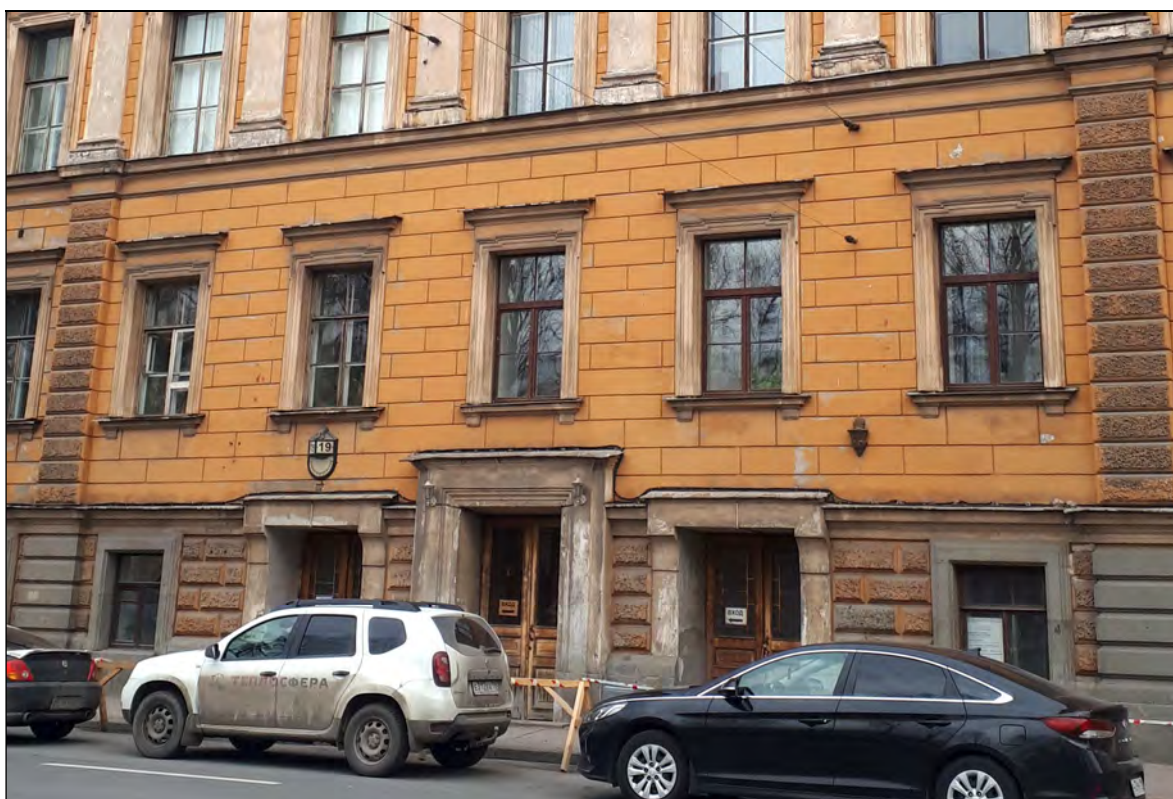
3. Объект культурного наследия «Корпус для прислуги», в составе комплекса «Дворец Великого князя Николая Николаевича (Ксенинский институт)», расположенного по адресу: г.Санкт-Петербург, площадь Труда, дом 4, литера А. Фрагмент южного лицевого фасада. Три дверных проема. 20.04.2021 г.
