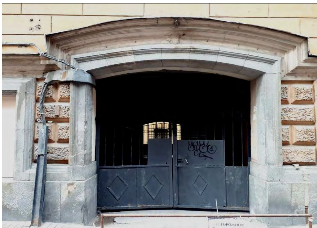
8. Объект культурного наследия «Корпус для прислуги», в составе комплекса «Дворец Великого князя Николая Николаевича (Ксенинский институт)», расположенного по адресу: г.Санкт-Петербург, площадь Труда, дом 4, литера А. Фрагмент восточного лицевого фасада. Северная проездная арка. 20.04.2021 г.
