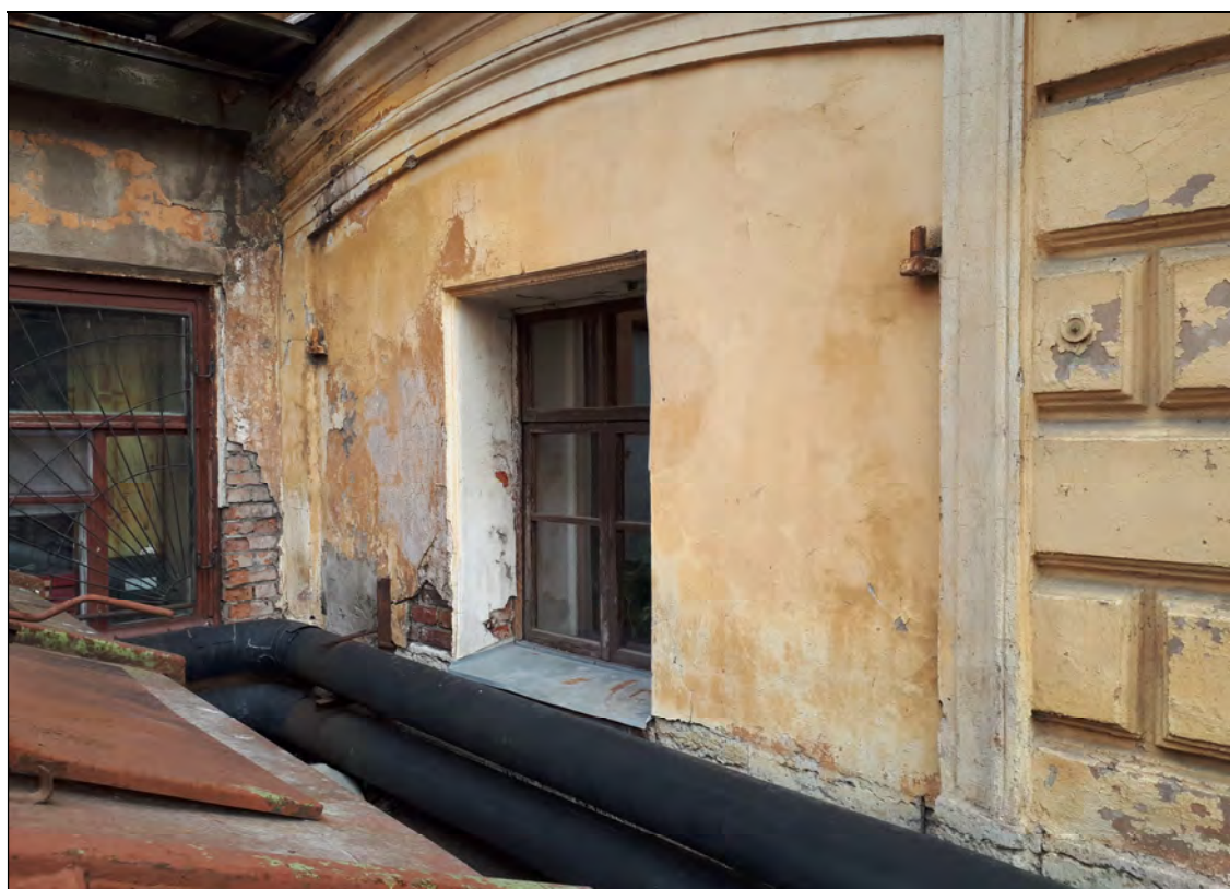
18. Объект культурного наследия «Корпус для прислуги», в составе комплекса «Дворец Великого князя Николая Николаевича (Ксенинский институт)», расположенного по адресу: г. Санкт-Петербург, площадь Труда, дом 4, литера А. Северная часть западного лицевого фасада. Оконный проем 1-го этажа. 20.04.2021 г.
