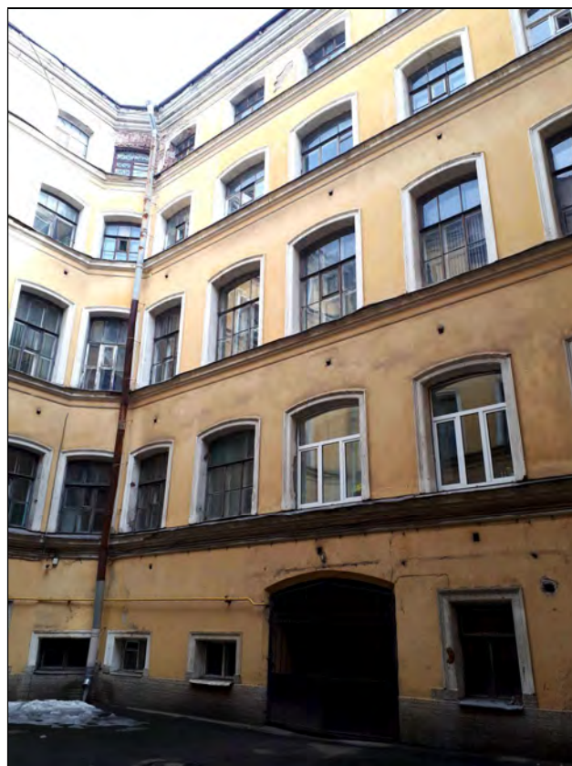
34. Объект культурного наследия «Корпус для прислуги», в составе комплекса «Дворец Великого князя Николая Николаевича (Ксенинский институт)», расположенного по адресу: г. Санкт-Петербург, площадь Труда, дом 4, литера А. Восточная часть южного внутреннего двора. Вид на северо-восток. 20.04.2021 г.
