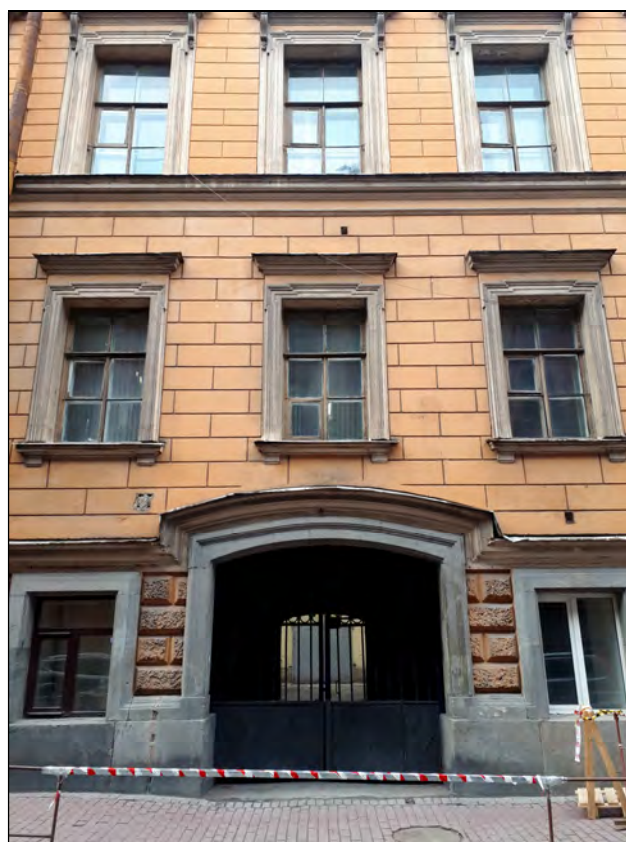
7. Объект культурного наследия «Корпус для прислуги», в составе комплекса «Дворец Великого князя Николая Николаевича (Ксенинский институт)», расположенного по адресу: г.Санкт-Петербург, площадь Труда, дом 4, литера А. Фрагмент восточного лицевого фасада. Южная проездная арка. 20.04.2021 г.
