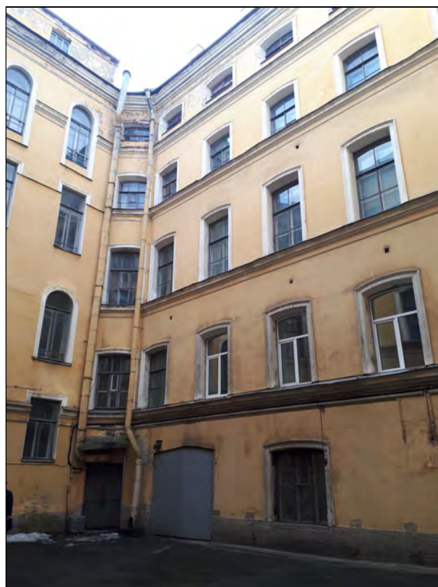
37. Объект культурного наследия «Корпус для прислуги», в составе комплекса «Дворец Великого князя Николая Николаевича (Ксенинский институт)», расположенного по адресу: г. Санкт-Петербург, площадь Труда, дом 4, литера А. Юго-западная часть южного внутреннего двора. Вид на юго-запад. 20.04.2021 г.
