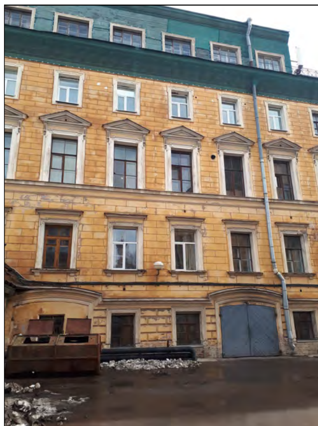
17. Объект культурного наследия «Корпус для прислуги», в составе комплекса «Дворец Великого князя Николая Николаевича (Ксенинский институт)», расположенного по адресу: г. Санкт-Петербург, площадь Труда, дом 4, литера А. Северная часть западного лицевого фасада. Вид на восток. 20.04.2021 г.
