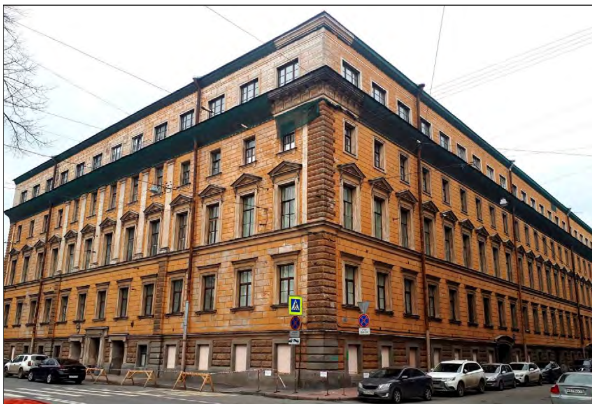
1. Объект культурного наследия «Корпус для прислуги», в составе комплекса «Дворец Великого князя Николая Николаевича (Ксенинский институт)», расположенного по адресу: г.Санкт-Петербург, площадь Труда, дом 4, литера А. Южный и восточный лицевые фасады. Вид на северо-запад от Конногвардейского бульвара. 20.04.2021 г.
