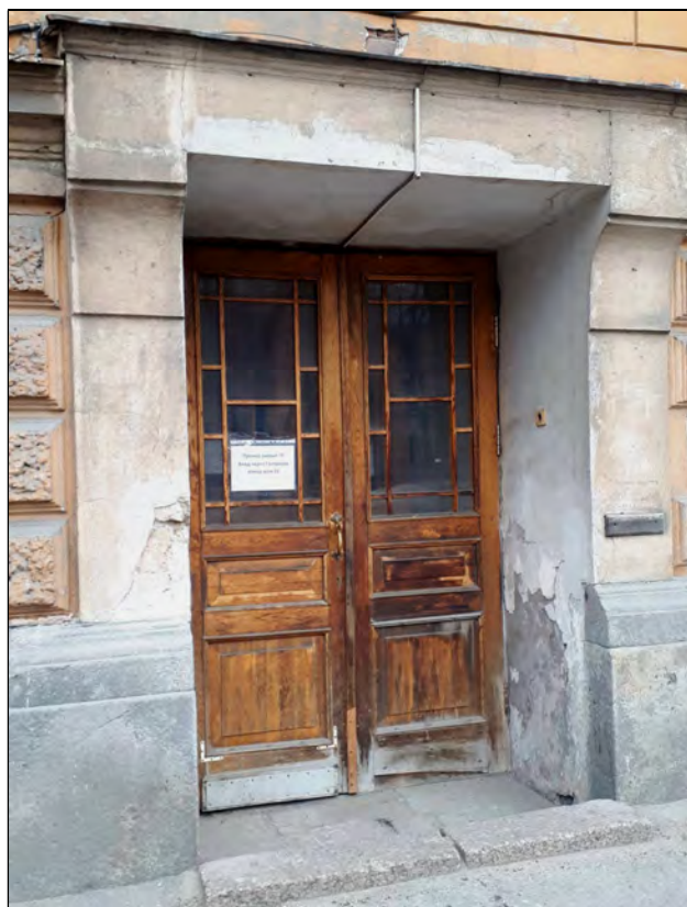
4. Объект культурного наследия «Корпус для прислуги», в составе комплекса «Дворец Великого князя Николая Николаевича (Ксенинский институт)», расположенного по адресу: г.Санкт-Петербург, площадь Труда, дом 4, литера А. Фрагмент южного лицевого фасада. Западный дверной проем. 20.04.2021 г.
