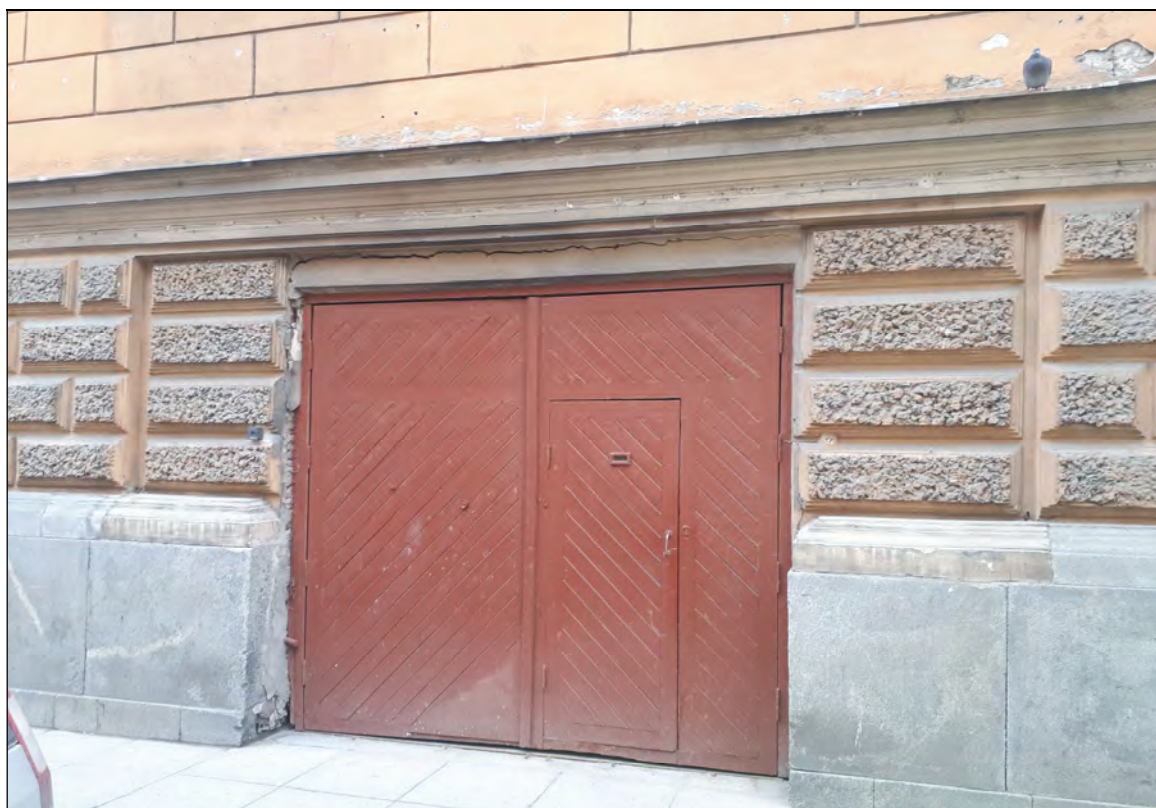
11. Объект культурного наследия «Корпус для прислуги», в составе комплекса «Дворец Великого князя Николая Николаевича (Ксенинский институт)», расположенного по адресу: г. Санкт-Петербург, площадь Труда, дом 4, литера А. Фрагмент северного лицевого фасада. Западные ворота. 20.04.2021 г.
