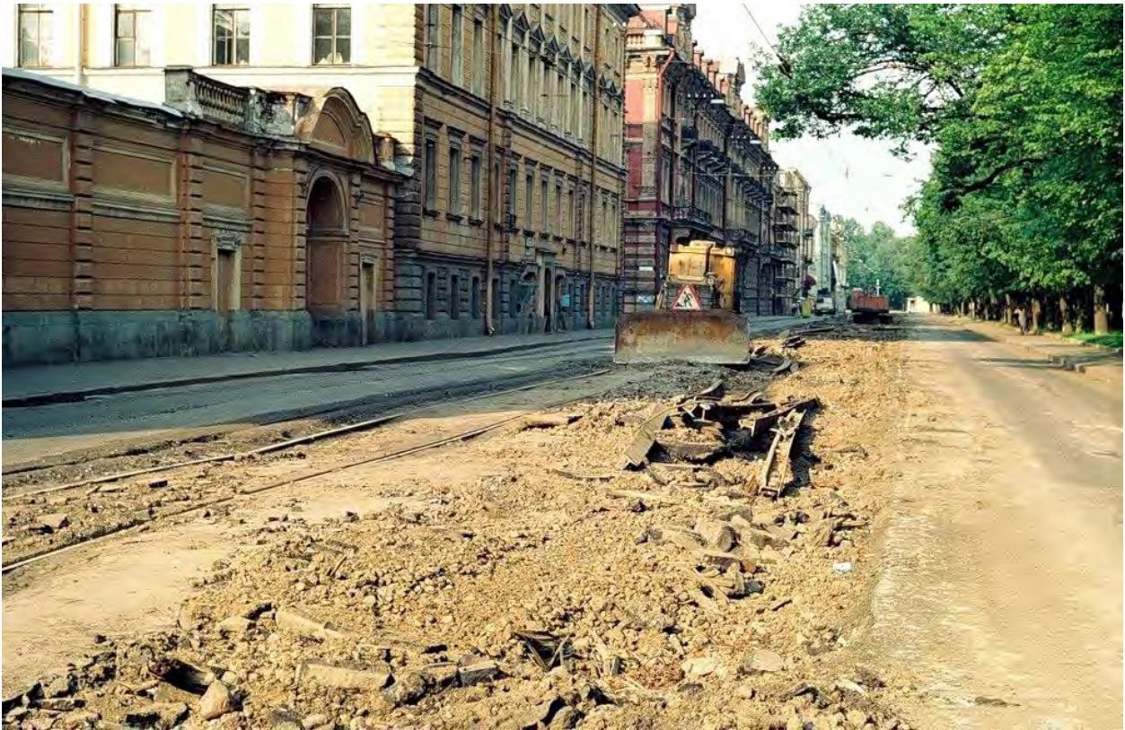
Илл. 57. Демонтаж трамвайной линии на Конногвардейском бульваре. 1987 г., URL: https://pastvu.com/p/129637 . Дата обращения: 12.04.2021 г.
