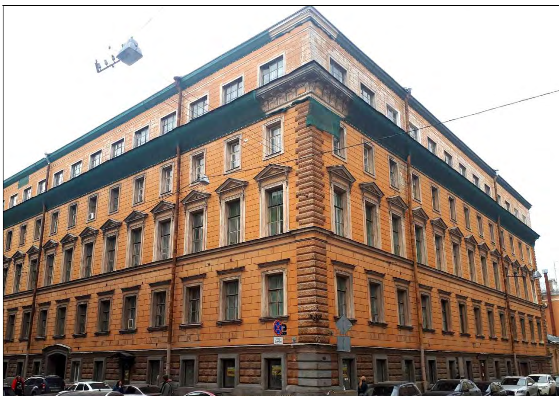
6. Объект культурного наследия «Корпус для прислуги», в составе комплекса «Дворец Великого князя Николая Николаевича (Ксенинский институт)», расположенного по адресу: г. Санкт-Петербург, площадь Труда, дом 4, литера А. Северный и восточный лицевые фасады. Вид на юго-запад от перекрестка улицы Галерной и Замытина переулка 20.04.2021 г.
