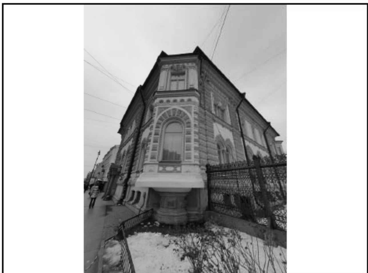
Фото 3 – юго-западный фасад. Дом 60-62
