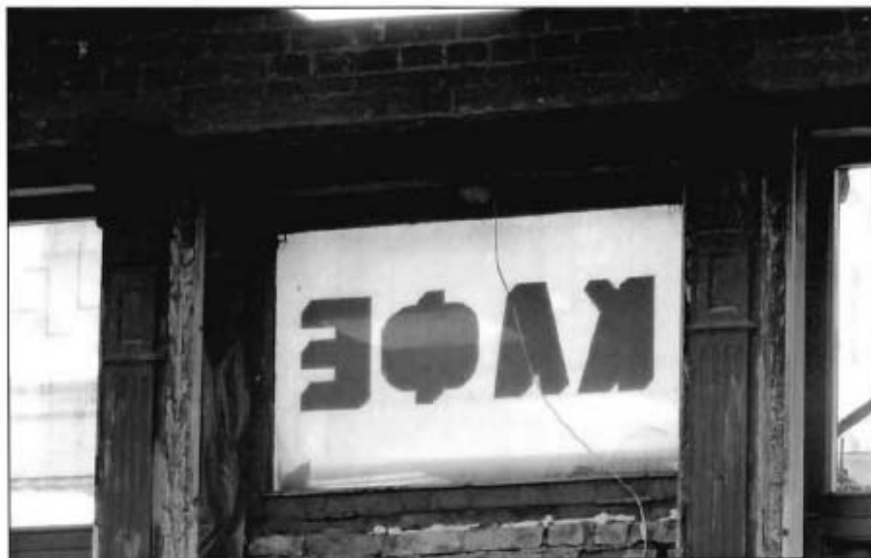
4. Интерьер. Фрагмент. Каннелированные чугунные пилястры.
