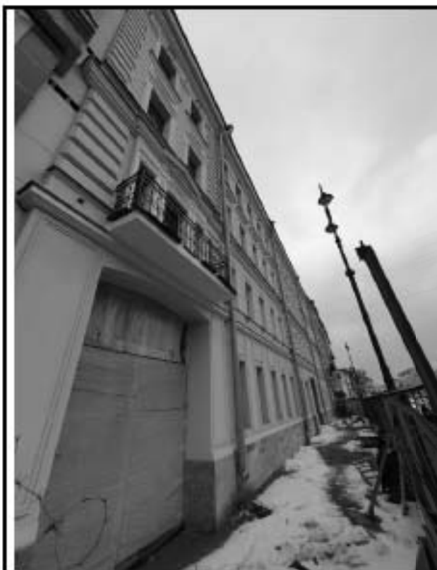
Фото 13 – западный фасад. Дом 56
