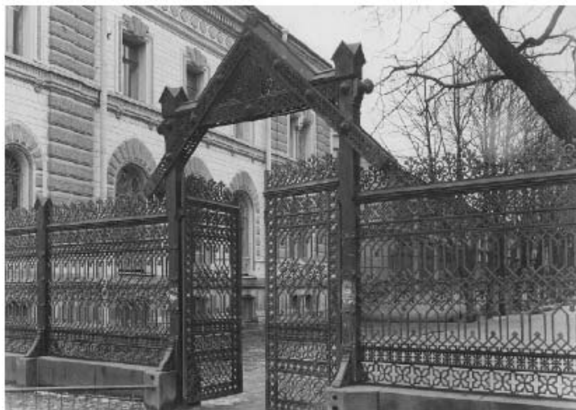
Илл. 68. Ограда Сада Сан-Галли. Вид со стороны Лиговского проспекта. Фото 1999 г. КГИОП. Паспорт. Завод Чугуно-литейный и механический Ф.К. Сан-Галли. Комплекс. 294-1. Инв. № 878п. Составитель Луцко Е.И.
