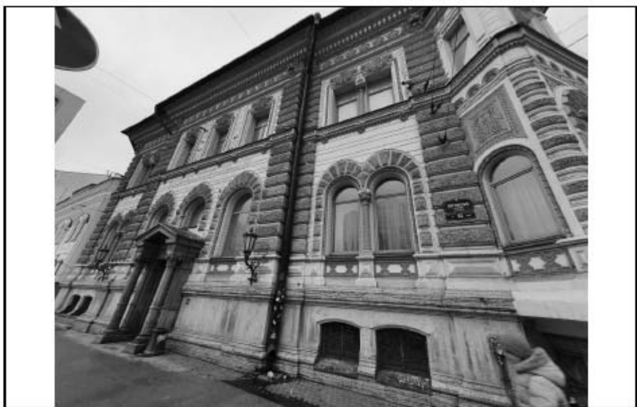
Фото 4 – западный фасад. Дом 60-62
