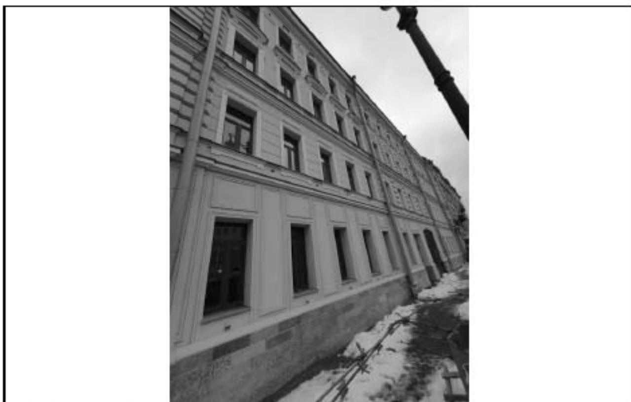
Фото 12 – западный фасад Дом 56
