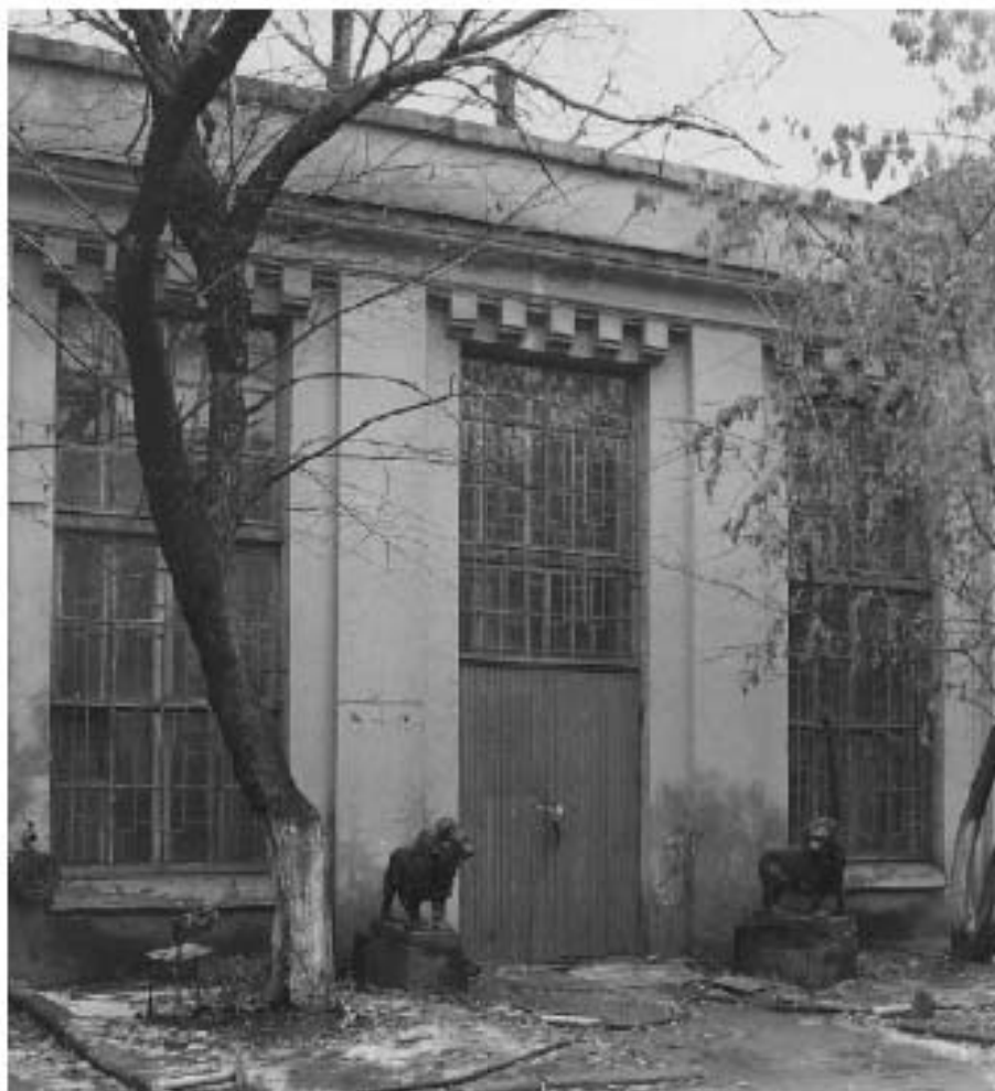
Илл. 76. Здание конторы. Юго-западный фасад пристройки. Фото 1999 г. КТИОП. Паспорт. Завод Чугуно-литейный и механический Ф.К. Сан-Галли. Контора. 294-3. Инв. № 880п. Составитель Луцко Е.И.
