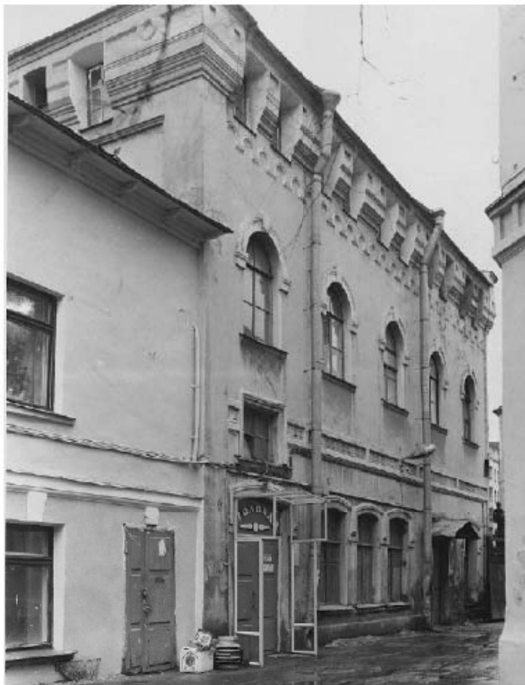
Илл. 71. Боковой (северо-восточный) фасад здания заводоуправления. Фото 1999 г. КГИОП. Паспорт. Завод Чугуно-литейный и механический Ф.К. Сан-Галли. Комплекс. 294-1. Инв. № 878п. Составитель Луцко Е.И.
