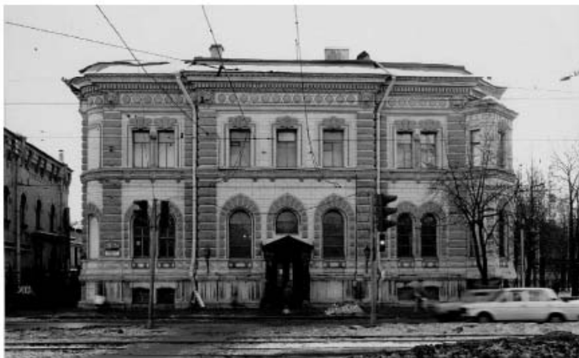
Илл. 66. Главный (северо-западный) фасад особняка Ф.К. Сан-Галли. Фото 1999 г. КГИОП. Паспорт Завод Чугуно-литейный и механический Ф.К. Сан-Галли. Особняк. 294-2. Инв. № 879п. Составитель Луцко Е.И.
