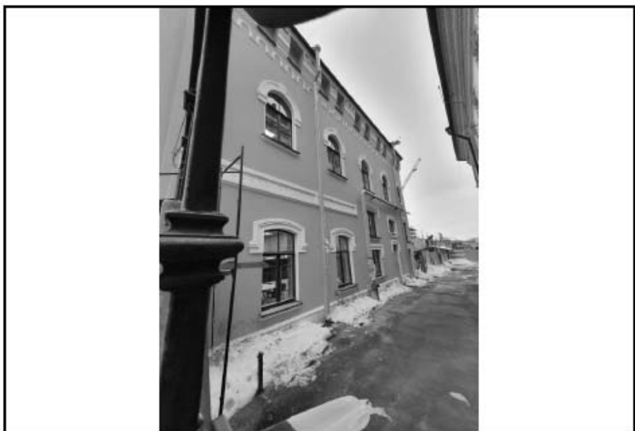
Фото 7 – южный фасад. Дом 60-62Б
