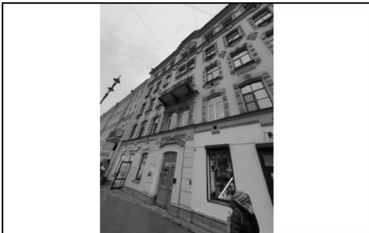
Фото 11 – западный фасад Дом 58
