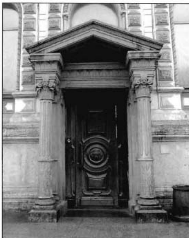
4. Общий вид лицевого фасада объекта культурного наследия. Фрагмент. Главный вход.
