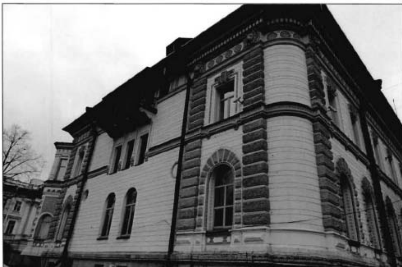
3. Общий вид объекта культурного наследия с северо-востока.
