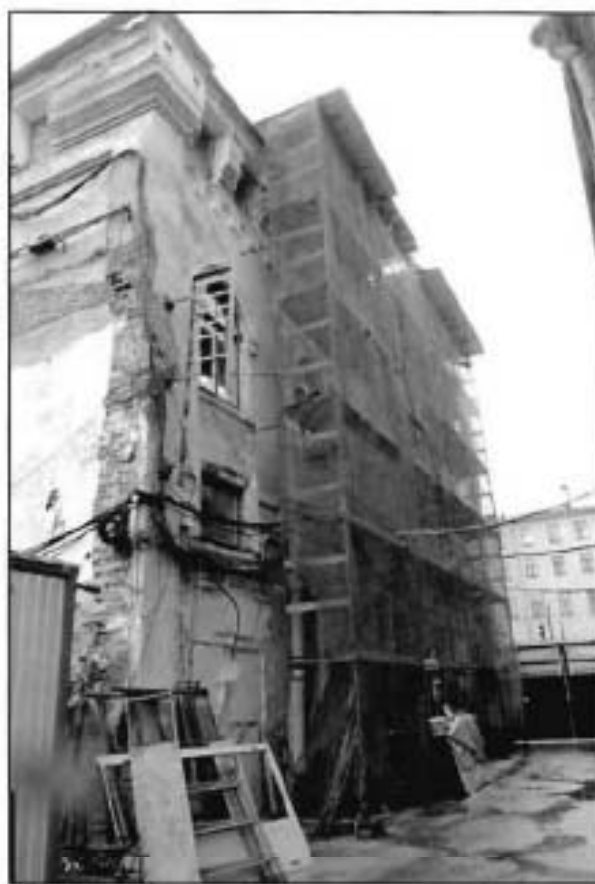
3. Общий вид северо-восточного фасада объекта культурного наследия.
