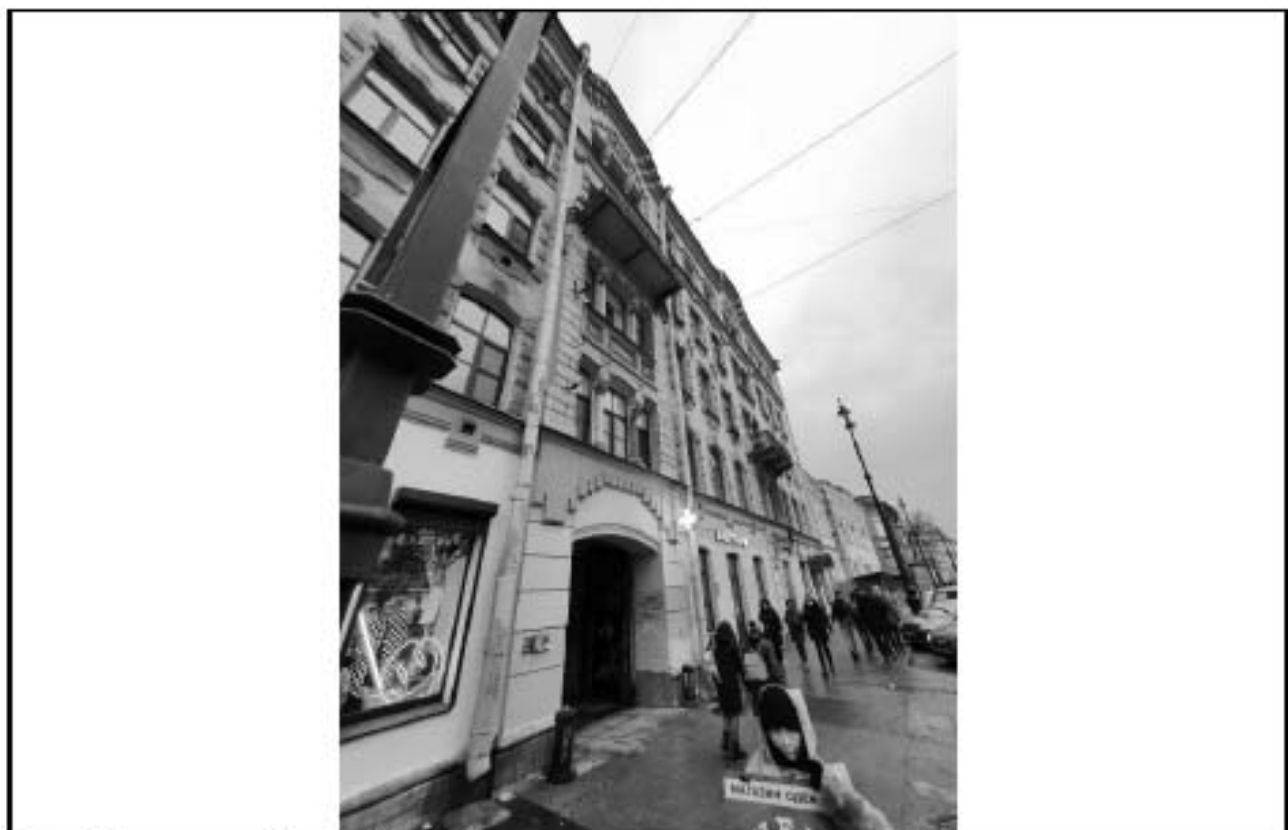
Фото 10 – западный фасад. Дом 58
