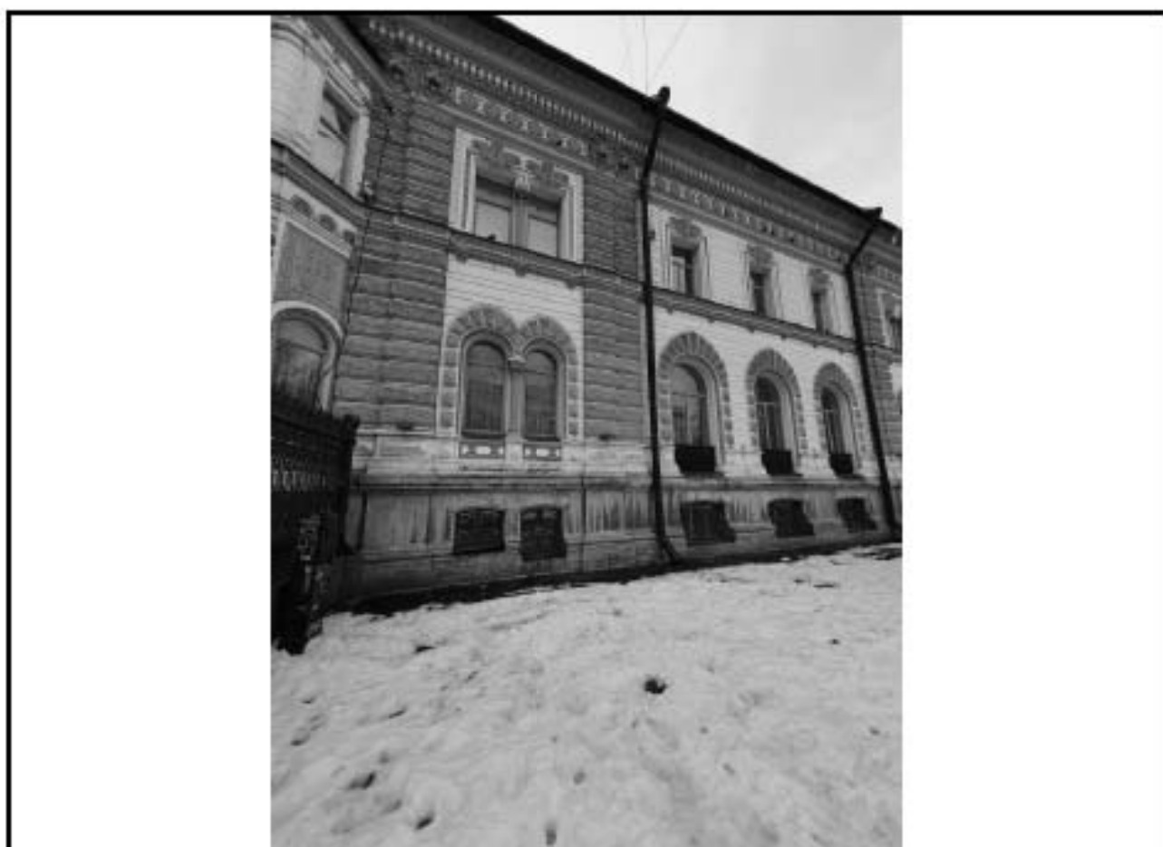
Фото 2 – южный фасад, Дом 60-62
