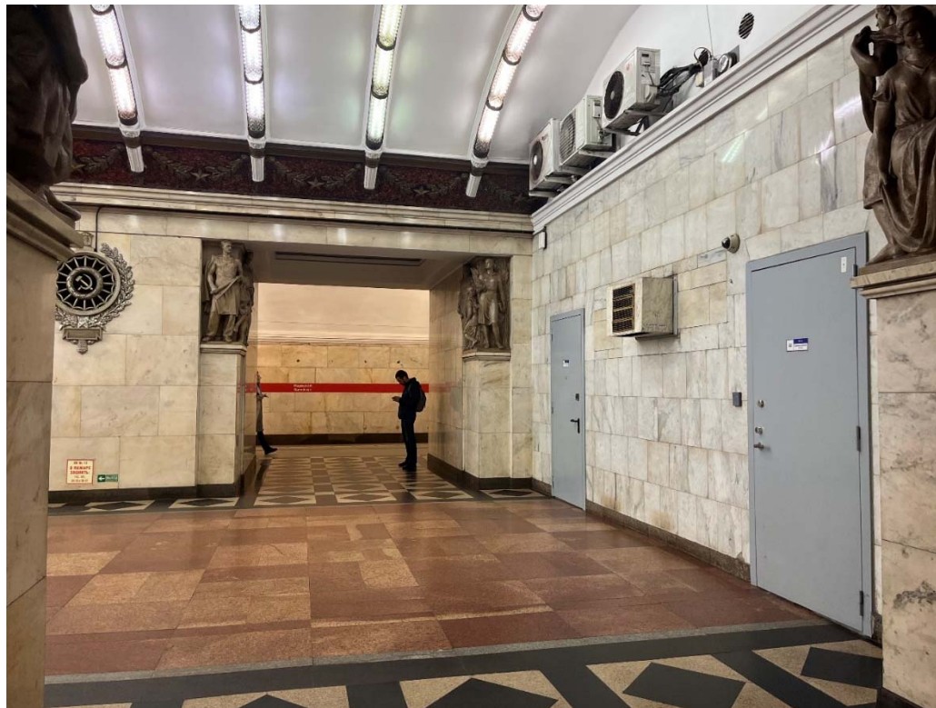
Фото №18. Второй подземный этаж, вестибюль платформы, общий вид.
