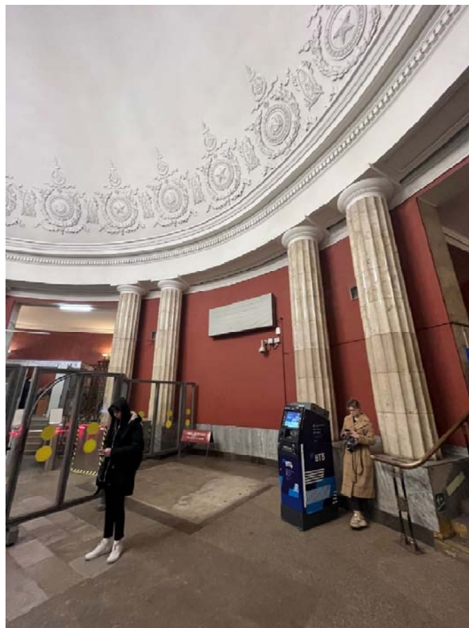
Фото №12. Первый этаж, вестибюль.
