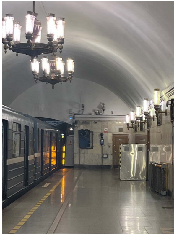
Фото №20. Второй подземный этаж, вестибюль платформы.
