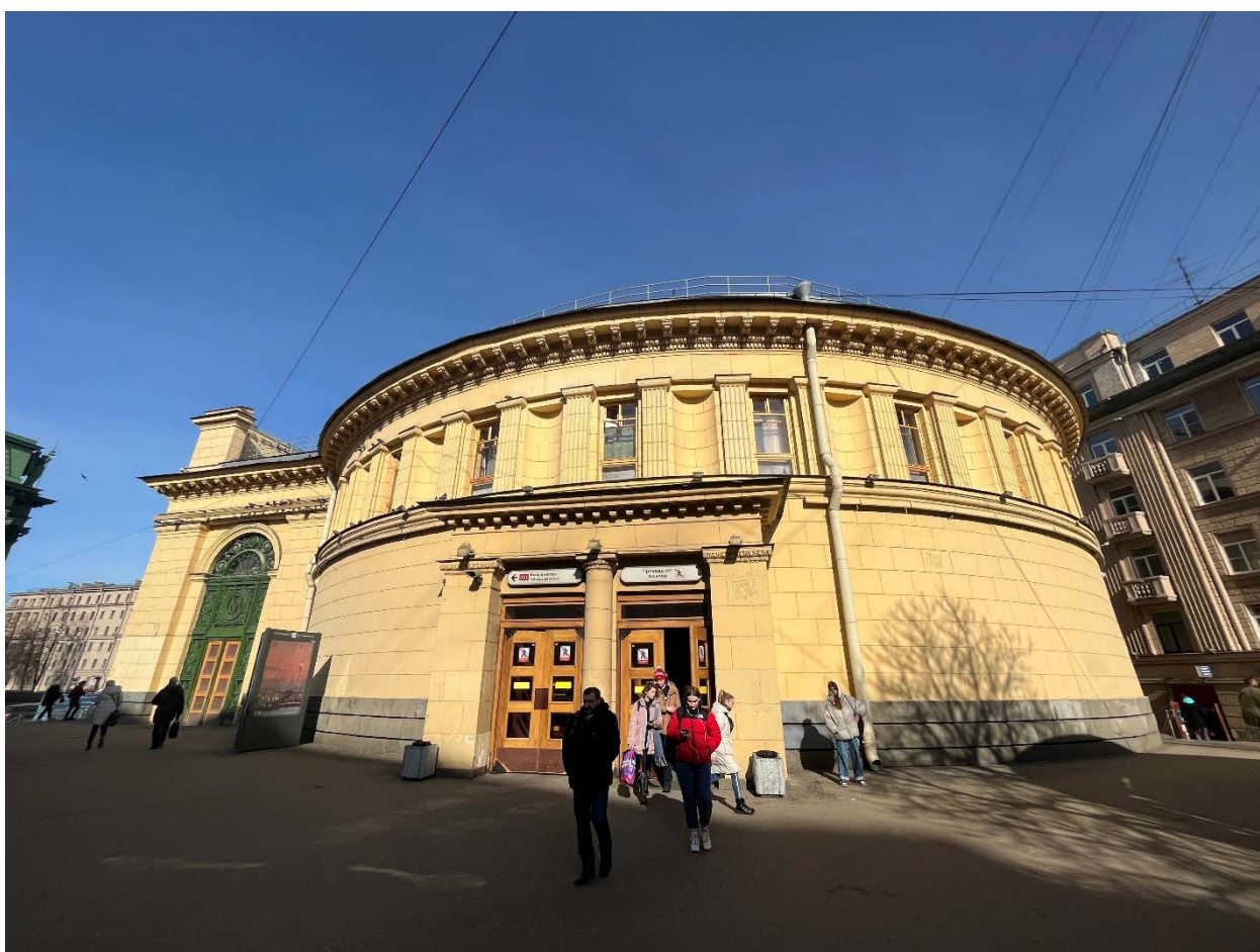
Фото №3. Юго-восточный фасад здания, общий вид.
