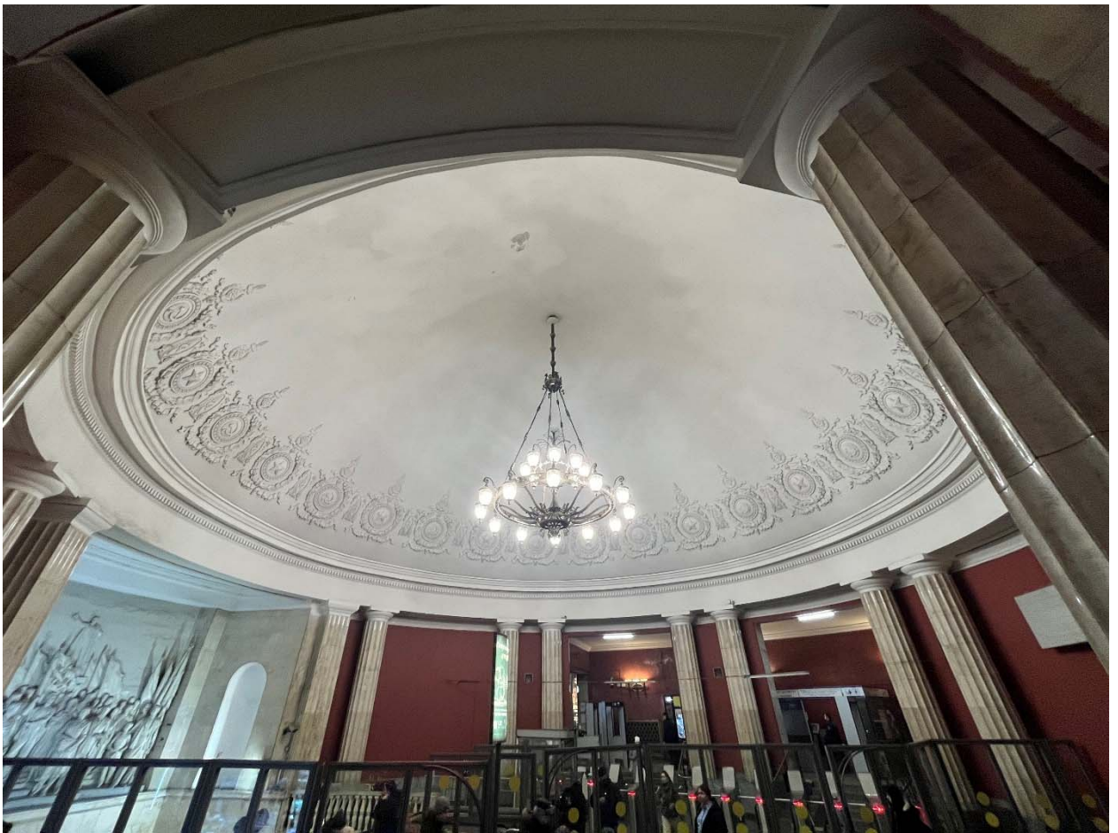
Фото №9. Первый этаж, вестибюль, купол свода.
