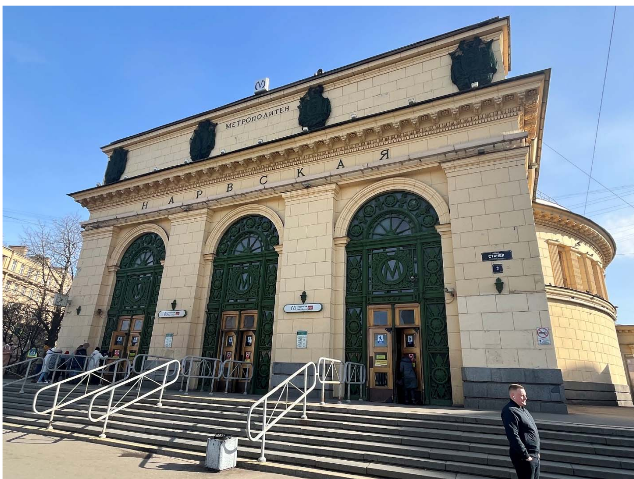
Фото №4. Северо-западный фасад здания, общий вид.
