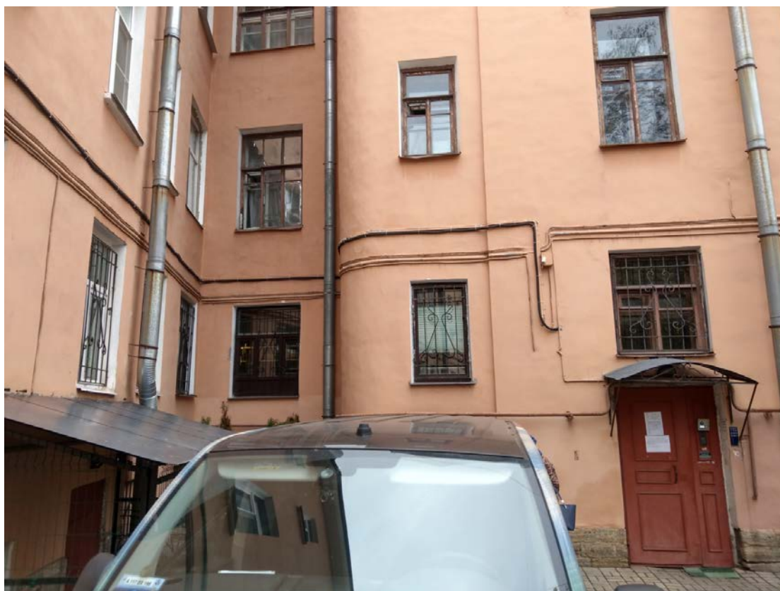
Фото 2 Фрагмент дворового фасада выявленного объекта культурного наследия «Жилой дом» расположенного по адресу: г. Санкт-Петербург, ул. Садовая, д. 125, лит. А
