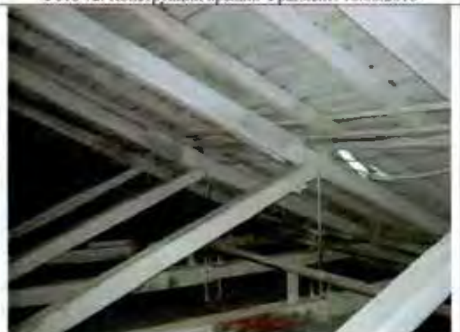
Фото 74. Конструкции крыши. Фрагмент. 10.06.2016
