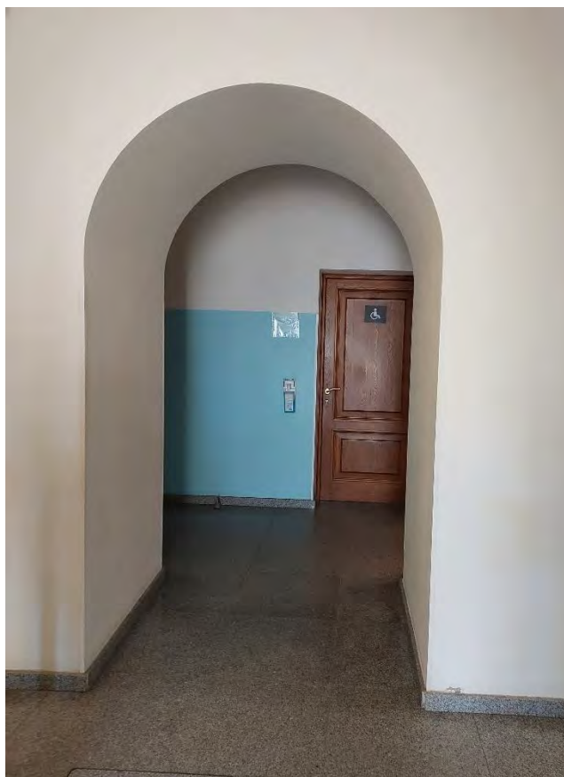
Илл. 5. Вид на входной проем в помещение №212.
