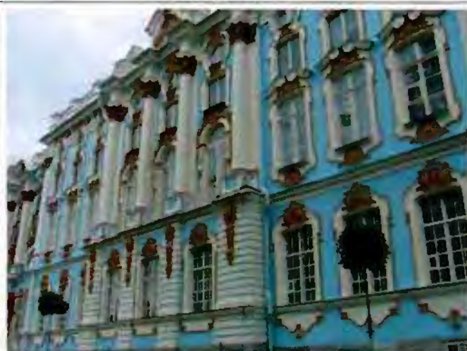
Фото 9. Северный флигель. Общий вид со стороны парка. 10.06.2016
