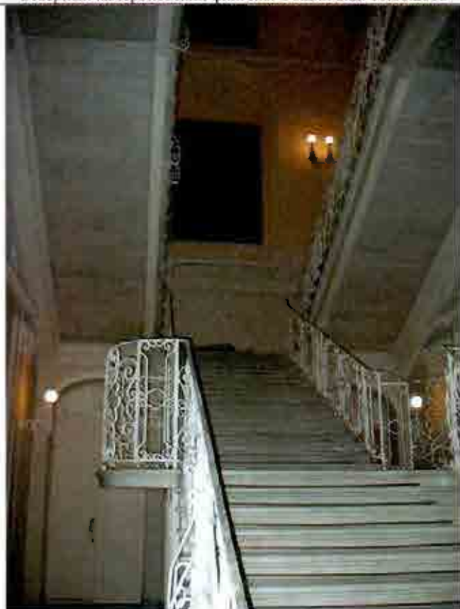
Фото 30. Пом. 1-Н (95, 294). Стасовская лестница. Северный камероновский флигель. Общий вид. 10.06.2016
