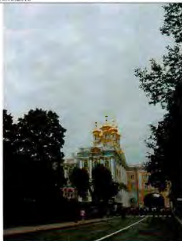
Фото 27. Церковный корпус. Общий вид со стороны Садовой улицы. 10.06.2016
