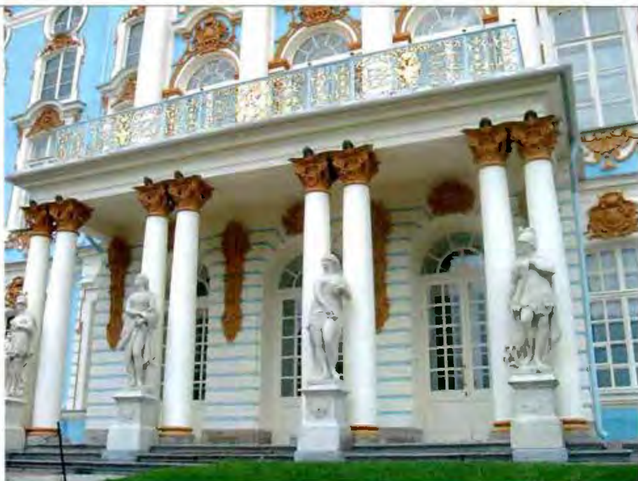
Фото 13. Балкон с ажурным кованым металлическим ограждением. Средний дом. Общий вид со стороны парка. 10.06.2016
