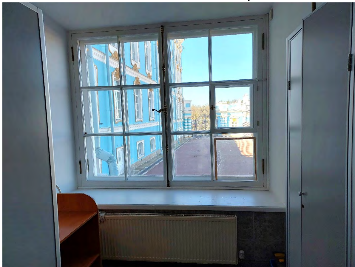
Илл. 8. Вид на помещение №213. Оконный проем и заполнение.
