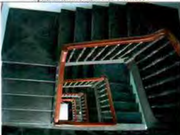
Фото 67. Лестница в Пом. I-II (207, 313, 390). Южный камероновский флигель. Общий вид. 10.06.2016
