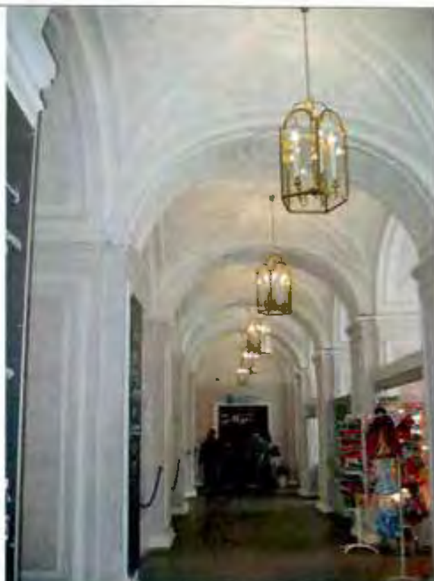
Фото 36. Пом. 1-Н (172), Южная галерея. Общий вид. 10.06.2016
