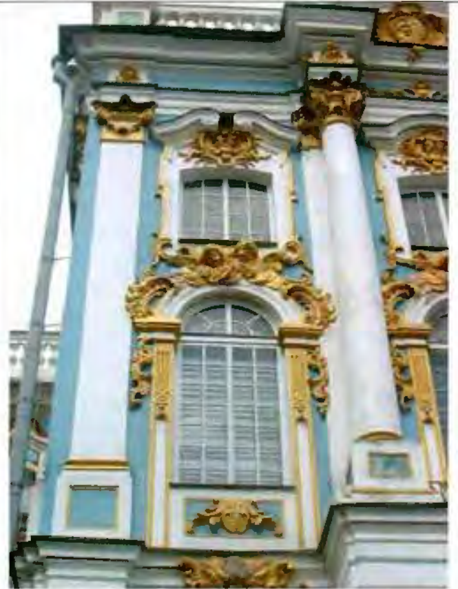
Фото 4. Оформление оконных проемов церковного флигеля. Общий вид. 10.06.2016
