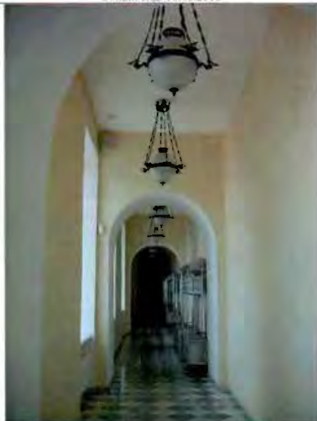
Фото 38. Помещение 1-го этажа, Zubовский флигель. Общий вид. 10.06.2016
