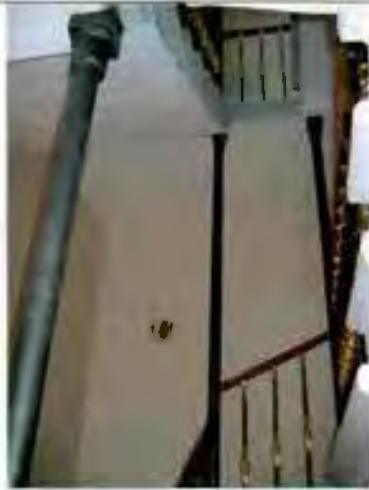
Фото 69. Лестница в Пом. 1-Н (242, 330, 401). Зубовский флигель. Общий вид. 10.06.2016
