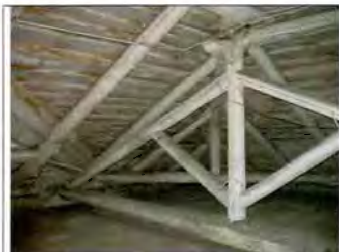
Фото 75. Конструкции крыши. Фрагмент. 10.06.2016
