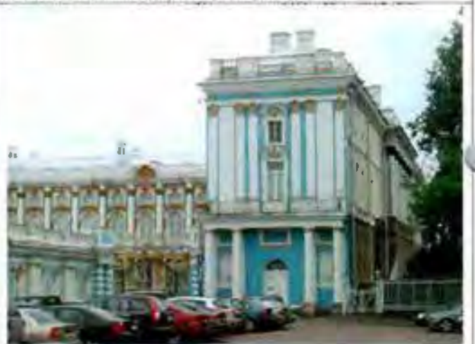
Фото 17. Западный торцевой фасад. Общий вид. 10.06.2016
