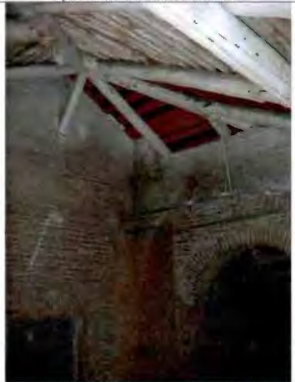
Фото 72. Конструкции крыши. Фрагмент. 10.06.2016
