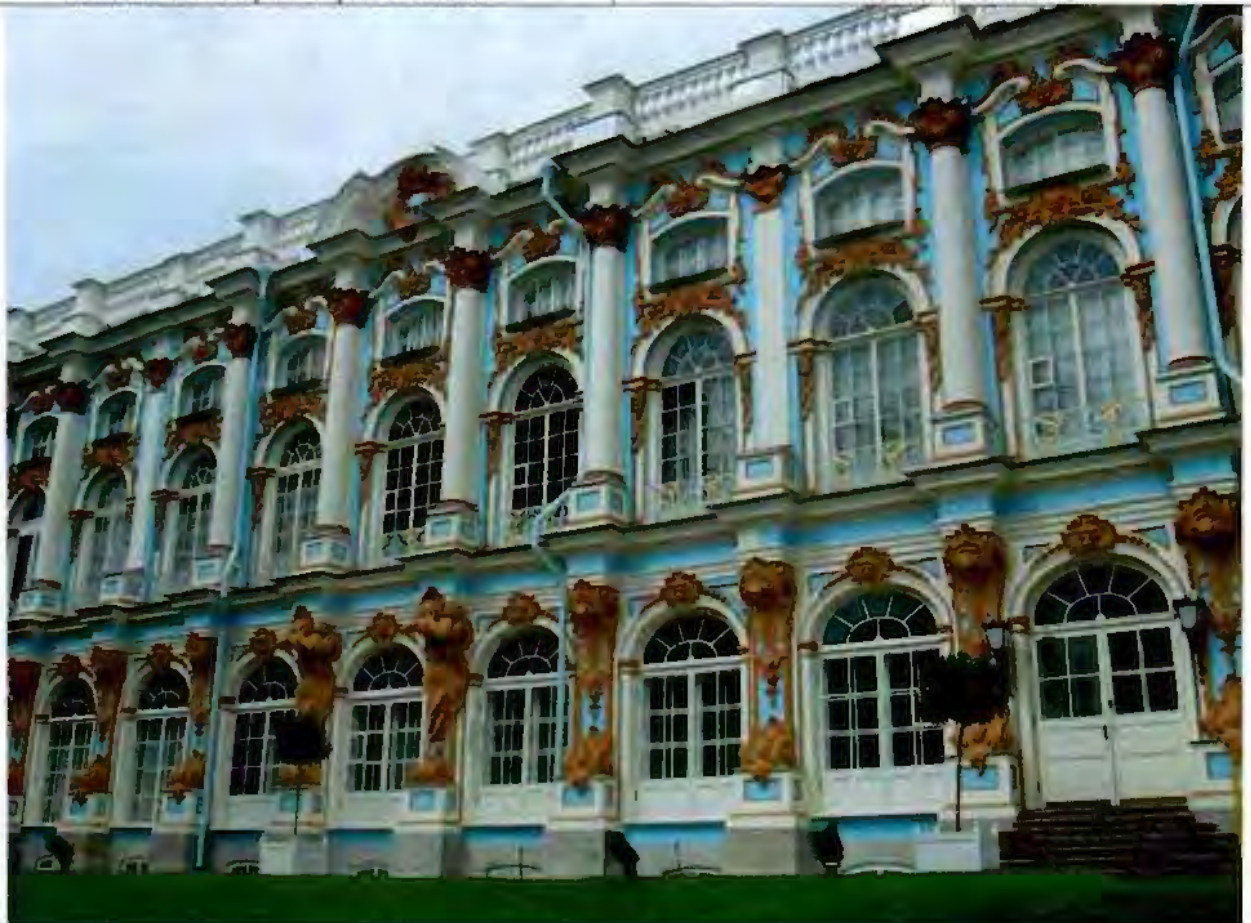
Фото 5. Северный Кастероновский флигель. Общий вид со стороны парка. 10.06.2016
