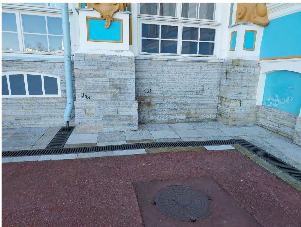
Илл. 3. Общий вид на северо-западный фасад Екатерининского дворца. Вид на отмостку и систему водоотведения.
