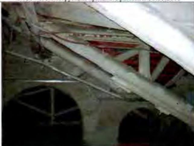
Фото 73. Конструкции крыши. Фрагмент. 10.06.2016
