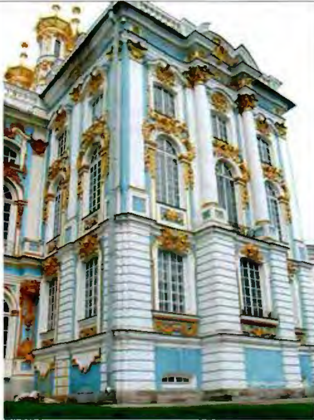
Фото 3. Церковный флигель, восточный торцевой фасад. Общий вид со стороны парка. 10.06.2016
