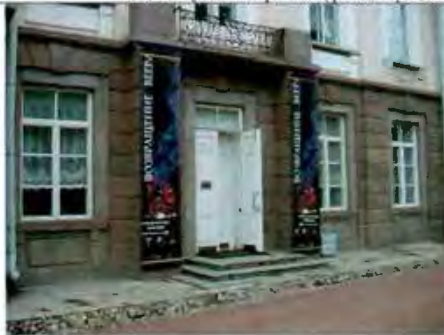
Фото 16. Дверной проем Zubовского флигеля (фасад, обращенный в «Собственный сад»). Общий вид. 10.06.2016
