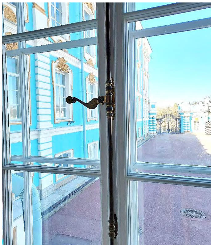
Илл. 9. Помещение №213. Вид на заполнение оконного проема, фурнитура.
