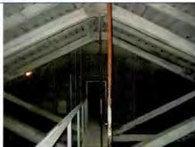
Фото 76. Конструкции крыши. Фрагмент. 10.06.2016
