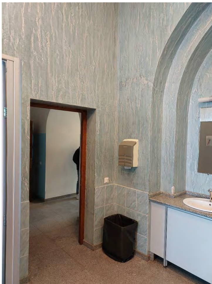
Илл. 23. Общий вид на помещение №214. Вид на дверной проем.
