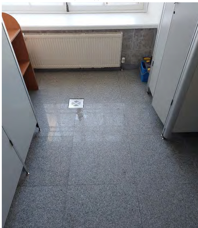
Илл. 14. Общий вид на отделку пола в помещении №213.
