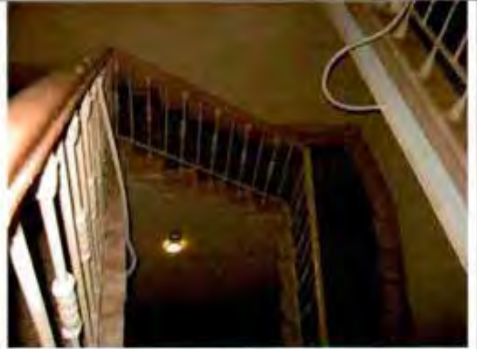
Фото 70. Лестница в Пом. 1-Н (139, 282, 389). Средний дом. Общий вид. 10.06.2016
