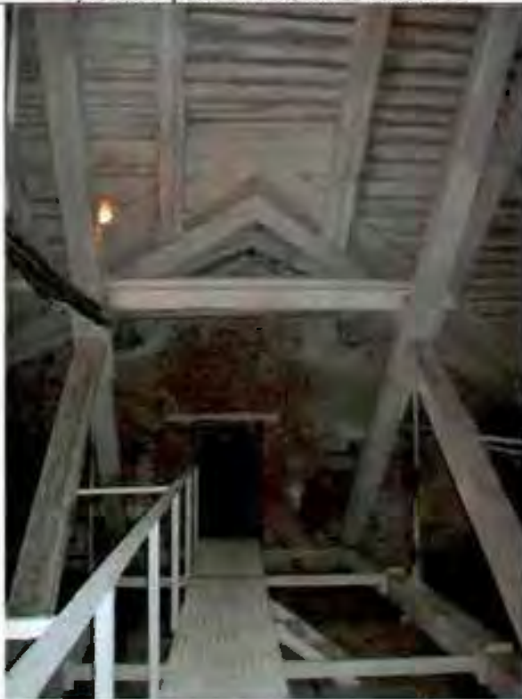
Фото 71. Конструкции крыши. Фрагмент. 10.06.2016
