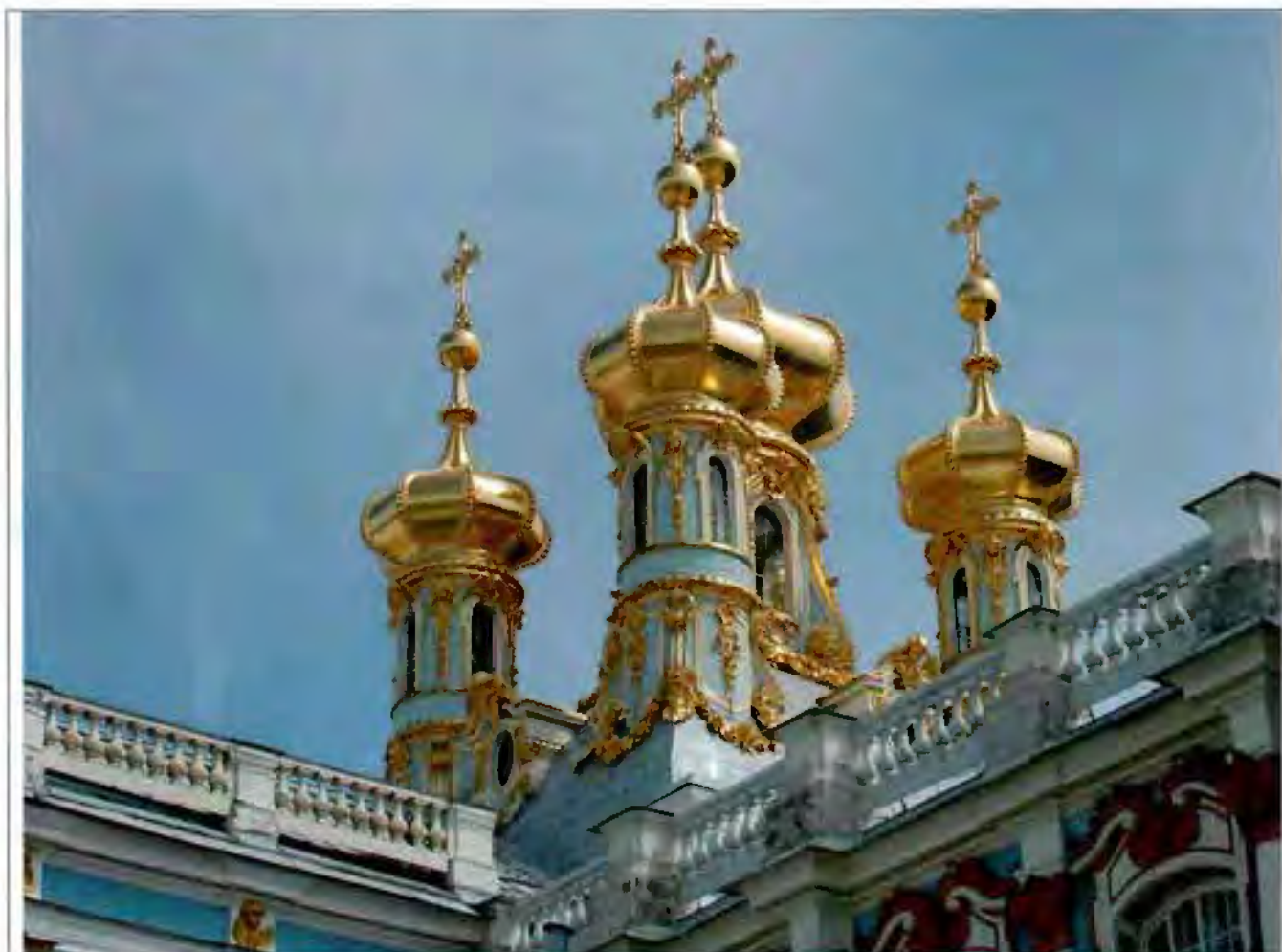
Фото 25. Пять глав на узких высоких барабанах с оконными проемами с полуциркульным завершением. Общий вид со стороны плаца. 10.06.2016
