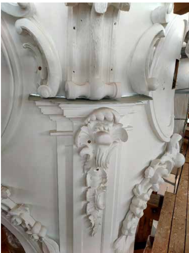
23. «Колокольня», входящая в состав объекта культурного наследия федерального значения «Собор Николо-Богоявленский (Морской)», Никольская пл., д. 1/3., лит. Б. Фрагмент колокольни. Фото 27.04.2022г.
