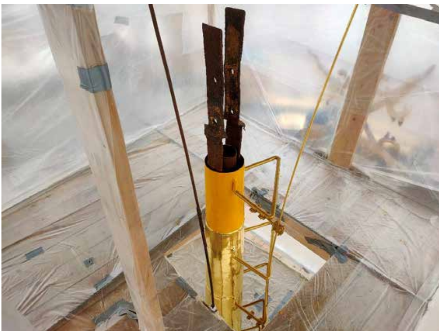
33. «Колокольня», входящая в состав объекта культурного наследия федерального значения «Собор Николо-Богоявленский (Морской)», Никольская пл., д. 1/3., лит. Б. Фрагмент колокольни. Фото 27.04.2022г.
