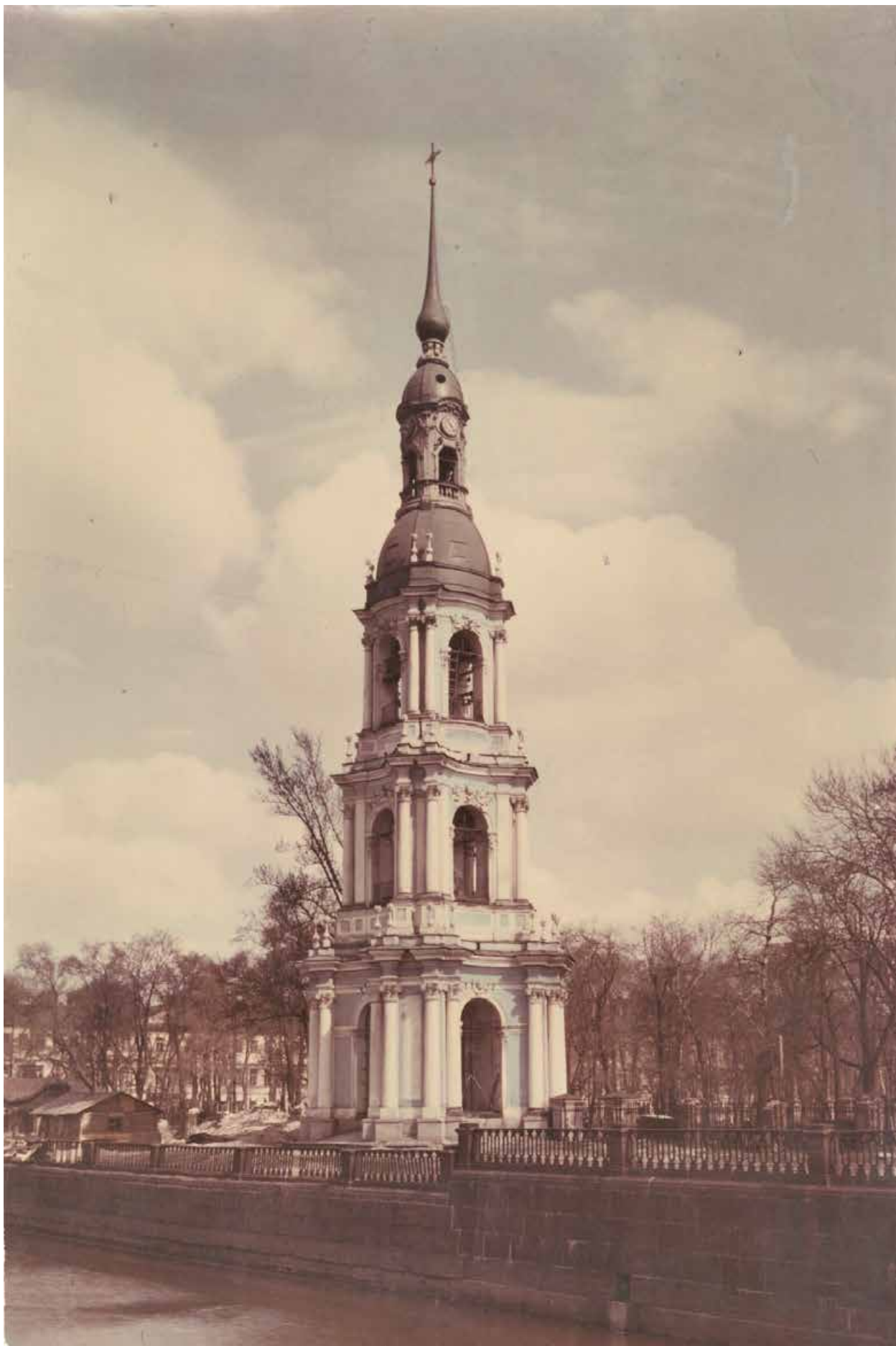
Илл. 52. Вид на колокольню Николо-Богоявленского Морского собора с юго-западной стороны. Фотография. 1953 г. Архив КГИОП (инв. № 44273)
