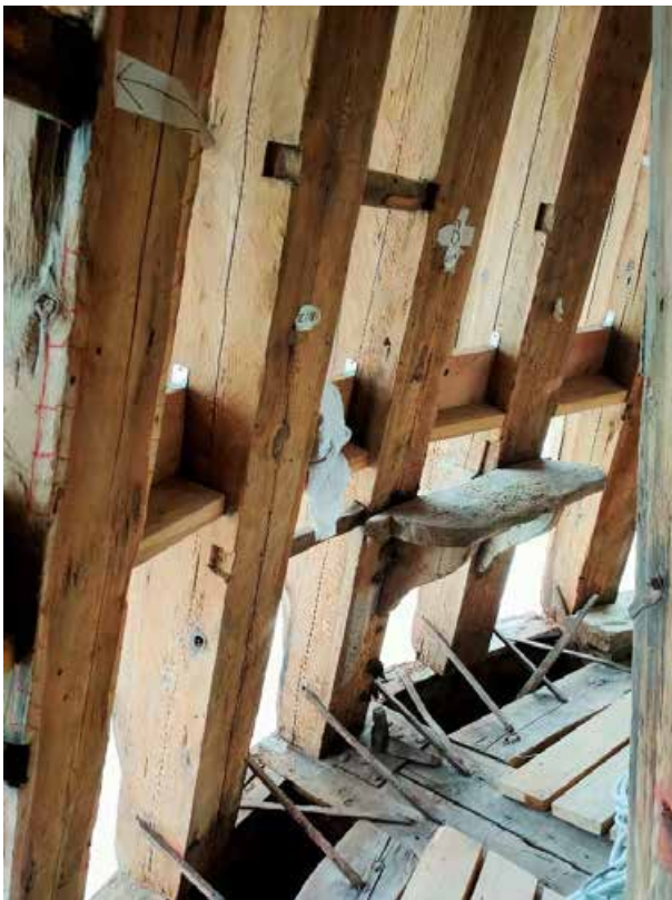
12. «Колокольня», входящая в состав объекта культурного наследия федерального значения «Собор Николо-Богоявленский (Морской)», Никольская пл., д. 1/3., лит. Б. Фрагмент колокольни. Фото 27.04.2022г.
