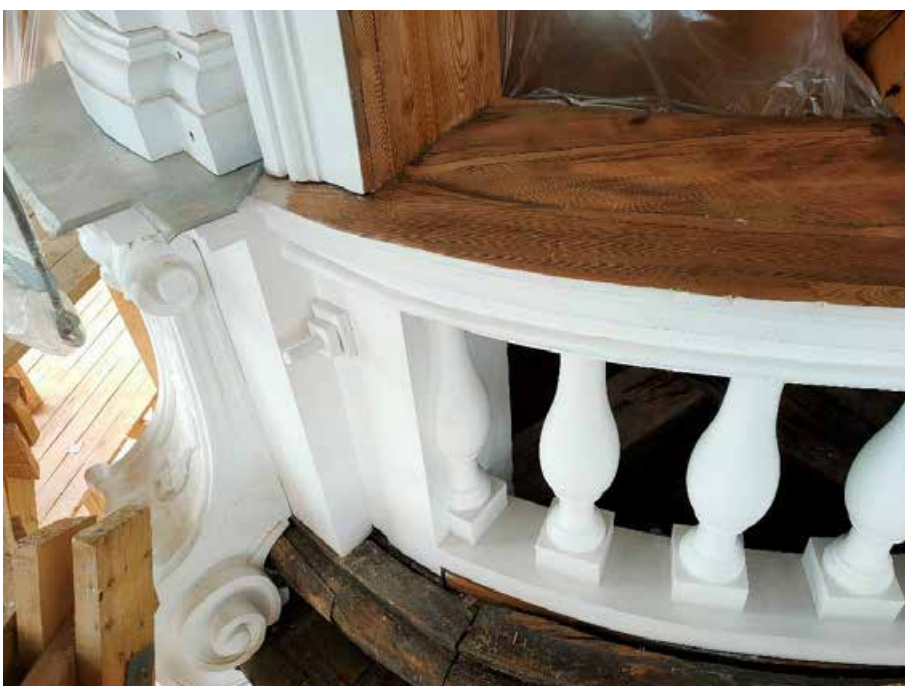
14. «Колокольня», входящая в состав объекта культурного наследия федерального значения «Собор Николо-Богоявленский (Морской)», Никольская пл., д. 1/3., лит. Б. Фрагмент колокольни. Фото 27.04.2022г.
