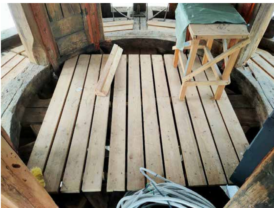
6. «Колокольня», входящая в состав объекта культурного наследия федерального значения «Собор Николо-Богоявленский (Морской)», Никольская пл., д. 1/3., лит. Б. Фрагмент колокольни. Фото 27.04.2022г.
