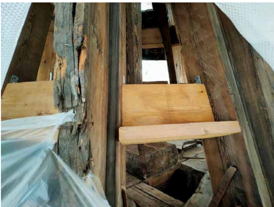
26. «Колокольня», входящая в состав объекта культурного наследия федерального значения «Собор Николо-Богоявленский (Морской)», Никольская пл., д. 1/3., лит. Б. Фрагмент колокольни. Фото 27.04.2022г.
