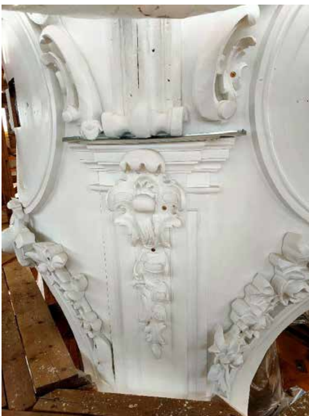
24. «Колокольня», входящая в состав объекта культурного наследия федерального значения «Собор Николо-Богоявленский (Морской)», Никольская пл., д. 1/3., лит. Б. Фрагмент колокольни. Фото 27.04.2022г.
