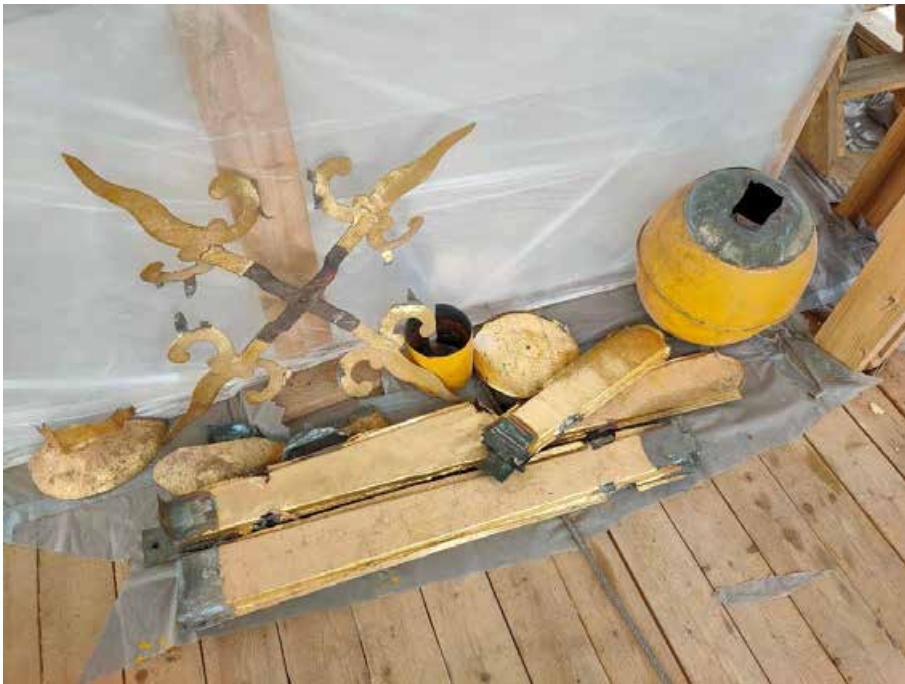
35. «Колокольня», входящая в состав объекта культурного наследия федерального значения «Собор Николо-Богоявленский (Морской)», Никольская пл., д. 1/3., лит. Б. Фрагмент колокольни. Фото 27.04.2022г.
