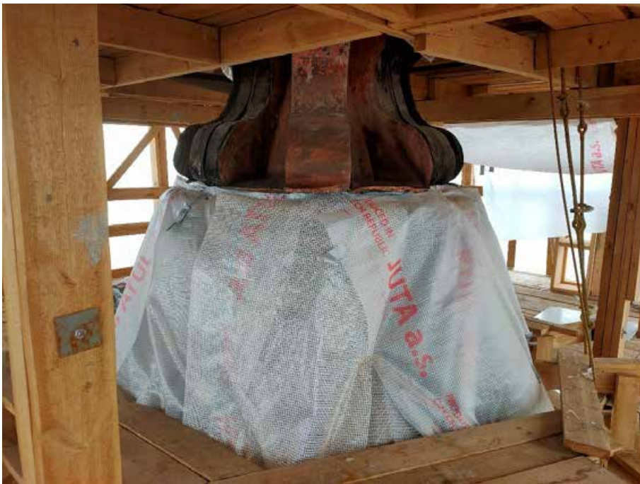
28. «Колокольня», входящая в состав объекта культурного наследия федерального значения «Собор Николо-Богоявленский (Морской)», Никольская пл., д. 1/3., лит. Б. Фрагмент колокольни. Фото 27.04.2022г.
