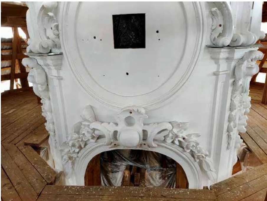
22. «Колокольня», входящая в состав объекта культурного наследия федерального значения «Собор Николо-Богоявленский (Морской)», Никольская пл., д. 1/3., лит. Б. Фрагмент колокольни. Фото 27.04.2022г.
