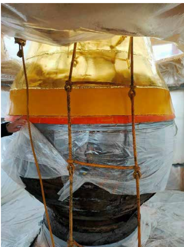
30. «Колокольня», входящая в состав объекта культурного наследия федерального значения «Собор Николо-Богоявленский (Морской)», Никольская пл., д. 1/3., лит. Б. Фрагмент колокольни. Фото 27.04.2022г.
