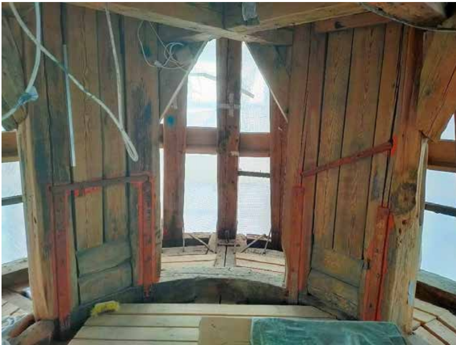
11. «Колокольня», входящая в состав объекта культурного наследия федерального значения «Собор Николо-Богоявленский (Морской)», Никольская пл., д. 1/3., лит. Б. Фрагмент колокольни. Фото 27.04.2022г.
