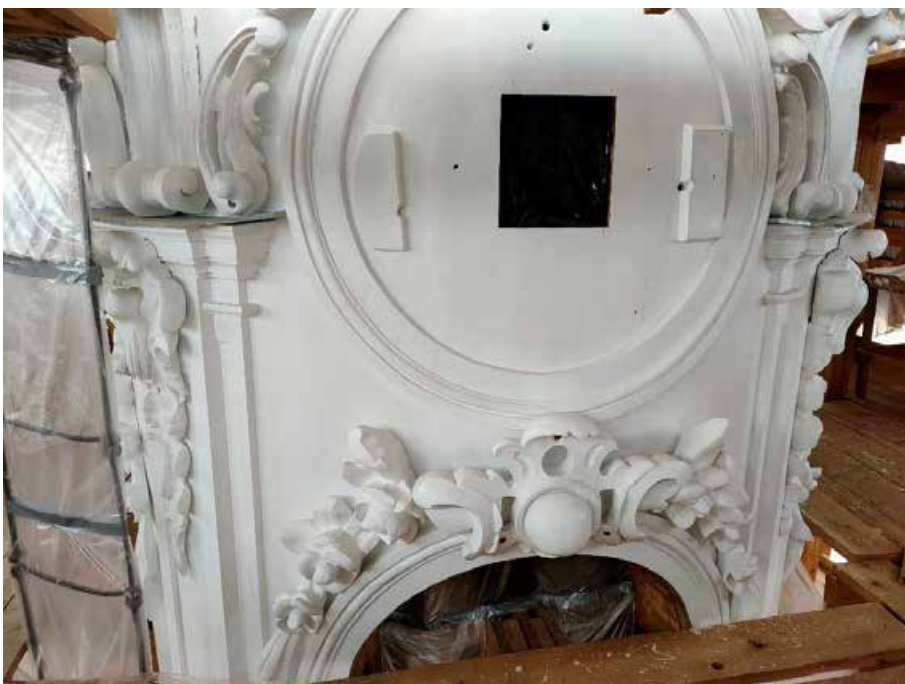
20. «Колокольня», входящая в состав объекта культурного наследия федерального значения «Собор Николо-Богоявленский (Морской)», Никольская пл., д. 1/3., лит. Б. Фрагмент колокольни. Фото 27.04.2022г.
