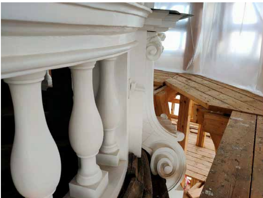
15. «Колокольня», входящая в состав объекта культурного наследия федерального значения «Собор Николо-Богоявленский (Морской)», Никольская пл., д. 1/3., лит. Б. Фрагмент колокольни. Фото 27.04.2022г.
