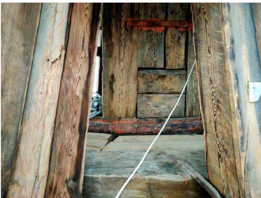
2. «Колокольня», входящая в состав объекта культурного наследия федерального значения «Собор Николо-Богоявленский (Морской)», Никольская пл., д. 1/3., лит. Б. Фрагмент колокольни. Фото 27.04.2022г.
