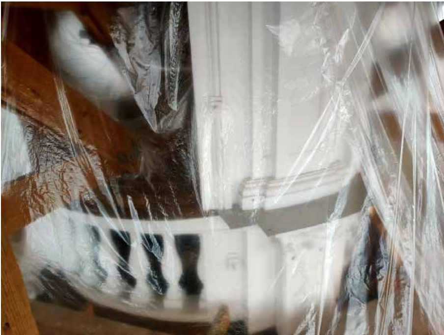
18. «Колокольня», входящая в состав объекта культурного наследия федерального значения «Собор Николо-Богоявленский (Морской)», Никольская пл., д. 1/3., лит. Б. Фрагмент колокольни. Фото 27.04.2022г.
