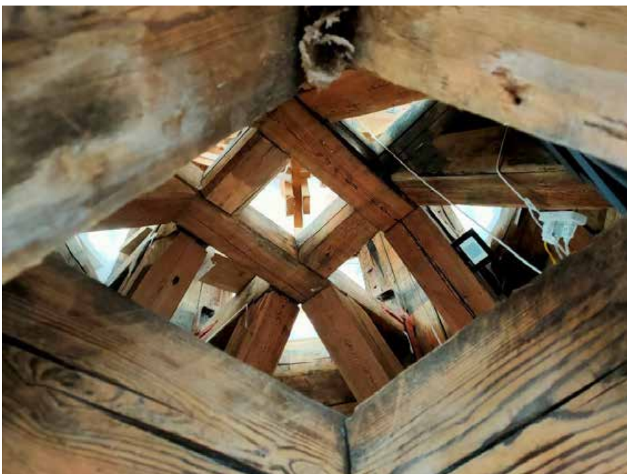
5. «Колокольня», входящая в состав объекта культурного наследия федерального значения «Собор Николо-Богоявленский (Морской)», Никольская пл., д. 1/3., лит. Б. Фрагмент колокольни. Фото 27.04.2022г.
