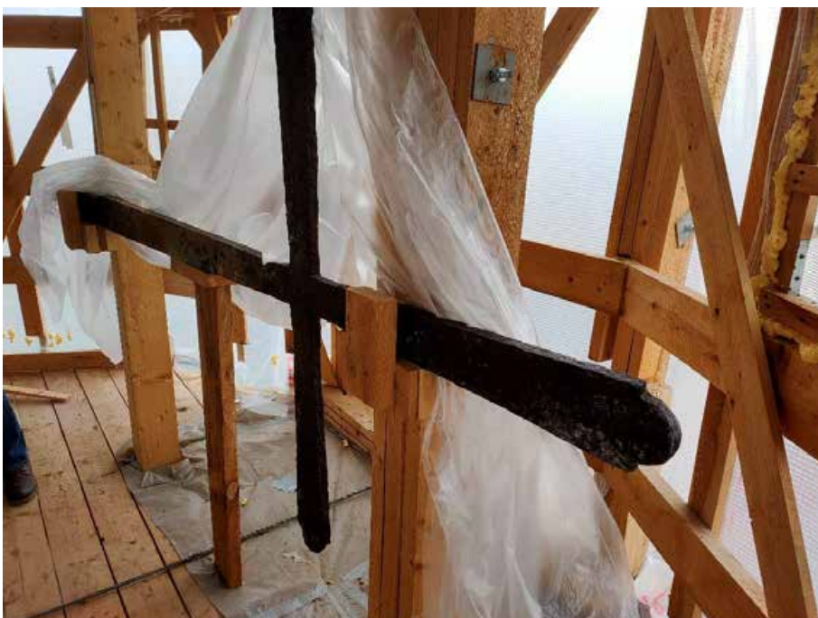
32. «Колокольня», входящая в состав объекта культурного наследия федерального значения «Собор Николо-Богоявленский (Морской)», Никольская пл., д. 1/3., лит. Б. Фрагмент колокольни. Фото 27.04.2022г.
