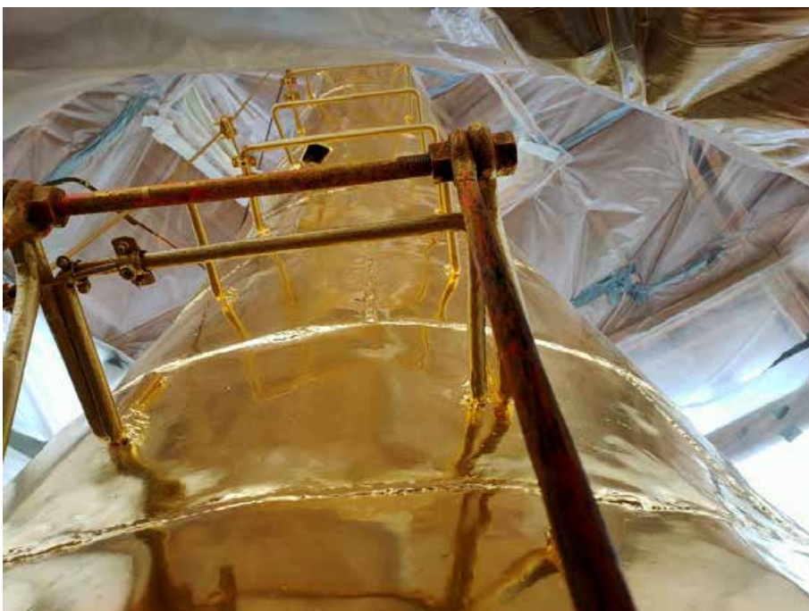
31. «Колокольня», входящая в состав объекта культурного наследия федерального значения «Собор Николо-Богоявленский (Морской)», Никольская пл., д. 1/3., лит. Б. Фрагмент колокольни. Фото 27.04.2022г.
