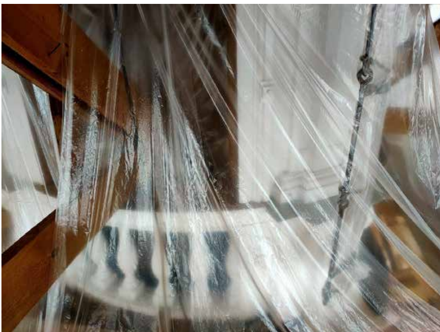
13. «Колокольня», входящая в состав объекта культурного наследия федерального значения «Собор Николо-Богоявленский (Морской)», Никольская пл., д. 1/3., лит. Б. Фрагмент колокольни. Фото 27.04.2022г.
