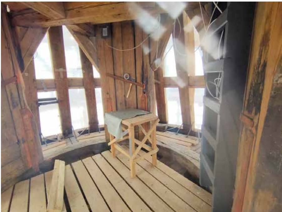
4. «Колокольня», входящая в состав объекта культурного наследия федерального значения «Собор Николо-Богоявленский (Морской)», Никольская пл., д. 1/3., лит. Б. Фрагмент колокольни. Фото 27.04.2022г.
