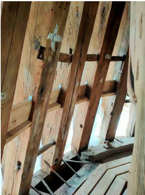
10. «Колокольня», входящая в состав объекта культурного наследия федерального значения «Собор Николо-Богоявленский (Морской)», Никольская пл., д. 1/3., лит. Б. Фрагмент колокольни. Фото 27.04.2022г.
