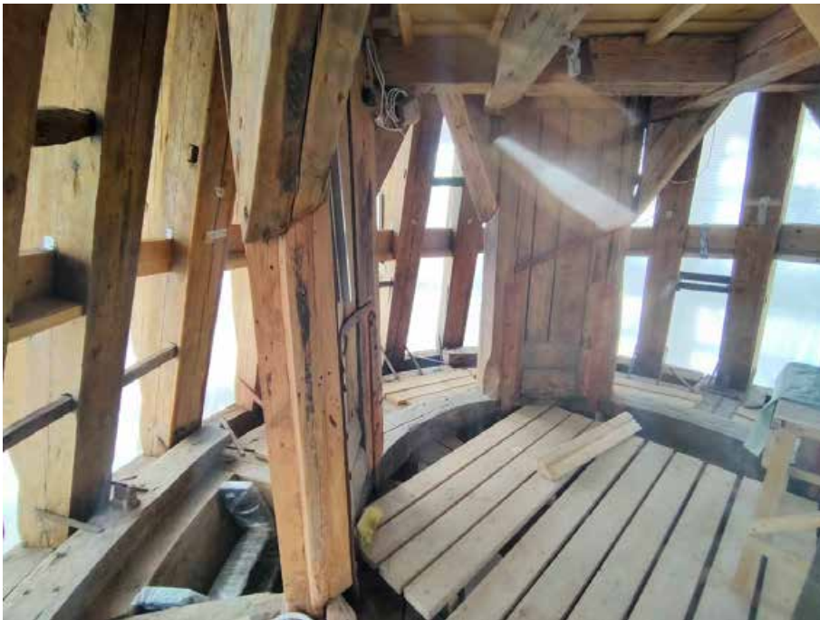
3. «Колокольня», входящая в состав объекта культурного наследия федерального значения «Собор Николо-Богоявленский (Морской)», Никольская пл., д. 1/3., лит. Б. Фрагмент колокольни. Фото 27.04.2022г.
