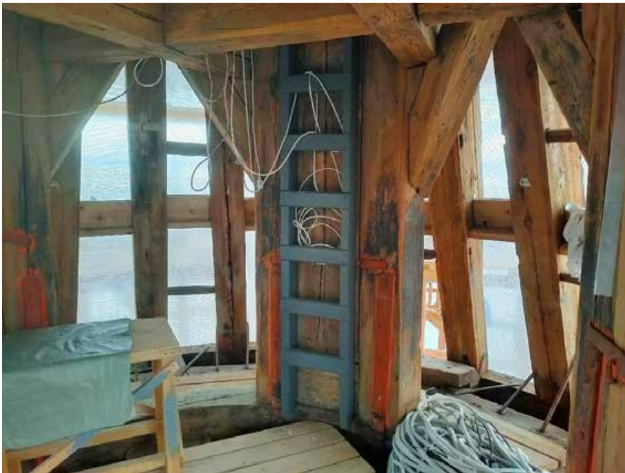
7. «Колокольня», входящая в состав объекта культурного наследия федерального значения «Собор Николо-Богоявленский (Морской)», Никольская пл., д. 1/3., лит. Б. Фрагмент колокольни. Фото 27.04.2022г.
